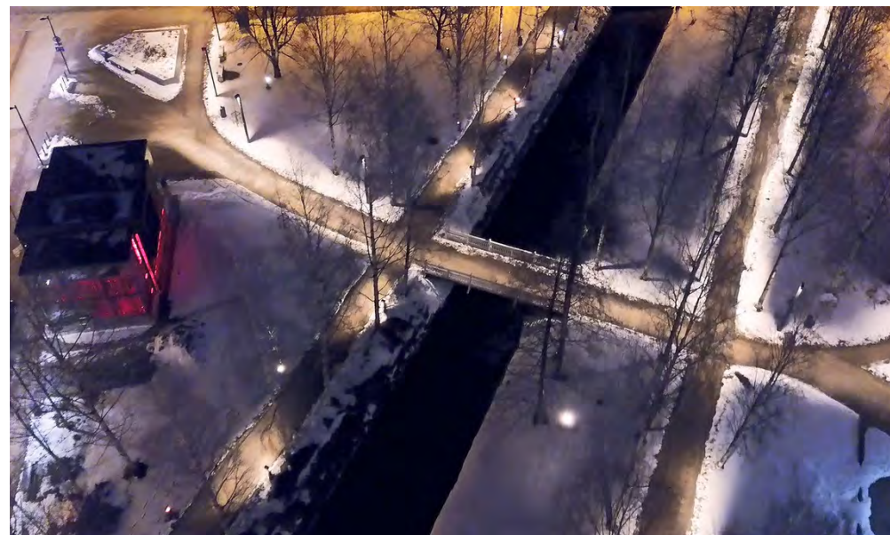
Kuva 7. Otto Karhin puiston valaistus drone-kuvattuna.
