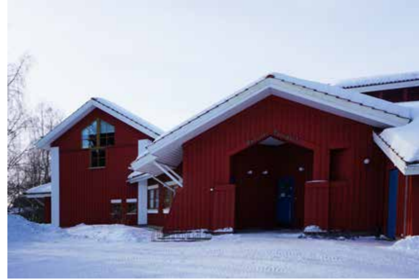
Saloilan päiväkotii, pääsisäänkäynti
