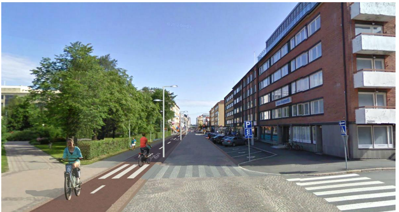
Kuva 19. Isokatu Sepänkadusta pohjoiseen. Valokuva nykytilanteesta ja havainnekuva tilanteesta, jossa kadun länsireunassa on kaksisuuntainen pyörätie ja kiviraidalla erotettu jalkakäytävä.
