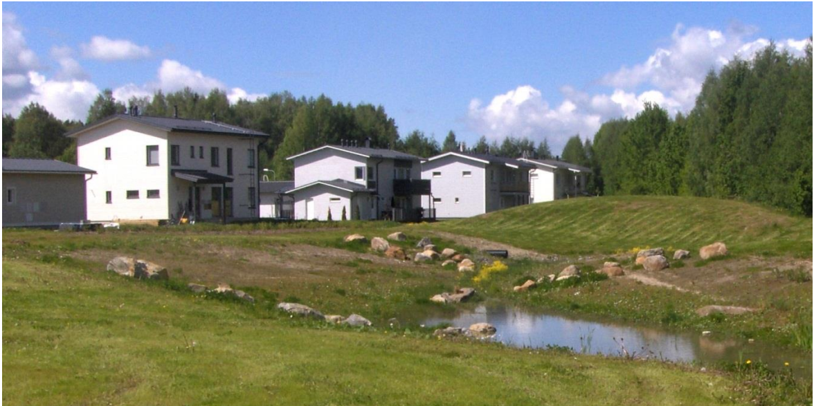
Kuva 5.5. Rambollin suunnittelema hulevesien luonnonmukainen viivytyalue Vaarinmaalla, Kangasalla vuosi rakentamisen jälkeen. Käsitellyalueella yhdistyy pysyvän veden alue sekä sitä ympäröivä tulvaniittyalue.
