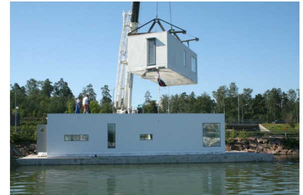
Kuva: kelluvan talon asennus, Keilaniemi Espoo, Marina Housing, 2007
