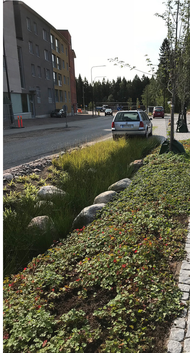
Kuva 6. Kuninkaantammen alueella Helsingissä on rakennettu erilaisia luonnonmukaisia hulevesien hallintarakenteita yleisillä ja yksityisillä alueilla. Kuvassa Kuninkaankierron biosuodatuspainanteita.
