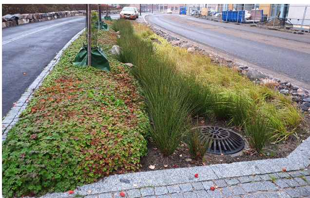
Kuva 6. Kuninkaantammen alueella Helsingissä on rakennettu erilaisia luonnonmukaisia hulevesien hallintarakenteita yleisillä ja yksityisillä alueilla. Kuvassa Kuninkaankierron biosuodatuspainanteita.
