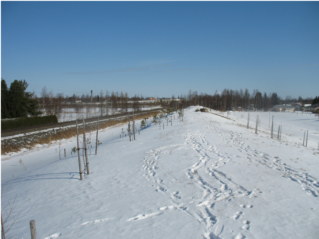
Liminka, (kmv noin 727+000), rata-osaa Limingan eteläpuolella. Radan itäpuolella on useita metrejä korkea rakennettu maavalli.
