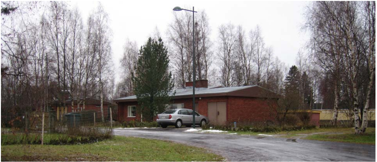
Kuva 7. Mittauspisteet 5 ja 6 olivat rakennuksen sokkelissa ja läheisyydessä maassa.
