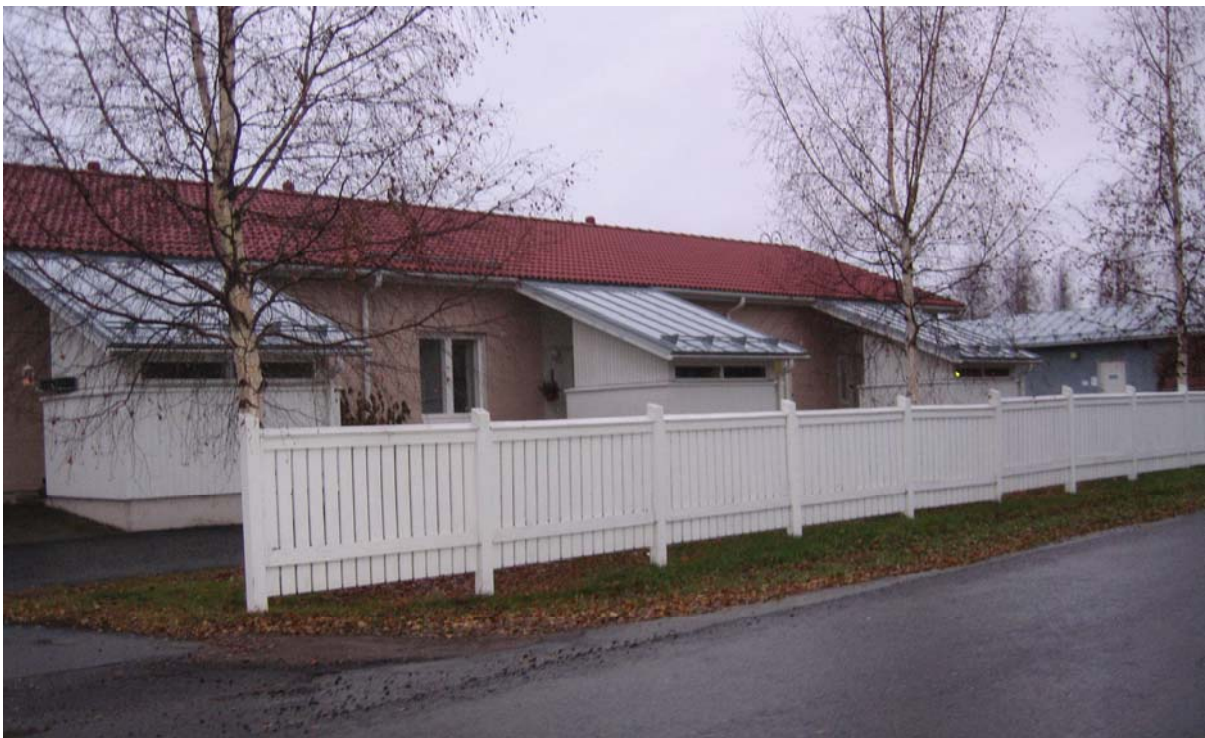
Kuva 4. Mittauspisteet 3 ja 4 olivat kuvan rakennuksen keskivaiheilla.
