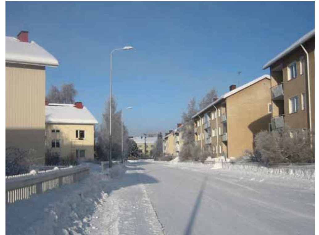
Kuva 118. Pylväskorkeus 10 m, perusvalaisin, nykytilanne, Karjasilta.
