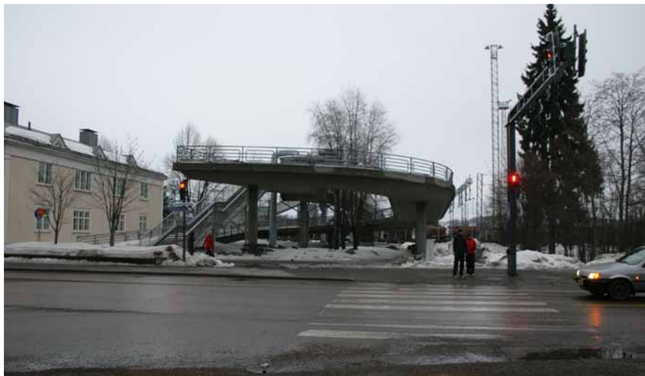
Kuvat 58 ja 59. Kilpisen ylikäytäväsillan pääty päivällä ja yöllä. Jyväskylä.
