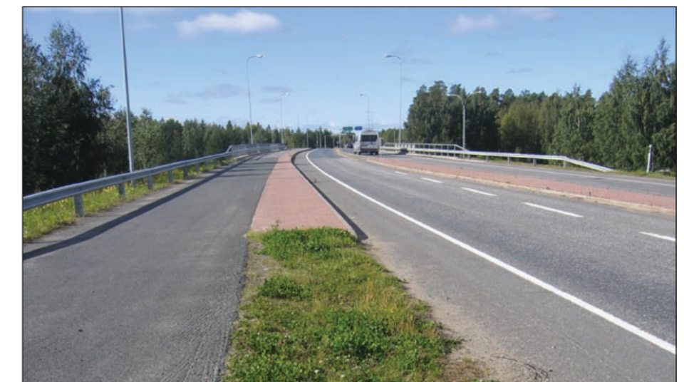
Kuva 29. Näkymä nykyiselle moottoritien ylikulkusillalle..
