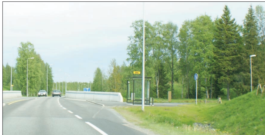
Kuva 34. Raitotien uusi pysäkki Pöllöntien liittymän lähellä.
