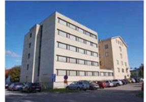
OSAO:n asuntolan laajennus
