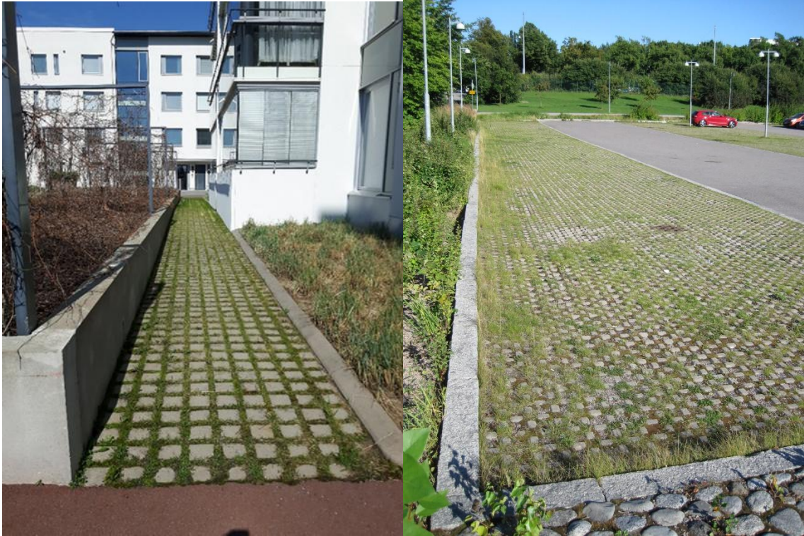
Kuva 10. Nurmikivillä saadaan lisättyä läpäisevää pintaa tontille, mutta saadaan riittävän kantava alusta mm. pelastusajoneuvon pelastuspaikalle.
