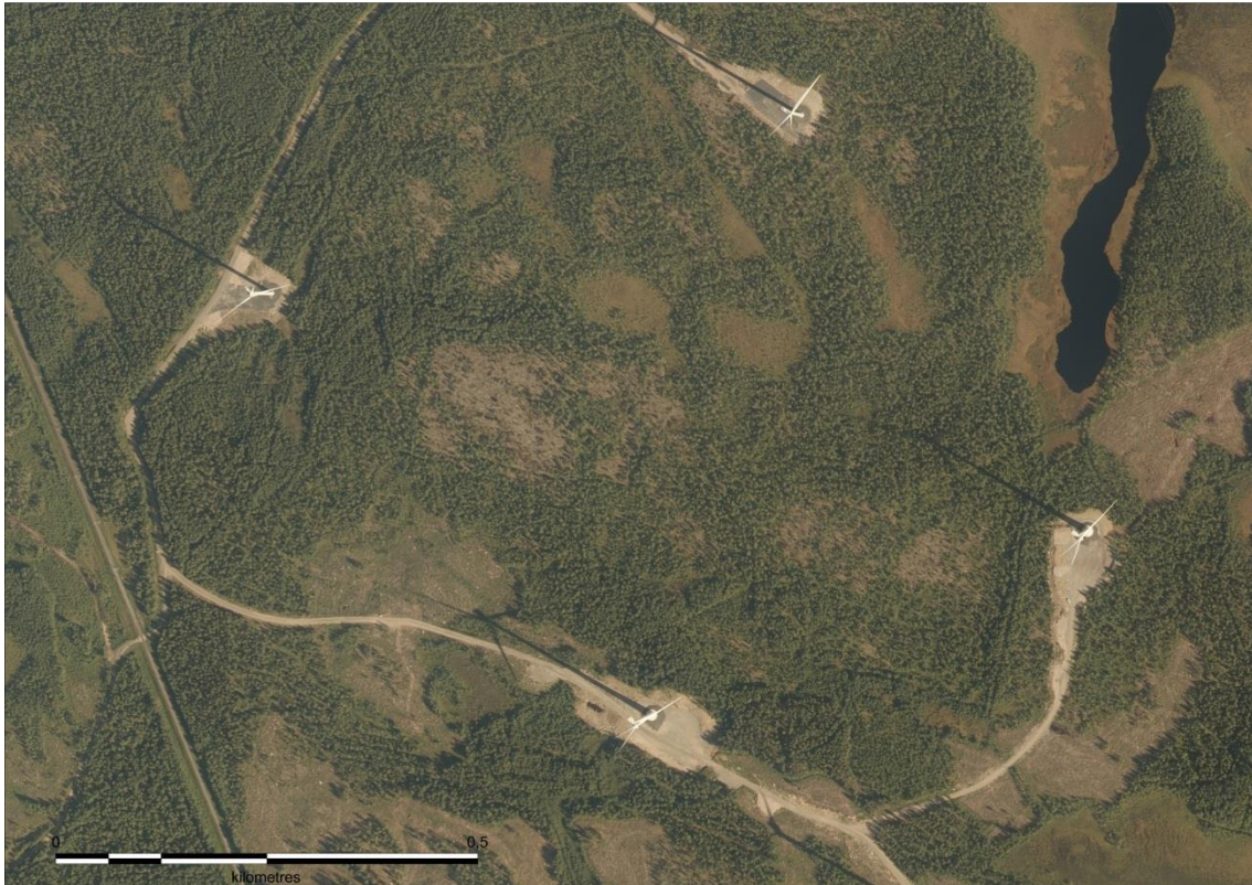
Kuva 73. Ilmakuvasa näkyy toiminnassa olevia tuulivoimaloita, huoltotiet ja nostokentät. Tuulivoimaloiden ympäristössä ja välialueilla aikaisempi maankäyttö on säilynyt ennallaan.
