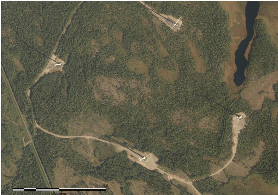
Kuva 12. Ilmakuvassa näkyy toiminnassa olevia tuulivoimaloita, huoltotiet ja nostokentät. Tuulivoimaloiden ympäristössä ja välialueilla aikaisempi maankäyttö on säilynyt ennallaan.
