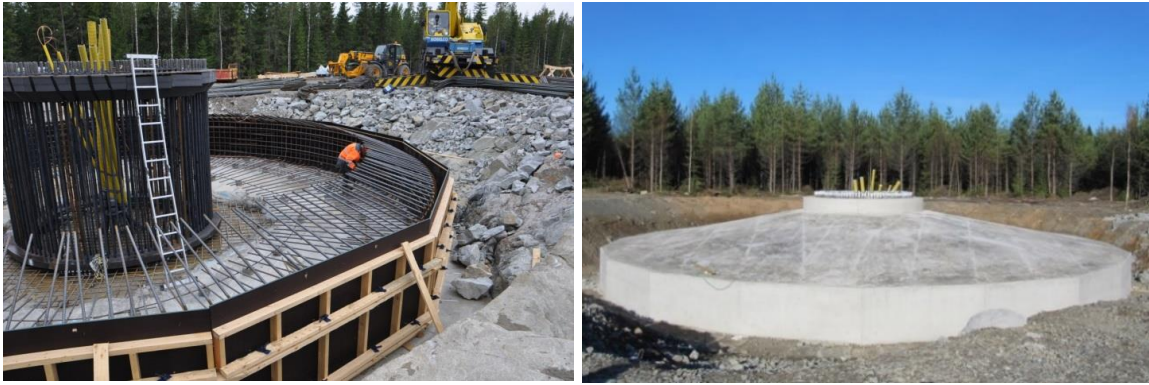
Kuva 22. Tuulivoimalan perustusten rakentamista. (Kuvat: Leila Väyrynen, FCG)
