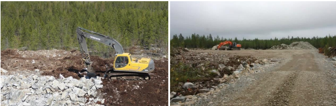
Kuva 20. Tuulivoimapuiston rakentaminen alkaa huoltoteiden ja pystytysalueiden rakentamisella (kuvat: FCG).
