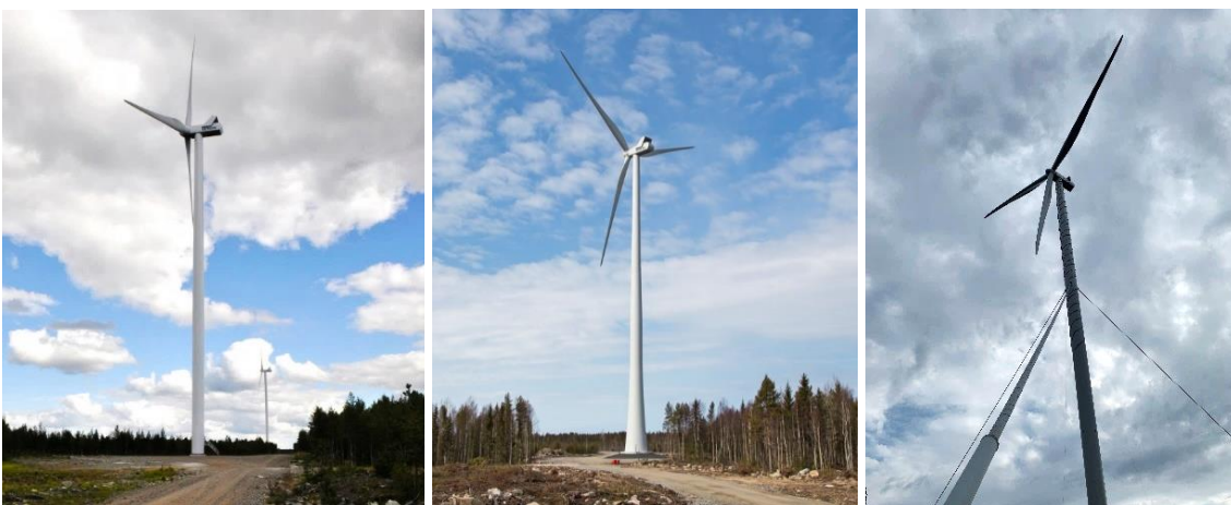
Kuva 14. Vasemmalla on esimerkki teräslieriötornista, keskellä hybriditornista ja oikealla harustetusta tornista. 250 metrin korkeuden ylittäminen ei välttämättä tarkoita harustettua tornia. (Kuvat: FCG, Carelin)
