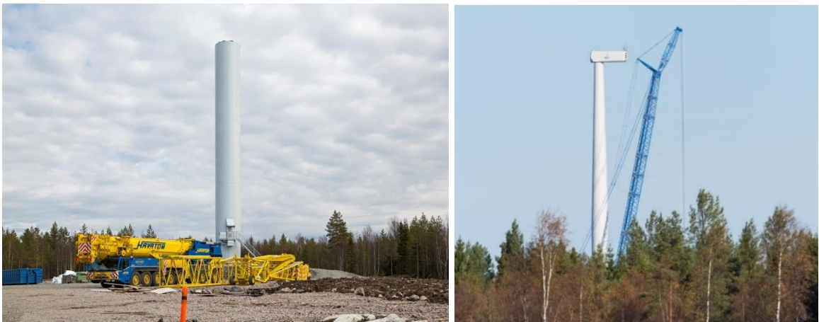
Kuva 23. Tuulivoimalan kokoamista. (Kuvat: FCG)
