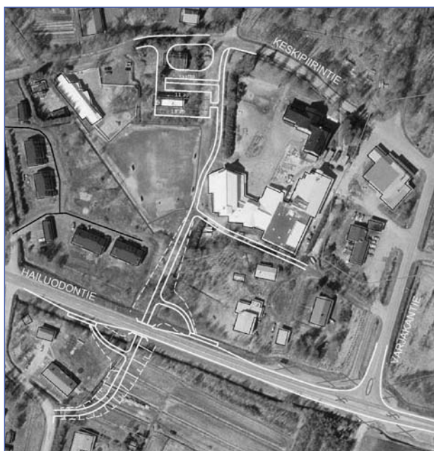
Kuva 18. Liikennejärjestelyt koulun alikulkukäytävässä.
