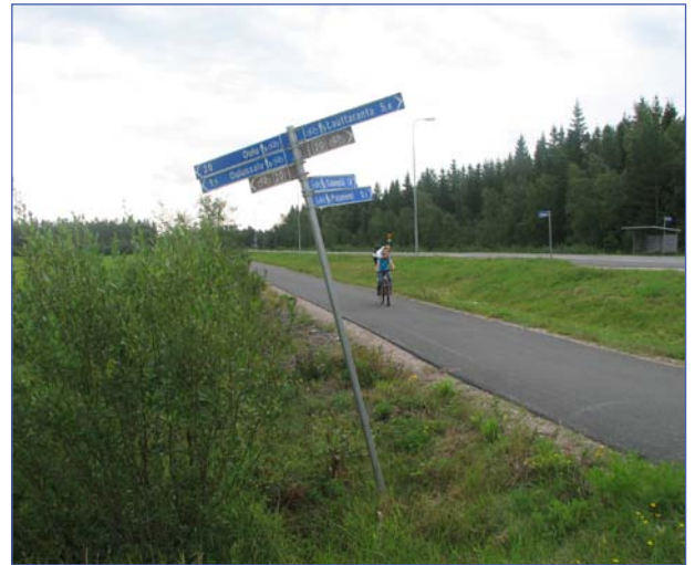
Kuva 2. Salonpääntien liittymän kevyen liikenteen väylä.
