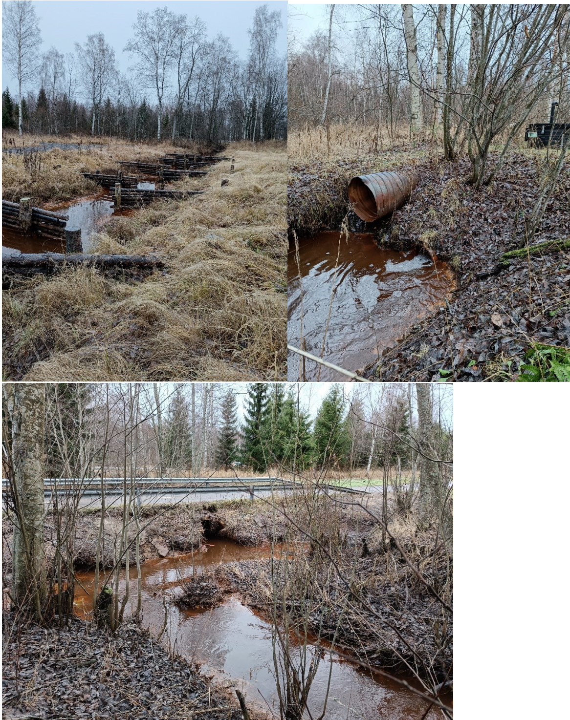
Kuva 6. Lopakkaaja Raitotien länsipuolella riukutukkipadon kohdalla (vasen yläkuva), Lopakkoja ennen Raitotien kevyen liikenteen väylää kohdasta (oikea yläkuva), missä on Kiertokaaren mittauskaivo. Alakuva; Lopakkaaja ennen Raitotien kevyen liikenteen väylän alitusta, missä vettä padottuu.
