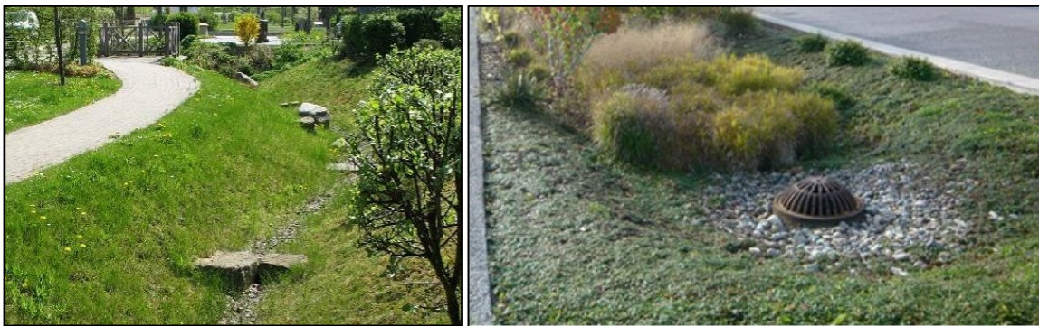
Kuva 21. Vasen kuva: Esimerkki hulevesien pintajohtamista kadun reunaosassa, johon on istutettu kasvillisuutta ja rakennettu pohjapatoja. 12 Oikea kuva: Esimerkki katualueen viherpainanteesta, jossa on ylivuotojärjestelmä hulevesiviemäriverkkoon (Seattle, USA). 12
