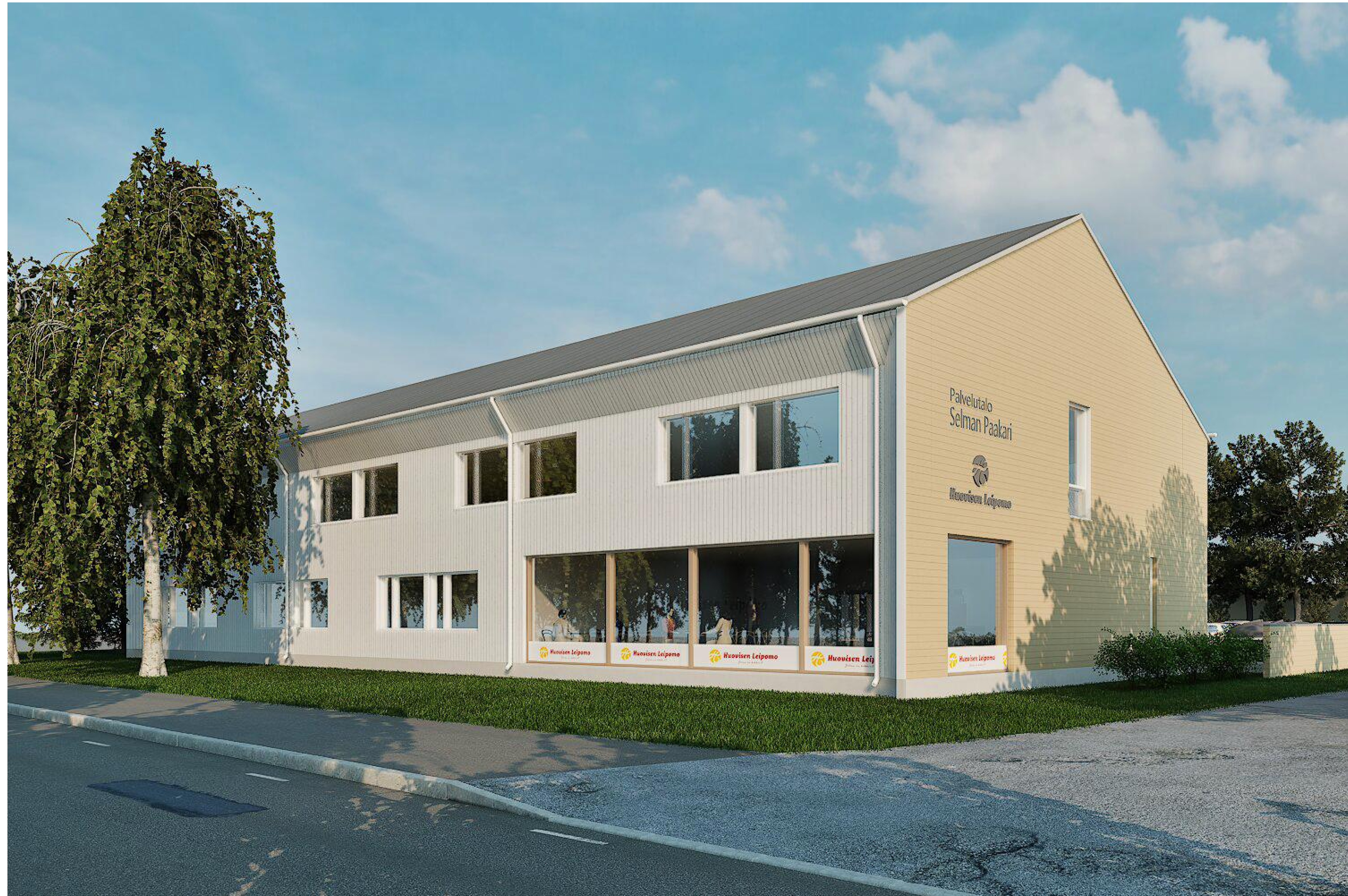
OULUNSUUNTIE JA PIHTAKUJAN RISTEYKSEN SUUNNASTA.
