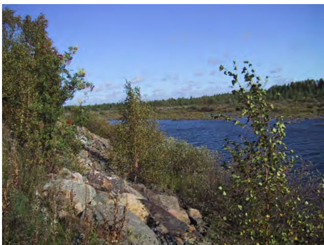
Kuva 1. Iijoen rakennetut rannat ovat paikoin hyvin kivisiä ja karuja.
