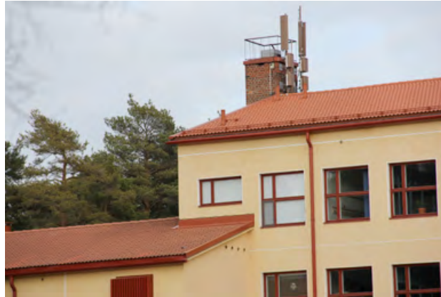
Savitiilikatto ja saman värinen pellitys. B-osassa on ollut 30 m 2 peltikattoa.
