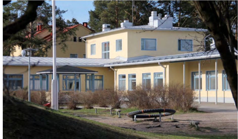
Taustalla näkyvän Martti Heikuran vuonna 1955 suunnitteleman Höyhtyän lastenkodin rakentaminen kytkettiin samaan hankkeeseen Nokelan koulun kanssa. Etualalla on niinikään Heikuran suunnittelema Höyhtyän lastentalo vuodelta 1963. Se oli valmistuessaan Oulun ensimmäinen tähän tarkoitukseen suunniteltu rakennus.
