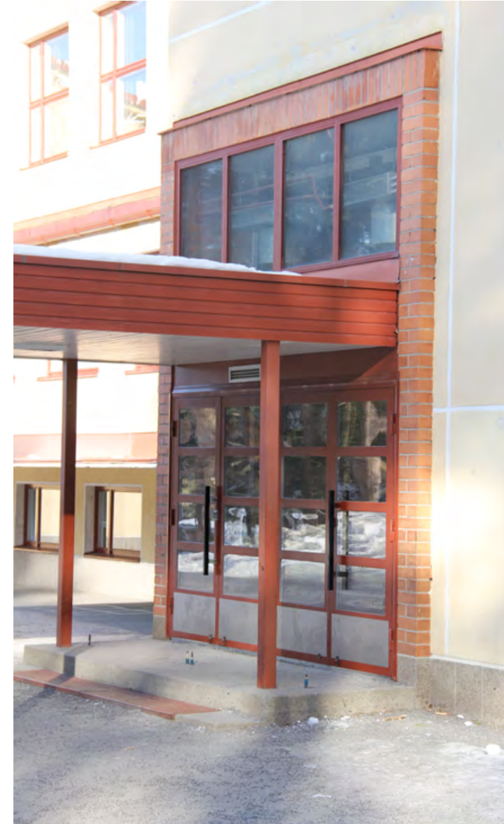
Pääsisäänkäyntiä korostaa punatiili-aihe. Alkuperäinen sisäänkäynti muodosti solan, kunnes pääovi siirrettiin ulkoiseinän linjaan. Sadekatos jatkuu pääoven levyisenä.
