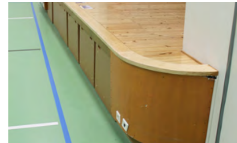
Näyttämön tuolivaunujen teräksiset vetimet on poistettu.
