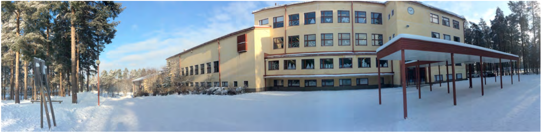
Alkuperäisessä suunnitelmassa koulun luokkatilat sijaitsivat korkeimmassa eli C-osassa. Koulun ulkoinen hahmo on säilynyt muuttumattomana lukuun ottamatta vuonna 1977 rakennettua sadekatosta.
