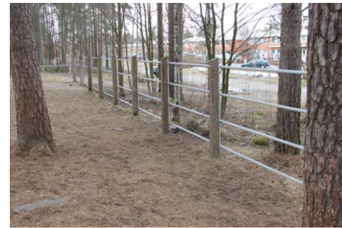
Nykyinen aita hyödyntää alkuperäisiä betonipilareita.
