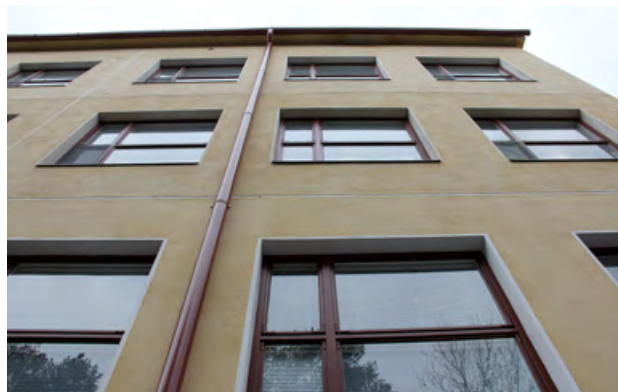
Itäjulkisivulla rappaus on kohtalaisen hyvässä kunnossa.
