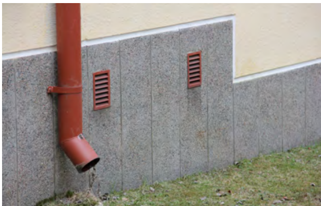
Perustukset on tehty säästöbetonista. Näkyvä osa on pesubetonია.
