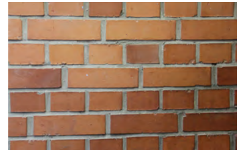
Puhtaaksi muurattu tiililimitys kertoo seinän rakenteesta.
