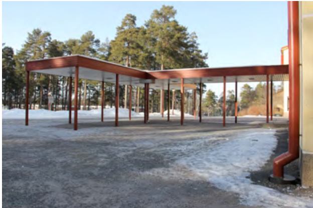
Pääsisäänkäynnin sadekatos lisättiin vuonna 1977.
