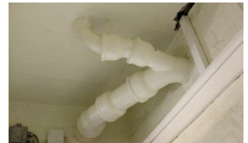
Valurautaisia viemäriinjoja kellarin alakatossa.
