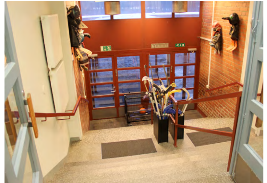
Pääsisääkäynnin sisäänvedetty ulko-ovi siirrettiin samaan linjaan ulkoseinän kanssa. Kuvassa näkyvä tiiliseinä oli alunperin ulkotilaa. Graniittinen ulkoporras vaihdettiin mosaiikkibetoniseen sisäportaaseen.
