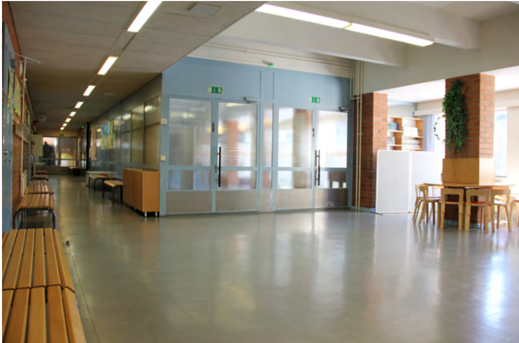
1990-luvun peruskorjaus muutti koulun alakattomaailmaa. Ilmastointikanavat, putkitukset, kaapeloinnit ja valaisimet upotettiin alaslaskettujen kattojen sisään. Akustiikkalevyt sijoitettiin välipohjapalkiston väliin siten, että ne eivät muuttaneet arkkitehtuuria.
