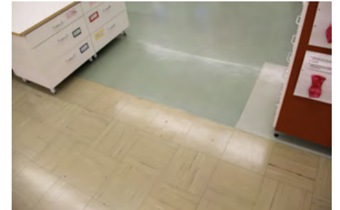
Kolmen erilaisen lattiapinnoitteen risteyskohta.
