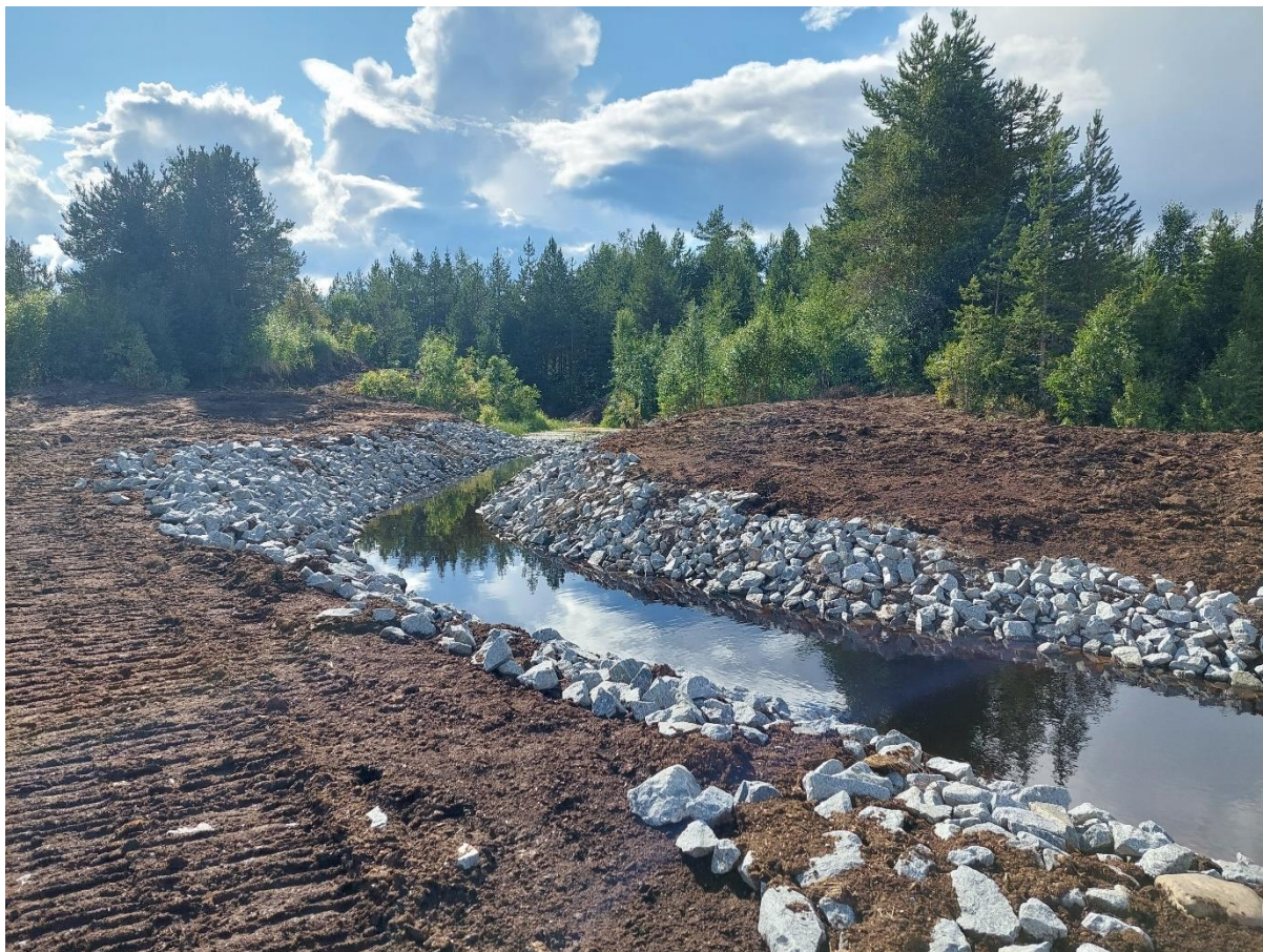
Kuva 3 Esimerkkikuva valmiista johdeojasta. Kuva Asmo Hyvärinen
