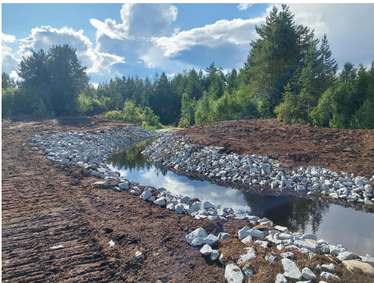
Kuva 7 Esimerkkikuva valmiista johdeojasta. Kuva Asmo Hyvärinen
