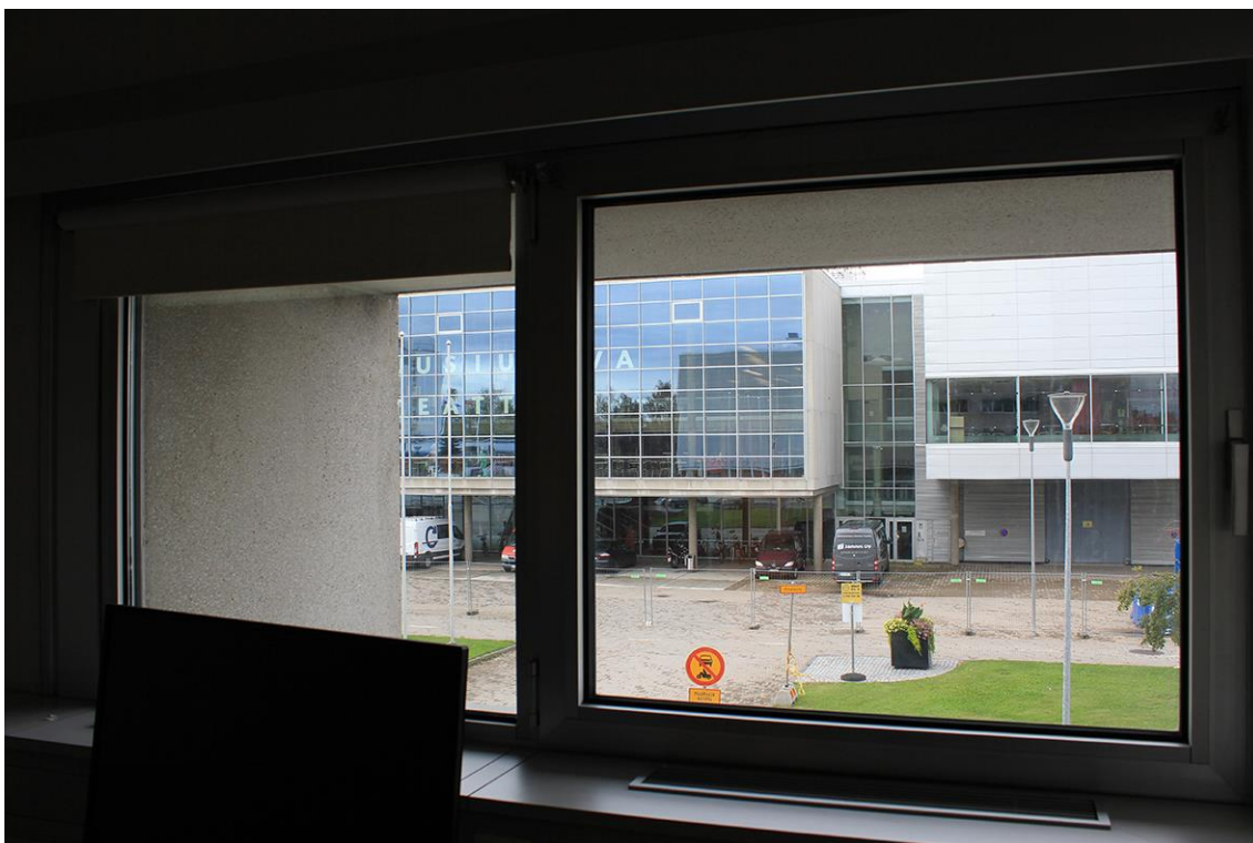
Ikkunasta avautuvaa näkymää reunustaa julkisivulle luonteenomainen betoniuloke.
