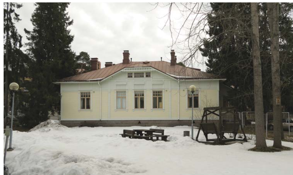
107. Johtajan asunnon länsijulkisivu huhtikuussa 2018.
