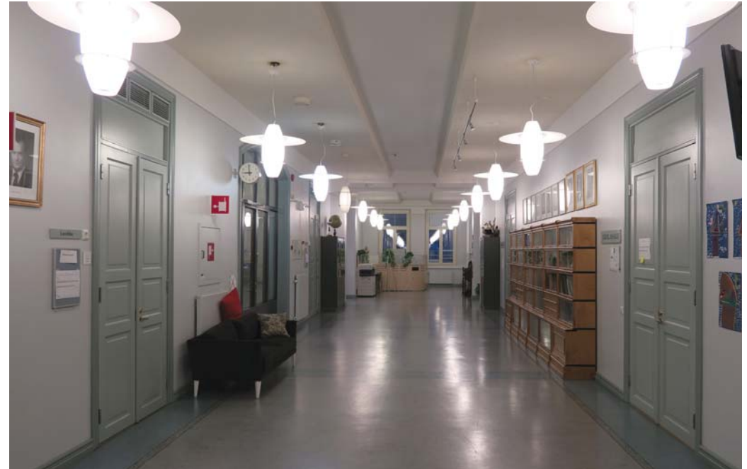
84. Yläaulan tilarakenne on säilynyt. Ovet on uusittu vanhan mallin mukaan. Kattopintaan on lisätty edellisessä remontissa akustointia.
