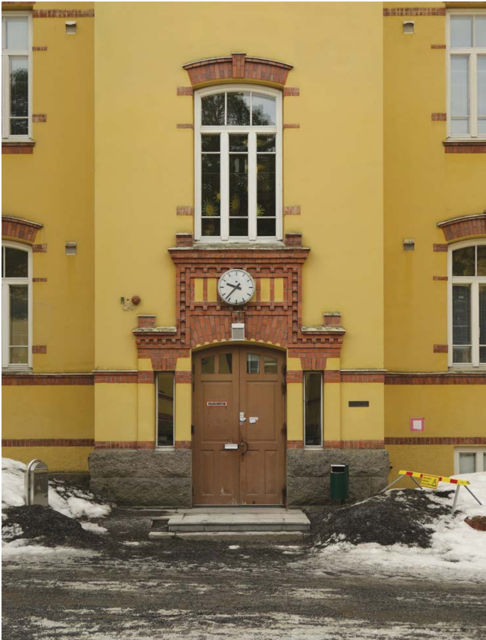
74. Merikartanon koulurakennuksen pääsisäänkäynti koristeellisine tiilimuurauksineen huhtikuussa 2018. Ikkunoiden vieressä näkyvissä vanhat raitisilmasäleiköt.
