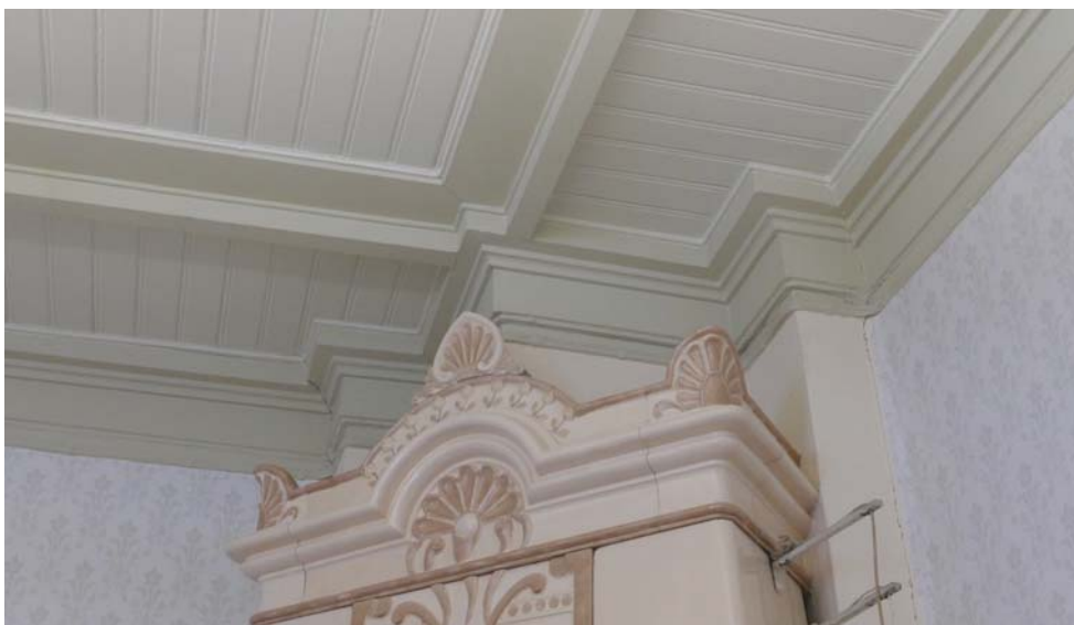
117. Johtajan asunnon salin kattopanelointia listoituksineen.
