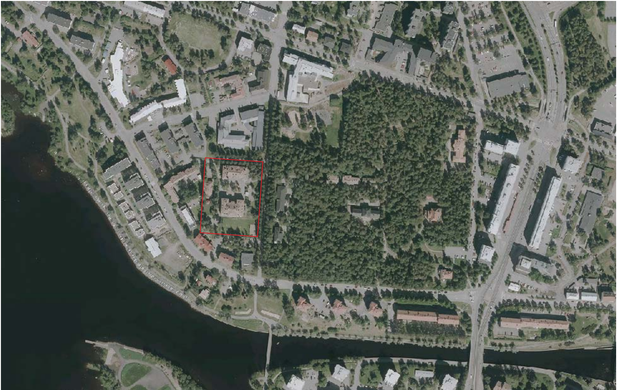
19. Ilmakuva vuodelta 2017. Koulun tontilla ja viereisen Tuuranpuiston alueella ei ole tapahtunut suuria muutoksia. 1960-luvulla puretun piharakennuksen paikalla on nyt leikkialue. Pienimittakaavainen puurakentaminen on vaihtunut Koskitien, Merikoskenkadun ja Kangastien varrelle ryhmiteltyihin kerrostaloihin. (Kuva: Oulun kaupunki, Yhdyskunta- ja ympäristöpalvelut)
