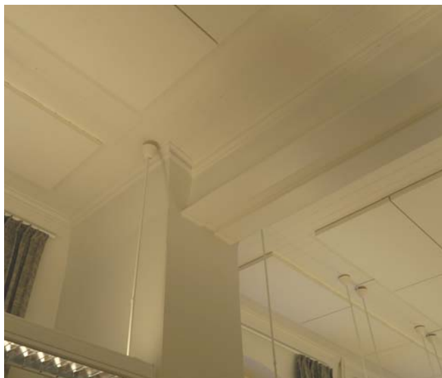
88. Luokkatilojen panelikatot ovat osittain näkyvissä akustiikkalevykenttien välissä.
