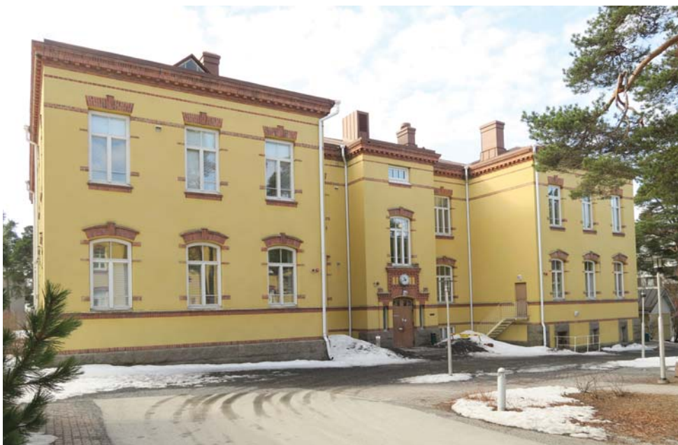
73. Merikartanon koulurakennuksen sisäänkäyntijulkisivu huhtikuussa 2018. Kuvassa näkyy myös 1970-luvulla lisätty poistumistieporras
