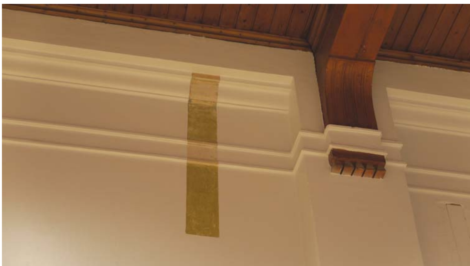
82. Salin seinälle on paljastettu vanha vihertävä maalikerros. Valmistuttuaan salin seinät olivat aikalaiskuvauksen mukaan tumman vihreät, ja niitä kiersi valkoinen friisi.
