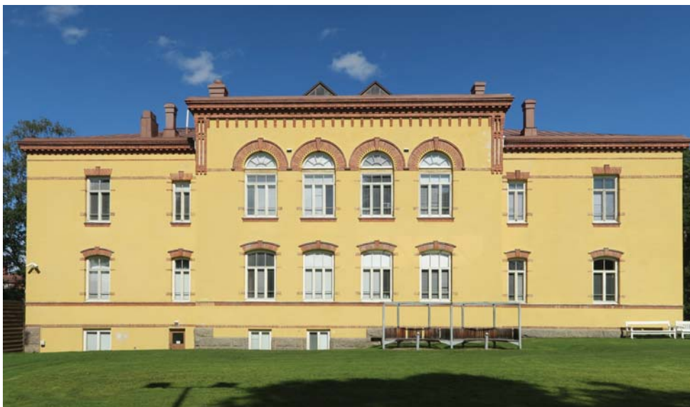
72. Merikartanon koulurakennuksen eteläjulkisivu. (Riitta Kosonen, Pohjois-Pohjanmaan liitto, 2015)
