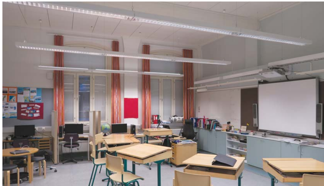
78. Merikartanon koulun ensimmäisen kerroksen luokkatila 107, eli entinen opetustarveluokka. Luokkatilojen järjestys ja luonne on säilynyt hyvin. Panelikatot ovat osin näkyvissä akustiikkalevykenttien välissä.
