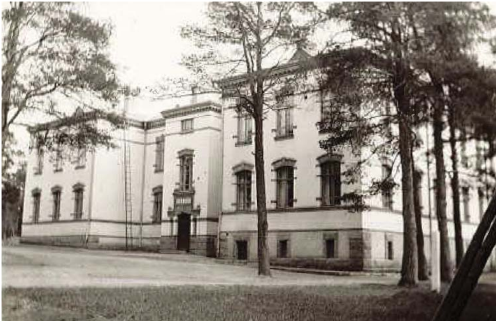
70. Merikartanon koulurakennuksen sisäänkäyntijulkisivu, kuvausaika tuntematon /ennen 1960 (kellarin ikkunat vielä suurentamatta). (Kuva Uno Kivimäki?)
