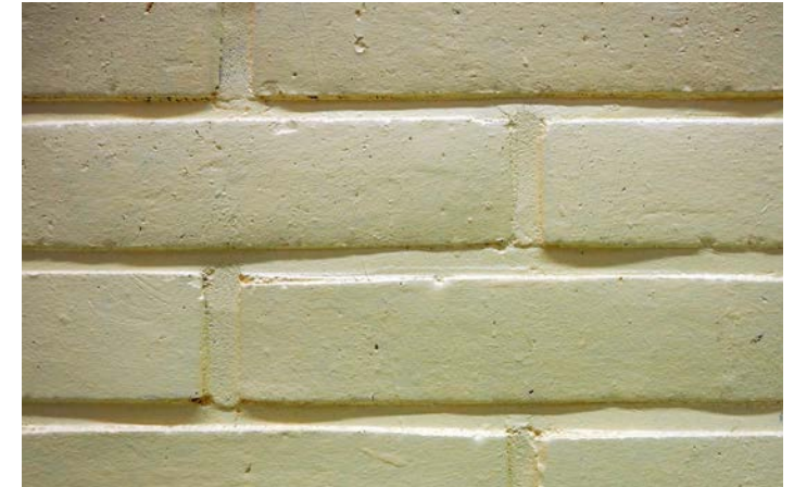
A-rakennuksen sisätilojen detalleja ja pintamateriaaleja. Käytävän mosaiikkibetonilattia ja pinnakaide ovat alkuperäisiä.
