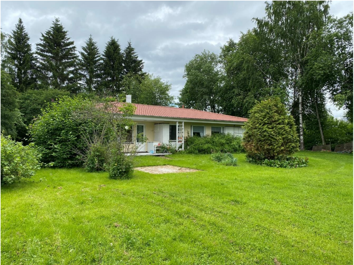
Kuva 11. Asuintalon näkymä takapihalta. Takana pihaa jakava korkea kuusiaidanne ja toisella sivulla kaakon puoleinen leppä- ja koivuvaltainen aidanne. Pihassa istutusalueita, norjanangervoa, syreeniä, tuijia ja huonokuntoinen lumipalloheisi.
