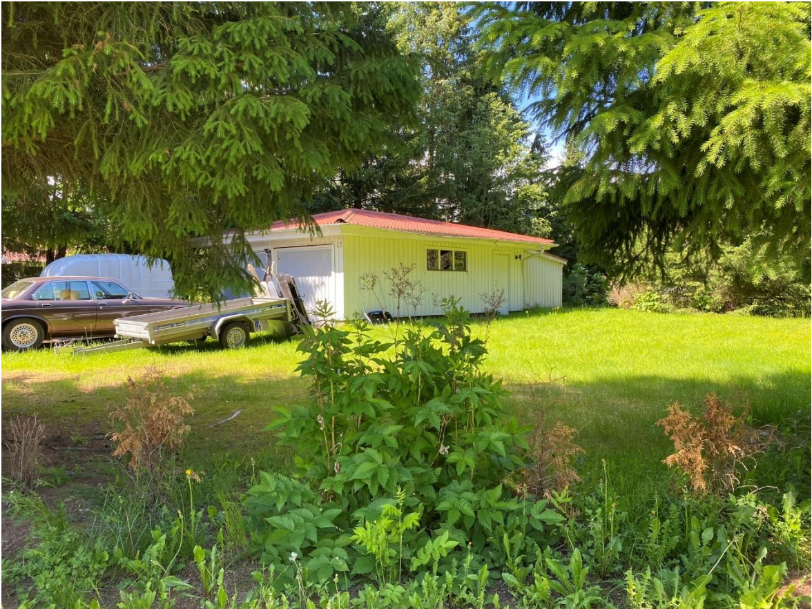
Kuva 6. Autotallin näkymä Nissiläntien ja Pyrästien liittymästä, kuusiaidanteen välisestä raosta. Istutetut tuijat matalia ja ruskeita, välissä mesiangervo. Autotallin takana toinen aidanne.
