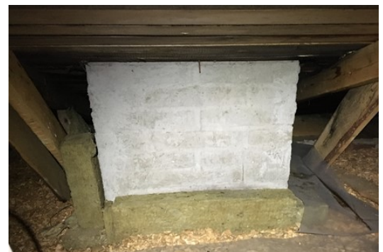
Kuva. Vesikatoissa läpimenojen kohdat ovat haasteellisia.
