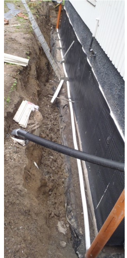
Kuva. Kellarin seinän ulkopuolinen korjaus.
