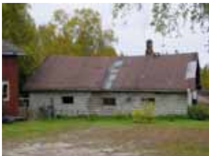
KUVA 36. Lehtolan lohkopintaisista sementti- tiilistä rakennettu navetta, Lehtolantie 11
