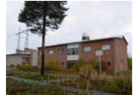
KUVA 21. Pikkaralan sähköaseman valvomo (Aarne Ervi 1955) Asemakyläntie 50
