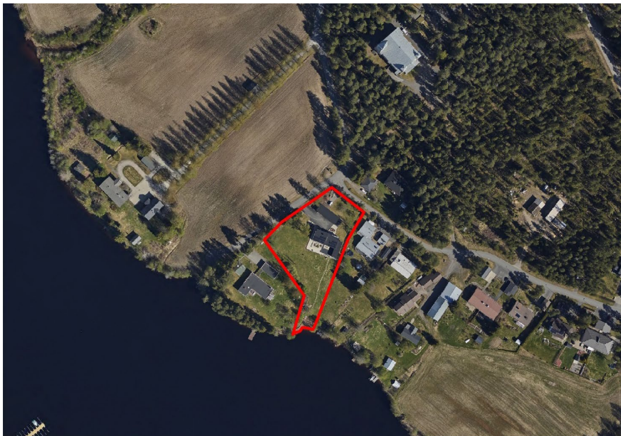
Kuva 2: Ilmakuva. Kaavamuutosalue on rajattu punaisella viivalla.
