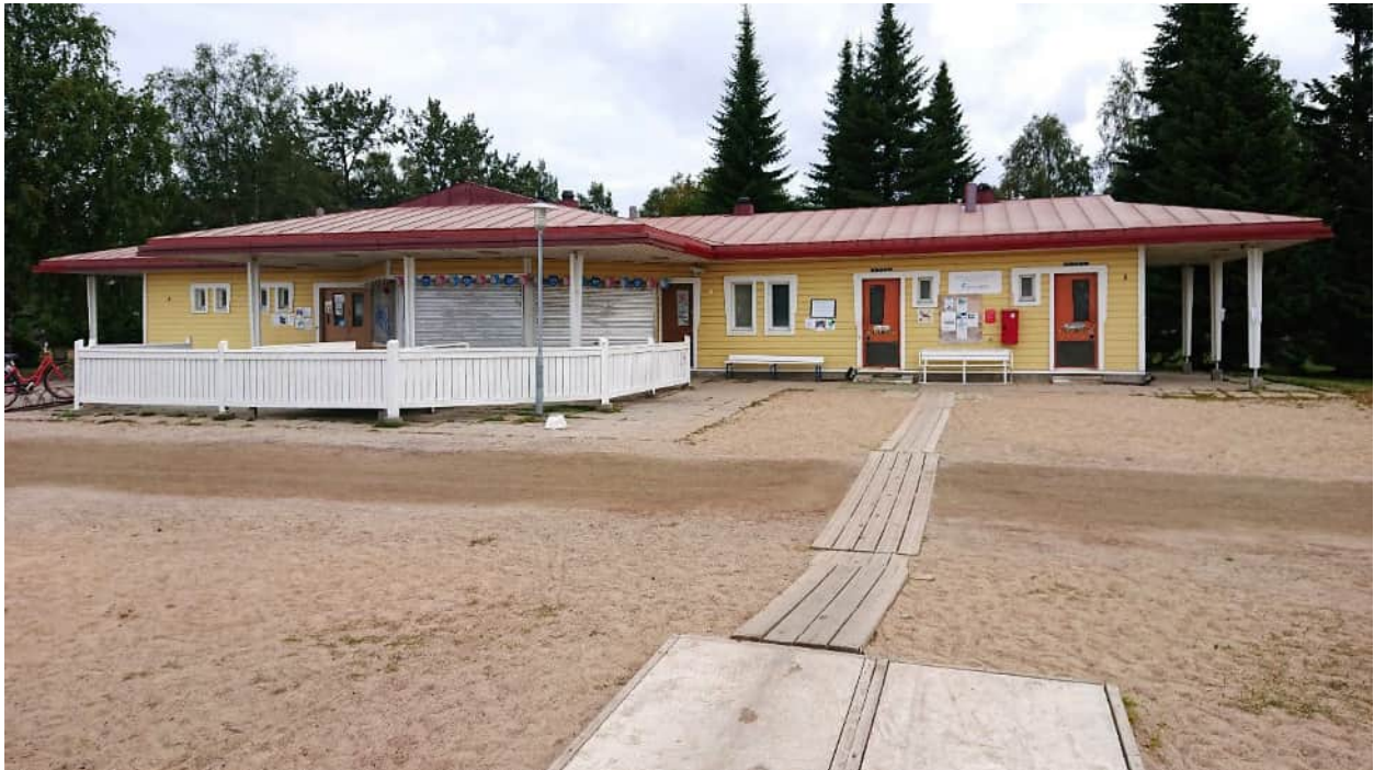
Tuiran uimalan kahvila- ja huoltorakennus elokuussa 2019.
