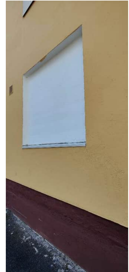
Sisäpihan alkuperäinen ikkuna-aukko on rakennettu umpeen.
