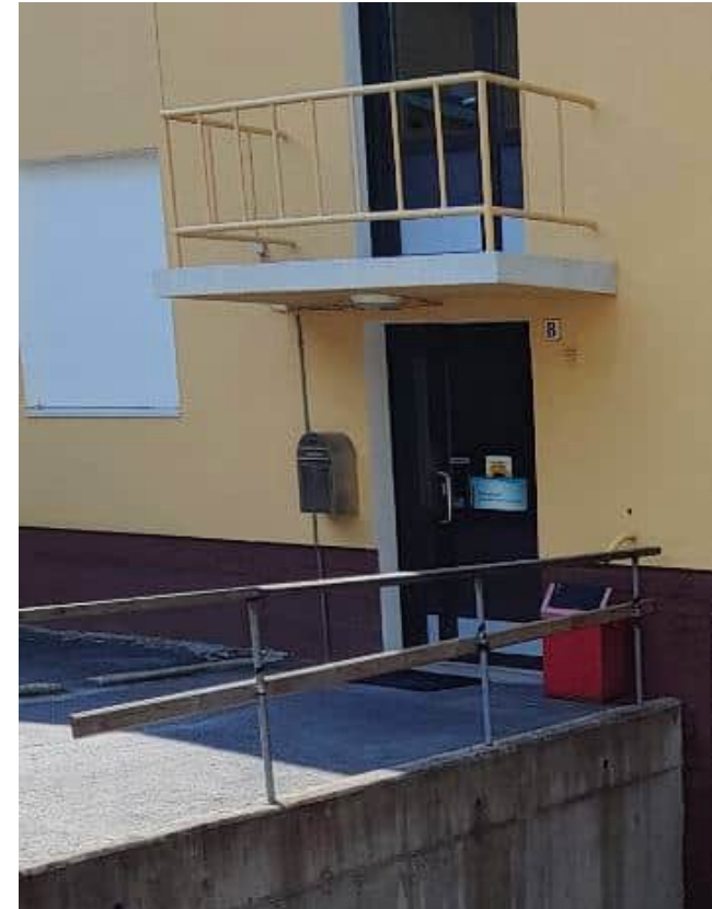
Sisäpihan parveke. Laatta betonia, kaide maalattua terästä. Parveke kaiteineen on uusittu 2015, alkuperäisen mukaisesti.
