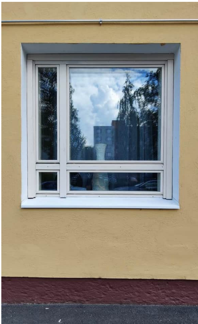
Alkuperäisen pielijaon mukainen puu-alumiini-ikkuna, vuodelta 1995. Ikkunan pellitysten ja syvennyksen sävy valkoinen.
