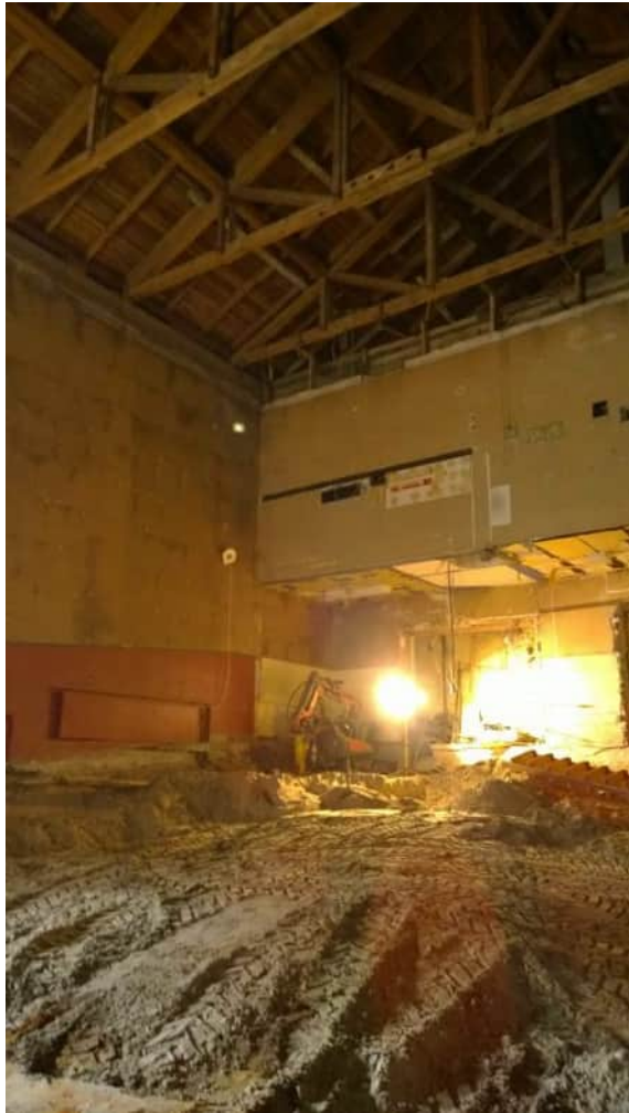
Valokuvia rakennustöiden ajalta. Olevat salirakenteet ja alapohja on purettu.
