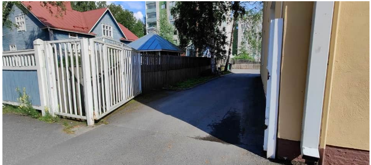
Kalliotien metallirakenteinen, valkoiseksi maalattu portti.
