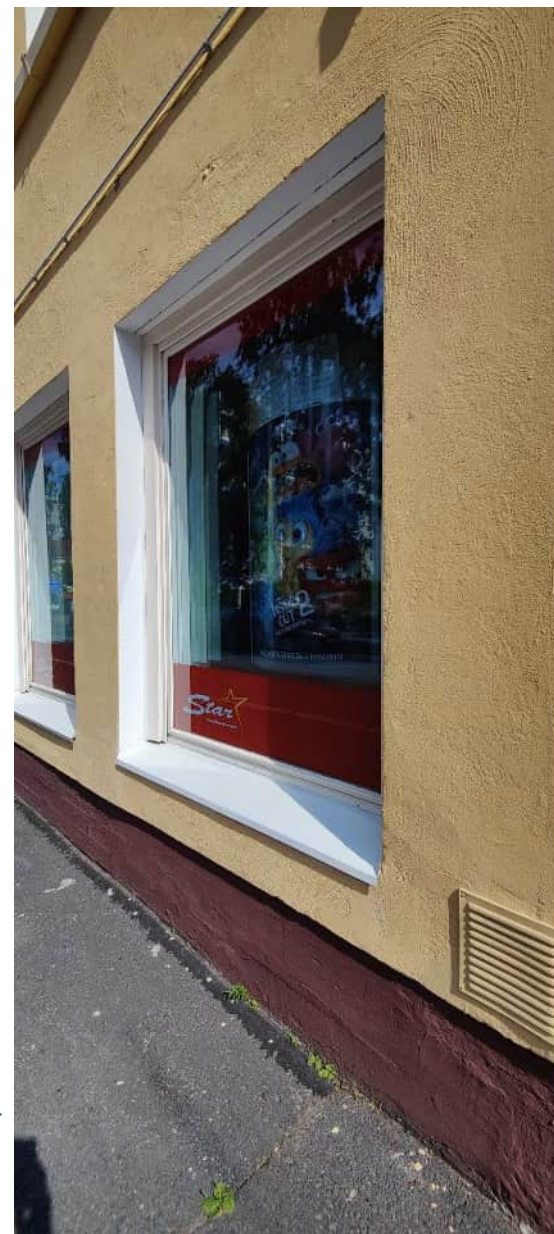
Alun perin liiketilojen, nykyisin aulan puu-alumiini-ikkunat, vuodelta 1995. Ikkunan pellitysten ja syvennyksen sävy valkoinen.
