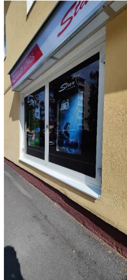
Kalliotien alkuperäinen ikkuna-aukko on korvattu avattavalla vitriinillä.
