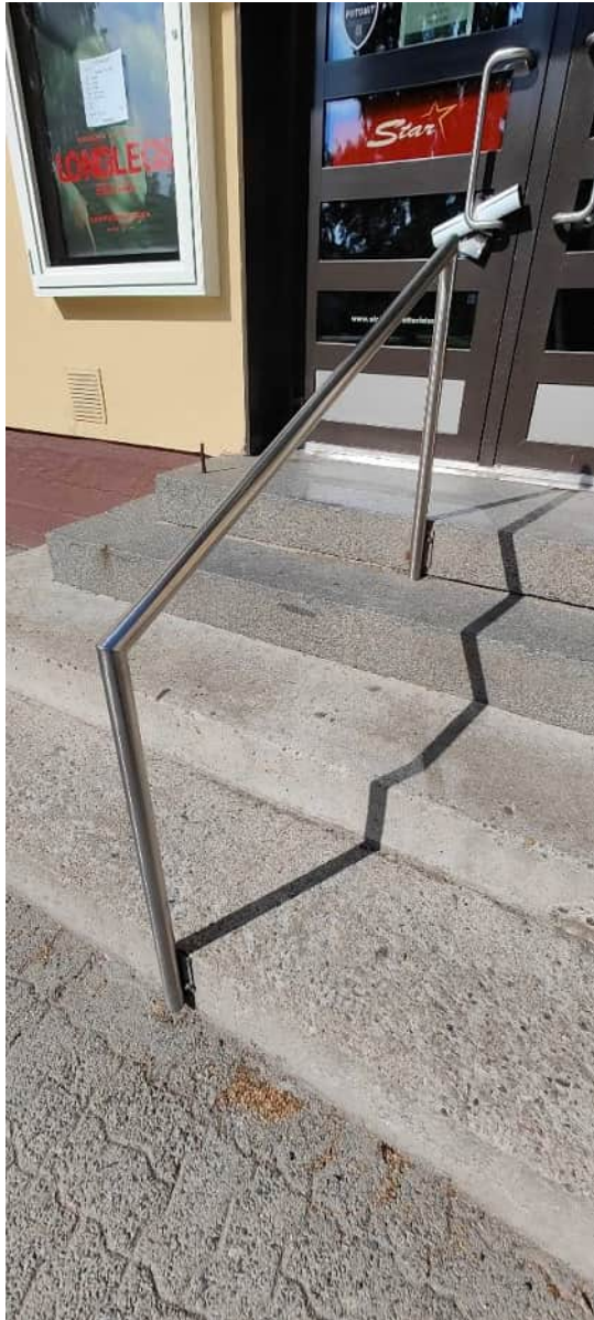
Eteläsivun pääsisäänkäynnin porras. Kaksi ylintä askelmaa graniittia, alemmat askelmat betonia. Kaide RST. Betoniosat 80-luvulta, yläosa 2000-luvulta.
