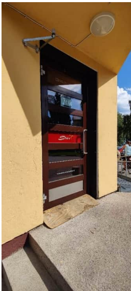
Pääsisäänkäynnin teräs-lasi-ovi, uusittu vetimineen 2004, sävy ruskea
