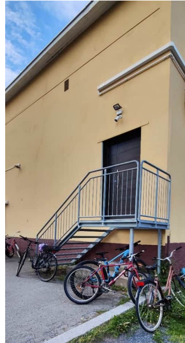
Eteläsivun poistumisporras, sinkittyä teräsritilää, pinnakaide, vuodelta 2016
