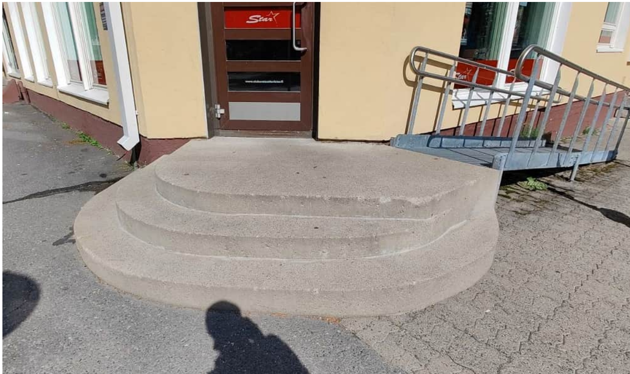
Pääsisäänkäynnin betoniporras ja taso, johon liittyy sinkitty teräsriläluiska. Porras ja luiska vuodelta 2004
