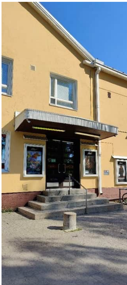
Eteläisivun sisäänkäyntikatos. Katoksen alapinta on ruskeaksi petsattua puupaneelia, etupinta on valkoiseksi maalattua sormipaneelia- Räystääspelti valkoinen.
