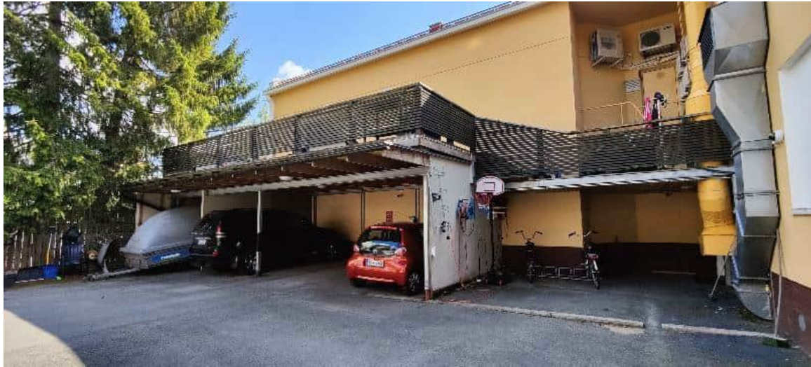
Sisäpihan autosuoja. Kantavat rakenteet sinkittyä terästä ja kertopuuta. Terassiosan kaide puuta.
