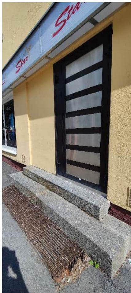
Kalliotien poistumisovi, umpioveen on tehty teippaus jäljittelemään pääsisäänkäynnin lasi-aukkoja. Ovi on vuodelta 2004.
