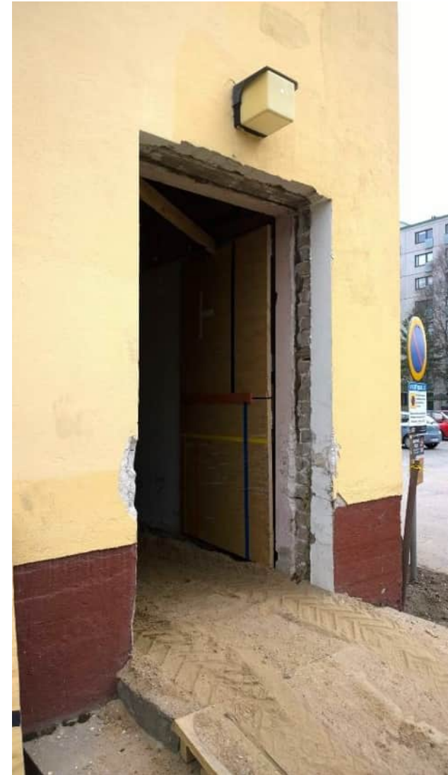
Valokuvia rakennustöiden ajalta. Seinärakenne on nähtävissä oviaukon pielessä.
