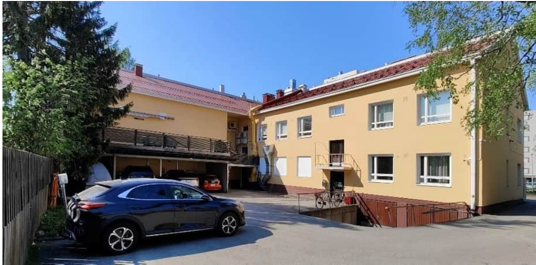
Sisäpihan julkisivut. Alkuperäisiä ikkuna- aukkoja on ummistettu.
