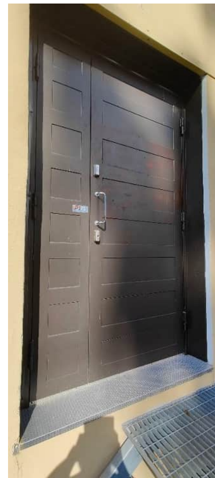
Eteläsivun poistumisovi, umpioveen syvennykset jäljittelevät pääsisäänkäyntien lasi-aukkoja. Ovi on vuodelta 2016.
