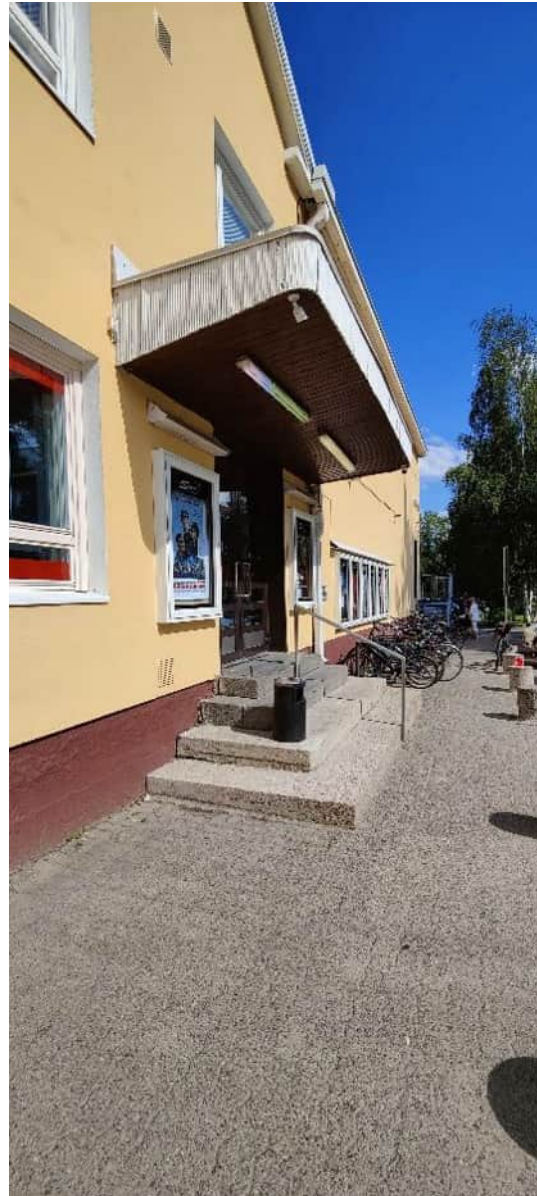
Eteläsivun pääsisäänkäynnin porras. Kaksi ylintä askelmaa graniittia, alemmat askelmat betonia. Kaide RST. Betoniosat 80-luvulta, yläosa 2000-luvulta.
