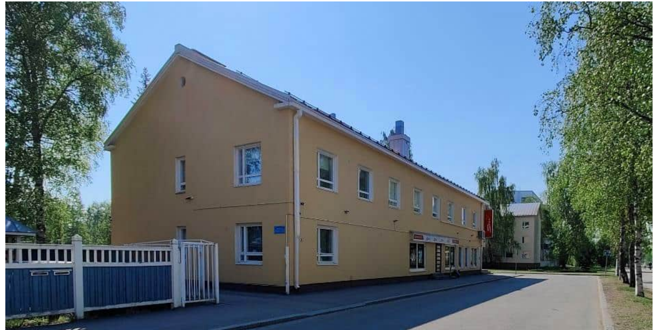
Julkisivu pohjoiseen ja Kalliotielle. Kalliotien alkuperäiset liiketilo- jen ikkunat ja ovet on korvattu vitriinillä tai rapattu seinän tasoon
