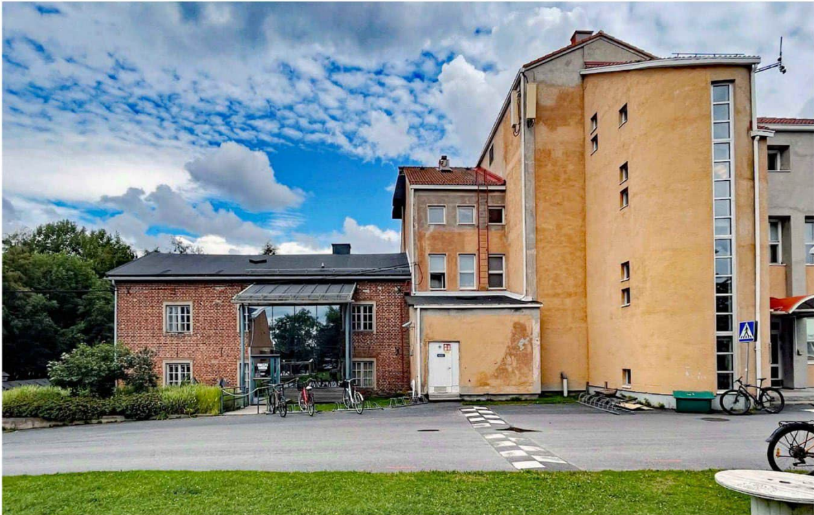
Kuva 9 Mallassauna vasemmalla ja kutomorakennus oikealla. (Kuva: Lukkaroinen arkkitehdit Oy/rakennushistoriaselvitys, Maisa Seppänen 2023).
