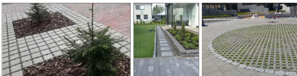
Kuva 9. Nurmikiviä sekä laatan ja sorapinnan yhdistämistä. Kuvat vasemmalta: Pihakivi.com, RudusPiha, Eija Toivonen.
