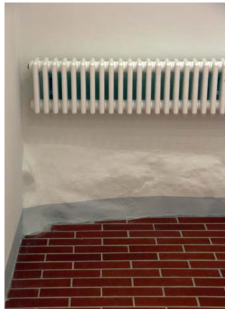
Seinän alaosassa näkyy vanhan 1800-luvun perustuksen lohkokivipintoja.
