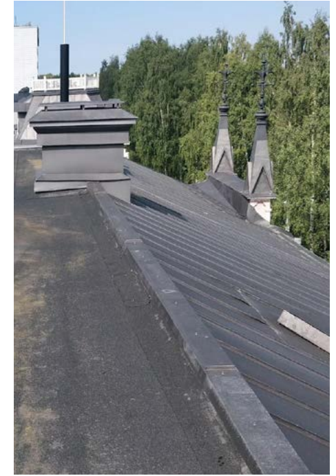
Ojakadun sisäpihan puoleisella lappeella on bitumihuopakate. KUVA: Kattotutka Oy
