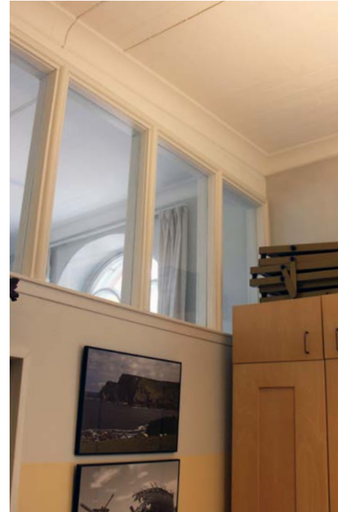
Toimistohuoneen yläosan lasitusta.
