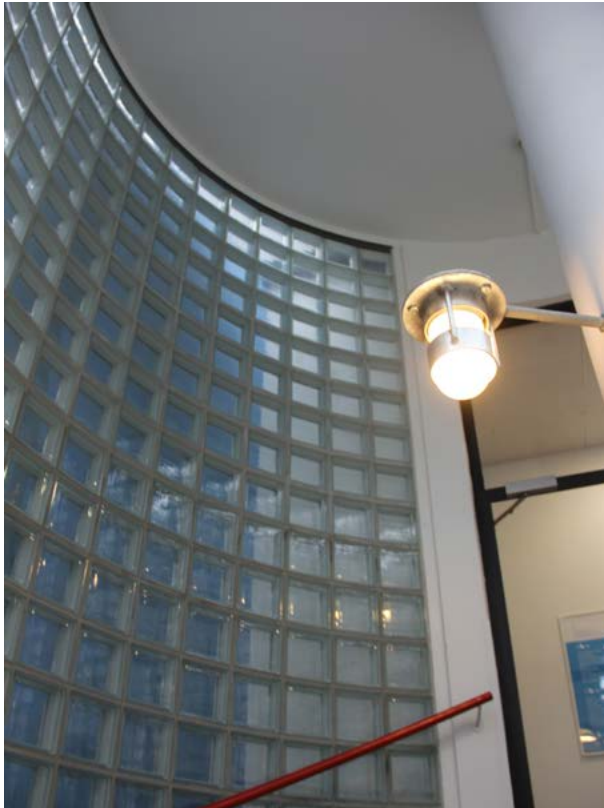
Lasitiilistä muurattu pääporrashuone on valaistu sisäpuolelta varrellisilla seinävalaisimilla. Kulttuurikeskuksen pystysuoran liikenteen halutaan tehdä näkyväksi.
