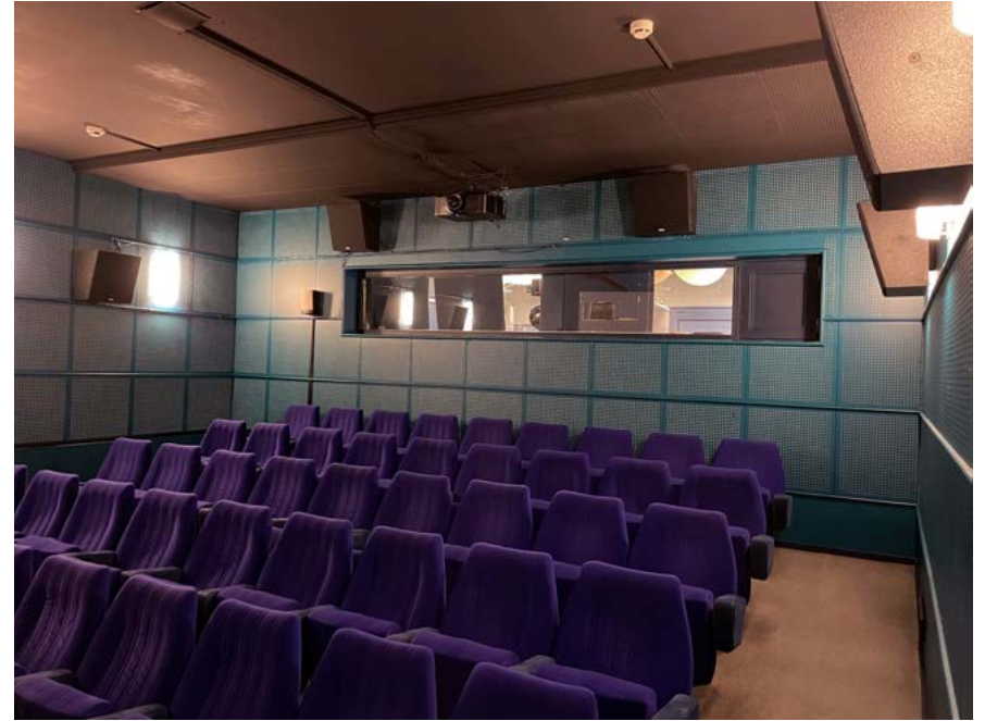
Näkymä elokuvateatterin takaosaa kohti. Salin seinät on vuorattu metallikuorisilla akustiikkaelementeillä.
