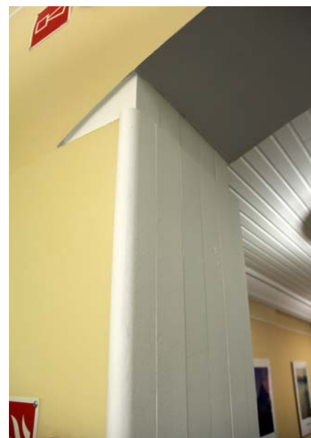
Käytävän oviaukon muotoaihe esiintyy myös Valvegallerian vuoden 1925 kattopalkissa.
