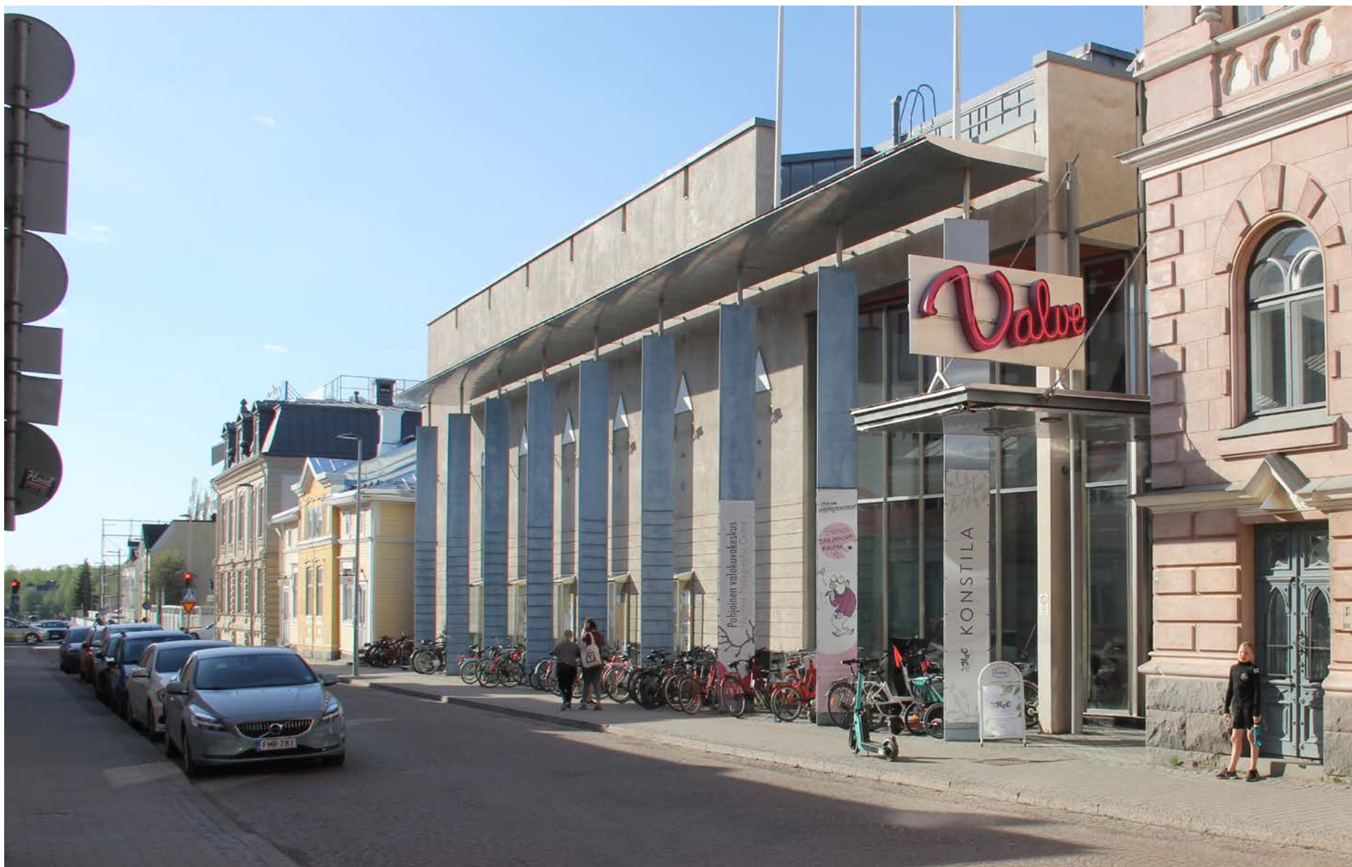
Uuden osan pääjulkisivu asemoituu osaksi Hallituskadun alkupään rikasmuotoista historiallisten fasadien sarjaa. Valvesalin betonijulkisivu kätkeytyy sinisten betonipilareiden muodostaman rivistön taakse. Julkisivun ikkunattomuus on korvattu seinään sijoitetuilla lasivitrineillä.
