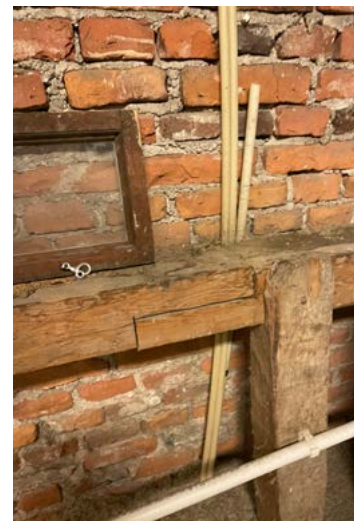
Vesikaton kannatusrakenteiden lovettuja puuliitoksia.
