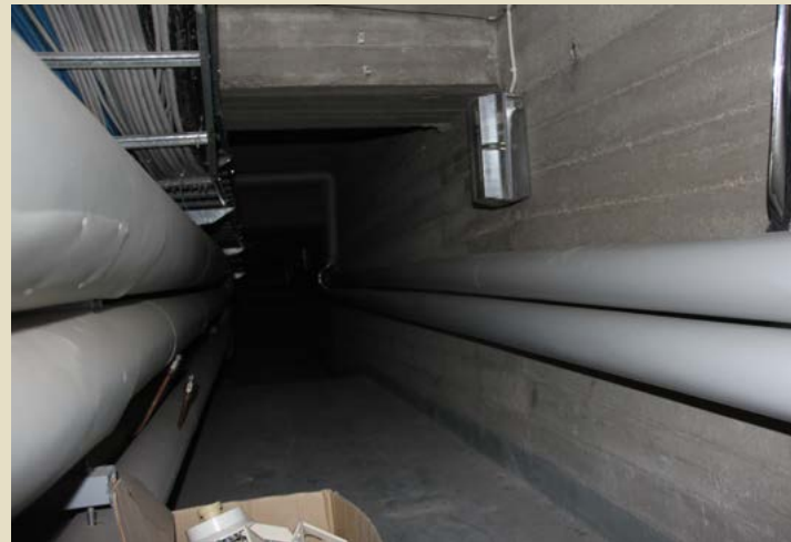
Maanalainen putkikanaali kulkee vanhan osan päästä päähän.
