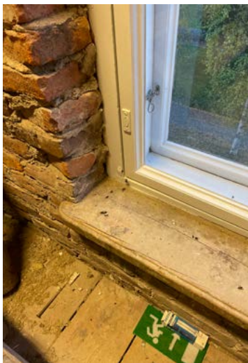
Ullakon uusittu ikkuna ja vanha puusta muotoiltu smyygilauta.
