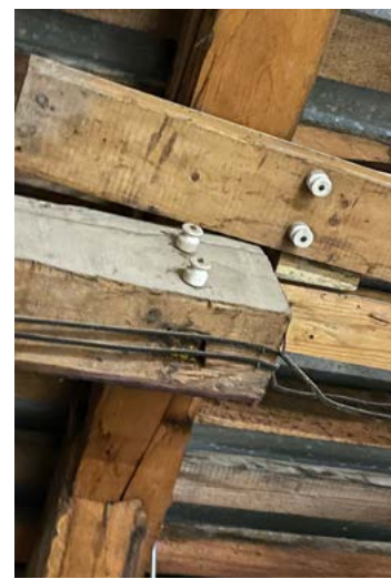
Vesikaton alapintaa ja puhelinyhtiön vanhaa johdotusta.
