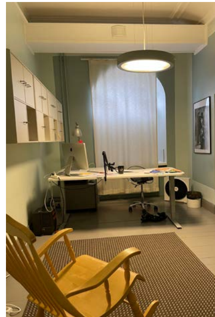
Jaetun toimistohuoneen 213 puolikkaassa ikkunan päälle on tehty ilmanvaihtokanava.
