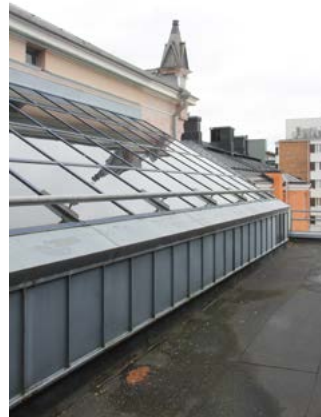
Vanhan ja uuden osan välissä on sisääntulokäytävän pulpetti-mainen lasikatto.
