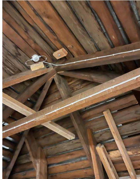
Vesikaton alapinnan rakenteita. Peltikate on tehty laudoituksen päälle ilman aluskatetta.
