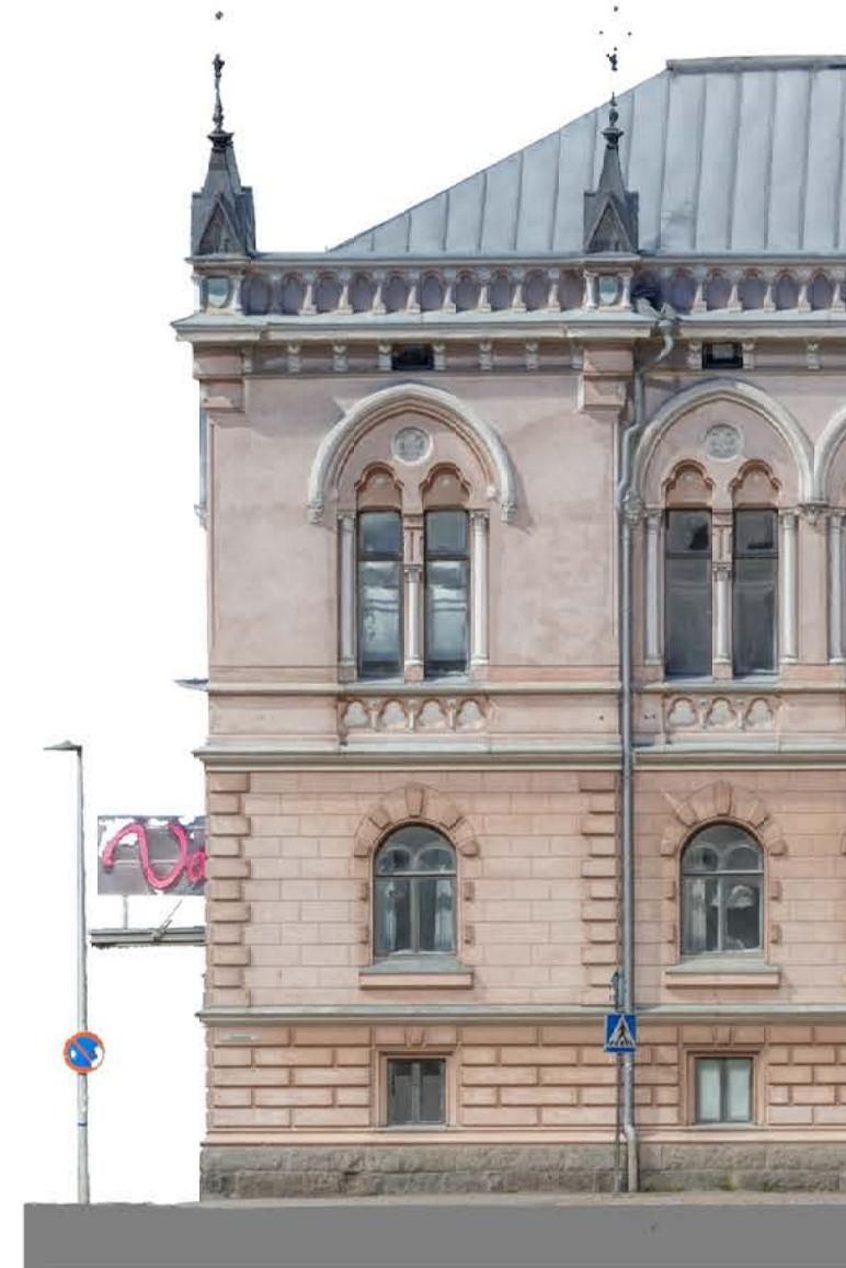
Vanhan osan julkisivuissa on kaksi tyylikerrostuma. KUVA: Oulun kaupungin Tilapalvelut
