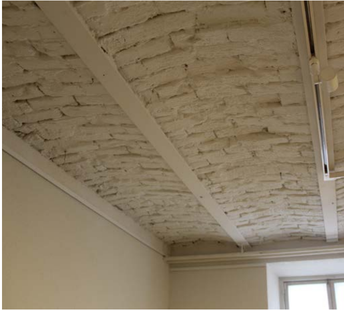
Peruskorjauksen yhteydessä tilasta poistettiin levyrakenteiset alakatot. Niiden alta tuli esiin rautakiskojen kannattama kappaholvi. Holvin suunta on harjan suuntaan nähden poikittainen.
