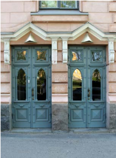
Ojakadun kaksi ovea. Oikeanpuoleinen johtaa porrashuoneeseen.
