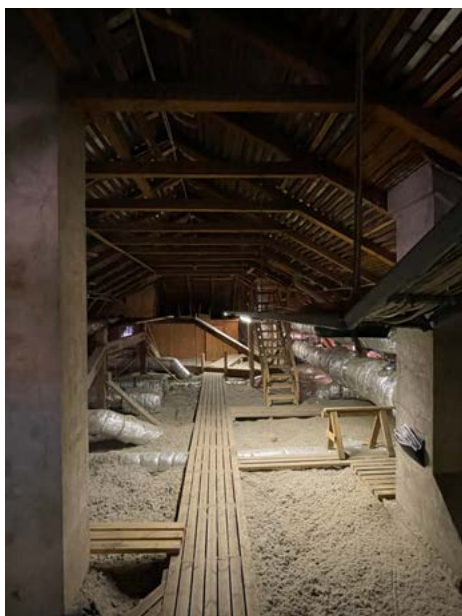
Näkymä ullakon pohjoispäädystä. Palopermantoa peittää lisäeriste ja puiset kulkusillat.
