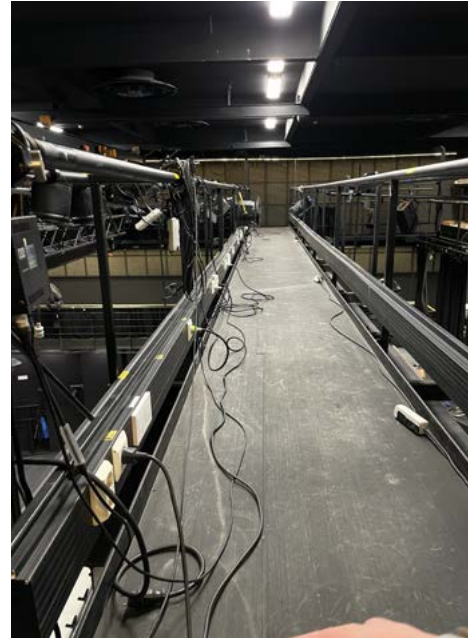
Salin kolmannen kerroksen tekniikkaparvelta on poikittaiset sillat, joita pitkin voi siirtyä puolelta toiselle.
