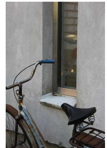
Sama ikkuna ulkopuolelta.
