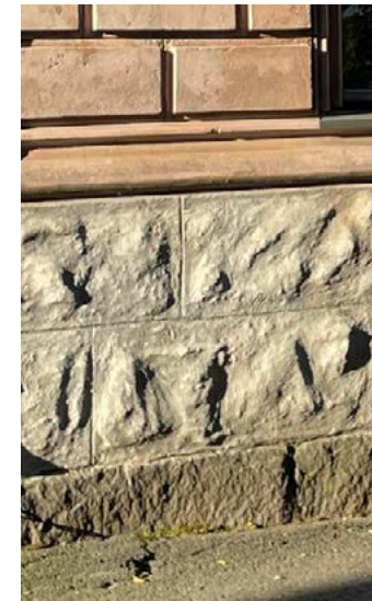
Ojakadun puolella kivijalkaa on vahvistettu ruiskubetonilla. Päädyssä kivijalka on tiliverhoiltu.
