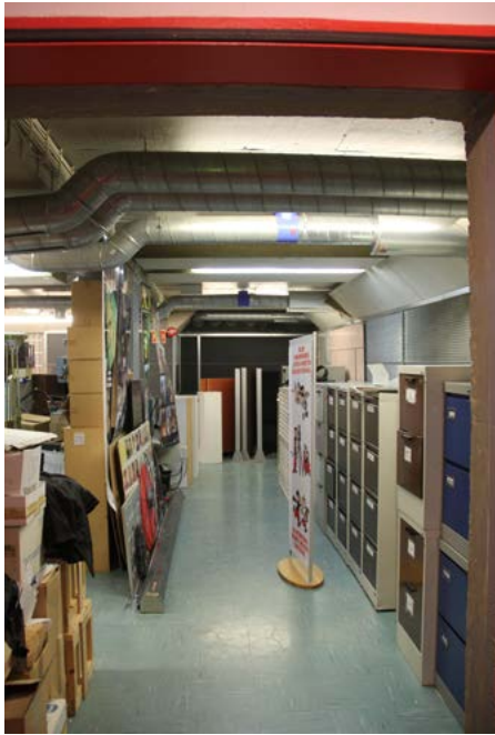
Varajohtokeskuksen tiloja hyödynnetään nykyisin arkisto- ja varastotilana.
