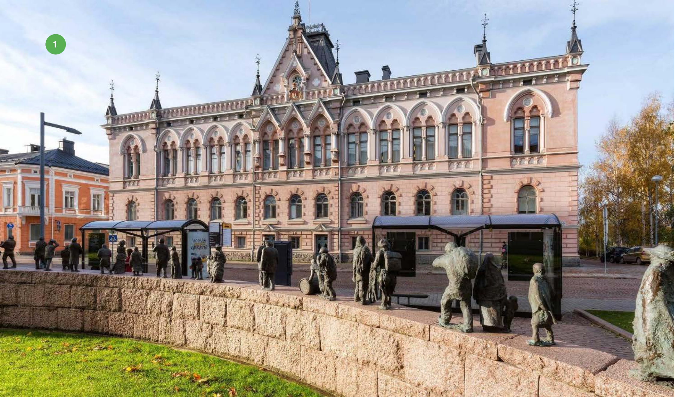
Näkymä Kaupungintalon länsipuolelta Maria Silfvanin puistosta Valveen suuntaan. Etualalla on Sanna Koiviston teos "Ajan kulku". Oulun Kauppakamari lahjoitti veistoksen Oulun kaupungille 400-vuotisjuhlan kunniaksi. Kokonaisuus muodostuu 32 punagraniittijalustan päällä olevasta pronssisesta pienoisveistoksesta, jotka kuvaavat kaupungin elinkeinoelämän historiaa ja kehitystä. KUVA: Oulun kaupunki
