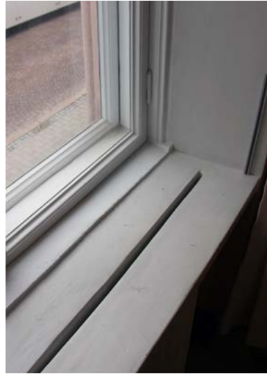
Toisen kerroksen toimistossa ikkunapenkki on puuta ja siihen on tehty ilman kiertoa tehostava viilto.
