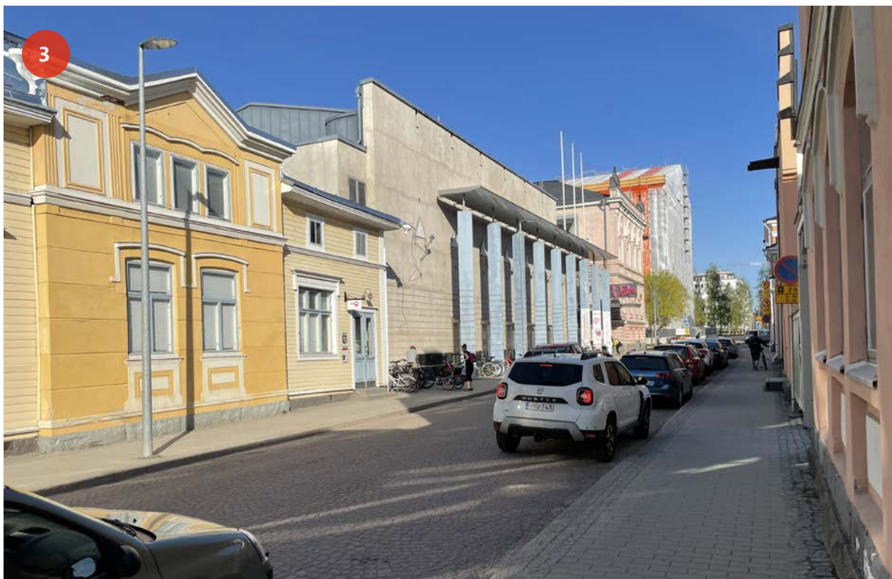
Etualalla Byströmin talon sivurakennus Nappi ja sen jatkeella Kulttuuritalo Valveen uudisosan betonijulkisivu. Taustalla näkyy Valveen vanha osa sekä huputettu kaupungintalo.
