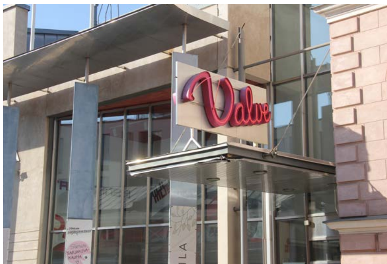
Sisäänkäyntiä suojaava katos ulottuu jalkakäytävän yli. Katoksen päällä olevassa valokyltissä on vielä Valveen vanha logo.
