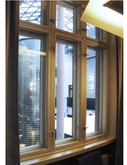
Sisäpihalle suuntautuva kuusiruutuinen ikkuna toimistohuoneessa. Ikkunaan on myöhemmin lisätty palolasi.
