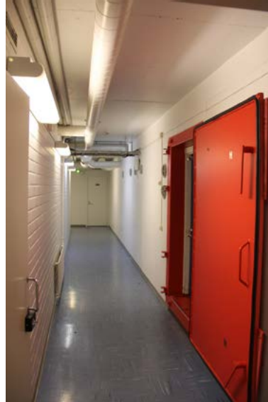
Välikäytävä suojatilojen ja teknisten tilojen välissä. Suojatilan seinät ovat vankkaa betonia.
