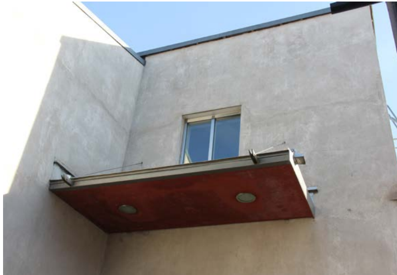
Lastauslaituria suojaava katos on ripustettu vetotangoilla. Katoksen yläpuolella on toisen kerroksen päätyaulan ikkuna.
