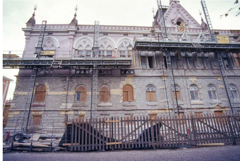
Torikadulta otettu kuva julkisivutyömaalta. Vanha rappaus on poistettu ja rappaus työ on aloitettu vasemmasta yläkulmasta. KUVA: Oulun Tilapalveluiden arkisto.
