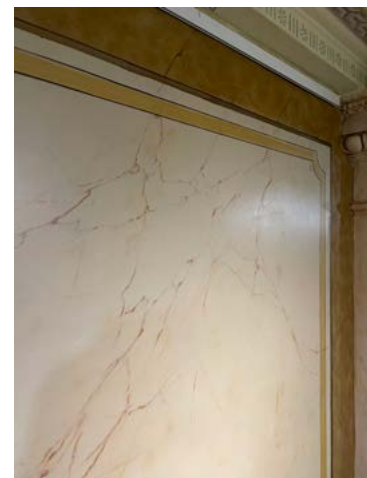
Seinään on maalattu marmorointi. Maalipinta on kiillotettu.
