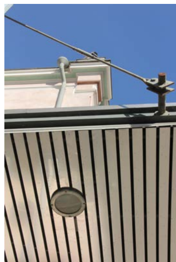
Lippamaisen katoksen alapintaa ja ripustutuksen yksityiskohtia.
