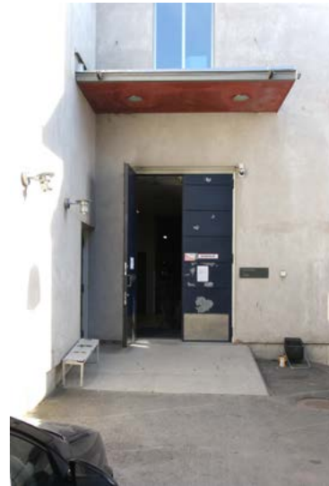
Betoniluiskalla varustettu lastausovi johtaa tavarahissille ja Valvesaliin.
