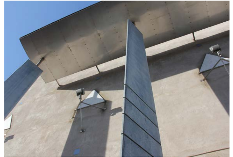
Pilarit kannattelevat ruostumattomasta teräksestä tehtyä siipimäistä katos- ta. Katos jatkaa vanhan osan listoituksen vaakalinjaa.
