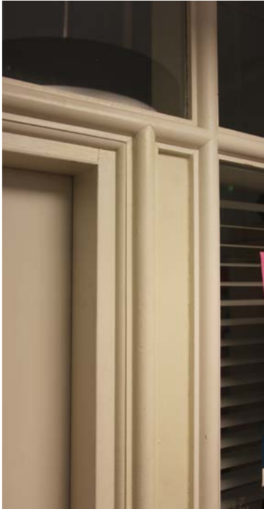
Yksityiskohta väliseinän lastiuksesta, jossa on käytetty puolipyöreää listaa.
