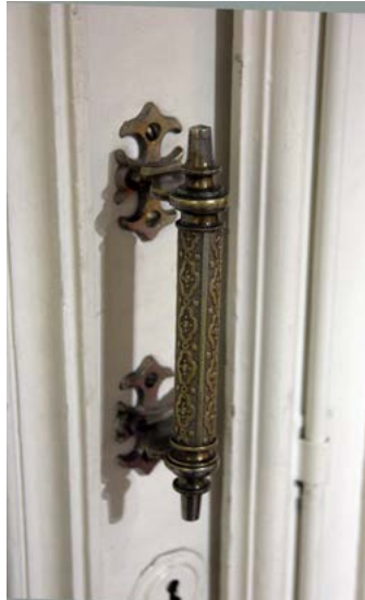
Pääaulaan ulko-oven sisäpuolinen messinkivedin.
