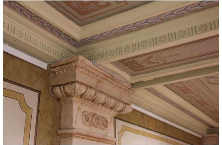
Käytävää jäsentävän pilasterin ja palkin liitoskohta. Klassistisia aiheita runsaasti viljelevä koristemaalaukset on toteutettu katto- ja seinäpintojen lisäksi myös listoihin.
