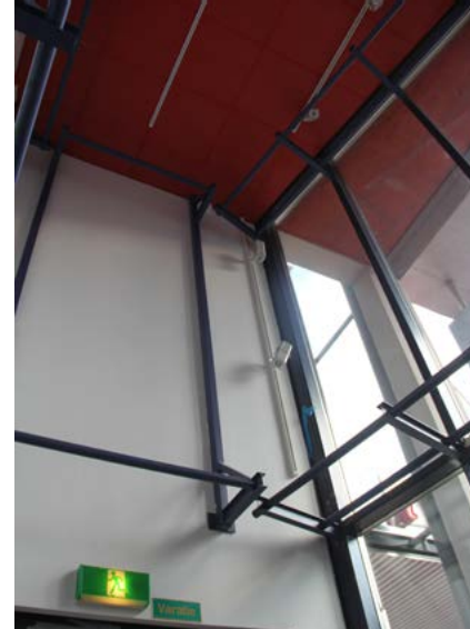
Hallituskadun puolella on korkea tila, jonne suunniteltu näyttävä veistos ei toteutunut.
