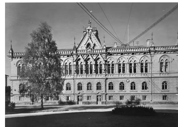
Kuvassa kaupungintalo, josta lähtee kaapelit kohti Seura-huonetta. Puhelinyhdistyksen huoneiden kohdalla julkisivaissa on kello. KUVA: Kansallisarkisto, Oulun kauppareura ry:n I arkisto
