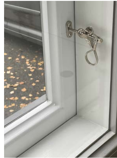
Sisään ja ulos avautuva kaksilasinen ikkuna päädystä. Ikkuna on ennallistettu.
