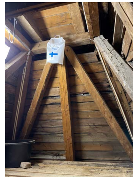
Keskitornin rakenteet on tehty käsin veistettyä piiruista.
