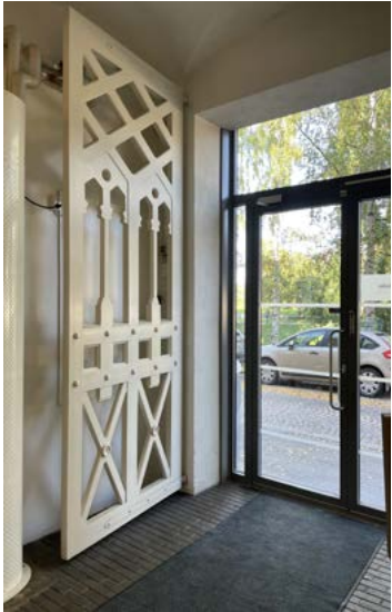
Ojakadulle sisäänkäynnin portti on tehty alkuperäisen mallin mukaan. Uusi ulko-ovi on teräsrunkoinen.
