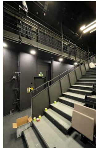
Teleskooppikatsomon alaosa avattuna. Taustalla näkyy akustoivia seinälevyjä.
