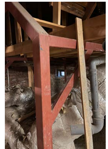
Polkupyörävinnssille tehtiin 1970-luvulla teräksinen runko.
