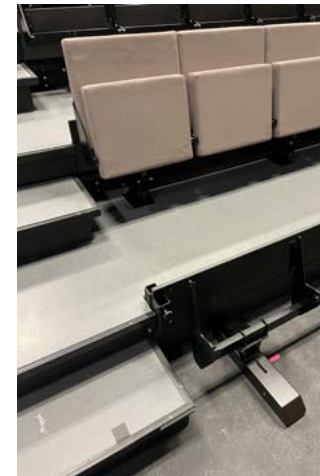
Ylärivissä on klaffi-istuimet asennettuina. Alarivissä näkyy istuinelementtien teäsrunko..
