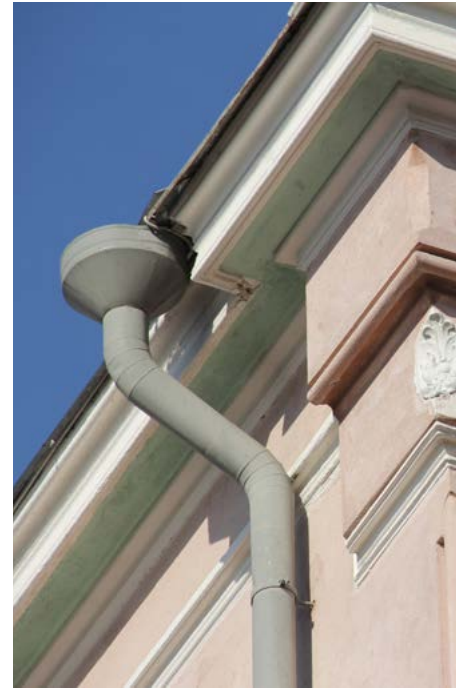
Sadevesi ohjataan jalkaränneillä räystäällä oleviin suppiloihin. Syöksytorvet ovat pyöreät.
