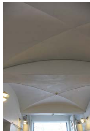
Ojakadun käytävän ristiholvi
