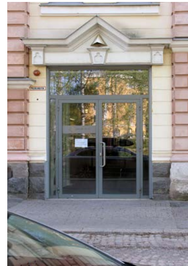
Sisäpihalle johtavan solan uusi metallirunkoinen ulko-ovi.
