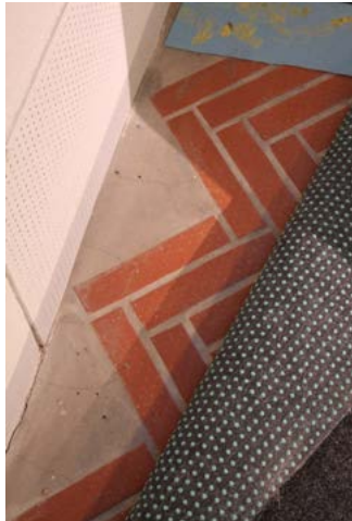
Gallerian lattiasa on punaisella tiililaatalla tehty kalanruotokuvio.
