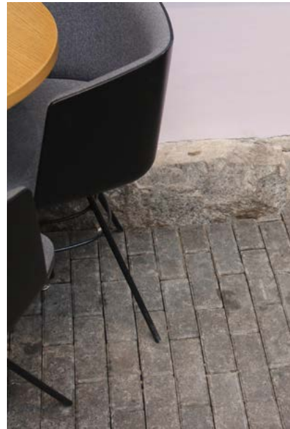
Sisäpiha on ladottu betonisella katukivellä. Pihan ja seinän rajapinnassa näkyy vanhaa kivijalkaa.
