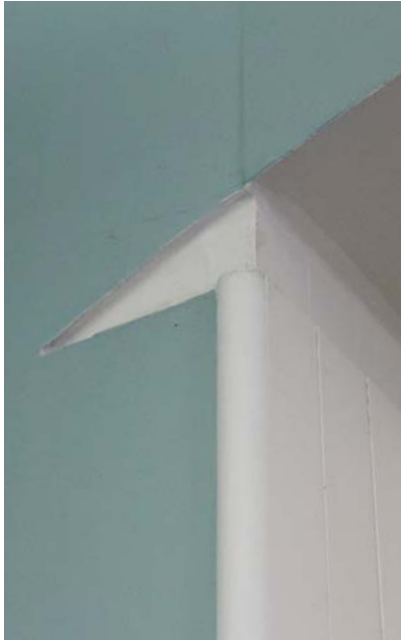
Käytävää jakavat seinät toimivat ilmanvaihtokanavien koteloina. Kuvan yksityiskohta esiintyy Valvegallerian kattopalkissa.
