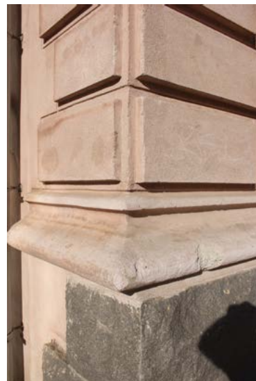
Nurkkaharkotusta ja muurattu lista jalustan päällä.
