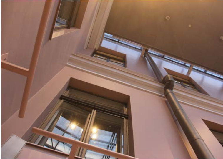
Vanhan osan julkisivu on käsitelty ulkoseinän tavoin. Rappaus on sileä.
