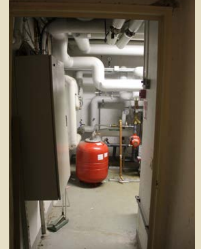
Kaukolämmön lämmönvaihdin.
