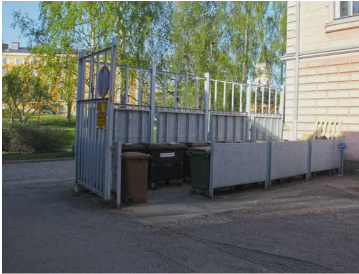
Aidan yhteyteen on tehty kattamaton jäteaitaus.
