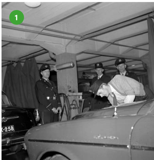
Poliisivankilan autotalli oli matala. Kuvassa näkyy betonista paikalla valettua runko- ja välipohjarakennetta. KUVA: Museovirasto JOKA
