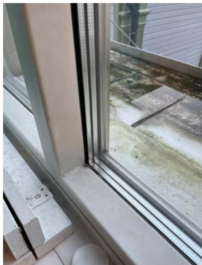
Toisen kerroksen päätyaulan ikkuna sisäpuolelta. Ikkunassa lasielementti on kiinnitetty kiinteään teräskarmiin.
