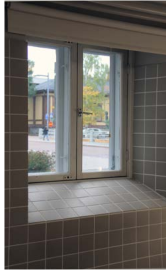
Ensimmäisen kerroksen ikkuna savipajasta. Sisäänpäin kallistuva ikkunapenkki on laatoitettu.
