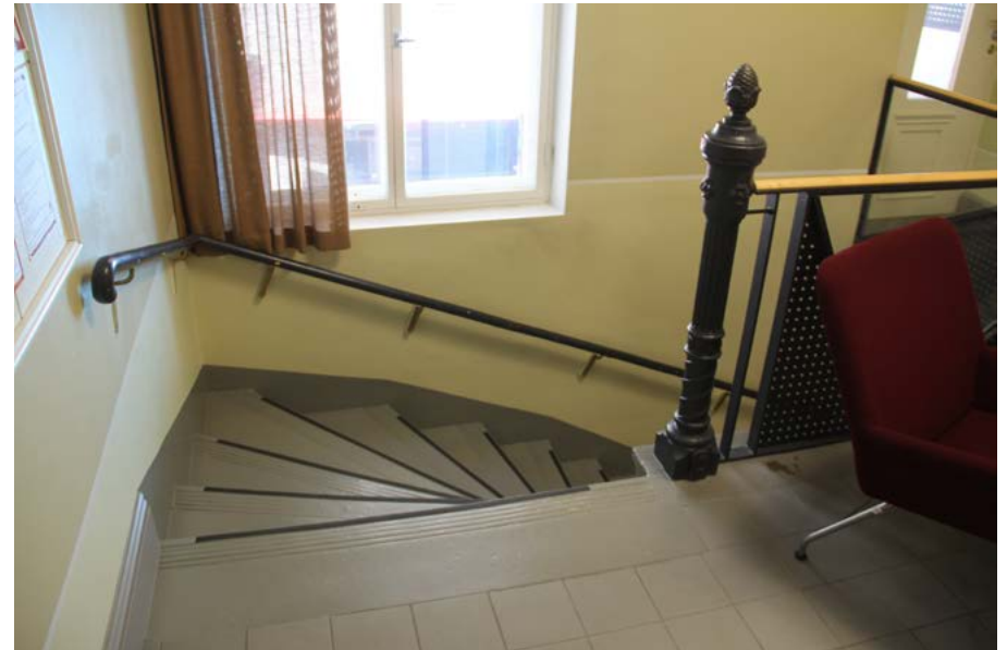
Näkymä toisen kerroksen tasanteelta. Edessä näkyvä ikkuna suuntautuu sisäpihalle.
