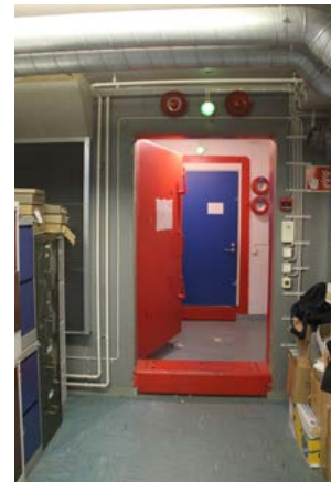
Suojatilan ovia ja kynnyksiä.
