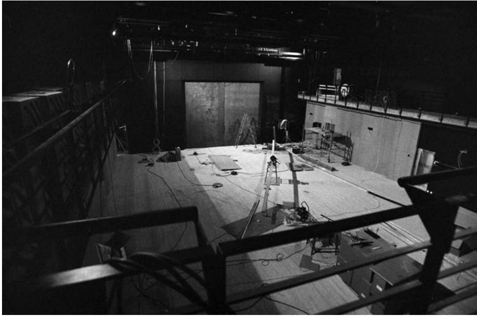
Nukun monitoimisali rakennusvaiheessa. Kuva on otettu nykyisen tarkkaamoparven kohdalta salin päänäyttämöä kohti. KUVA: Museovirasto JOKA
