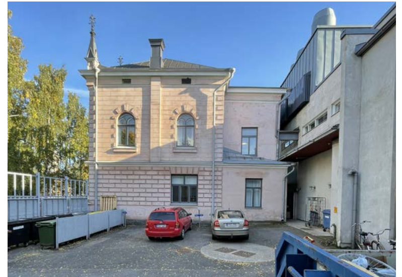
Vanhan osan länsijulkisivu suuntautuu sisäpihalle. Oikealla näkyvä osa kuuluu alkuperäiseen rakennukseen, vaikka sen rappaus ja ikkunajako ovat poikkeavat.
