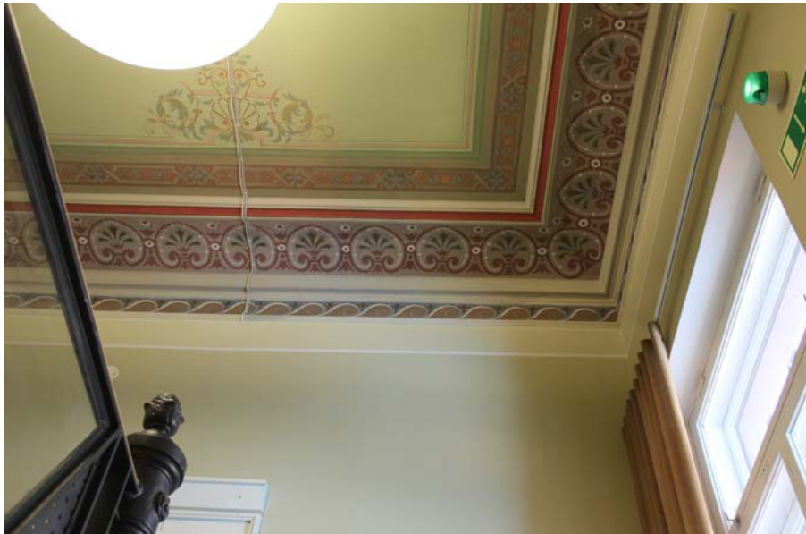
Näkymä pääportaan puolivälistä kohti koristeellista alakattoa. Vasemmalla näkyvässä kaitteessa on yhdistetty alkuperäinen valurautatolppa ja moderni lasikaide.
