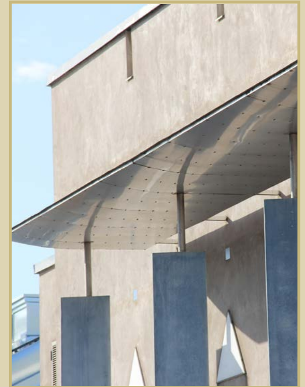
Uudisosan huonetilat sijoittuvat vuonna 1992 valmistuneeseen betonirunkoiseen rakennukseen.
