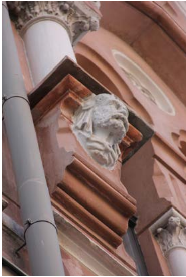
Kipsikoristeet on valettu 1890-luvulla yleisesti myynnissä olleilla muoteilla.
