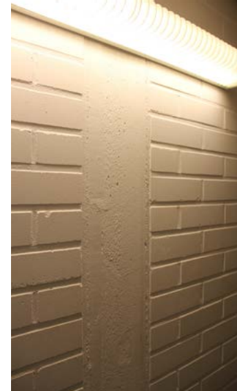
Puhtaaksimuurattu väliseinää betonipilarin kahden puolin.
