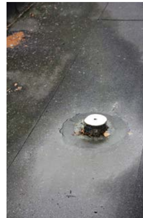
Tasakatolla on sisäpuolinen vedenpoisto. Kuvassa katto-kaivo ja sitä suojaava sihti.
