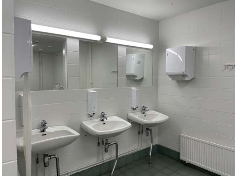
Yleisöwc:n etuhuoneen kalustusta. Laatoitettuja seiniä on uudistettu maalaamalla.
