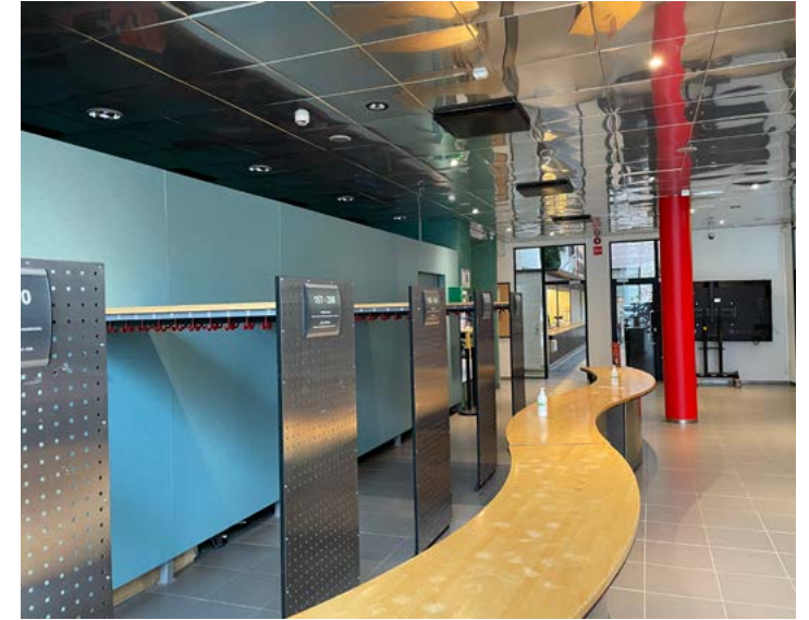
Naulakoita on lyhennetty ja kevyen väliseinän taakse on tehty varostilaa.
