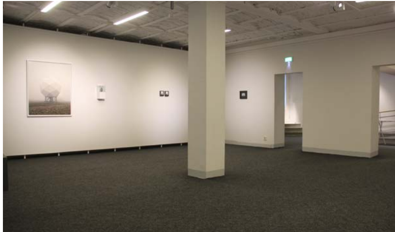
Toisen galleriahuoneen keskellä on betonipilari. Se kannattaa kahdesta rautakiskosta tehtyä välipohjapalkkia.
