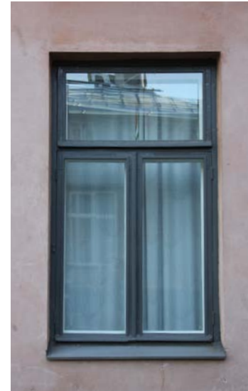
Ojakadun puolella ensimmäisen kerroksen ikkunat ovat T-mallisia.
