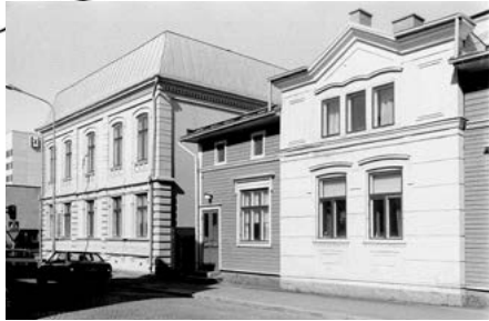
Kuvassa oikealla on uudisosan suunnitteluvaiheessa keskustelua herättänyt Byströmin Nappi. KUVA: Arkkitehtitoimisto Laation arkisto
