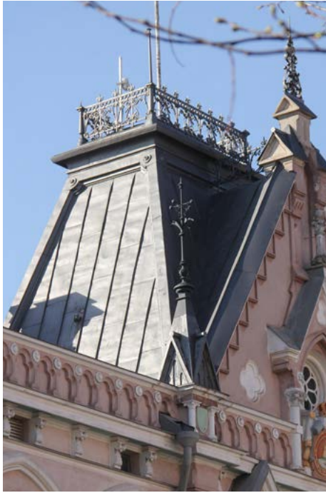
Tornin selkätaitteet on vahvistettu. Tornin laella on rautakaiteella reunustettu tasanne.
