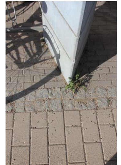
Pilarin alapään liittyminen katuki- vetykseen.
