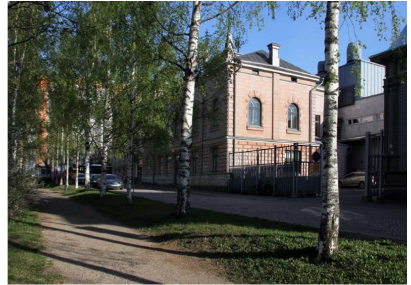
Kulttuurikeskus Valveen vanhan osan länsipääty Ojakadun suuntaisesta puiston suunnasta nähtynä.
