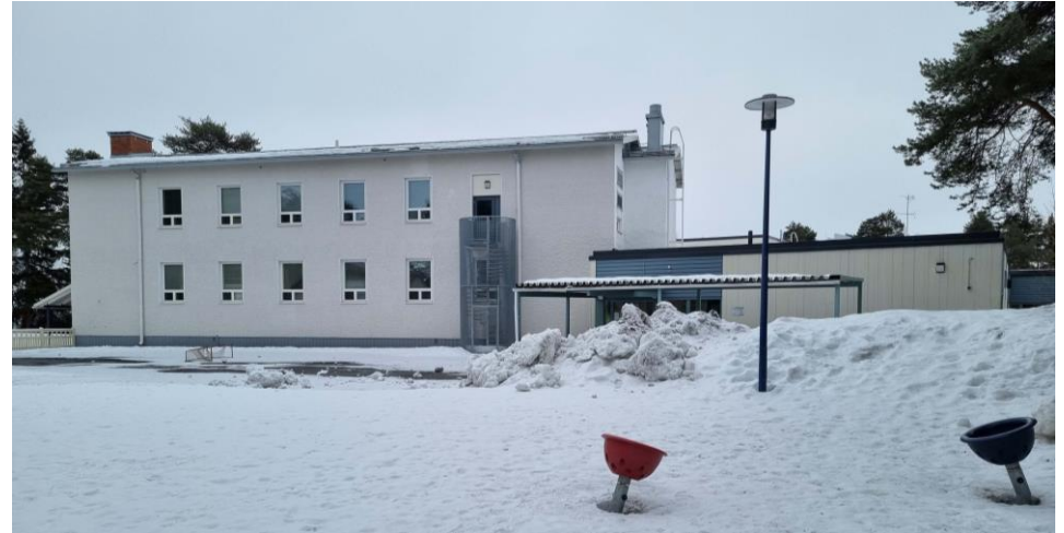
Kivikoulun julkisivu pohjoiseen. Rakennuksen länsipäättyyn yhdistyy vuonna 1978 valmistunut laajennusosa.
