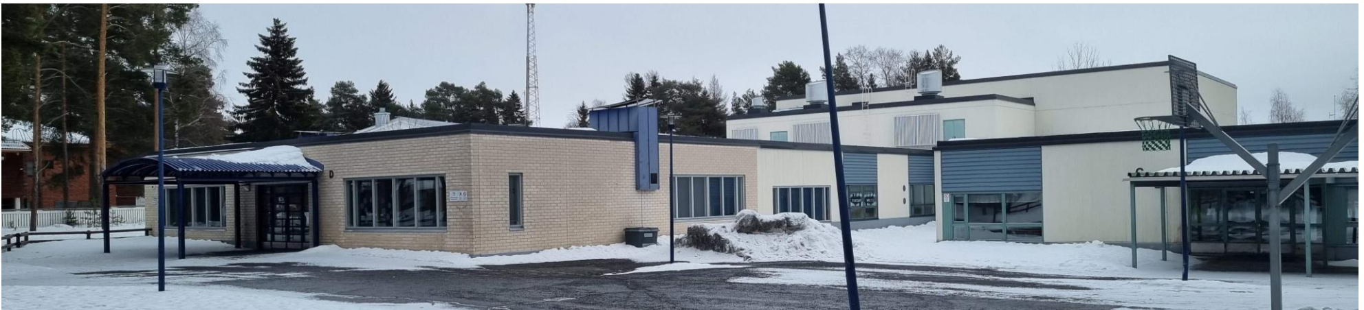
Koulurakennus kuvattuna idän suunnalta. Kuvassa erottuu luokkasiiven laajennusosan muusta rakennuksesta poikkeava julkisivumateriaali. Kuvassa oikealla alkuperäinen sisäänkäynnin katos. Takana erottuu liikunta- / juhlasalin massa muusta koulurakennuksesta korkeampana.
