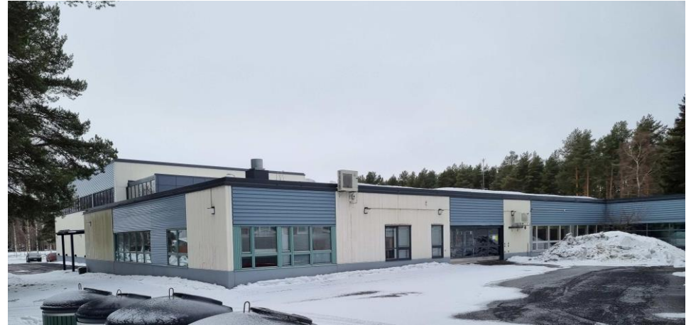
Koulurakennusta kuvattuna koillisesta. Keittiön alueella tehdyistä korjaus- ja muutostöistä kertovat alkuperäisistä poikkeavat ovi- ja ikkunarakenteet.
