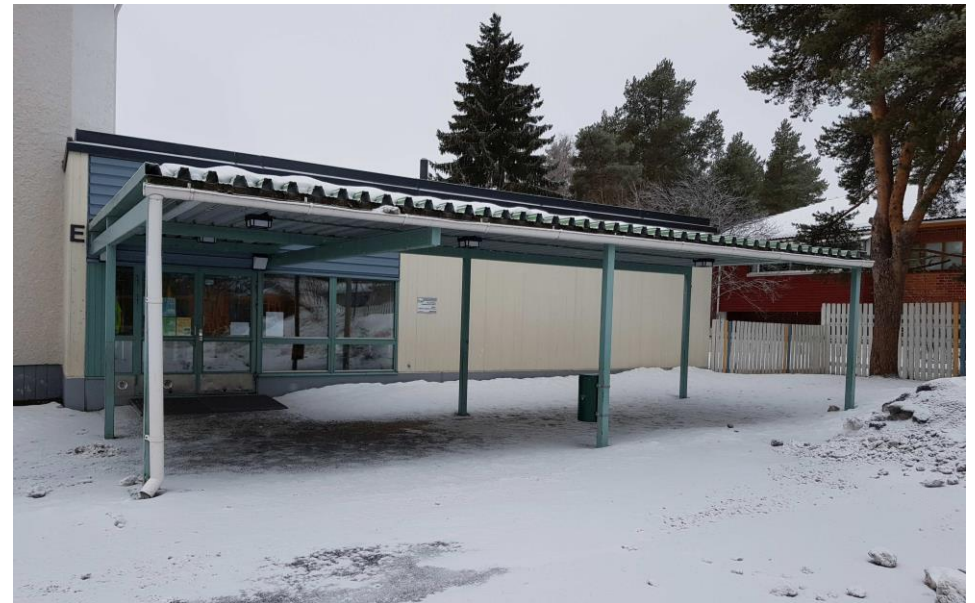
Alkuperäiset katokset ovat hyvin pelkistetyt: rungot ovat teräsputkea, katteena on poimulevy.
