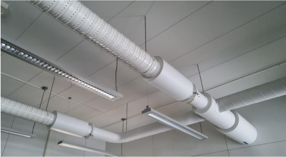
Luokkahuoneissa on erilaisia sisäkattoverhouksia. Ilmastointikanavat erottuvat tiloissa hallitsevina.
