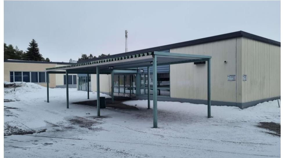
Alkuperäiset katokset ovat hyvin pelkistetyt: rungot ovat teräsputkea, katteena on poimulevy.
