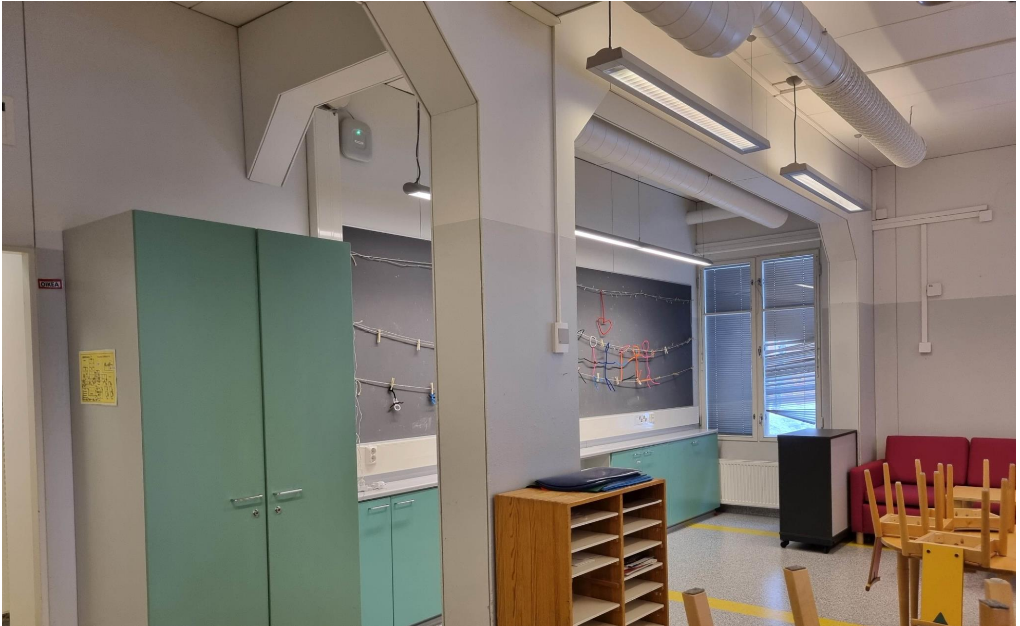
Rakennuksen pohjoiskulmassa sijaitsevan luokkahuoneen paikalla ovat alun perin sijainneet opettajan asuinhuoneet. Niistä kertovat enää seinien purkamisen jälkeen jääneet koteloidut tukirakenteet.
