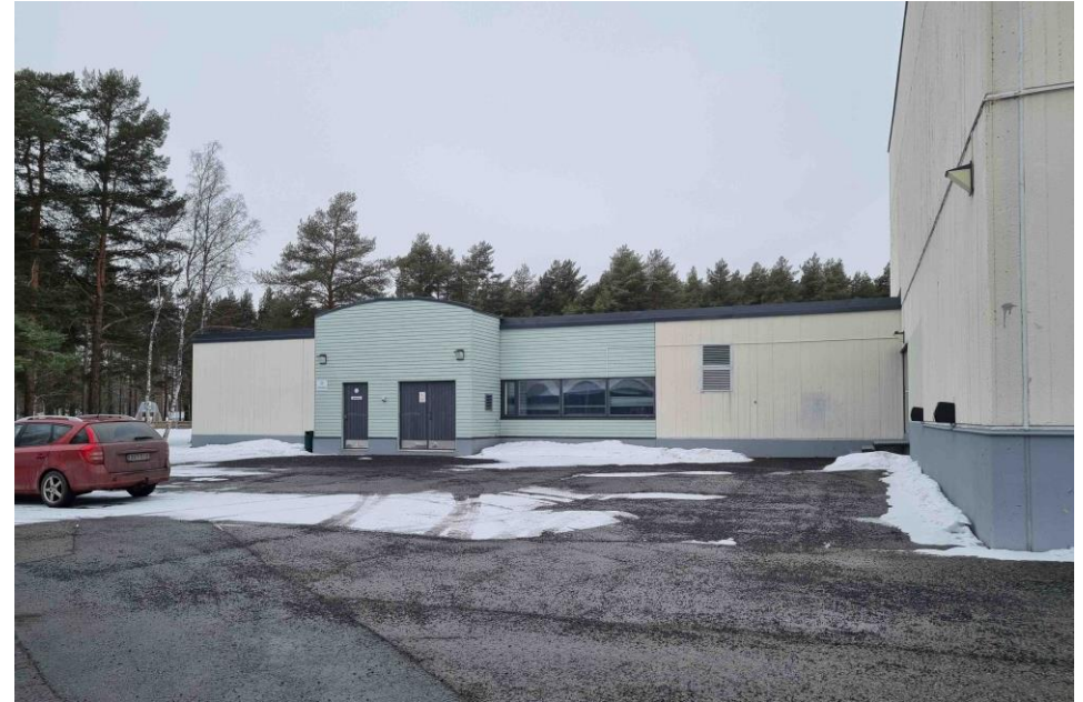
Koulun lounaispäätyyn on rakennettu 2000-luvun alussa teknisen käsityön tarpeisiin tila purunpoistolle. Rakennusosa erottuu muusta rakennuksesta kaarevalla kattomuodollaan.
