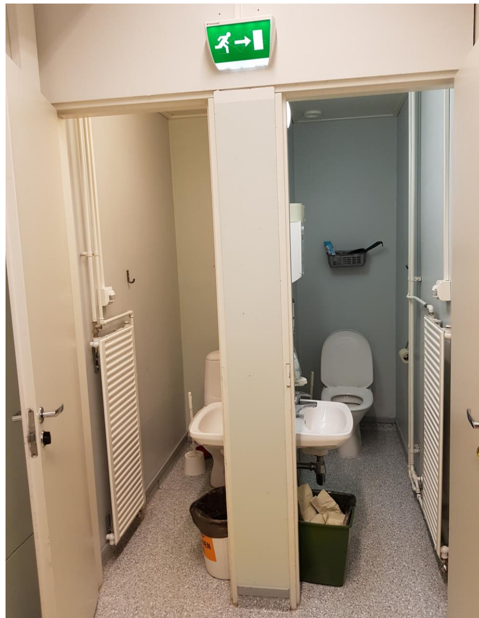
Käytävän päässä sijaitsevat wc-tilat on rakennettu vuonna 1976. kalusteet on uusittu vuonna 2006.
