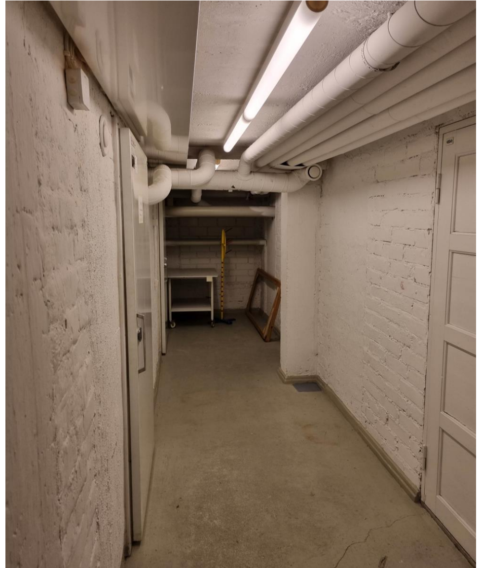
Kellaritiloissa on näkyvillä alkuperäisiä pintoja: seinät ovat rapattuja ja maalattuja tiilipintoja, lattiat betonipintoja. Pitkittäisen käytävän kattoa rytmittävät välipohjan palkit. Tilat ovat pääasiassa varastokäytössä tai taloteknisinä tiloina.
