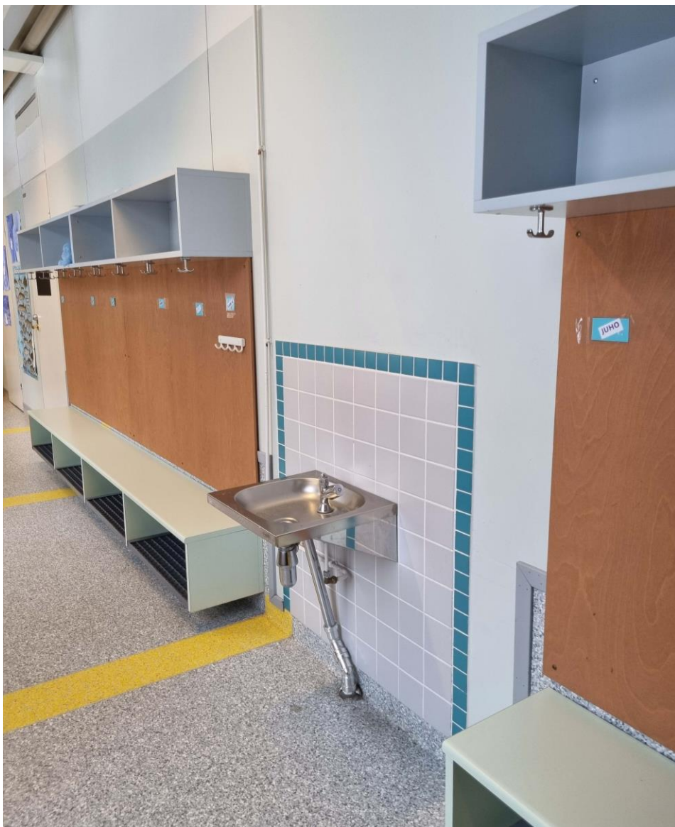
Käytävätilassa korostuvat vuoden 2006 kalusteet ja värimaailma. Nykyinen väritys, joka henki oman aikakautensa uudisrakentamisen tyyliä, ei parhaalla mahdollisella tavalla sovi historiallisesti arvokkaaseen rakennukseen.
