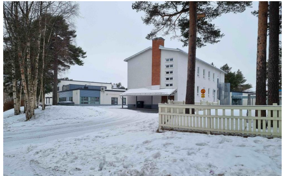
Kivikoulun pääty itään, vasemmalla vuonna 1978 valmistunut koulurakennus.
