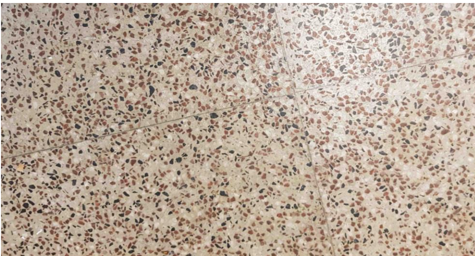
Lattiat ovat graniittimosaiikkia, jossa on punaisen kiviaineksen lisäksi mustaa ja valkoista kiveä. Pinnat on jaettu ruutuihin sinkkilistoilla.
