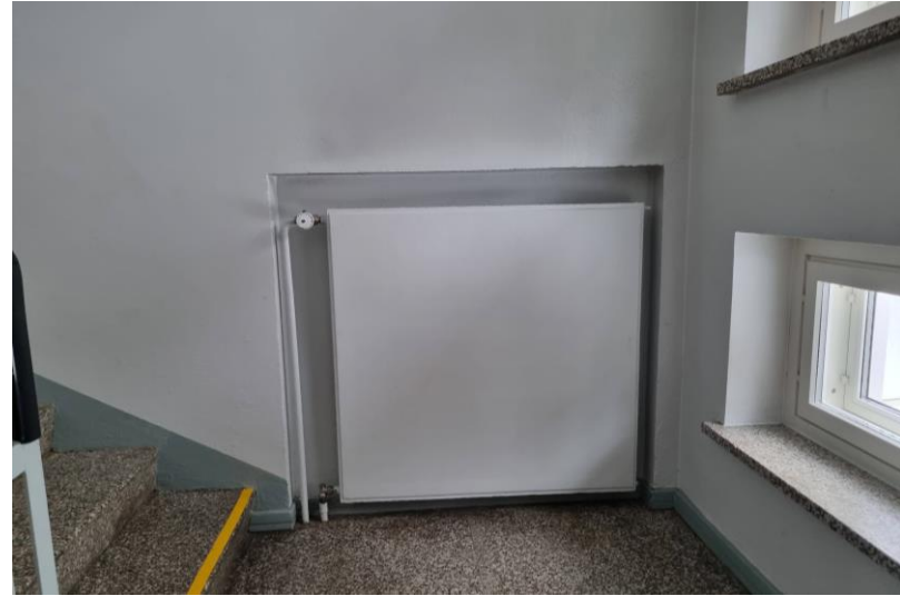
Porrashuoneissa lämpöpatterit sijaitsevat seiniin muuratuissa syvennyksissä.
