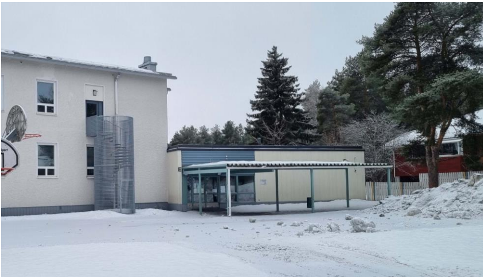
Kivikoulun liittyminen vuonna 1978 rakennettuun koulurakennukseen pohjoisen suunnasta kuvattuna. Kuvassa näkyy myös vuonna 2006 rakennettu hätäpoistumistie ja kierreporras.
