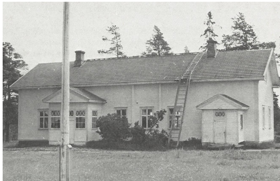
Kirkonkylän vuonna 1887 valmistunut valkea koulu vuonna 1966. Kuva on otettu ennen rakennuksen peruskorjausta, suunnitelmat on päivätty vuosina 1967 ja 1968. Rakennus on kuvan ottamisen aikaan lähes 80 vuotta vanha, joten jotain korjauksia ja muutoksia siihen lienee tehty jo aikaisemmin. (Kuva Räisänen 1981).
