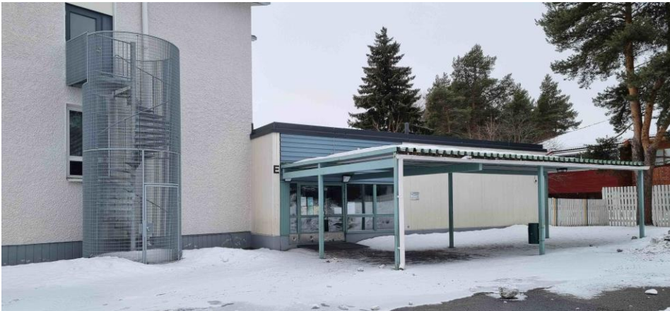
Vuonna 1978 rakentuneen laajennusosan koillisen puolen sisäänkäynti ja sen alkuperäinen sisäänkäynnin katos.
