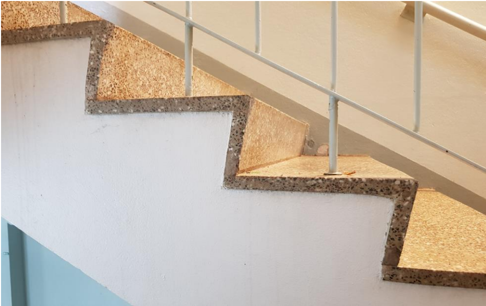
Portaiden askelmat on vuoden 1957 rakennuslityksen mukaan esivalmistettu tehtaalla ja asennettu paikoilleen rakennusvaiheessa.
