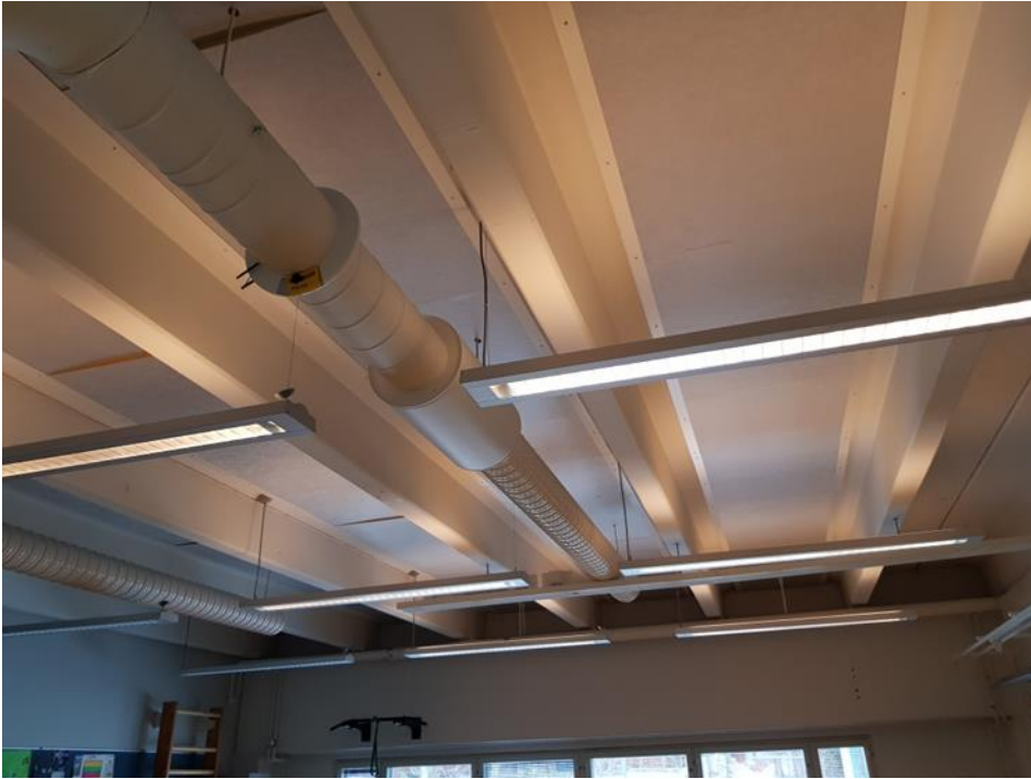
Koulurakennuksessa näkyy paikoitellen kantavien betonirakenteiden luomia arkkitehtonisia aiheita, kuten TT-laattojen palkistoja sekä pilarien ja palkkien liitoksia. Monin paikoin rakenteelliset aiheet kuitenkin jäävät kalusteiden ja talotekniikan katveeseen.
