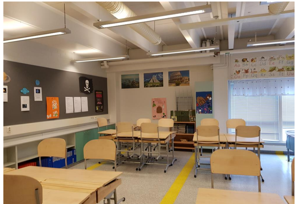
Koulurakennuksessa näkyy paikoitellen kantavien betonirakenteiden luomia arkkitehtonisia aiheita, kuten TT-laattojen palkistoja sekä pilarien ja palkkien liitoksia. Monin paikoin rakenteelliset aiheet kuitenkin jäävät kalusteiden ja talotekniikan katveeseen.
