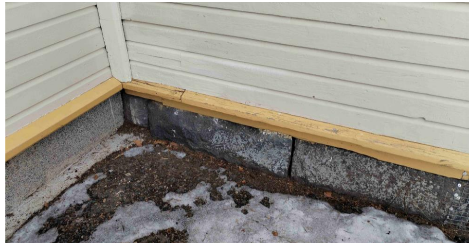
Koulurakennus on perustettu suurille luonnonkiviharkoille. Kuistien kohdalla sokkelin ulkopinta on betonia. Koska kuistit ovat alkuperäiset, niiden perustukset lienevät alkuperäiset. Betonipinta lienee peräisin jossain vaiheessa tehdystä perustusten korjauksesta.
