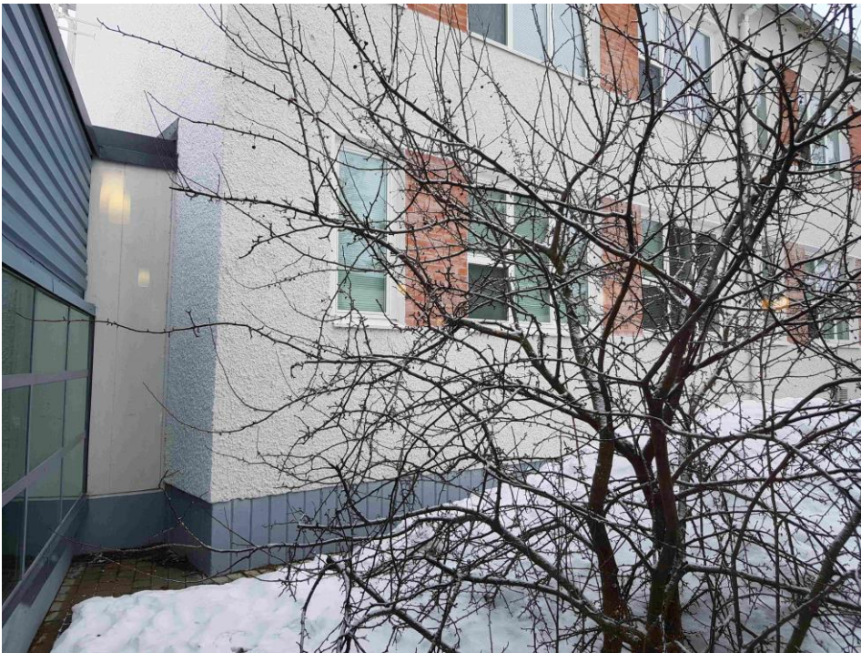
Kivikoulun liittyminen 1976 rakennettuun koulurakennukseen eteläpuolelta.
