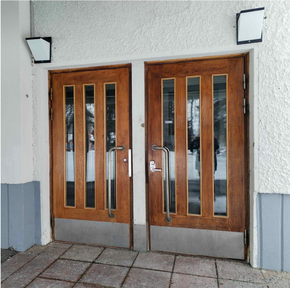
Pääsisäänkäynti sijaitsee koulurakennuksen itäpäädyssä. Ulko-ovet ovat alkuperäiset tammiovet.
