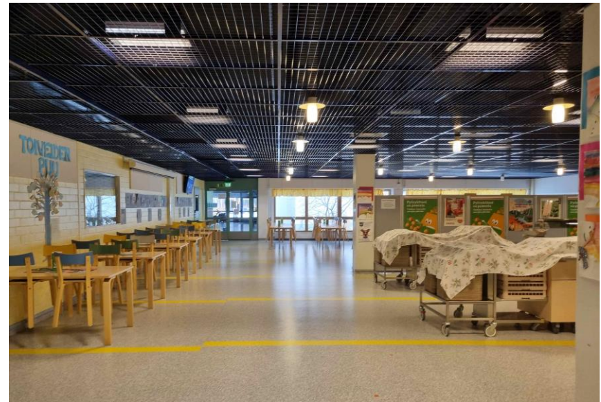
Ruokala. Tilaa hallitsee 2000-luvun peruskorjauksessa asennettu ripustettu teräsverkkoalakatto.
