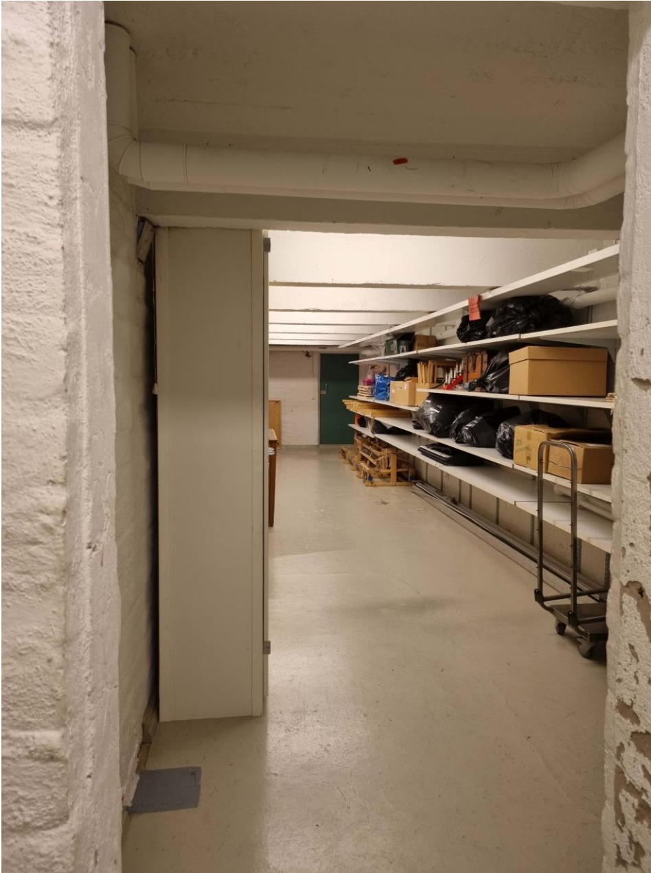
Kellaritiloissa on näkyvillä alkuperäisiä pintoja: seinät ovat rapattuja ja maalattuja tiilipintoja, lattiat betonipintoja. Pitkittäisen käytävän kattoa rytmittävät välipohjan palkit. Tilat ovat pääasiassa varastokäytössä tai taloteknisinä tiloina.
