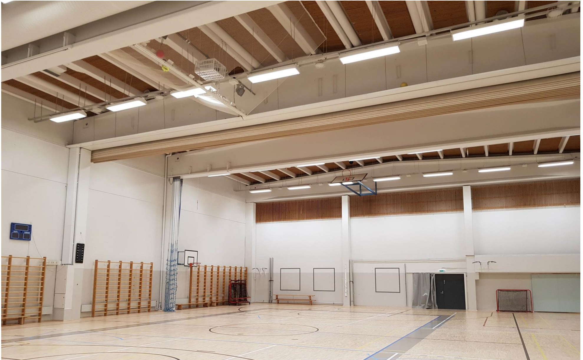
Liikunta- / juhlasali on korkea ja juhlava tila. Salissa kantavat rakenteet, pilarit ja kattoa kannattavat harjapalkit, erottuvat arkkitehtonisena teemana.
