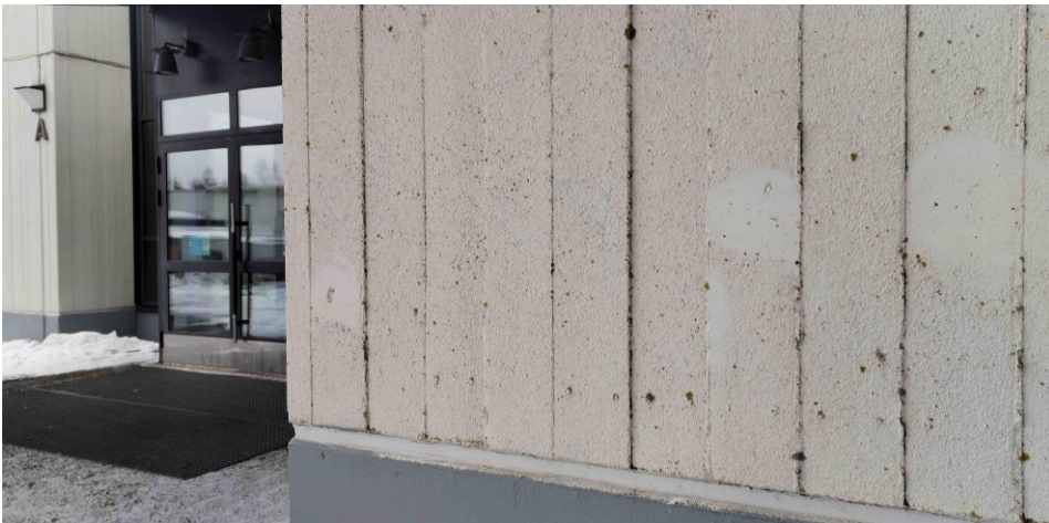
Betonielementtijulkisivuissa on muottilautojen muodostama pystysuuntainen pintakuviointi.
