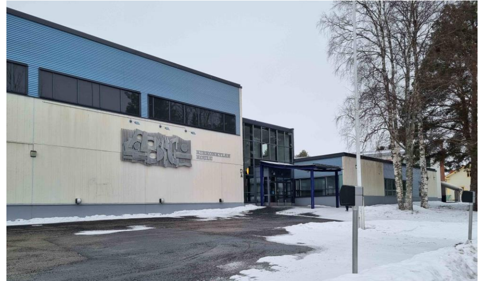
Kaarevakattoinen katos ja lasiseinäinen aulatila erottuvat uusina 2000-luvun elementteinä vuoden 1978 ala-asteen koulun Koulutien suuntaan avautuvalla julkisivulla.
