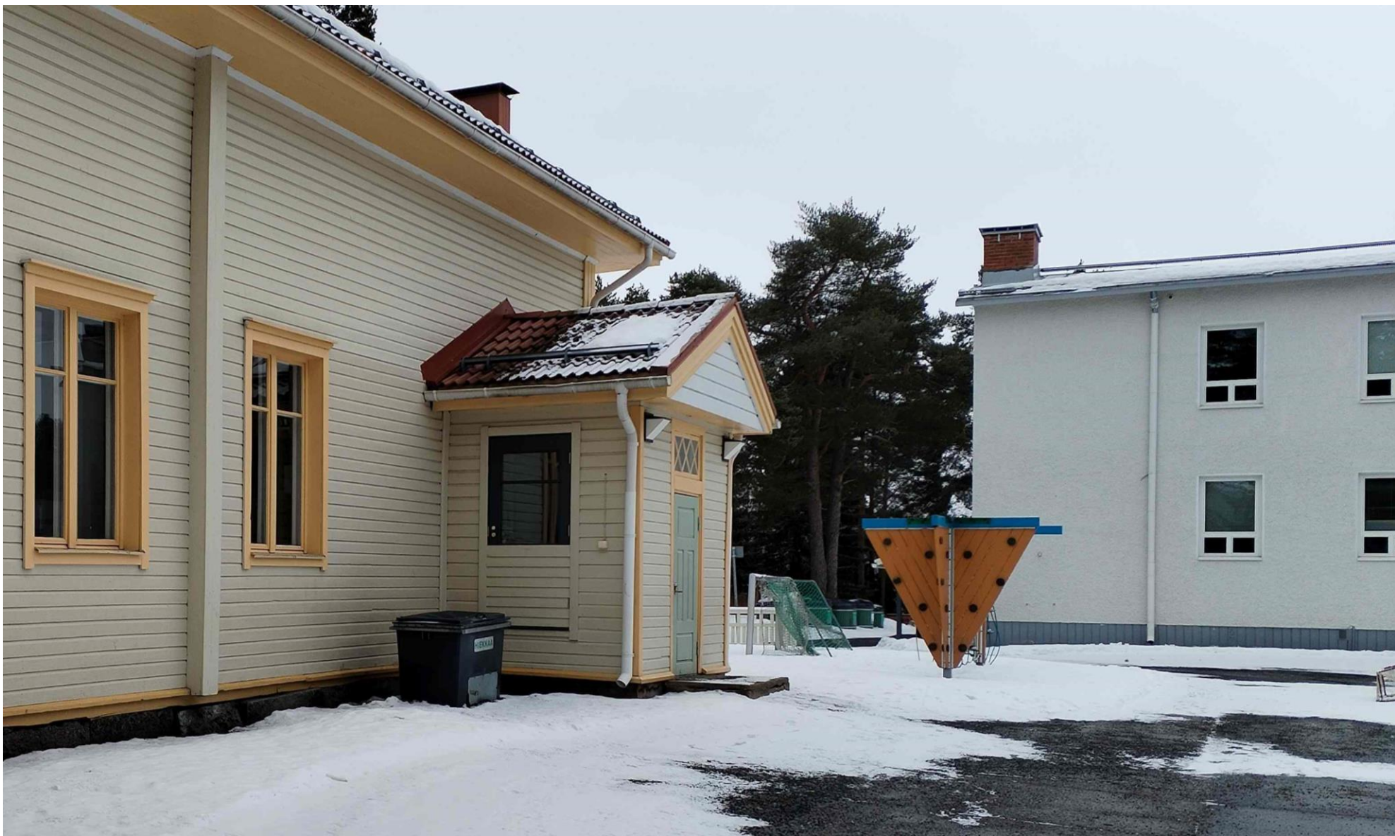
Pienemmän umpikuistin sivulla on uudenaikaisempi ovi mahdollista esteettömän sisäänkäynnin lisäystä varten. Ovi on alaosasta laudoitettu vastaamaan ulkovoorausta, jotta ovi istuisi paremmin rakennukseen.
