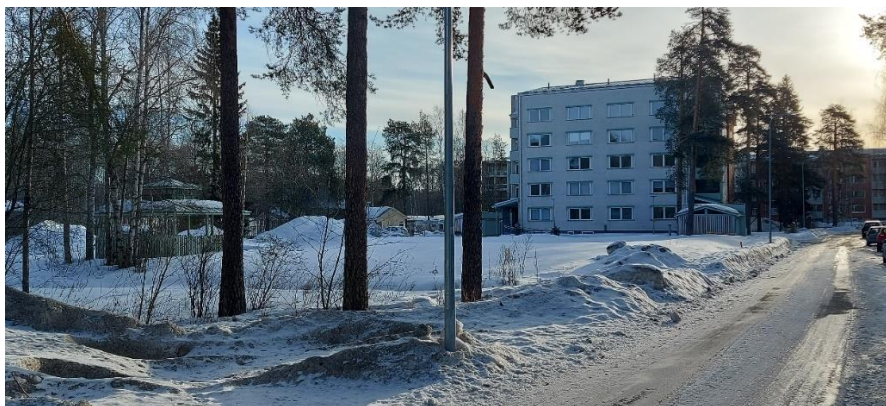
Kuva 1. Hoikantie 21-23. (kuva: Erkki Kauppinen, 5.4.2024)
