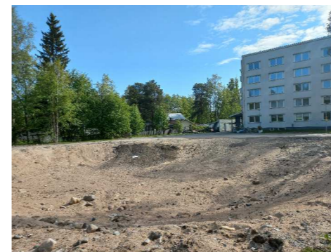
Kuva 3. Toinen tontilla olleista kerrostaloista on purettu.
