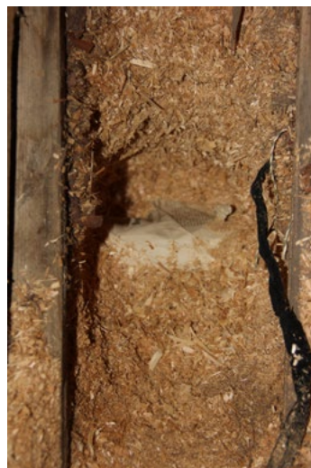
83. Yläpohjatäytteen kaivaus päättyi niskoja peittäviin sanomalehtiin.
