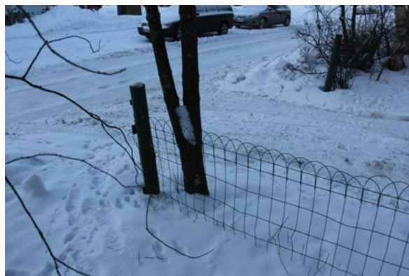
50. Tonttia rajaa kevyt verkkoaita. Ajoportti on poistettu.
