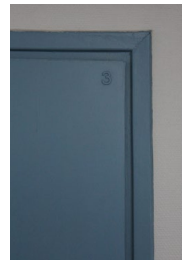
65. Vastapäinen ovi on laakaovi ilman reunalistaa.
