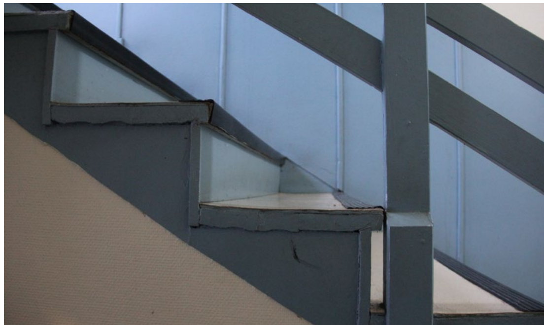
67. Portaat ja kaiteet on tehty kirvesmiestyönä työmaalla.
