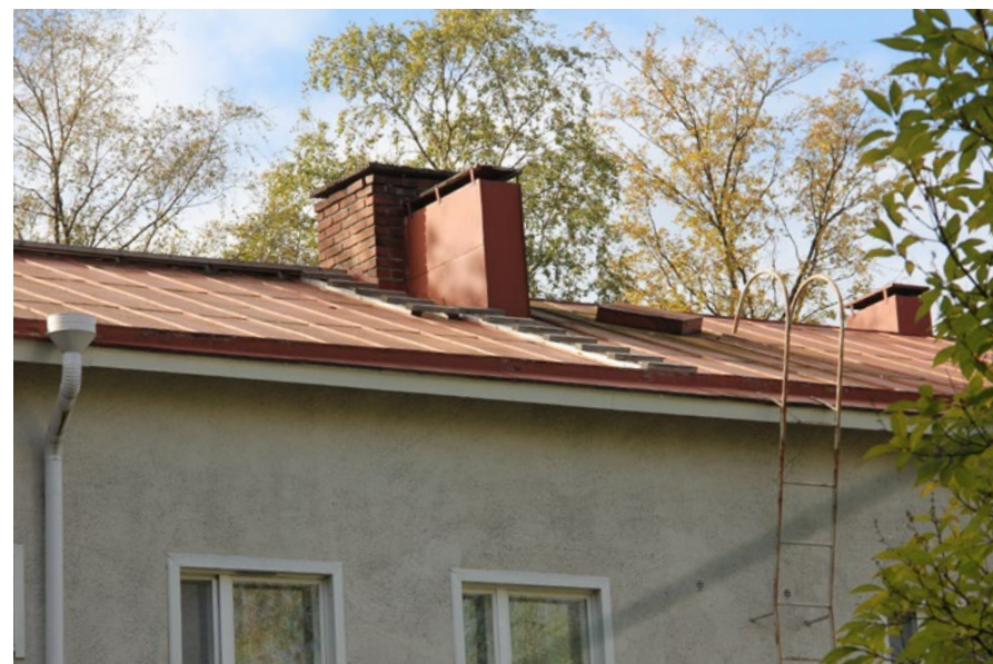
41. Vesikatto on alkuperäinen. Keskellä on rinnakkain punatiilinen savuhormi ja sen edessä pellitetty ilmanvaihtoormi.
