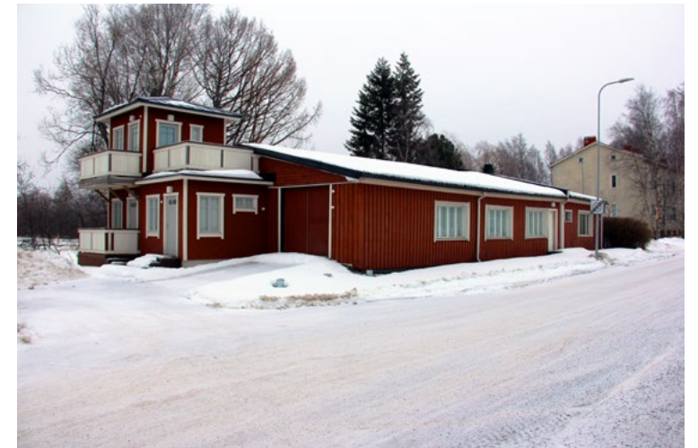
34. Rakennusmestari K. Kaarelan vuonna 1954 suunnittelemassa rakennuksessa on toiminut veneveistämö sekä siitä palomuurilla erotettu asunto. Rakennuksen osoite on Puistokatu 1 C. Kohteemme näkyy taustalla, kuvan oikeassa reunassa.
