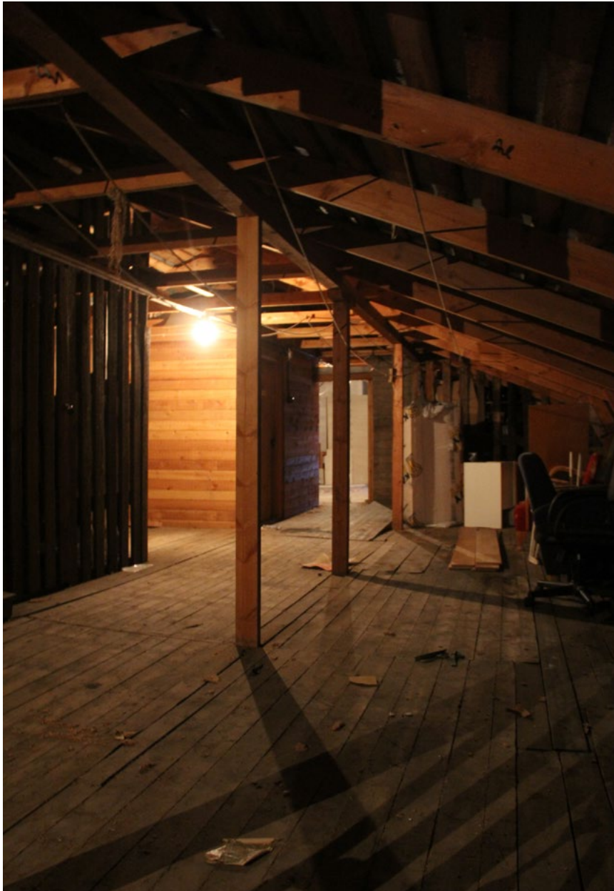
86. Ullakon interiööri on säilynyt muuttumattomana. Tässä tapauksessa tilaan ei ole lisätty ilmanvaihtoputkistoja tai muutakaan talotekniikkaa.
