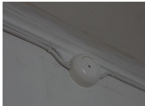
53. Asunnon sähköverkkoa on uusittu vanhaa asennustapaa ja kalustusta mukaillen.
