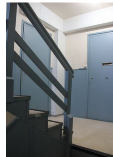
72. Ovien yläpuolella on uusi putkille tehty kotelointi.
