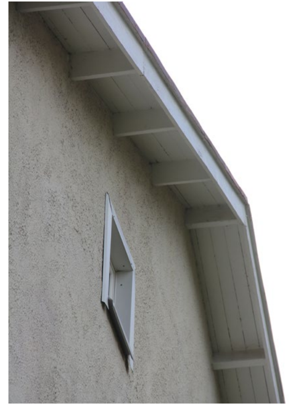
48. Rakennuksessa on lyhyet avoräystäät ja tuulettuva ullako. Ullakkoikkunoita on vain päädyissä.
