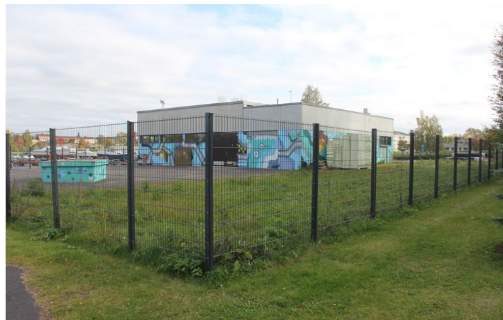
30. Korttelin 3 ja Hollihaan venesataman väliselle alueelle valmistui vuonna 1974 kuvassa näkyvä jätevedenpuhdistamo. Rakennus on erotettu ympäröivästä puistosta teräsaidalla.
