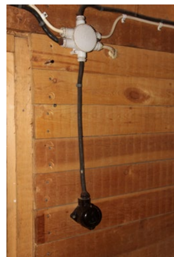
84. Ullakolla on säilynyt 1950-luvun sähkökalusteita.
