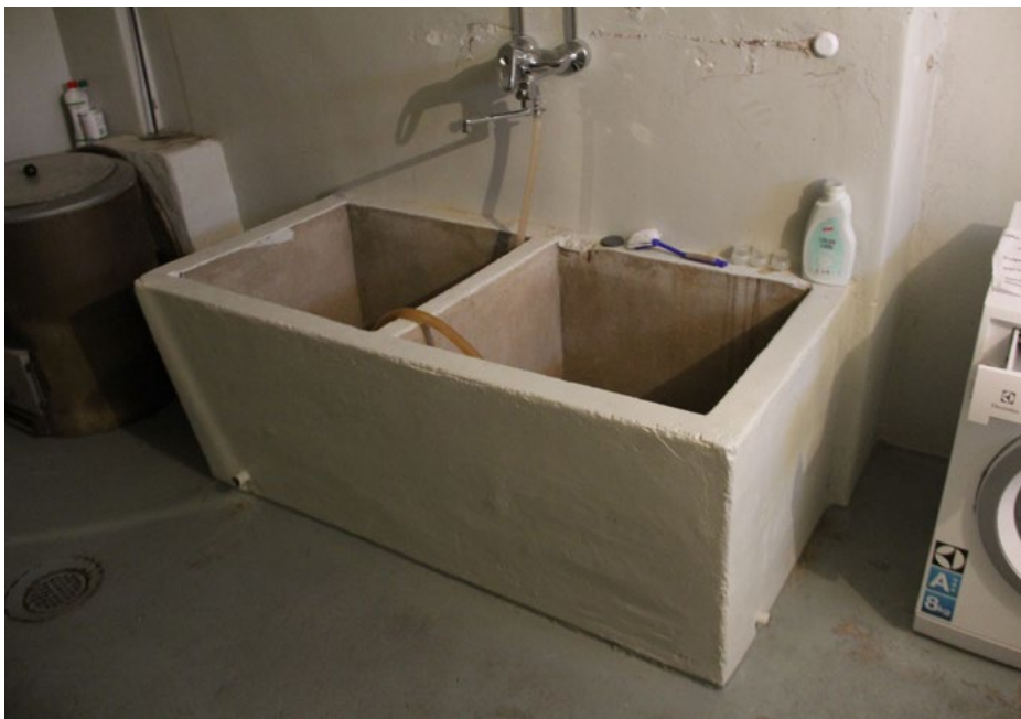
76. Alkuperäinen pyykkikaukalo on säilytetty. Paikalla valettu kaukalo on tiivistetty vesilasilla,
