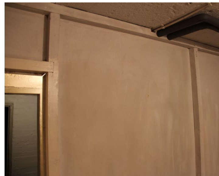
113. Saunaosaston toinen pukuhuone rakennettiin myöhemmin ja se on toiminut mankelihuoneena. Kuvassa tilan kulissimaista seinää.
