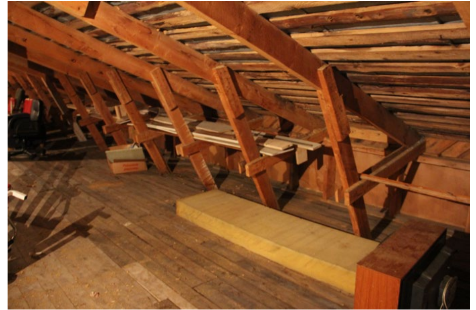
87. Ullakon pitkällä sivuilla on vesikattoa kannattavat ruotsalaismalliset kattotuolit, jotka jättävät käyttöullakon keskiosan vapaaksi. Yläpohjaan ei ole lisätty eristystä.
