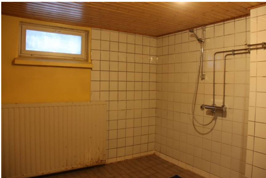
111. Saunaosastoa on uusittu vuonna 2003. Vanhempia kerrostumia on säilytetty.
