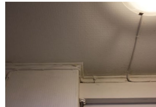
54. Alakatossa ja porrashuoneen vastaisessa seinässä on maalattu pinkopahvi. Katossa on kapea kourulista.
