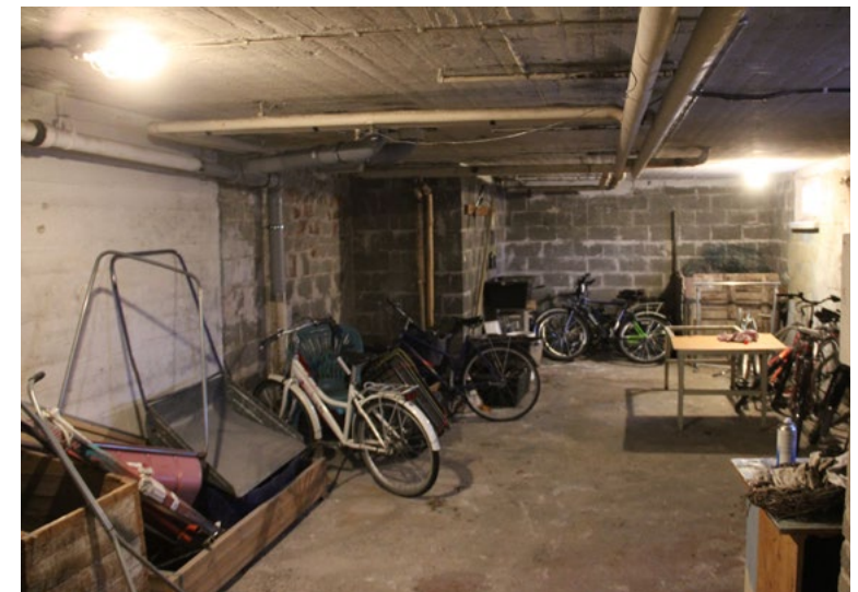
110. Entinen polttoainevarasto toimii nykyisin talon yhteisenä varastona. Perällä näkyy oljysäiliötä varten muurattu 1960-luvun väliseinä.
