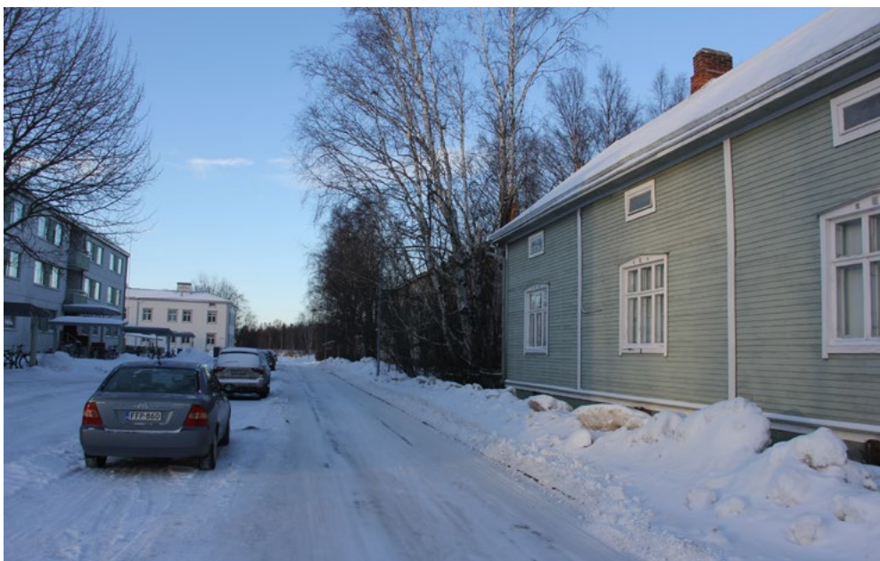
29. Näkymä Puistokadulta Hollipuiston kulmalta länteen. Vasemmalla on vuonna 1974 nuorisohotelliksi valmistunut kerrostalo. Sen takana näkyy vuonna 1939 nahkatyöväelle rakennettu puukerrostalo. Tien oikealla puolella taaimmaisena näkyy Puistotkatu 1 ja etumaisena Puistokatu 5. Niiden välissä on metsittyntä tontti numero 2.
