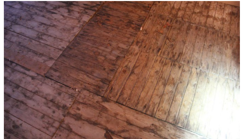
88. Ullakon lattia muodostuu ristikkäin ladotuista lankuista, joita on käytetty rakennusvaiheessa muun muassa muottirakenteena. Lankut on naulattu niskapalkkeihin.
