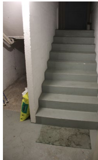
73. Kellariin laskeutuvat maalatut betoniportaat.
