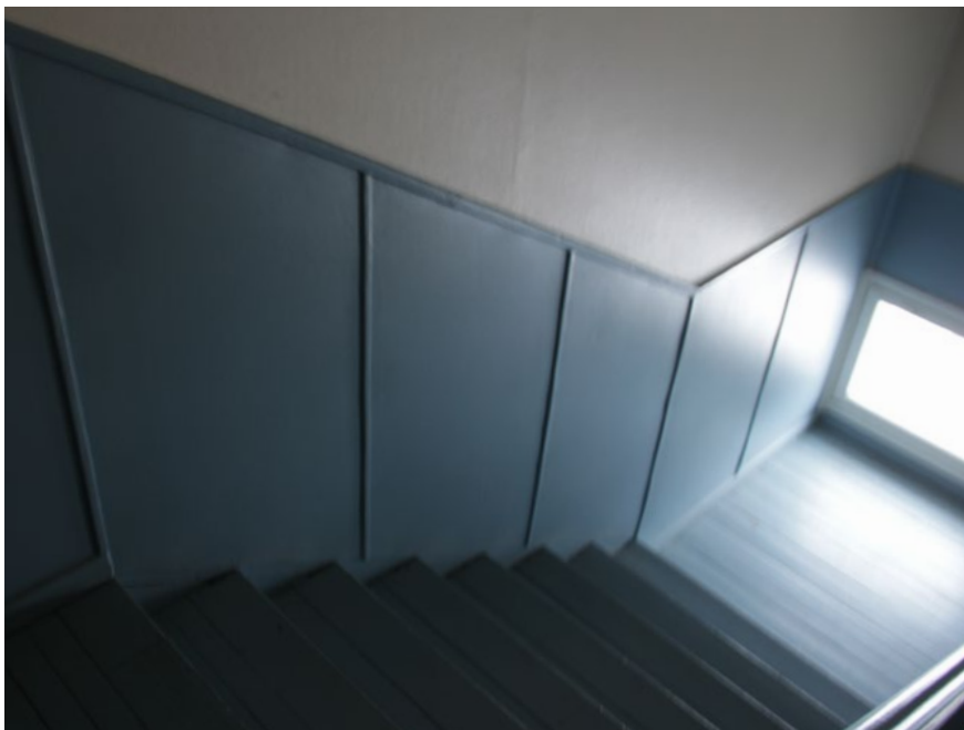
66. Näkymä ullakon tasanteelta porrassyöksyyn. Ullakon portaat ovat puupintaiset.
