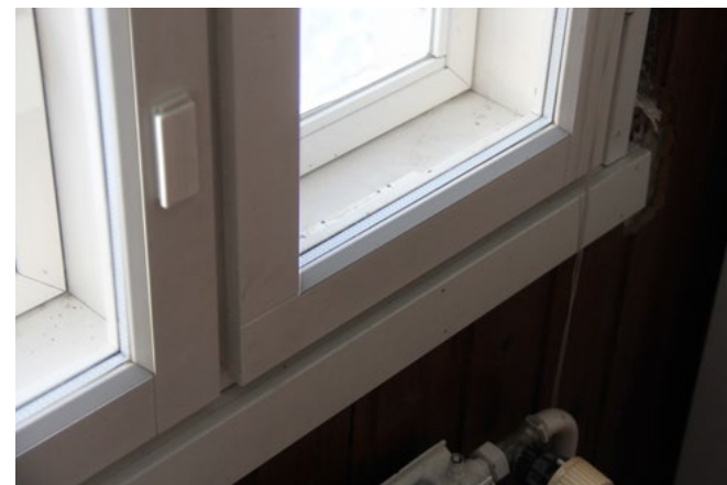
61. Uusittu MSE-ikkuna, jonka sisemmässä puitteessa on lämpöläsi.
