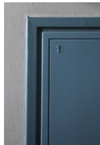
64. Reunalistalla varustettu huoneiston ovi.
