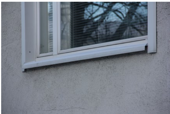
49. Ikkunat on uusittu vuonna 1996. Ikkuna-aukkoja kiertää valkoinen suojaPELLITYS.
