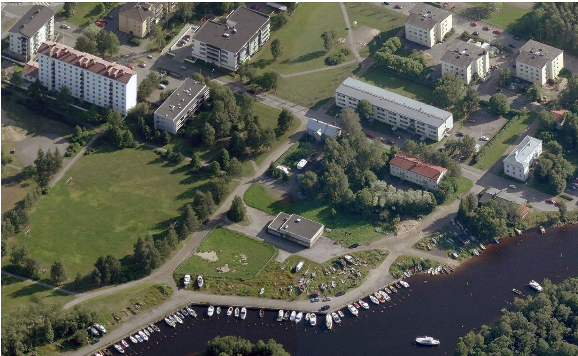
101. Viistoilmakuva pohjoisesta Puistokadun suuntaan ennen vuonna 2018 valmistunutta venesataman uudistamista. Punakattoinen Puistokatu 1 on kuvan keskellä. KUVA: Oulun kaupunki
