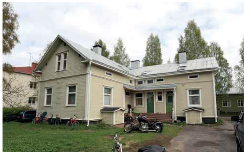
207. Pihan puolella näkyvät muutokset ovat uusitut ulko-ovet ja ikkunat, kellarien uudet sisäänkäynnit, sisäänkäyntikatos, korotetut tai uudet haukkaikkunat ja katon lapeikkunat. (Kuva: Riitta Kosonen, Arkkitehtitoimisto Jorma Teppo Oy, 5/2021.)
