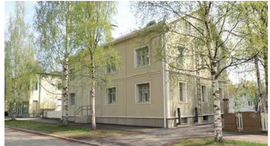
137. Syrjäkatu 19 ensimmäisen kerroksen julkisivumateriaali on muutettu vaakapaneeliksi. ja julkisivut on lisälämmöneristetty. Betonisokkeli on levytetty ja sokkelista nousevat ilmanvaihtoputket. (Kuva: Riitta Kosonen, Arkkitehtitoimisto Jorma Teppo Oy, 5/2021.)
