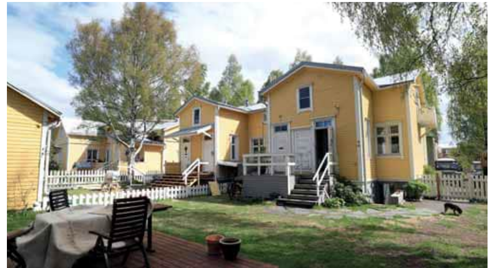
417. Karjakatu 8 pihan puolella rakennuksen alkuperäiset ominaispiirteet ovat selvästi havaittavissa. Ulko-ovet ovat alkuperäiset tai alkuperäisen mukaiset, osa ikkunoista on myös alkuperäisiä. Uudet kerrokset, kuten katos, parveke ja kellarin uudet sisäänkäynnit eivät peitä alleen alkuperäistä rakennusta. (Kuva: Riitta Kosonen, Arkkitehtitoimisto Jorma Teppo Oy, 5/2021.)
