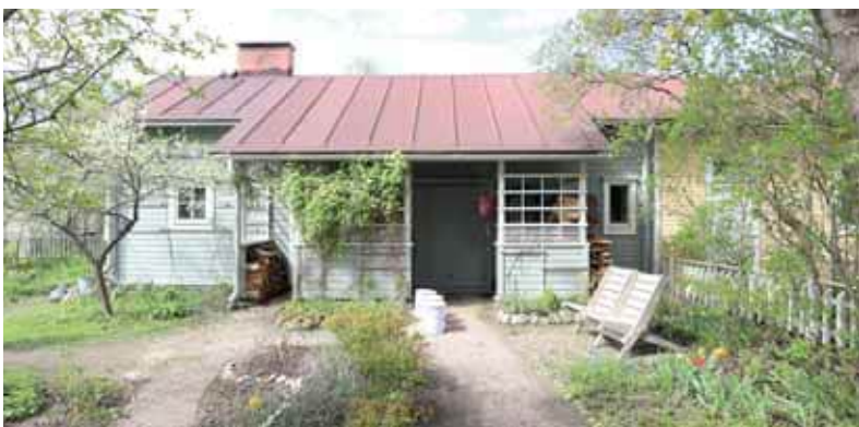
407. Karjakatu 12 piharakennukseen on tehty puusäleiköin varustettu avokuisti. (Kuva: Riitta Kosonen, Arkkitehtitoimisto Jorma Teppo Oy, 5/2021.)
