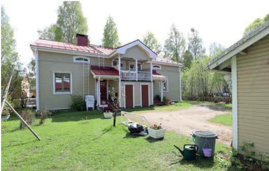
316. Karjakatu 20 pihan puolella tyyli on muuttunut selvästi. Kuisti on muotoiltu uudestaan koristeellisiksi yksityiskohdin. Sisäänkäyntikatokset ja uusitut ulko-ovet muuttavat myös rakennuksen tyyliä. (Kuva: Riitta Kosonen, Arkkitehtitoimisto Jorma Teppo Oy, 5/2021.)
