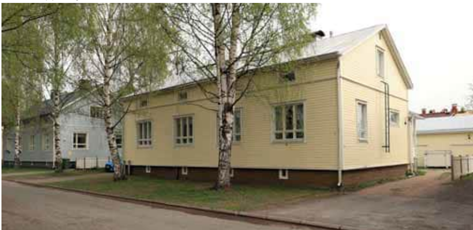
470. Karjakatu 5:n katto ja ikkunat ovat alkuperäisiä tai alkuperäisen mukaisia. Ullakon haukkaikkunat on vaihdettu alkuperäisen mukaisina, mutta yksiruutuisina. Ullakon ikkunat ovat voimakkaasti syvennyksessä. (Kuva: Riitta Kosonen, Arkkitehtitoimisto Jorma Teppo Oy, 5/2021.)
