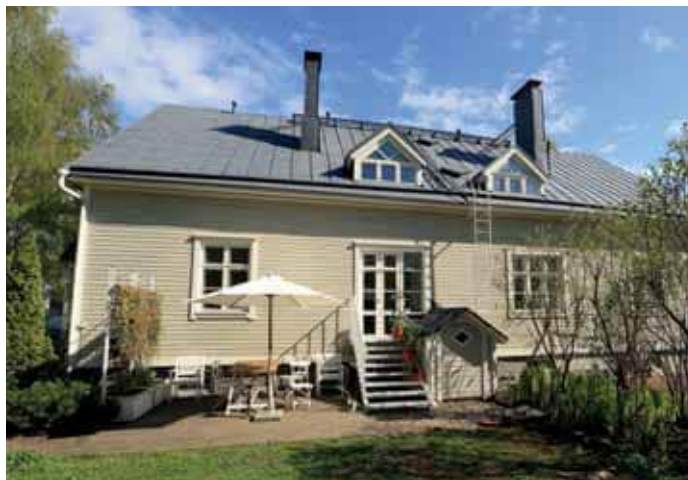
182. Vuonna 2020 lisätty ikkunan paikalle uusi lasiulko-ovi. Kuvassa myös 1980-luvulla korotetut kattolyhdyt. (Kuva: Riitta Kosonen, Arkkitehtitoimisto Jorma Teppo Oy, 5/2021.)
