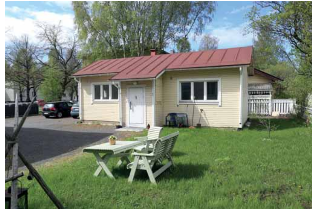
398. Puistikkokatu 11 piharakennuksen ulko-ovi ja ikkunat on vaihdettu. Katto on uusittu alkuperäisen mukaisena. Rakennuksen tyyli on säilynyt. (Kuva: Riitta Kosonen, Arkkitehtitoimisto Jorma Teppo Oy, 5/2021.)
