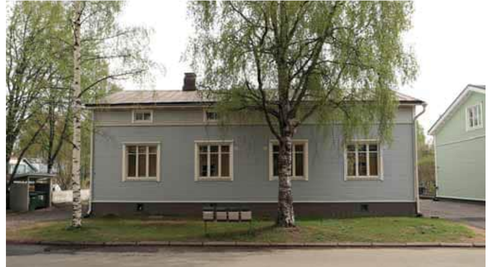
367. Puutarhakatu 9 katujulkisivussa ei ole tapahtunut suuria muutoksia. Merkittävimmät muutokset ovat kaikkien ikkunoiden uusimiset. Pohjakerroksen ja ullakon ikkunat on uusittu puuikkunoina puitejakosäilyttäen. Ullakon ikkunat jäivät syvennykseen. (Kuva: Riitta Kosonen, Arkkitehtitoimisto Jorma Teppo Oy, 5/2021.)
