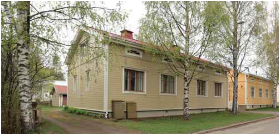
317. Karjakatu 20 katujulkisivun suurin muutos on voimakkaasti syvennykseen jäävät pohjakerroksen ikkunat. . (Kuva: Riitta Kosonen, Arkkitehtitoimisto Jorma Teppo Oy, 5/2021.)
