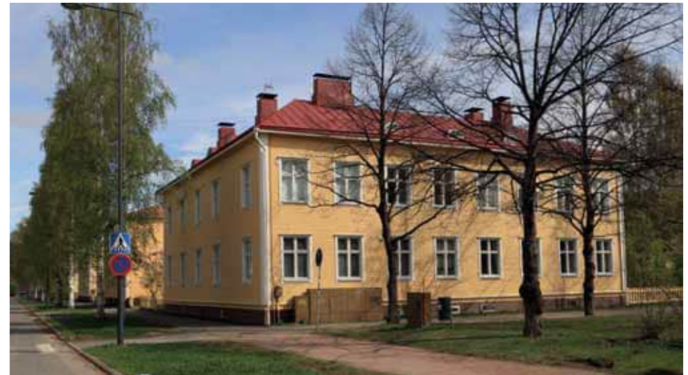
42. Syrjäkatu 11 vuonna 2021. Puusto on kasvanut ja rakennuksen eteen on tullut rivi sähkökaappeja. Puistikkokatu on suljettu autoliikenteeltä. (Kuva: Riitta Kosonen, Arkkitehtitoimisto Jorma Teppo Oy, 5/2021.)
