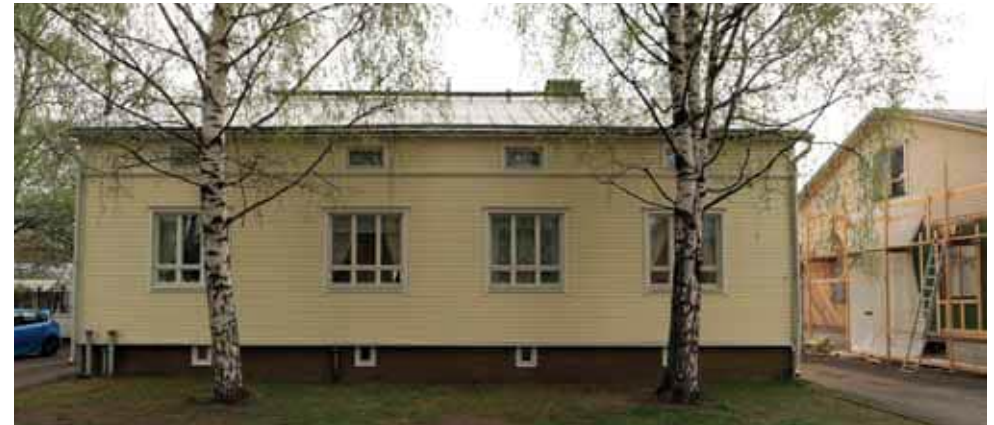
471. Karjakatu 5:n Puu-Raksilalle tyyppillinen symmetrinen katujulkisivu. (Kuva: Riitta Kosonen, Arkkitehtitoimisto Jorma Teppo Oy, 5/2021.)
