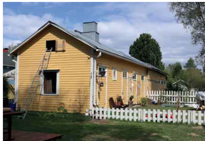
420. Karjakatu 8 piharakennus on kaavanmukaisesti rakennettu kiinni naapurin talousrakennukseen. Päädyn ikkuna on uusittu tyylistä poikkeavana. (Kuva: Riitta Kosonen, Arkkitehtitoimisto Jorma Teppo Oy, 5/2021.)
