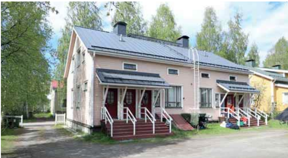
592. Karjakatu 19 on ainoa Puu-Raksilan kuistittomana pysynyt pientalo. Sisäänkäyntien päälle on kuitenkin rakennettu katokset Ulko-ovet ja asuinkerroksen ikkunat on vaihdettu. (Kuva: Riitta Kosonen, Arkkitehtitoimisto Jorma Teppo Oy, 5/2021.)
