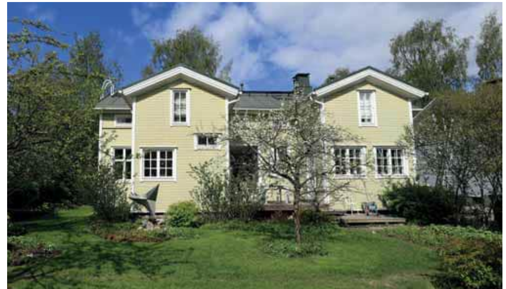
374. Puutarhakatu 11 pihan kulku keskittyy rakennuksen pohjoispäättyyn. Kuistien välissä näkyy uutena kerrostumana suuri lasiaukko. Sisäänkäyntien paikkaa ja kuistien ikkunoita on muutettu. (Kuva: Riitta Kosonen, Arkkitehtitoimisto Jorma Teppo Oy, 5/2021.)
