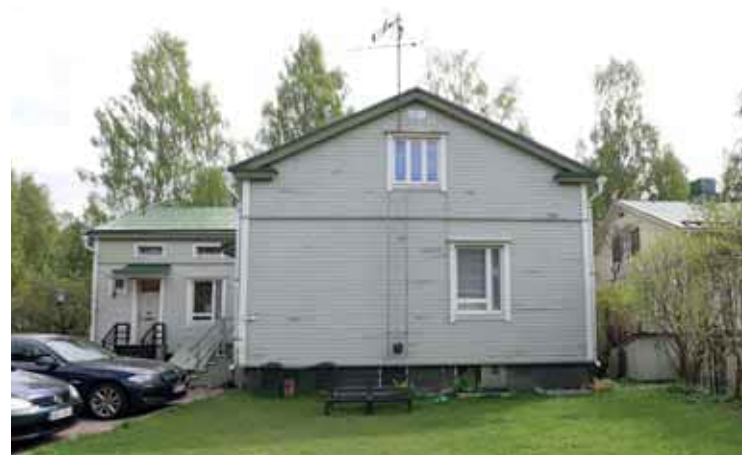
446. Ullakon päätyikkuna on uusittu. (Kuva: Riitta Kosonen, Arkkitehtitoimisto Jorma Teppo Oy, 5/2021.)
