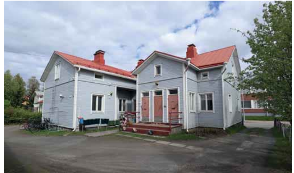
531. Pihan puolen suurin muutos on ulko-ovien uusiminen. (Kuva: Riitta Kosonen, Arkkitehtitoimisto Jorma Teppo Oy, 5/2021.)
