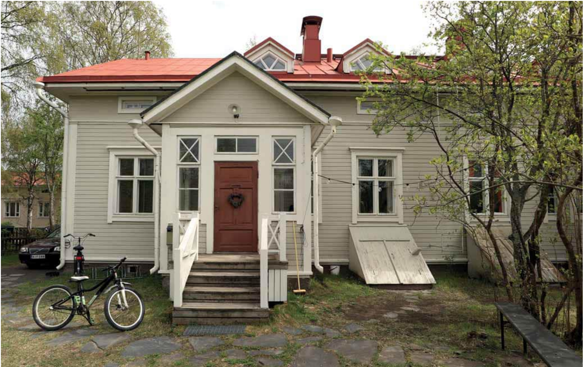
93. Päärakennuksen ikkunat ovat alkuperäiset ja ovet alkuperäiset tai alkuperäisen mukaiset puupeiliovet. Rakennuksessa on vielä jäljellä alkuperäisen mukaiset kellariin pihalta johtavat puuluukut. Myös porraskaiteet on uusittu alkuperäistä mukaillen. (Kuva: Riitta Kosonen, Arkkitehtitoimisto Jorma Teppo Oy, 5/2021.)
