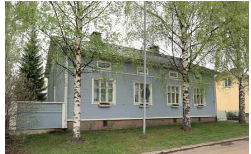
286. Karjakatu 26 katujulkisivussa ei ole tapahtunut suuria muutoksia. Pohjakerroksen ikkunat on uusittu alkuperäistä vastaavina puuikkunoina puitejakosäilyttäen. Julkisivuun on lisätty lämmöneristettä, mikä jättää ikkunat lievästi syvennykseen. (Kuva: Riitta Kosonen, Arkkitehtitoimisto Jorma Teppo Oy, 5/2021.)
