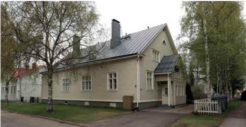
184. Pohjois-päädyn laajennuksessa ei ole muusta rakennuksesta poiketen jalkarännejä. Laajennukset eivät muutoinkaan ole identtiset. (Kuva: Riitta Kosonen, Arkkitehtitoimisto Jorma Teppo Oy, 5/2021.)
