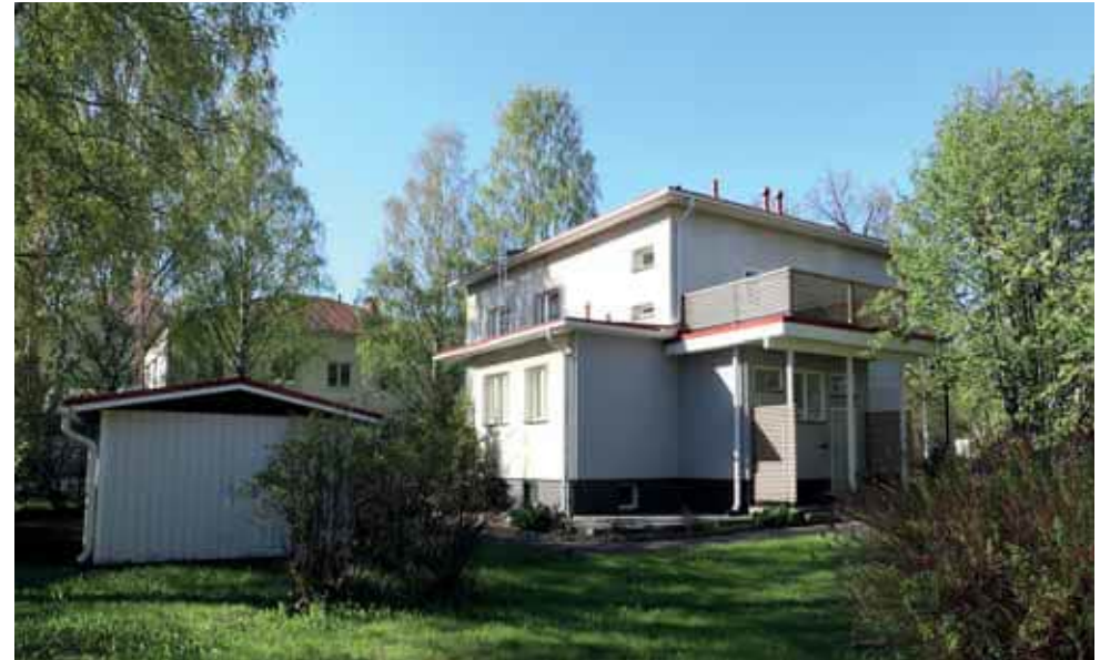
223. Puutarhakatu 15 pihan puolella on tapahtunut muutoksia. Itäisivulle on rakennettu vaakarimoitettu parveke. (Kuva: Riitta Kosonen, Arkkitehtitoimisto Jorma Teppo Oy, 5/2021.)
