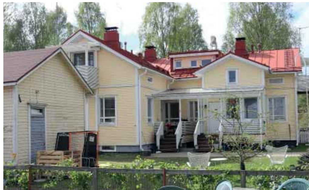
486. Ulko-ovet ja ikkunat on uusittu. Kattolyhty tehtiin ensimmäisen kerran jo 1960-luvulla. (Kuva: Riitta Kosonen, Arkkitehtitoimisto Jorma Teppo Oy, 5/2021.)
