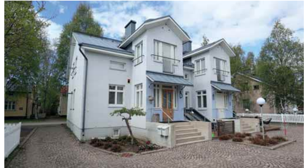
598. Karjakatu 21 pihan puolella ovat korkeat kuistit sisäänkäyntikatoksineen. Kuistien väliin jäävä lasikate tuo valoa kellaritiloihin. Poikkeuksellinen materiaali, korkeus, kivettypiha sekä moderni toteutus erottavat rakennuksen naapureistaan. (Kuva: Riitta Kosonen, Arkkitehtitoimisto Jorma Teppo Oy, 5/2021.)
