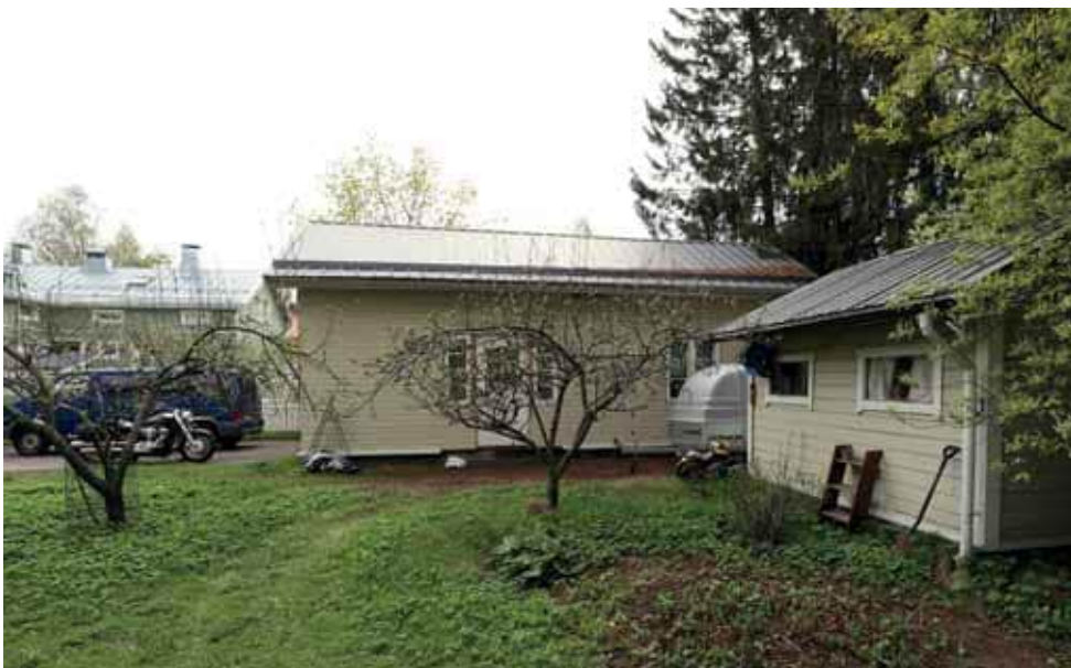
206. Taaempi piharakennus on alkuperäisellä paikalla ja mittasuhteiltaan alkuperäisen mukainen. Julkisivuissa ei kuitenkaan enää ole havaittavissa alkuperäisiä ominaispiirteitä, vaan ulkoisesti rakennus näyttää kokonaan uudelta. Etualalla toinen ulkorakennus, jonka rakentamisajasta ei ole tietoa. (Kuva: Riitta Kosonen, Arkkitehtitoimisto Jorma Teppo Oy, 5/2021.)
