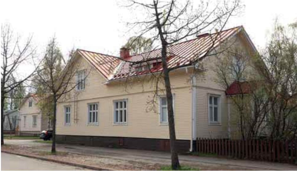
101. Tehtaankadun katujulkisivussa on vastaharja, jonka alle sijoittuu yksi ullakon asunnoista. Julkisivussa ei ole tapahtunut näkyviä muutoksia katon vaihdon lisäksi. (Kuva: Riitta Kosonen, Arkkitehtitoimisto Jorma Teppo Oy, 5/2021.)
