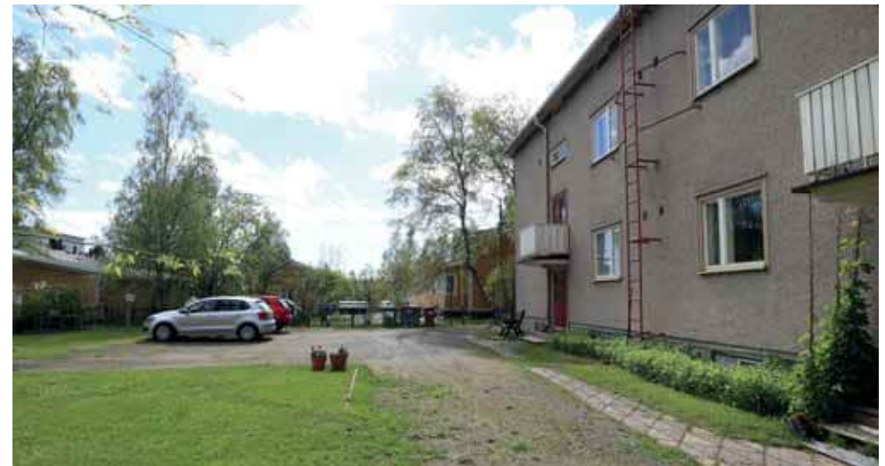
577. Karjakatu 15 pihan pintamateriaalit ovat perinteiset nurmi ja kivituhka. Tikkaat sijaitsevat keskeisesti julkisivussa. (Kuva: Riitta Kosonen, Arkkitehtitoimisto Jorma Teppo Oy, 5/2021.)
