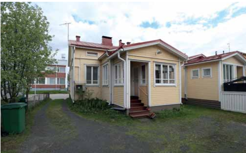
524. Tontin 258 molemmissa kuisteissa on samanlaiset teleskooppimaiset kuistilaajennukset. (Kuva: Riitta Kosonen, Arkkitehtitoimisto Jorma Teppo Oy, 5/2021.)
