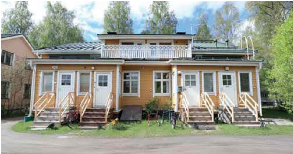
584. Kuistit ja lappeen nosto tehtiin 1950-luvulla. Sittemmin sisäänkäyntien sijainti on muutettu ja rakennettu parveke. (Kuva: Riitta Kosonen, Arkkitehtitoimisto Jorma Teppo Oy, 5/2021.)
