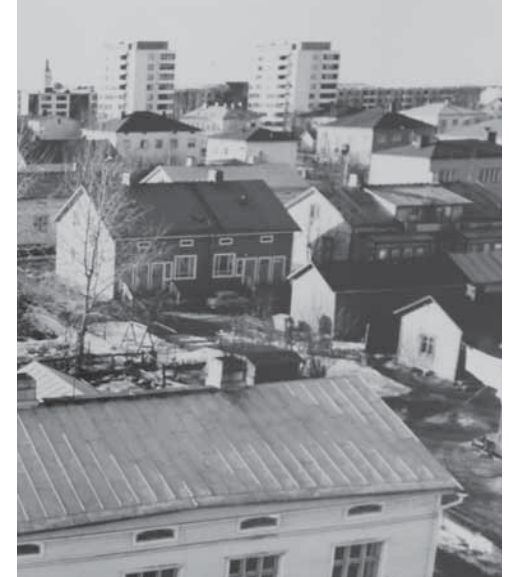
582. Karjakatu 17 on kuvassa oikeassa reunassa. Ullakon kattolipan nosto on tehty ja uudet kuistit lisätty. Kuva on otettu arviolta 1970-luvulla. (Kuva: Raksilan asukasyhdistys.)
