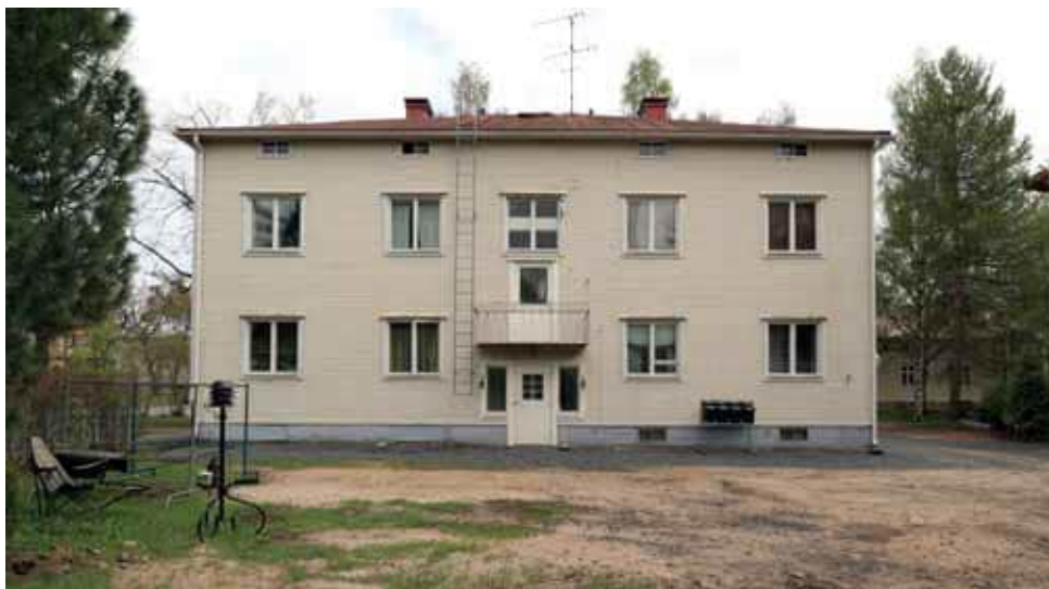
217. Puutarhakatu 14 pihan puolen jukisivu on identtinen katujulkisivun kanssa. Ulko-ovet erottuvat selkeästi tyylistä poikkeavina. (Kuva: Riitta Kosonen, Arkkitehtitoimisto Jorma Teppo Oy, 5/2021.)
