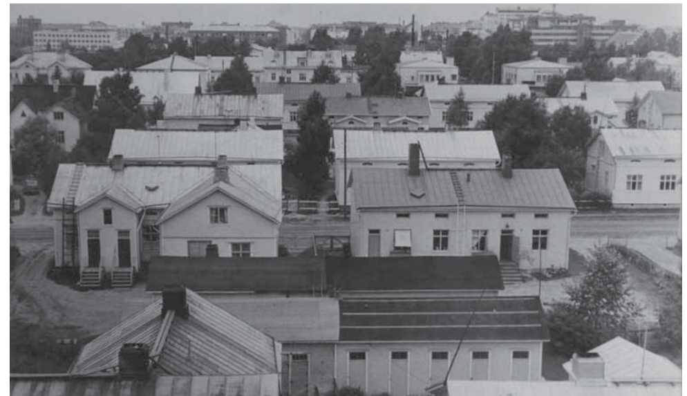
599. Karjakatu 21:n leipomo erottuu kuvassa keskellä vaaleana rapattuna ja kuistittomana rakennuksena. (Kuva: Raksilan asukasyhdistys.)
