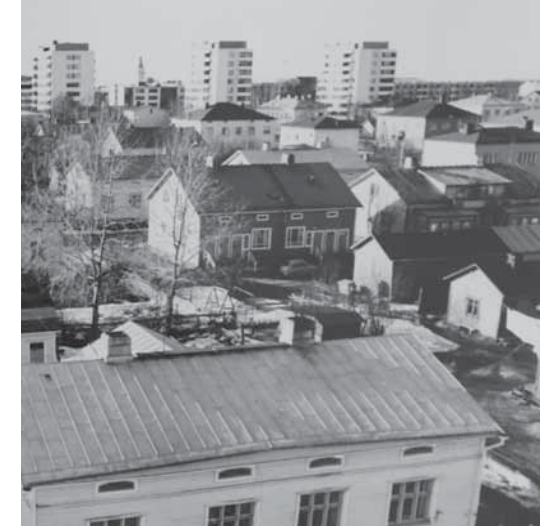
590. Karjakatu 19 on kuvassa keskellä. Väritys on vaihtunut tummaksi verrattuna vuoteen 1964. Valkoiset vuorilaudat kehystävät ikkunat ja lasiaukolliset ulko-ovet. Kuva on otettu arviolta 1970-luvulla. (Kuva: Raksilan asukasyhdistys.)
