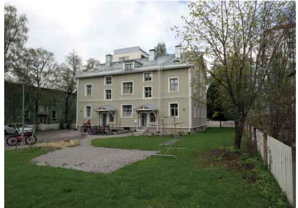
144. Syrjäkatu 19 piha on vastikään uudistettu. Kuvassa näkyvät myös uusi katto sekä 1990-luvulla lisätyt sisäänkäyntikatokset. Vuonna 1980-luvulla uusittiin ikkunat puitejako säilyttäen. Sen ajan uudet puuikkunat ovat huomattavasti raskastekoisemmat kuin alkuperäiset sirot ikkunat olivat. Ulko-ovien tyyli on muuttunut. (Kuva: Riitta Kosonen, Arkkitehtitoimisto Jorma Teppo Oy, 5/2021.)
