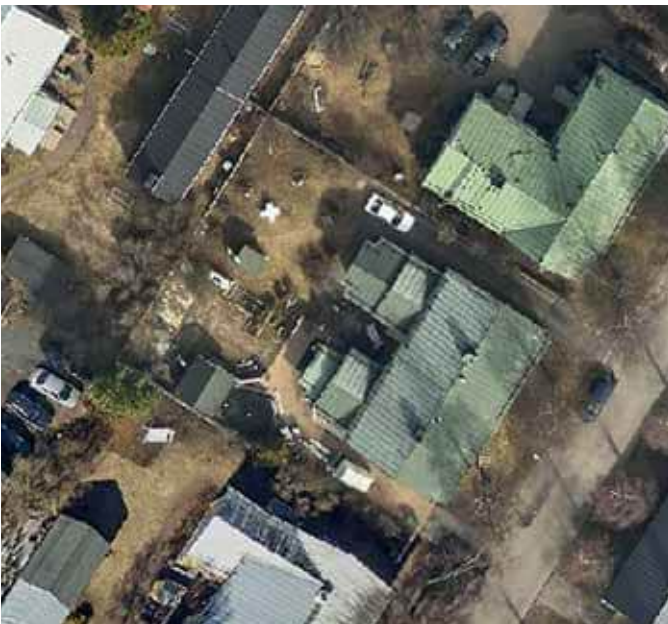
437. Tontilla 248 on sijainnut kaavan mukaisella paikalla Puu-Raksilalle tyypillinen talusrakennus, joka on purettu oletettavasti 1970-luvulla. Nykyisin pihalla on kaksi pientä varastoa. Kasvillisuus tontilla on lisääntynyt 1960-lukuun verrattuna. (Kuva: Ilmakuva 7.5.2020, Terratec Oy, Oulun kaupungin karttapalvelu)
