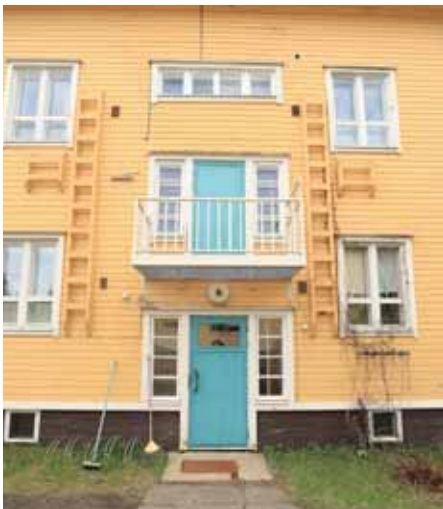
28. sisäänkäyntien päällä on tuuletusparvekkeet. (Kuva: Riitta Kosonen, Arkkitehtitoimisto Jorma Teppo Oy, 5/2021.)
