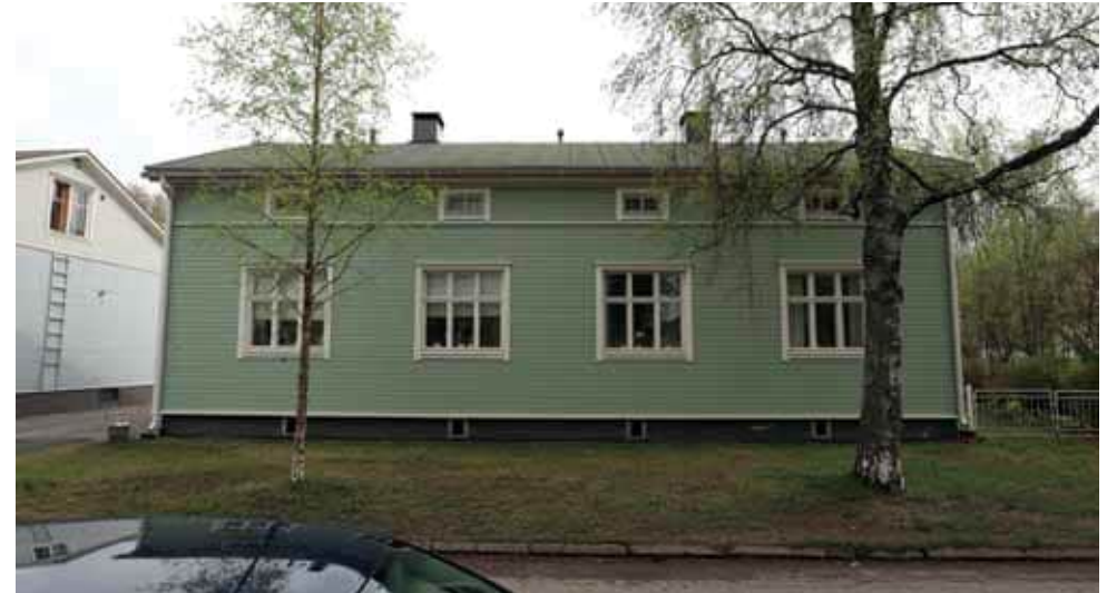
373. Puutarhakatu 11 katujulkisivu on säilynyt likimain alkuperäisen mukaisena. Merkittävin muutos on katemateriaalin vaihtuminen. Kaikki katujulkisivun ikkunat ovat alkuperäisiä. (Kuva: Riitta Kosonen, Arkkitehtitoimisto Jorma Teppo Oy, 5/2021.)
