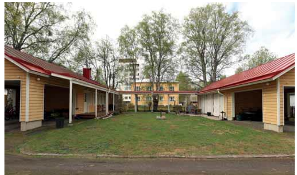
76. Tontin laiduille sijoittuvat suurehkot piharakennukset on yhdistetty pyykin kuivatuskatoksella. Pihan keskellä sijaitsee kaivo. (Kuva: Riitta Kosonen, Arkkitehtitoimisto Jorma Teppo Oy, 5/2021.)
