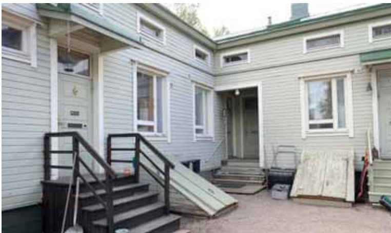
445. Haukkaikkunat ovat alkuperäiset, ulko-ovet ilmeisesti alkuperäisen mukaisina uusittu. Kellarin luukut ovat alkuperäisen mukaiset. (Kuva: Riitta Kosonen, Arkkitehtitoimisto Jorma Teppo Oy, 5/2021.)
