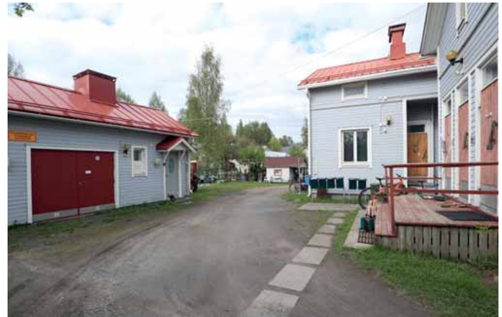
537. Pihan jäsenyminen on pitkälti alkuperäisen mukaista. L-laajennuksen katto on uusittu. (Kuva: Riitta Kosonen, Arkkitehtitoimisto Jorma Teppo Oy, 5/2021.)
