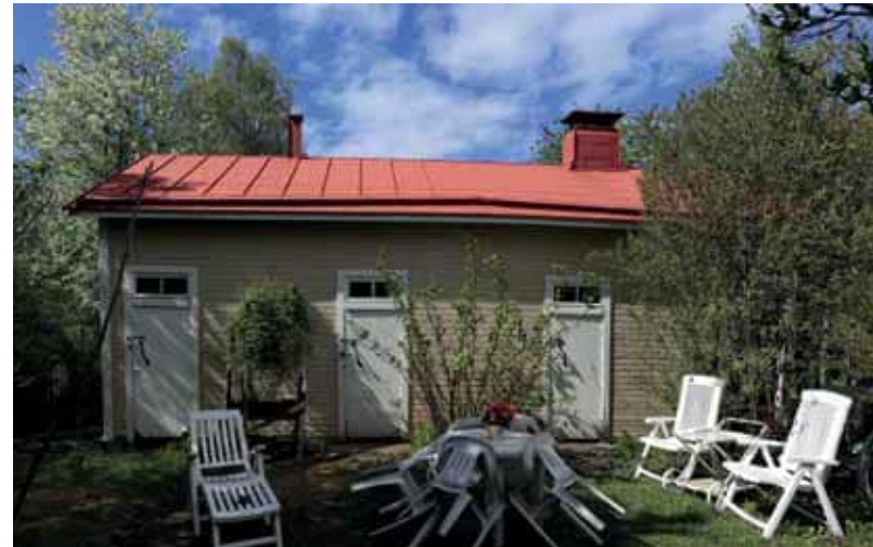
307. Karjakatu 22 piharakennus on säilynyt lähes alkuperäisenä. Piiput on pellitetty. (Kuva: Riitta Kosonen, Arkkitehtitoimisto Jorma Teppo Oy, 5/2021.)
