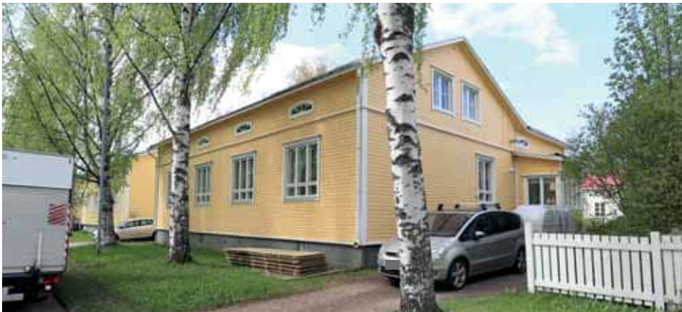
433. Karjakatu 6 L-laajennukseen on lisätty kuisti sisäänkäynnin kohdalle. (Kuva: Riitta Kosonen, Arkkitehtitoimisto Jorma Teppo Oy, 5/2021.)
