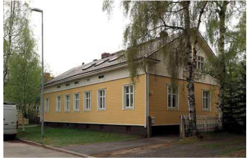
64. Puutarhakatu 10 ullakko on otettu käyttöön. Alkuperäiseen kattoon on lisätty lapeikkunoita. (Kuva: Riitta Kosonen, Arkkitehtitoimisto Jorma Teppo Oy, 5/2021.)
