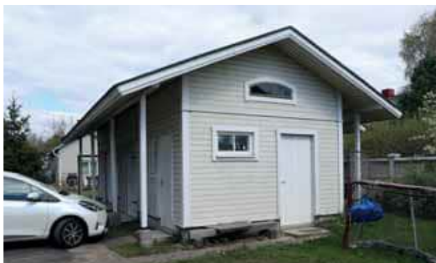
617. Piharakennuksessa on huomiota herättävän pitkät räystäät. (Kuva: Riitta Kosonen, Arkkitehtitoimisto Jorma Teppo Oy, 5/2021.)
