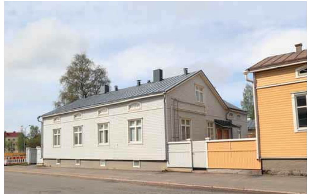
633. Teuvo Pakkalan katu 24 ikkunat on palautettu lähemmäksi alkuperäistä tyyliä. Sisäänkäyntikatus ja toinen ovi ovat 2000-luvun lisäykset. Liikenteeltä suojaa korkea puuaita. (Kuva: Riitta Kosonen, Arkkitehtitoimisto Jorma Teppo Oy, 5/2021.)
