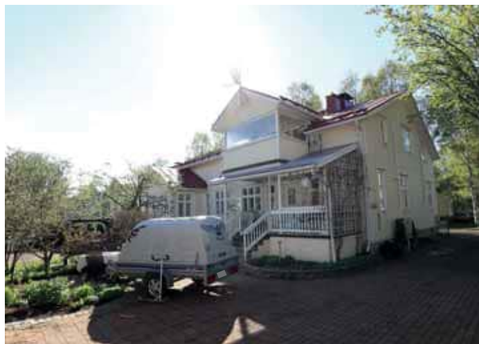
236. Puutarhakatu 17 korkeampaa kuistia on laajennettu valokatteisella ja lasitetulla osalla. Pihan puolella on lisäksi lisätty ilmalämpöpumppu ja lautasantenni. (Kuva: Riitta Kosonen, Arkkitehtitoimisto Jorma Teppo Oy, 5/2021.)
