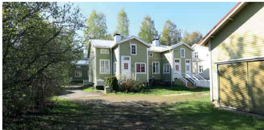
242. Puutarhakatu 19 isompi piha on edelleen saman henkinen kuin 1960-luvulla. Myös rakennuksen alkuperäinen luonne on säilynyt, vaikka ikkunat on pääosin uusittu, yksi sisäänkäynti on poistettu ja ulko-ovet sekä vesikate on uusittu. (Kuva: Riitta Kosonen, Arkkitehtitoimisto Jorma Teppo Oy, 5/2021.)
