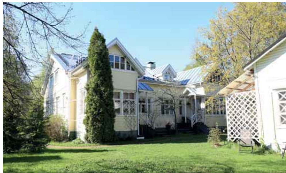
257. Pihan puolella kaksi kuistia ja kattolyhdyt ovat selkeitä muutoksia alkuperäiseen ja edustavat tyypillistä 1980-luvun kerrostumaa Puu-Raksilassa. Laajennusten ikkunat ja ovet ovat kuitenkin vanhoja ja tuotu Tuiran puretuista puutaloista. Katto on uusittu saumattuna peltikatteenä. (Kuva: Riitta Kosonen, Arkkitehtitoimisto Jorma Teppo Oy, 5/2021.)
