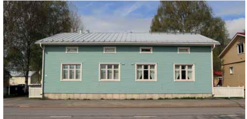
556. Teuvo Pakkalan katu 4:n sokkelissa näkyy levymuottikuvio. Katto on konesaumattu peltikatto. (Kuva: Riitta Kosonen, Arkkitehtitoimisto Jorma Teppo Oy, 5/2021.)
