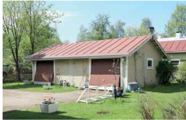
314. Autotallin materiaalit mukailevat alkuperäistä talousrakennusta. (Kuva: Riitta Kosonen, Arkkitehtitoimisto Jorma Teppo Oy, 5/2021.)
