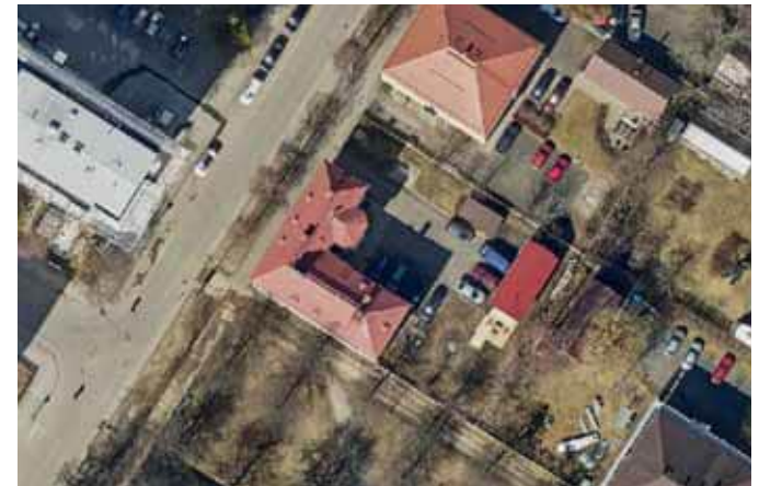
49. Syrjäkatu 11 on rakennettu kiinni tontin rajoihin Puistikkokadun ja Syrjäkadun nurkkaukseen. Piha jakautuu nurmialueisiin ja asfalttipintaiseen paikoitus- ja kulkualueeseen. (Kuva: Ilmakuva 7.5.2020, Terratec Oy, Oulun kaupungin karttapalvelu)
