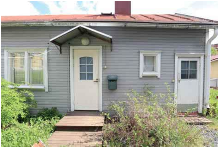
493. Karjakatu 11 piharakennukseen on lisätty kaksiosaisia suuria ikkunoita sekä uusi tyylistä poikkeava ulko-ovi. Oven ylle on lisätty sisäänkäyntikatos. (Kuva: Riitta Kosonen, Arkkitehtitoimisto Jorma Teppo Oy, 5/2021.)
