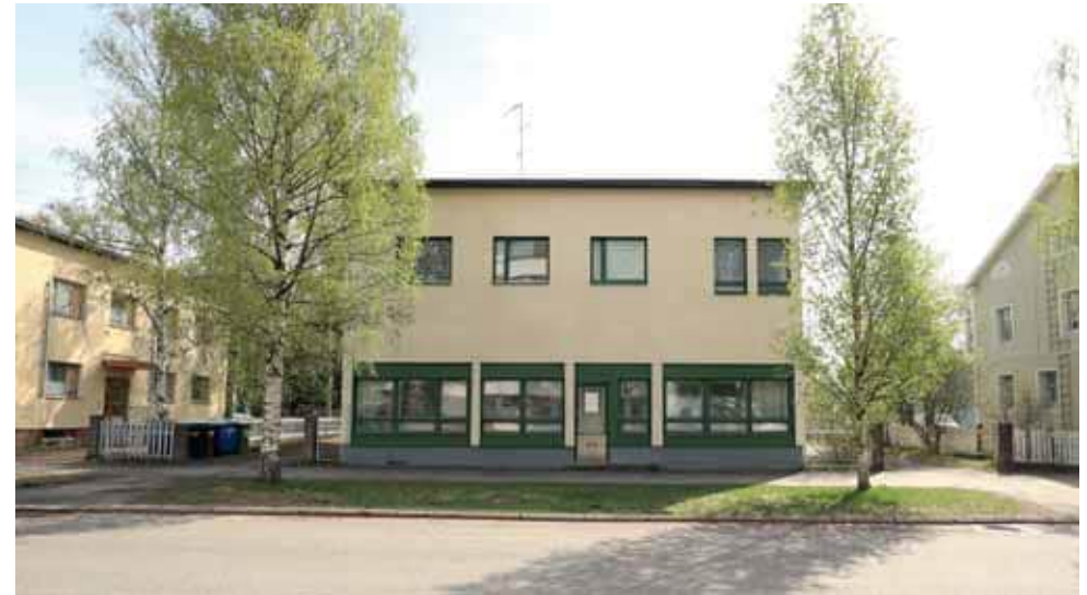
135. Syrjäkatu 17 katujulkisivun ensimmäisen kerroksen aukotuksessa ja sisäänkäynneissä on tapahtunut huomattavia muutoksia. (Kuva: Riitta Kosonen, Arkkitehtitoimisto Jorma Teppo Oy, 5/2021.)
