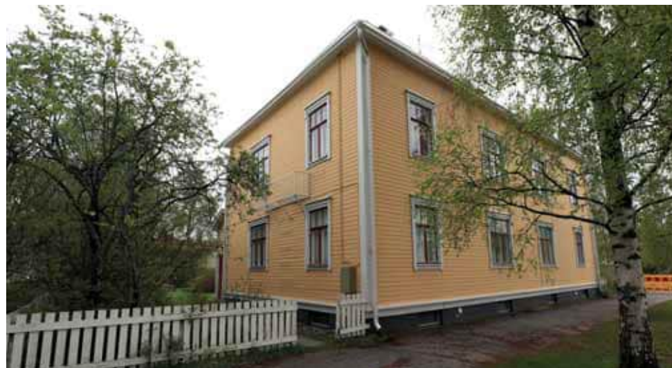
159. Syrjäkatu 23 Syrjäkadulta kuvattuna. Peltikatto on uusittu alkuperäisen mukaisena. Aita on uusittu Raksilalle tyypillisenä puusäleaitana. (Kuva: Riitta Kosonen, Arkkitehtitoimisto Jorma Teppo Oy, 5/2021.)
