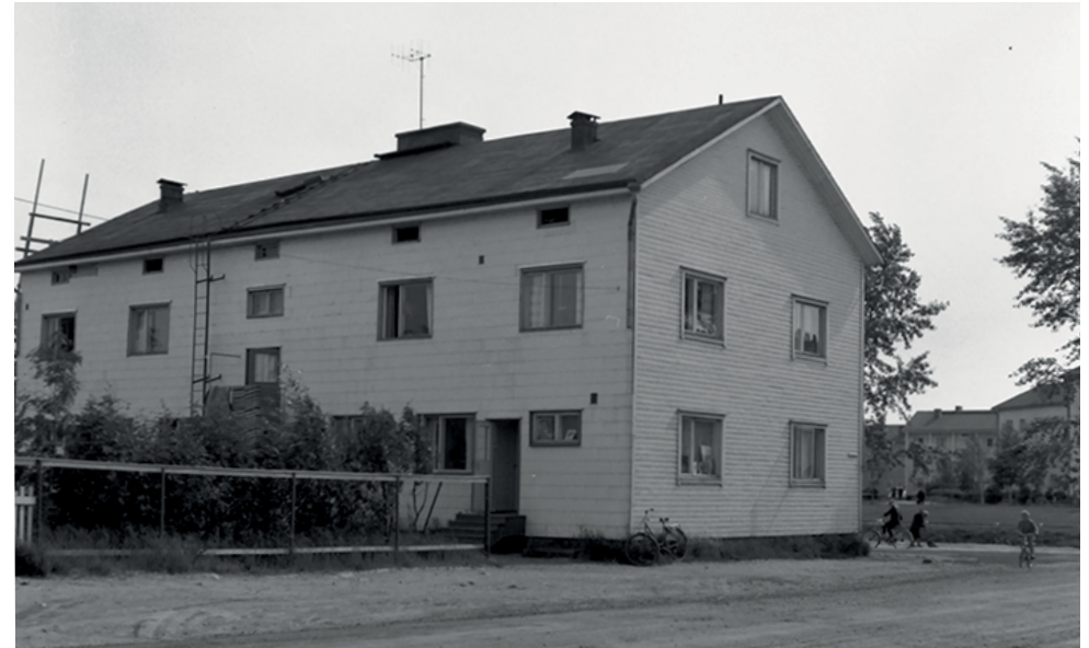
623. Karjakatu 29 näyttäisi massaltaan ja aukotukseltaan toteutuneen suunnitelmien mukaisesti. Pystyhirsirunkoinen rakennus verhoiltiin kuitenkin rappauksen sijasta kadun puolelta vaakalau-doituksella ja pihan puolelta mineriittilevyillä. Vesikatteeksi ei laitettu tiilikattoa vaan tavallinen huopakate. Tonttia ympäröi korkea metalliverkkoaita. Taustalla näkyvät Karjasillan kerrostalot. (Kuva: Pohjois-Pohjanmaan museo, kuvaaja Ahti Paulaharju, 1964.)
