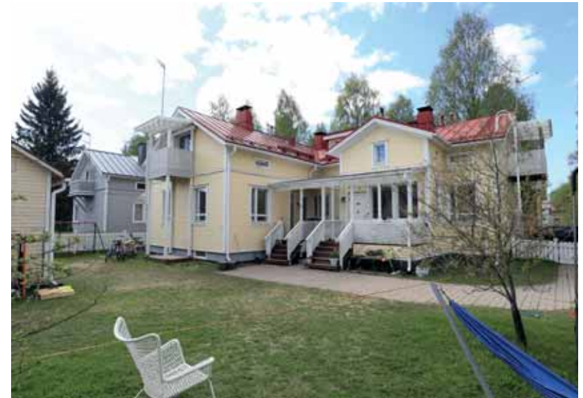
481. Karjakatu 9 pihan puolelle on lisätty runsaasti vaakarimoitettuja terassi- ja parvekerakennelmia, jotka erottuvat selvästi uutena kerroksena. (Kuva: Riitta Kosonen, Arkkitehtitoimisto Jorma Teppo Oy, 5/2021.)
