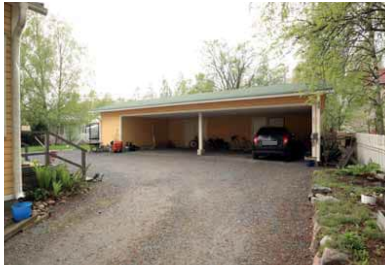
659. Kookas autokatos hallitsee näkymää tontille tultaessa. Autokatos poikkeaa kooltaan tyyliltään Puu-Raksilalle tyypillisistä piharakennuksista. (Kuva: Riitta Kosonen, Arkkitehtitoimisto Jorma Teppo Oy, 5/2021.)
