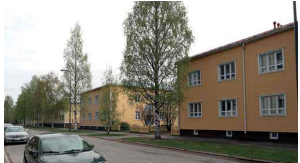
33. Nykyisinkin Syrjäkatu 7 ja 9 ovat lähes samanlaiset, mutta kattojen väritys eroaa edelleen. (Kuva: Riitta Kosonen, Arkkitehtitoimisto Jorma Teppo Oy, 5/2021.)
