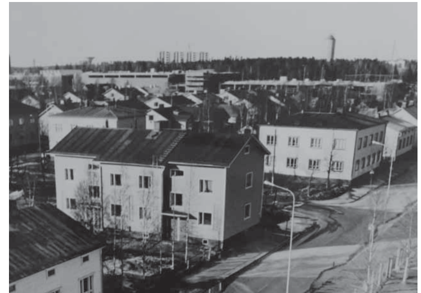
508. Teuvo Pakkalankatu 14 sijaitsee kuvassa oikealla. Taustalla näkyvät 1974-75 valmistuneet ensimmäiset Intiön tornitaloista, joten kuva on otettu 1970-luvun puolivälissä. (Kuva: Raksilan asukasyhdistys.)
