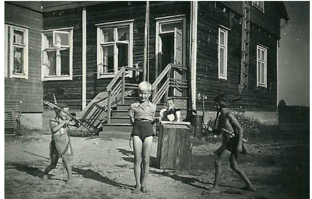
554. Teuvo Pakkalan katu 4 vuonna 1947. Hirsirunkoista rakennusta ei ole vielä vuorilaudoitettu kokonaan. alkuperäinen ulko-ovi ja ikkunat erottuvat selvästi. (Kuva: Raksilan asukas yhdistys.)
