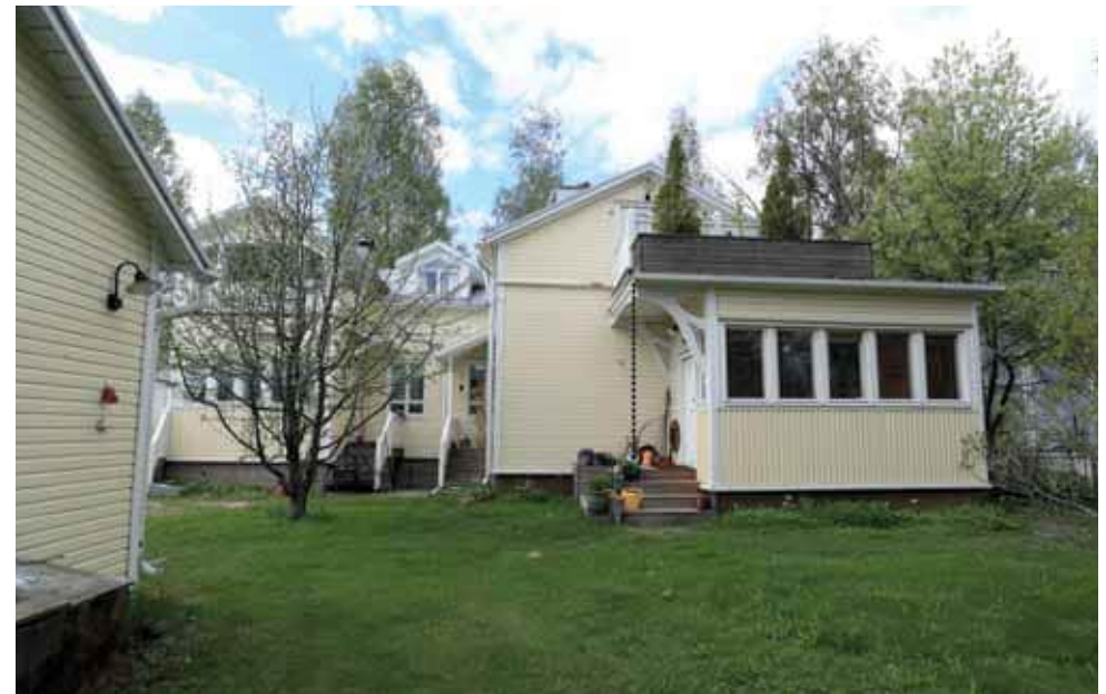
472. Kuvan jälleenrakennuskauden tyylinen kuistiaihe on 1940-luvulta, mutta sen päällinen parveke ja parvekettä kantavat koristeelliset konsolit 1990-luvulta. (Kuva: Riitta Kosonen, Arkkitehtitoimisto Jorma Teppo Oy, 5/2021.)
