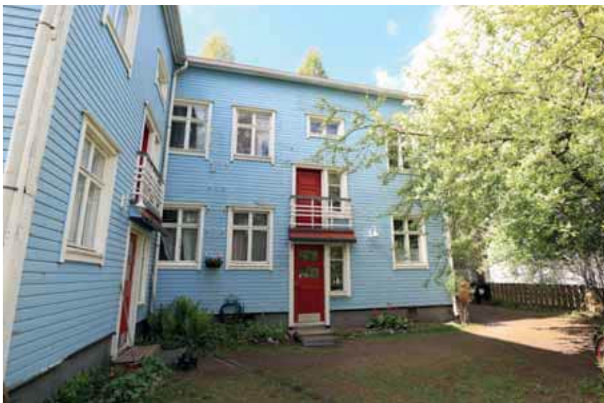
505. Sisäänkäyntien päällä on tuuletusparvekkeet. (Kuva: Riitta Kosonen, Arkkitehtitoimisto Jorma Teppo Oy, 5/2021.) Oy, 5/2021.)
