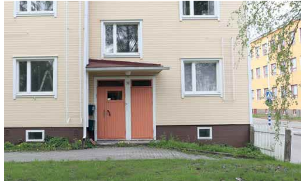
670. Ulko-ovet ovat alkuperäiset tai likimain alkuperäisen mukaisina uusitut. Viisto katos suojaa sisäänkäyntejä. (Kuva: Riitta Kosonen, Arkkitehtitoimisto Jorma Teppo Oy, 5/2021.)
