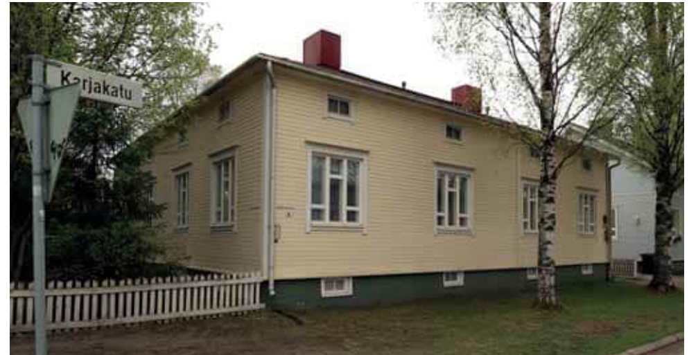
450. Karjakatu 1:n ominaispiirteet ovat säilyneet ikkunoiden vaihtamisesta huolimatta. (Kuva: Riitta Kosonen, Arkkitehtitoimisto Jorma Teppo Oy, 5/2021.)
