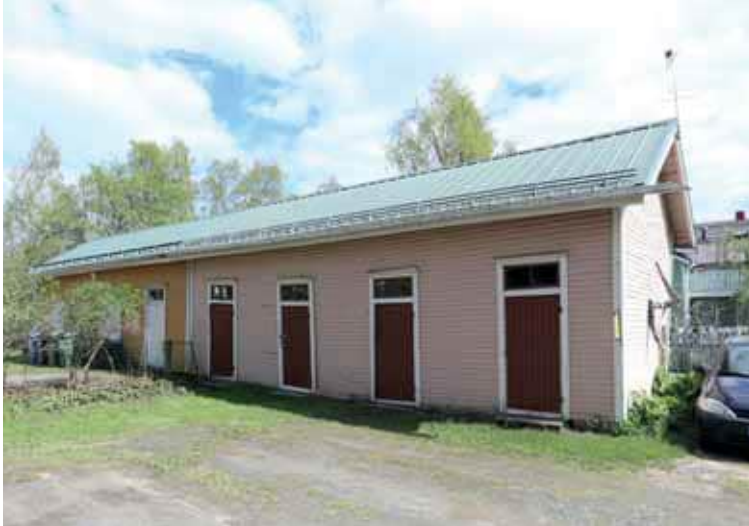
591. Karjakatu 19 piharakennuksen ulko-asu on säilynyt vesikatteen ja ulko-ovien vaihtamista lukuun ottamatta. (Kuva: Riitta Kosonen, Arkkitehtitoimisto Jorma Teppo Oy, 5/2021.)
