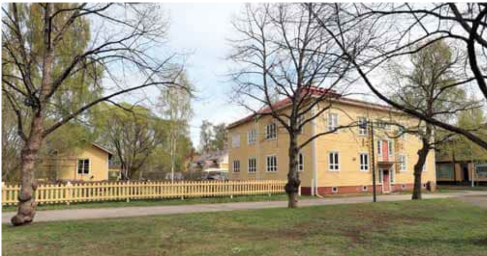
60. Syrjäkatu 9:n piharakennuksessa on huopakate ja pystypanelointi. Mittasuhteiltaan rakennus on likipitään Puu-Raksilan piharakennusten mukainen. (Kuva: Riitta Kosonen, Arkkitehtitoimisto Jorma Teppo Oy, 5/2021.)
