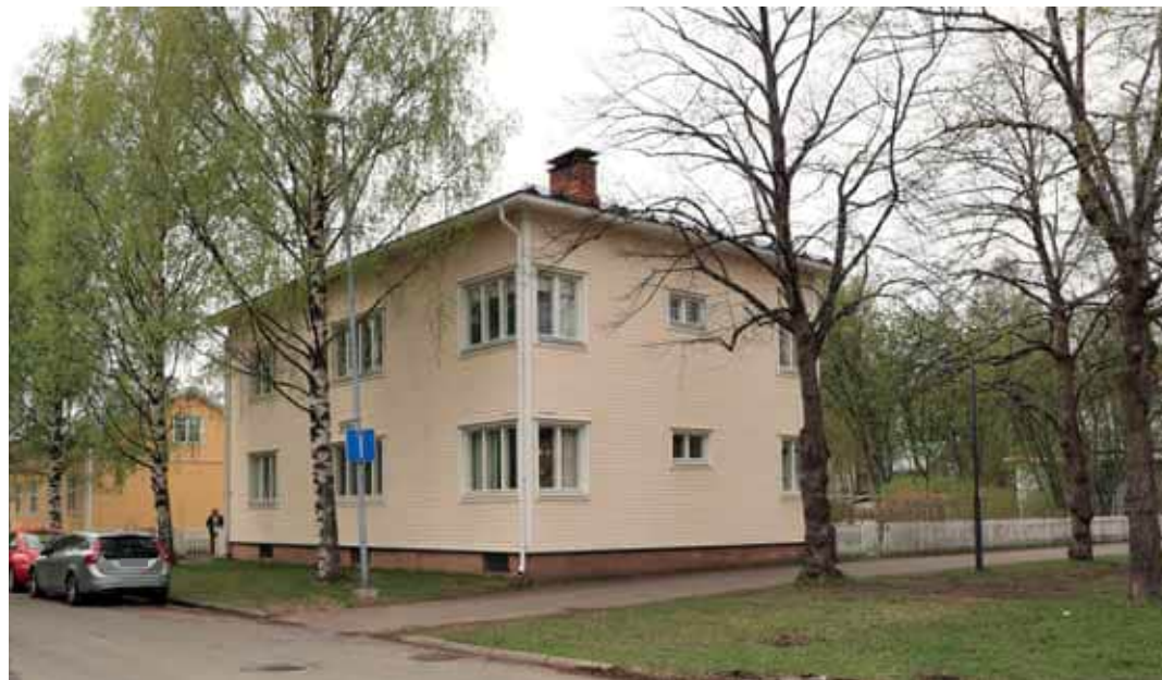
331. Karjakatu 16 julkisivussa ei ole havaittavissa muita muutoksia kuin ulkopuolinen lisälämmöneristys ja uudet räystäskourut ja syöksytorvet. (Kuva: Riitta Kosonen, Arkkitehtitoimisto Jorma Teppo Oy, 5/2021.)
