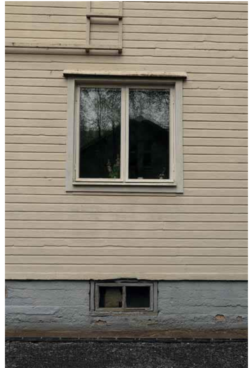
220. Puutarhakatu 14:n ikkunat ovat alkuperäiset. (Kuva: Riitta Kosonen, Arkkitehtitoimisto Jorma Teppo Oy, 5/2021.)
