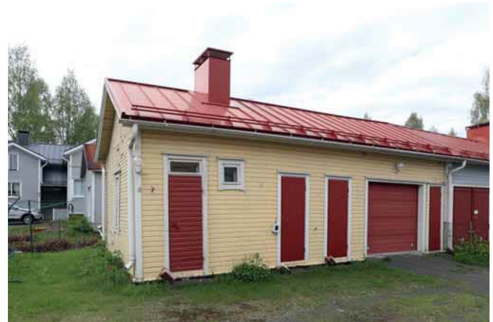
522. Tontin 258 alkuperäiseen piharakennukseen on tehty autokatos ja huopakatto on uusittu saumattuna peltikatteenä. Muutoin rakennus on alkuperäisen mukainen. (Kuva: Riitta Kosonen, Arkkitehtitoimisto Jorma Teppo Oy, 5/2021.)
