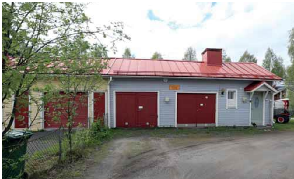
534. Autotallirakennus mukaillee alkuperäisen talusrakennuksen materiaaleja ja mittasuhteita. Varastoon johtava ovi poikkeaa pihapiirin tyylistä. (Kuva: Riitta Kosonen, Arkkitehtitoimisto Jorma Teppo Oy, 5/2021.)
