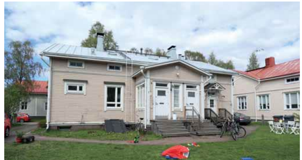
341. Puutarhakatu 3:n ulko-ovet on vaihdettu ja sisäänkäynnin päälle rakennettu katos. (Kuva: Riitta Kosonen, Arkkitehtitoimisto Jorma Teppo Oy, 5/2021.)
