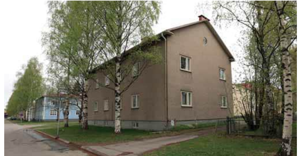
576. Karjakatu 15 päädyissä on ullakon alkuperäiset pyöreät ikkunat. (Kuva: Riitta Kosonen, Arkkitehtitoimisto Jorma Teppo Oy, 5/2021.)
