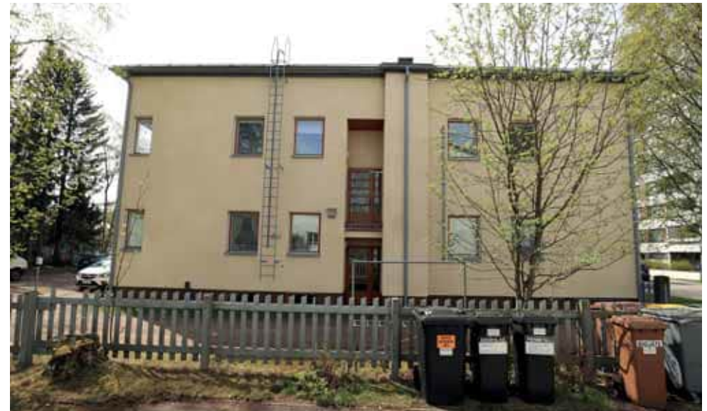
125. Syrjäkatu 15 kuvattuna pohjoisesta. Sisäänkäynti on sisäänvedettynä. Häätäpoistumistietikkaita on uusittu. (Kuva: Riitta Kosonen, Arkkitehtitoimisto Jorma Teppo Oy, 5/2021.)
