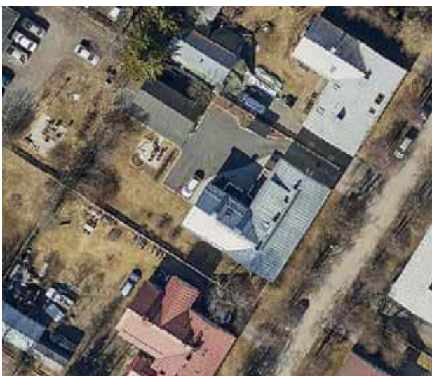
197. Tontin 217 piha-alue on aiemmin ollut jakautunut nurmi- ja hyötypuutarha-alueisiin. Eteläreunalla on ollut ja on edelleen marjapensaita. Tonttia reunustanut koivurivi on poistettu. Nykyisin iso osa pihaa on sepelöity paikoitusalueeksi. (Kuva: Ilmakuva 7.5.2020, Terratec Oy, Oulun kaupungin karttapalvelu)
