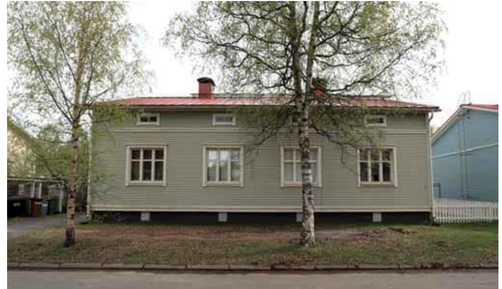
354. Puutarhaku 5 katujulkisivu on pääosin alkuperäisen mukainen. Pohjakerroksen vesikatto ja ikkunat on uusittu. (Kuva: Riitta Kosonen, Arkkitehtitoimisto Jorma Teppo Oy, 5/2021.)
