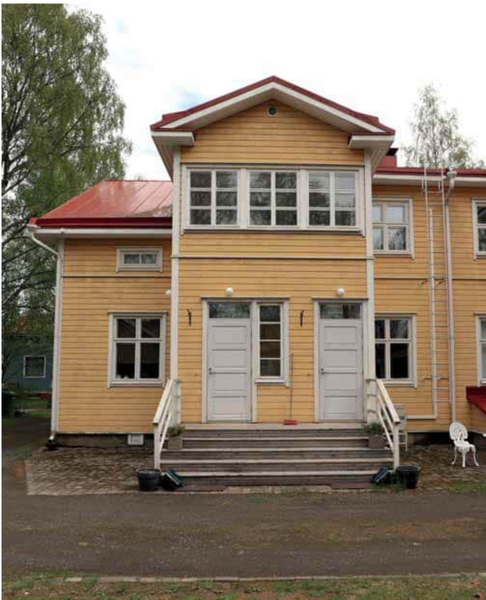
77. Ulko-ovet ovat alkuperäisten suunnitelmien mukaiset. Alakerran ikkunat ovat alkuperäiset. Korotetussa osassa on uudet perinteiset puuikkunat. (Kuva: Riitta Kosonen, Arkkitehtitoimisto Jorma Teppo Oy, 5/2021.)
