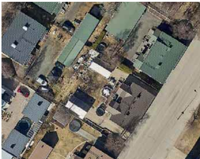
650. Tontin 277 luonne on muuttunut 1960-luvun avoimesta ja huolettomasti hoidetusta pihasta tarkkarajaisesti hoidetuksi piha-alueeksi. Pihan avoimus ja luonne yhteispihana ovat säilyneet, mutta kaksi piharakennusta pienentävät alkuperäistä piha-alaa. (Kuva: Ilmakuva 7.5.2020, Terratec Oy, Oulun kaupungin karttapalvelu)
