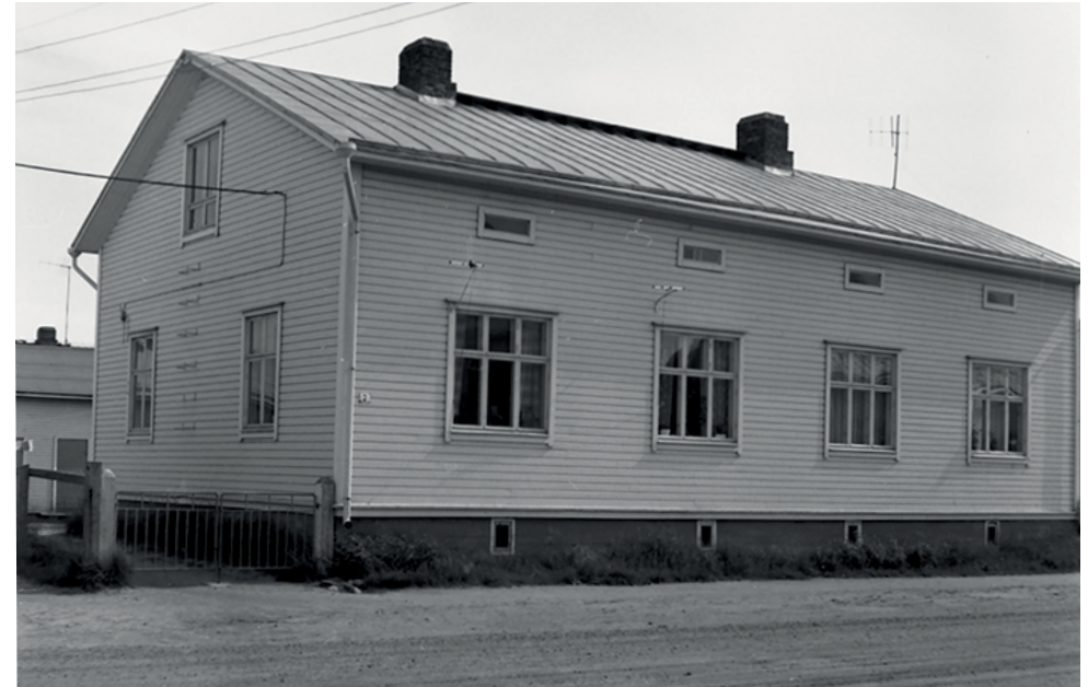
475. Karjakatu 7:n edustaa tyypillistä raxsilalaista rakennusta. Pihalle kuljetaan metalliputkiportin kautta. Päärakennuksessa on peltikate ja piharakennuksessa huopakatto. (Kuva: Pohjois-Pohjanmaan museo, kuvaaja Ahti Paulaharju, 1964.)
