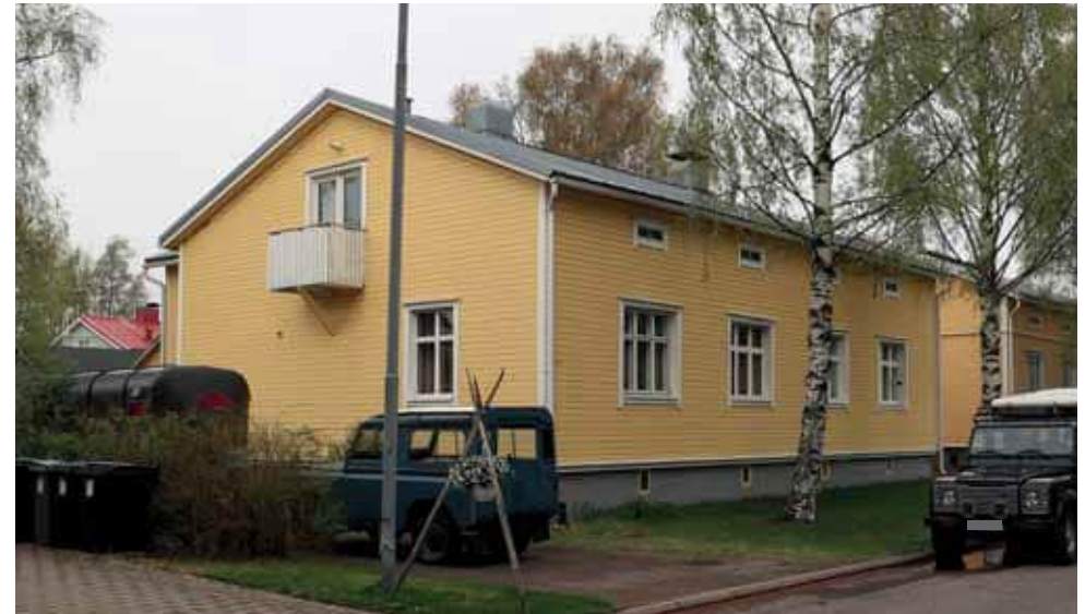
424. Karjakatu 8 eteläpäädyyn on lisätty pieni parveke ja uusi ikkuna. Ikkunat ovat jääneet voimakkaasti syvennykseen. (Kuva: Riitta Kosonen, Arkkitehtitoimisto Jorma Teppo Oy, 5/2021.)
