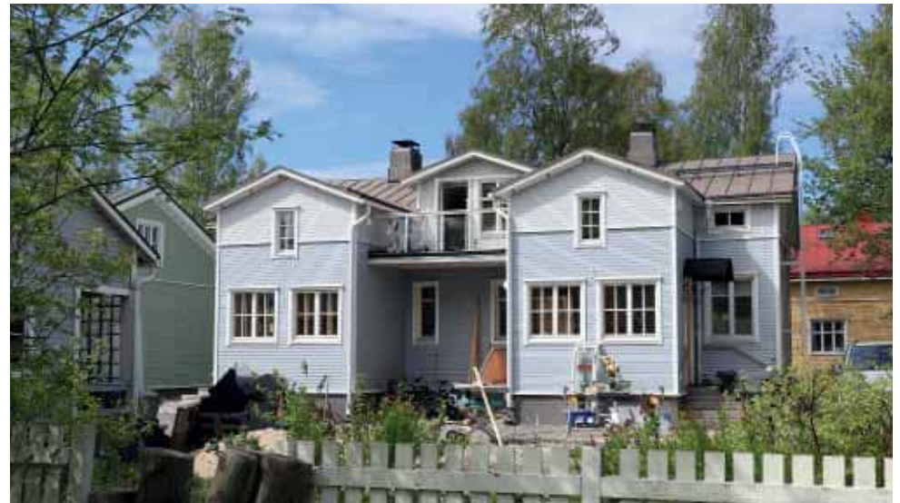
368. Puutarhakatu 9 pihan puolella on tehty runsaammin muutoksia 1980-luvulta tähän päivään. Ullakkoa on korotettu rakennuksen keskeltä ja lisätty parveke. Kuistien aukotusta ja sisäänkäyntejä on muutettu. (Kuva: Riitta Kosonen, Arkkitehtitoimisto Jorma Teppo Oy, 5/2021.)
