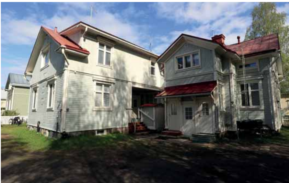
192. Puutarhakatu 20 pihan puolella on toteutettu muutoksia. Kattolapteen nostolla, sisääkäyntikatoksella ja ikkunoiden sekä ovien vaihdolla on kaikilla vaikutusta rakennuksen tyyliin. Katto on pääosin säilynyt alkuperäisenä tai alkuperäisen mukaisena. (Kuva: Riitta Kosonen, Arkkitehtitoimisto Jorma Teppo Oy, 5/2021.)
