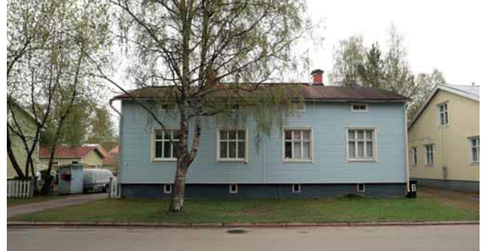
246. Puutarhaku 21 eteläpää on säilynyt lisälämmöneristystä ja piipun pellitystä lukuun ottamatta alkuperäisenä. Myös pohjoispää on kadulle päin alkuperäisen mukainen, vaikka ikkunat ja katemateriaali on vaihdettu. (Kuva: Riitta Kosonen, Arkkitehtitoimisto Jorma Teppo Oy, 5/2021.)
