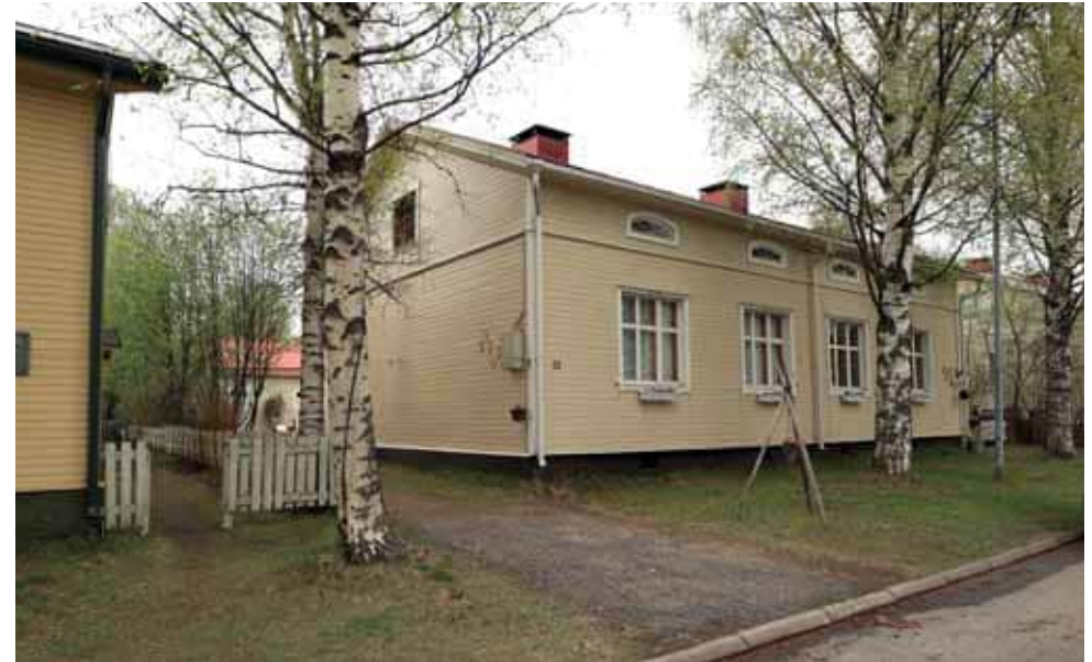
303. Karjakatu 22 katujulkisivun suurin muutos on uusitut ikkunat, jotka jäävät julkisivussa voimakkaasti syvennykseen. Ullakon sirot kaarevat haukkaikkunat ovat alkuperäiset. (Kuva: Riitta Kosonen, Arkkitehtitoimisto Jorma Teppo Oy, 5/2021.)
