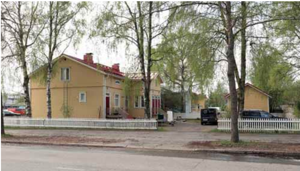
568. Teuvo Pakkalan katu 2:n pihaa ympäröi Puu-Raksilalle tyypillinen puusäleaita. Nurkkatontin pohjois- ja itäpuolella ympäristö on muuttunut merkittävästi. Kuvassa näkyvät päädyn ikkunat ovat uusia. (Kuva: Riitta Kosonen, Arkkitehtitoimisto Jorma Teppo Oy, 5/2021.)
