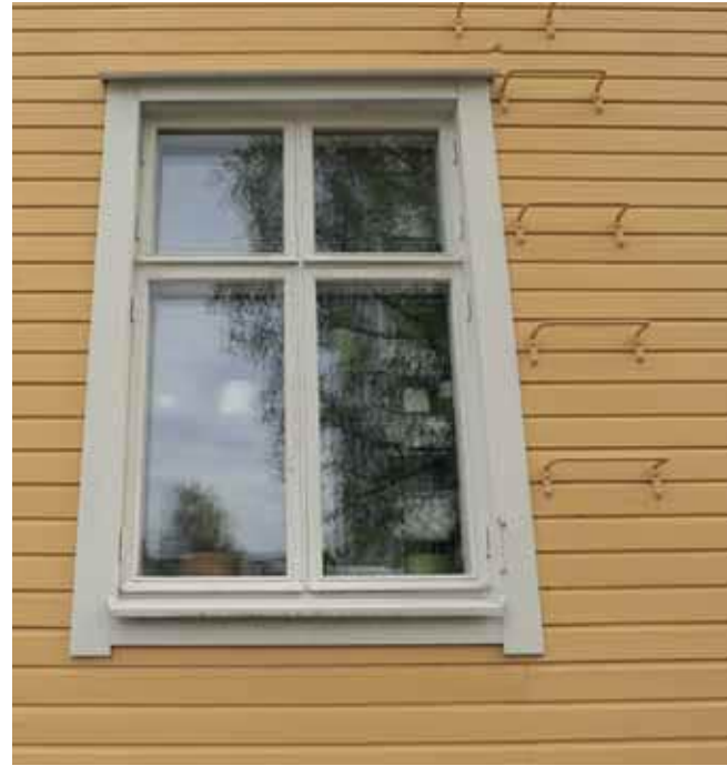
52. Alkuperäinen puuikkuna. (Kuva: Riitta Kosonen, Arkkitehtitoimisto Jorma Teppo Oy, 5/2021.)
