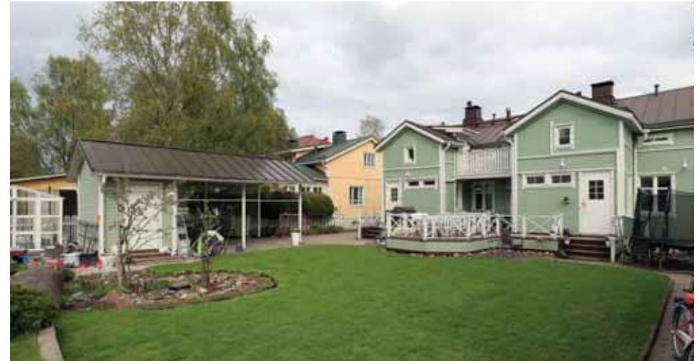
651. Teuvo Pakkalan katu 20:n pihan pinnat on tarkasti rajattu. Kuistien väliin on lisätty parveke ja mutterin muotoinen suuri terassi. (Kuva: Riitta Kosonen, Arkkitehtitoimisto Jorma Teppo Oy, 5/2021.)
