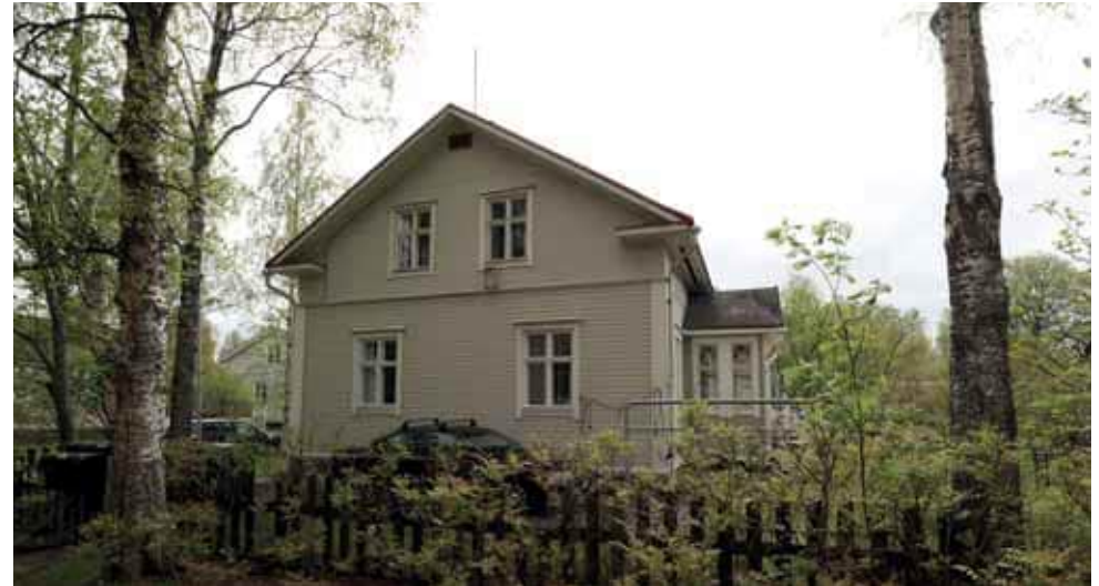
94. Päädyn alkuperäinen ikkuna on poistettu ja uudet ikkunat lisätty ennen vuotta 1986. Yläpohjan tuuletusta on parannettu päädyistä ja räystäään alta. Tonttia ympäröivä aitamalli on alueelle tyypillinen. (Kuva: Riitta Kosonen, Arkkitehtitoimisto Jorma Teppo Oy, 5/2021.)
