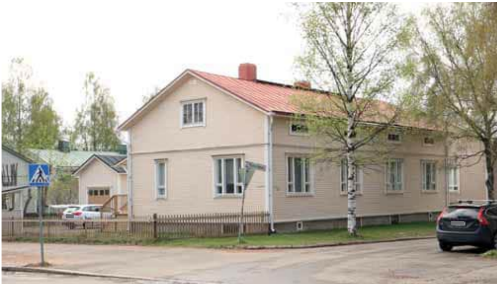
340. Puutarhakatu 1 katujulkisivut ovat säilyneet lähes alkuperäisinä. Ikkunat ovat alkuperäiset eikä niiden sijaintia julkisivun pinnassa ole muutettu. Katto on todennäköisesti alkuperäinen. (Kuva: Riitta Kosonen, Arkkitehtitoimisto Jorma Teppo Oy, 5/2021.)
