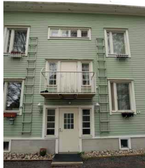
149. Sisäänkäyntien yhteydessä olevat pystyikkunat ovat alkuperäiset. Ulko-ovet on vaihdettu tyylliltään muusta rakennuksesta poikkeaviin. Myös parvekkeiden pinnakaiteet ovat alkuperäiset. (Kuva: Riitta Kosonen, Arkkitehtitoimisto Jorma Teppo Oy, 5/2021.)
