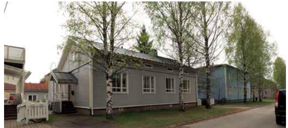
488. Karjakatu 11 katujulksivu on sittemmin muutettu lähes tontin ensimmäisen lupapiirustuksen mukaiseksi. Käynti kadulle ja näyteikkunat on poistettu. (Kuva: Riitta Kosonen, Arkkitehtitoimisto Jorma Teppo Oy, 5/2021.)
