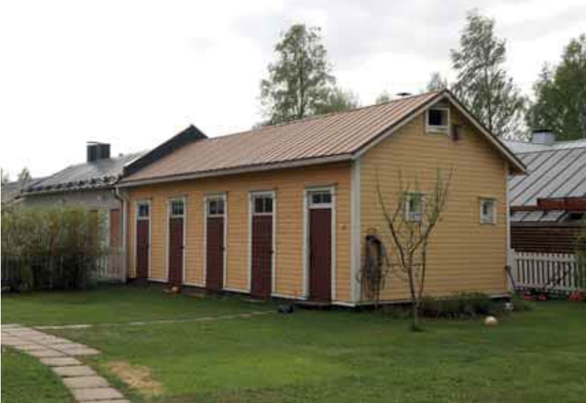
643. Teuvo Pakkalan katu 22 talousrakennuksen alkuperäiset ominaispiirteet ovat säilyneet. (Kuva: Riitta Kosonen, Arkkitehtitoimisto Jorma Teppo Oy, 5/2021.)
