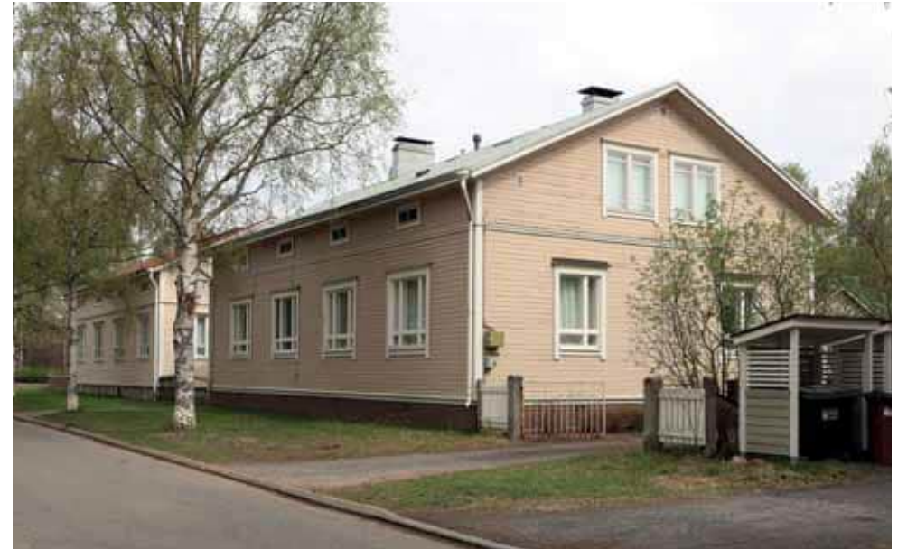
343. Puutarhakatu 3 katujulkisivun suurin muutos on pohjakerroksen ikkunoiden uusiminen. Muutoin julkisivu on säilynyt alkuperäisenä. (Kuva: Riitta Kosonen, Arkkitehtitoimisto Jorma Teppo Oy, 5/2021.)
