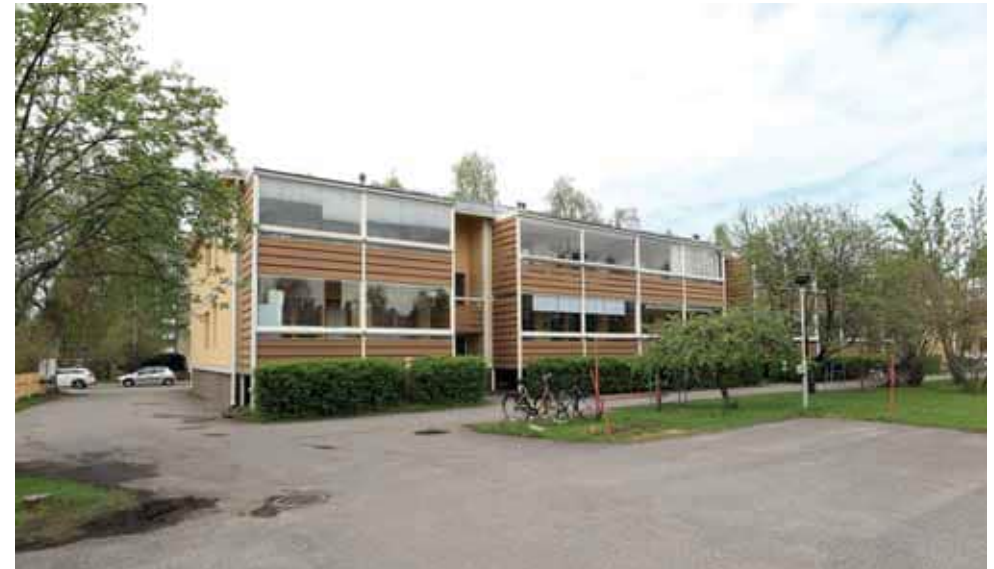
17. Syrjäkatu 3 - 5 kuvattuna pihan puolelta. Parvekkeisiin on lisätty lasitukset 1990-luvulla. Tontille on ajoyhteys rakennuksen molemmista päistä. Pihan molemmilla laidoilla sijaitsee paikoitusalue. (Kuva: Riitta Kosonen, Arkkitehtitoimisto Jorma Teppo Oy, 5/2021.)
