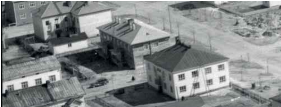
392. Puutarhakatu 13 odottaa vielä vuonna 1955 hirsien laskeutumista, ennen rakennuksen ulkuvuoraksen laittoa. (Kuva: Uuno Laukka 1955, Pohjois-Pohjanmaan museo, Uuno Laukan kuvakokoelmat.)
