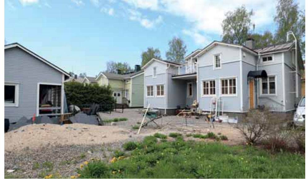
370. Puutarhakatu 9:ssä oli menossa peruskorjauksia inventointi hetkellä. Ulko-ovet on uusittu ja sisäänkäyntikatokset lisätty ulko-ovien päälle. Yläpohjan tuuletusta on parannettu. (Kuva: Riitta Kosonen, Arkkitehtitoimisto Jorma Teppo Oy, 5/2021.)
