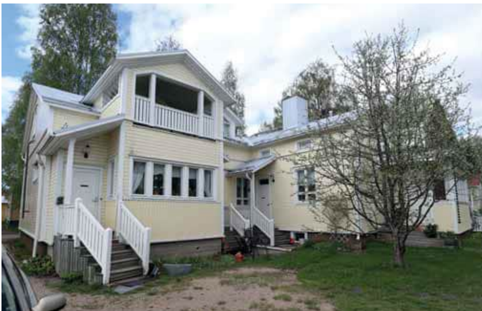
469. Pihan puolella julkisivuihin on tehty runsaasti muutoksia eri aikakausina. Korkea kuisti, sisäänkäyntikatokset, kattolyhty ja julkisivujen alaosan rimalaudoitus ovat peräisin 1990-luvulta. L-laajennus ja laajennuksen kuisti taas 1940-luvulta. (Kuva: Riitta Kosonen, Arkkitehtitoimisto Jorma Teppo Oy, 5/2021.)
