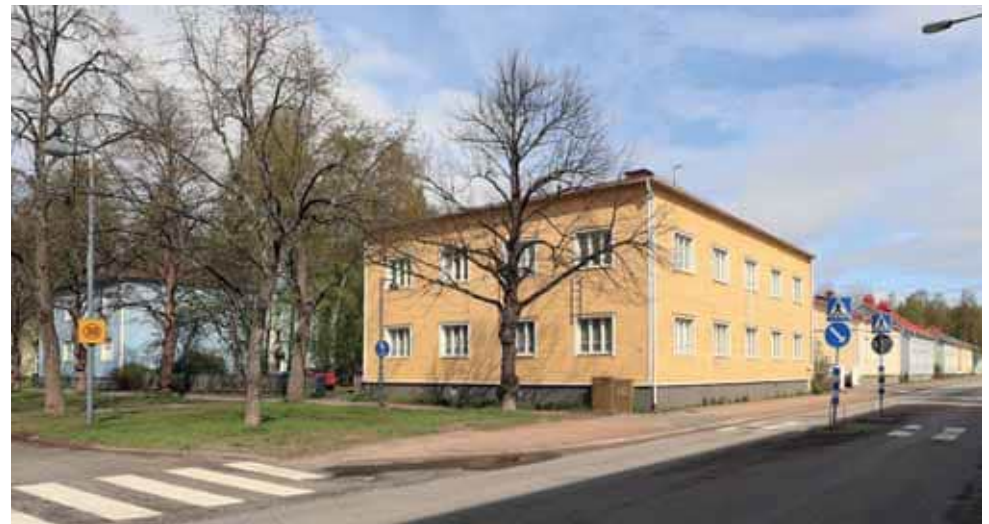
510. Teuvo Pakkalan katu 14:n ominaispiirteet ovat säilyneet, vaikka rakennusosia on uusittu. Ullakolle valoa tuoneet kattolyhdyt on poistettu. (Kuva: Riitta Kosonen, Arkkitehtitoimisto Jorma Teppo Oy, 5/2021.)
