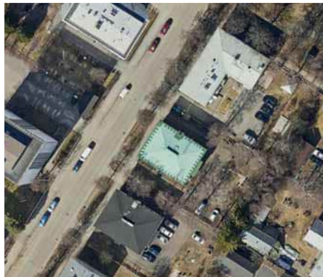
123. Tontin 207 piha-alue on säilynyt periaatteiltaan lähes samankaltaisena suhteessa rakennusaikaan. Vuoden 1961 ilmakuvasa näkyy kaavan mukaisella paikalla piharakennus, jota ei näy vuoden 1947 ilmakuvasa eikä sitä voida erottaa myöhemmissä ilmakuvasa. (Kuva: Ilmakuva 7.5.2020, Terratec Oy, Oulun kaupungin karttapalvelu)
