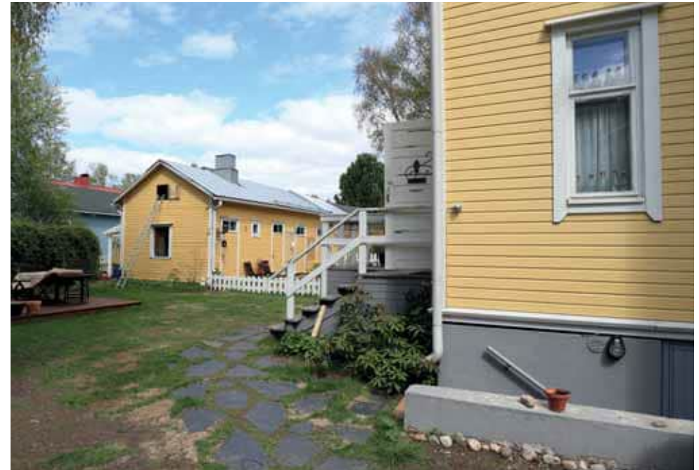
423. Karjakatu 8 piha-alueita. Rakennuksen päädystä on käynti päätyasunnon kellarin tehtyyn laajennukseen. (Kuva: Riitta Kosonen, Arkkitehtitoimisto Jorma Teppo Oy, 5/2021.)
