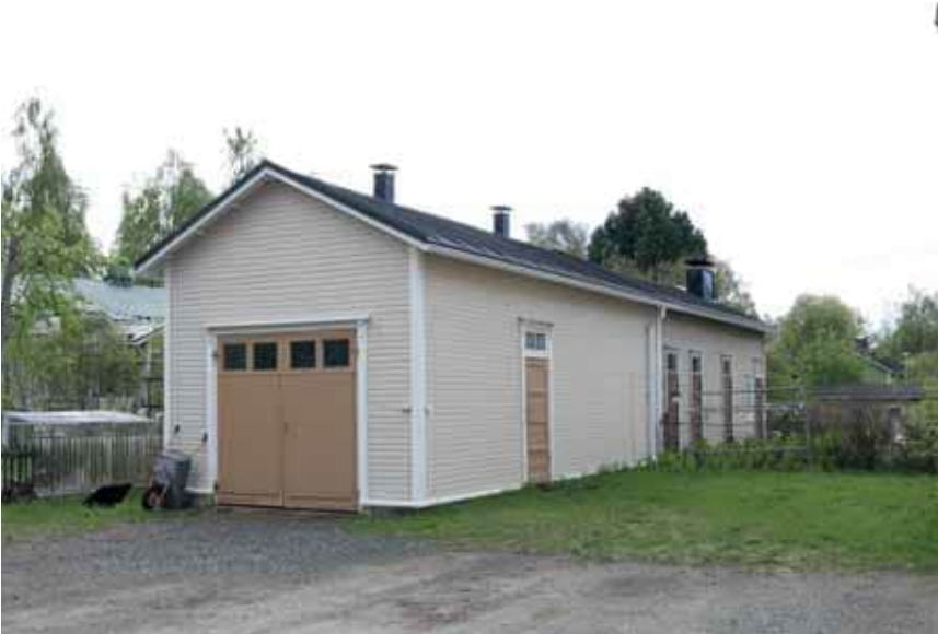
337. Puutarhakatu 1 alkuperäisestä piharakennuksesta on poistettu ylimääräiset ovet, kun rakennus muutettiin autosuojaksi. Päädyn pari ovi on 1960-luvun alulle tyypillinen. (Kuva: Riitta Kosonen, Arkkitehtitoimisto Jorma Teppo Oy, 5/2021.)
