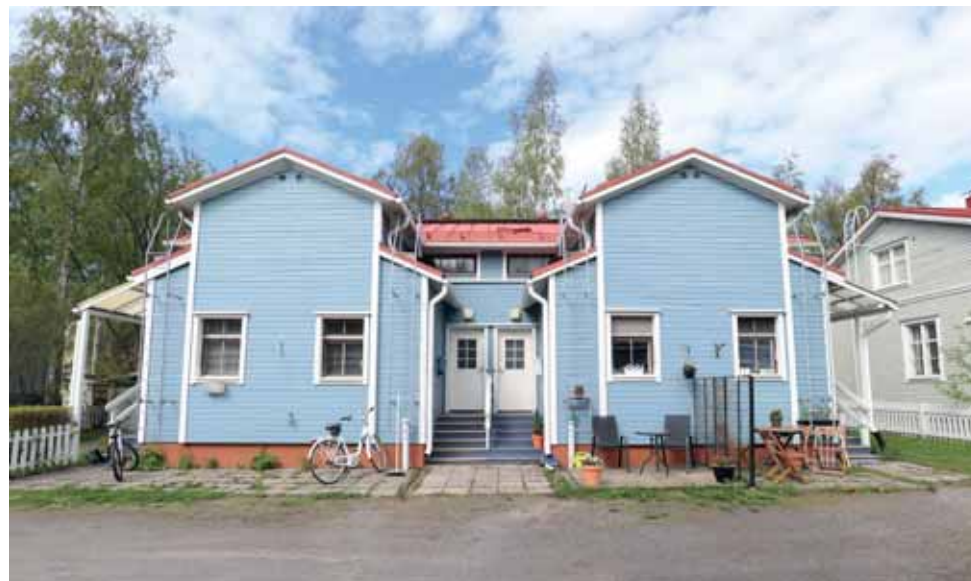
364. Puutarhakatu 7 sisäänkäynnit on siirretty pois kuisteista, jotka on otettu asuintiloiksi. Pihan puolen haukkaikkunoita on suurennettu. (Kuva: Riitta Kosonen, Arkkitehtitoimisto Jorma Teppo Oy, 5/2021.)
