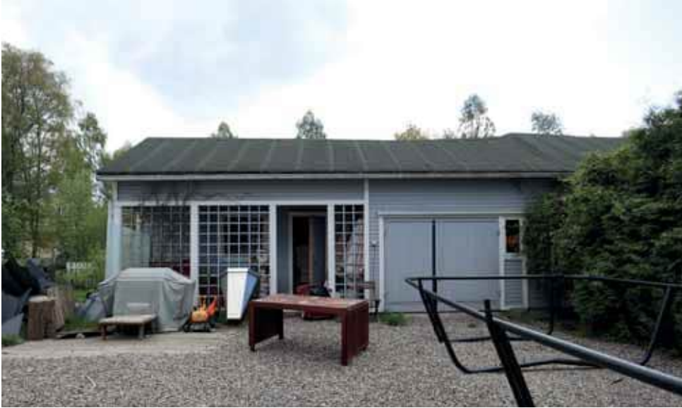
369. Puutarhakatu 9 piharakennusta on laajennettu autotalliksi tai se on rakennettu kokonaan uudestaan. Julkisivuun on lisätty puusäleiköt. (Kuva: Riitta Kosonen, Arkkitehtitoimisto Jorma Teppo Oy, 5/2021.)
