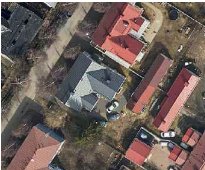
492. Tontin 255 pihalue on säilynyt lähes alkuperäisratkaisujen mukaisena. L-laajennus on muuttanut tilarakennetta, mutta 1950-luvun jälkeen pihan perusratkaisut ovat säilyneet ennallaan. (Kuva: Ilmakuva 7.5.2020, Terratec Oy, Oulun kaupungin karttapalvelu)
