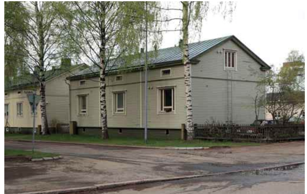
441. Karjakatu 2 katujulkisivun alkuperäiset ominaispiirteet ovat säilyneet ikkunoiden vaihdosta huolimatta. Myös vesikatto on uusittu saumattuna peltikatteenä. (Kuva: Riitta Kosonen, Arkkitehtitoimisto Jorma Teppo Oy, 5/2021.)
