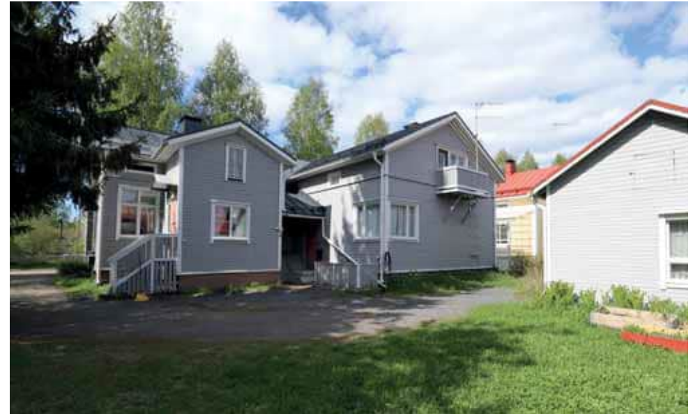
495. Karjakatu 11 kuistin aukotus on muuttunut. L-laajennuksen nurkkaikkuna on alkuperäinen, ja funktionalismille tyypillinen. Kuistin ja laajennuksen väliin jäävä katos on rakennuksen arkkitehtuurille vieras. (Kuva: Riitta Kosonen, Arkkitehtitoimisto Jorma Teppo Oy, 5/2021.)
