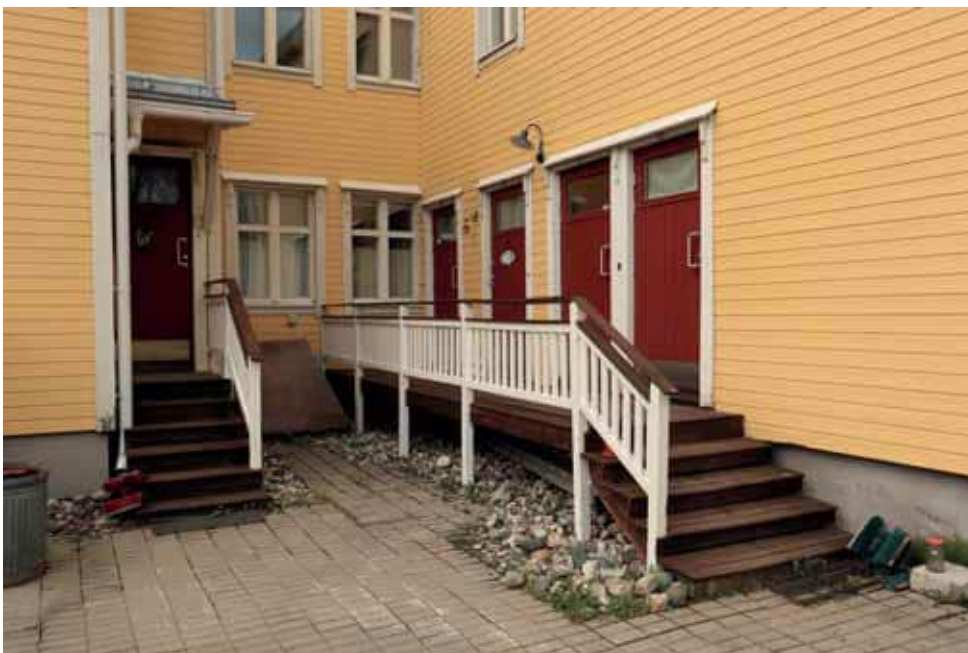
9. Syrjäkatu 1:n ulko-ovet ja ikkunat on uusittu. Myös kaiteet on uusittu. (Kuva: Riitta Kosonen, Arkkitehtitoimisto Jorma Teppo Oy, 5/2021.)
