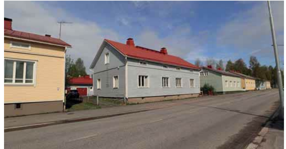
536. Teuvo Pakkalan katu 10 ominaispiirteet ovat säilyneet. Kadun puolella ei ole juuri lainkaan muutoksia. (Kuva: Riitta Kosonen, Arkkitehtitoimisto Jorma Teppo Oy, 5/2021.)
