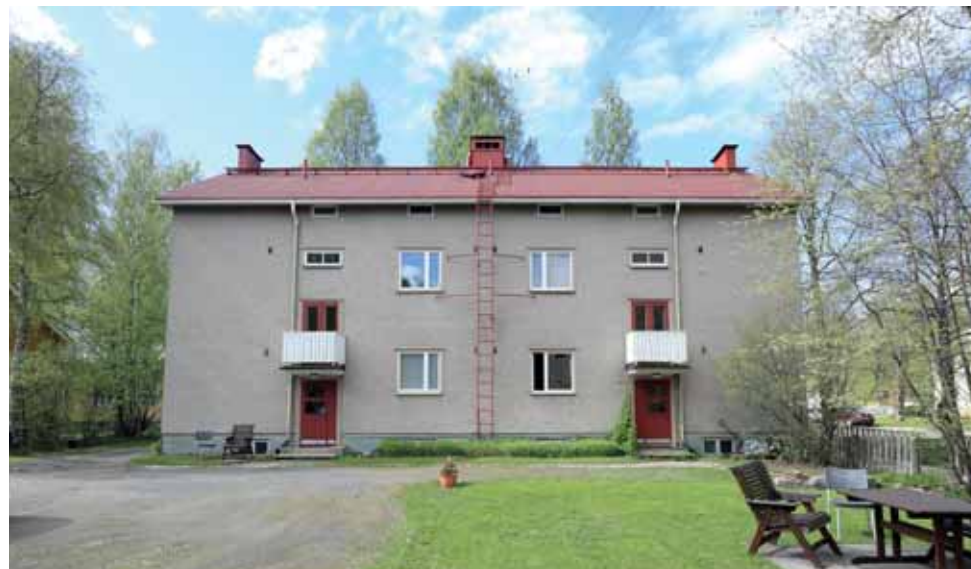
575. Karjakatu 15 pihajulkisivu on symmetrinen. Väritys on todennäköisesti alkuperäinen. (Kuva: Riitta Kosonen, Arkkitehtitoimisto Jorma Teppo Oy, 5/2021.)
