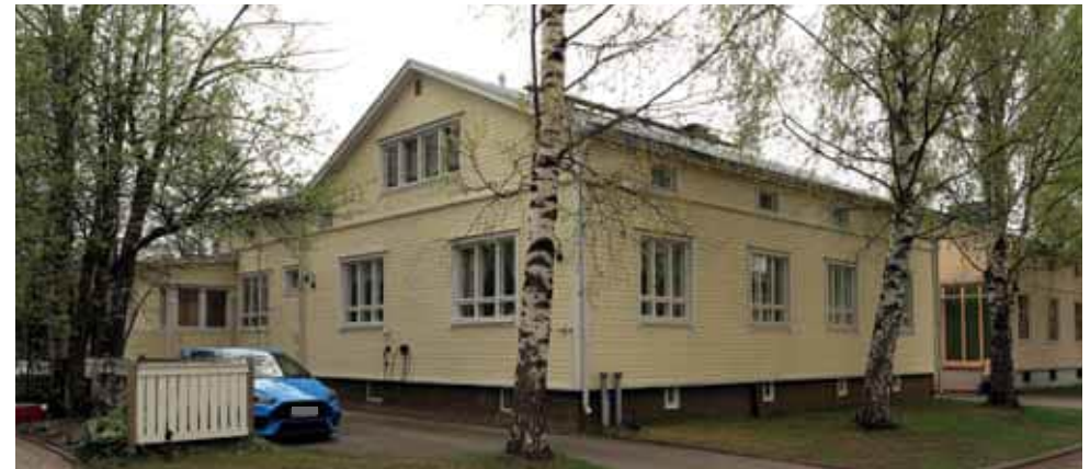
462. Karjakatu 5:n julkisivuissa ei ole tapahtunut juuri lainkaanmuutosta verrattuna 1960-lukuun. Kuvassa vasemmalla näkyvä kuistilaajennus oli jo tuolloin olemassa. Haukkaikkunat ovat siirtyneet syvennykseen. (Kuva: Riitta Kosonen, Arkkitehtitoimisto Jorma Teppo Oy, 5/2021.)
