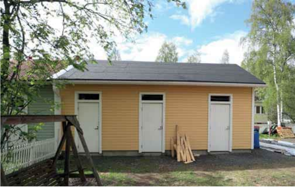
550. Teuvo Pakkalan katu 6:n piharakennus on kokonaan uusi. (Kuva: Riitta Kosonen, Arkkitehtitoimisto Jorma Teppo Oy, 5/2021.)
