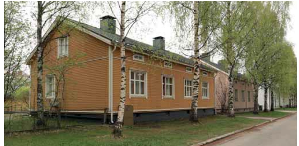
579. Karjakatu 17 ikkunat julkisivut on lisälämmöneristetty ja asuintilojen ikkunat uusittu. Vesikate on vaihdettu konesaumapeltikatteeksi. Karjakadun koivaja ei ollut vielä istutettu vuonna 1964. (Kuva: Riitta Kosonen, Arkkitehtitoimisto Jorma Teppo Oy, 5/2021.)
