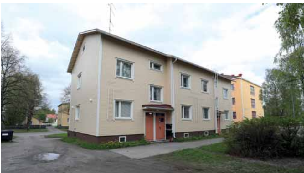
667. Teuvo Pakkalan katu 16 lännestä kuvattuna. Pihan puolella on rakennuksen massaa porrastettu. (Kuva: Riitta Kosonen, Arkkitehtitoimisto Jorma Teppo Oy, 5/2021.)
