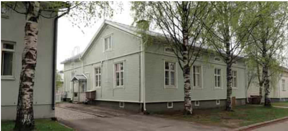
611. Karjakatu 23 nurkka-asunnon sisäänkäynnin päälle on lisätty katos. Haukkaikkunat ovat alkuperäiset. (Kuva: Riitta Kosonen, Arkkitehtitoimisto Jorma Teppo Oy, 5/2021.)
