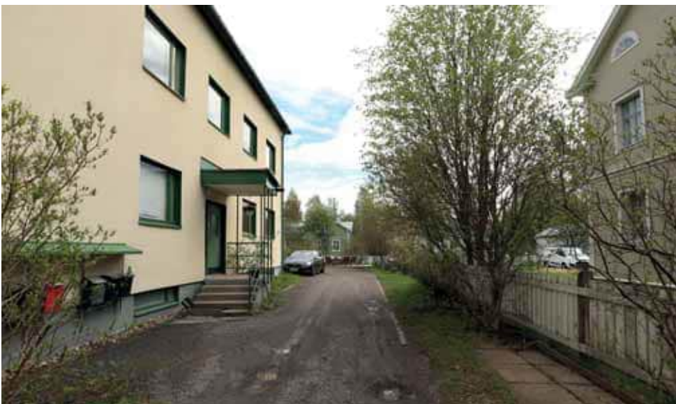
133. Pihan perällä on nurmea, pensasistutuksia ja kivetty oleskelualue. Kivituikkapintaiset autopaikat vievät suurimman osan piha-alueesta. (Kuva: Riitta Kosonen, Arkkitehtitoimisto Jorma Teppo Oy, 5/2021.)
