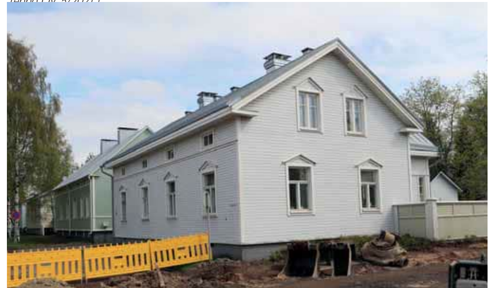
271. Puutarhakatu 27 päätyjulkisivuun on tehty ikkunamuutoksia ullakolle. Kainuuntien levennys on pienentänyt tonttia ja baanatyömaa ulottuu aivan rakennuksen tuntumaan. (Kuva: Riitta Kosonen, Arkkitehtitoimisto Jorma Teppo Oy, 5/2021.)
