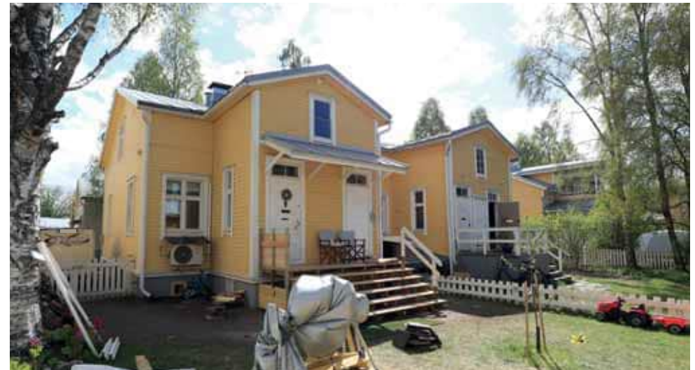
425. Pohjoispäädyn ikkunat on uusittu. Sisäänkäyntiä suojaa katos. Pihan puolelle on lisätty myös ilmalämpöpumppu. (Kuva: Riitta Kosonen, Arkkitehtitoimisto Jorma Teppo Oy, 5/2021.)
