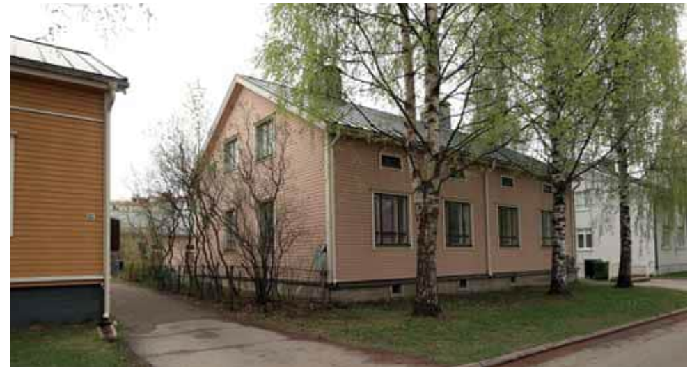
586. Karjakatu 19 ikkunat on vaihdettu vesilista on vaihtunut vesipelliksi ja katto konesaumatuksi peltikatteeksi. (Kuva: Riitta Kosonen, Arkkitehtitoimisto Jorma Teppo Oy, 5/2021.)
