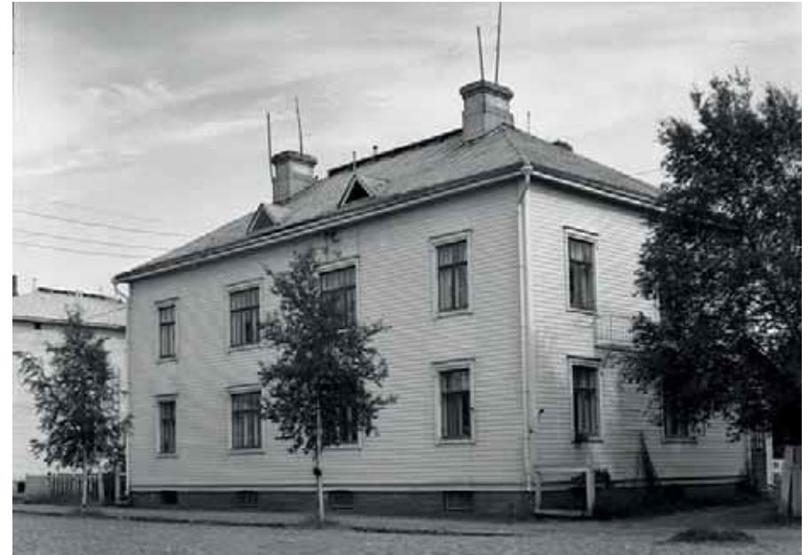
156. Syrjäkatu 23 julkisivu on säilynyt lähes entisellään, vaikka rakennusta on kunnostettu ja korjattu. Piiput olivat pellitetyt jo 1960-luvulla. Katolla on ukkosenjohdattimia. (Kuva: Pohjois-Pohjanmaan museo, kuvaaja Ahti Paulaharju, 1964.)
