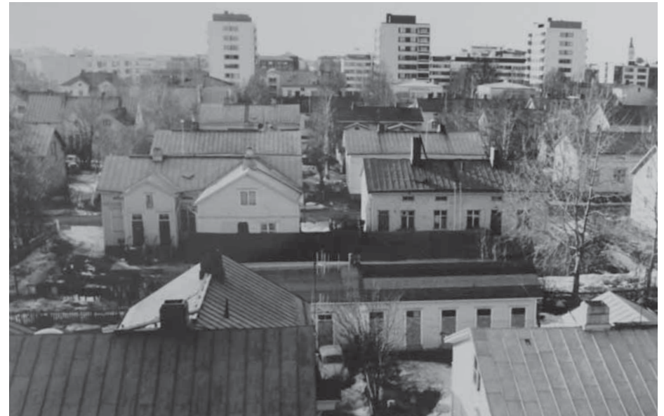
604. Karjakatu 23 pihan puolelta kuvattuna. Kuisti ja L-laajennus ja ikkunoiden puitejako erottuvat selvästi. (Kuva: Raksilan asukasyhdistys.)
