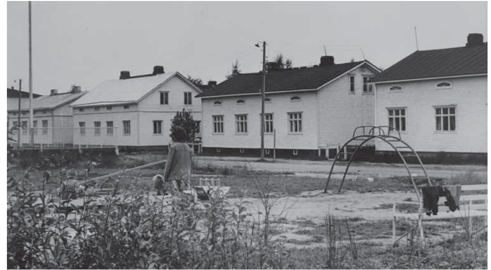
548. Teuvo Pakkalan katu 6 kuvassa oikealla. Suunnitelmista poiketen rakennus toteutui huopakatteisena, kaarevilla haukkaikkunoilla sekä ilman kerroslistaa. (Kuva: Raksilan asukasyhdistys.)
