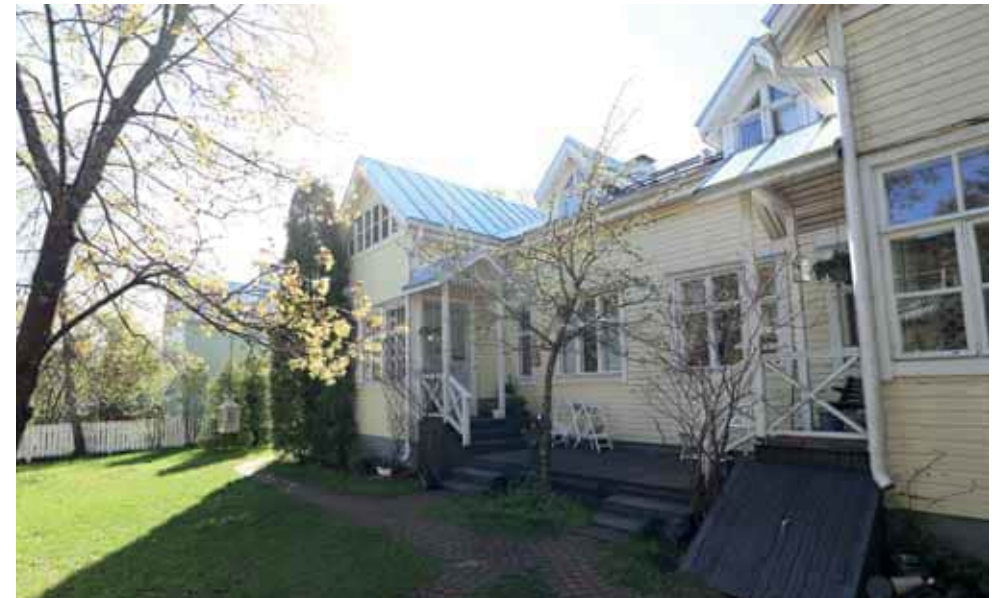
254. Pihan puolelle on 1980-luvulla tehty runsaasti muutoksia. Alkuperäinen kuisti on purettu ja tilalle rakennettu kaksi uutta. Ullakko on otettu asuinkäyttöön, ja sitä on valaistu kattolyhdyin. (Kuva: Riitta Kosonen, Arkkitehtitoimisto Jorma Teppo Oy, 5/2021.)
