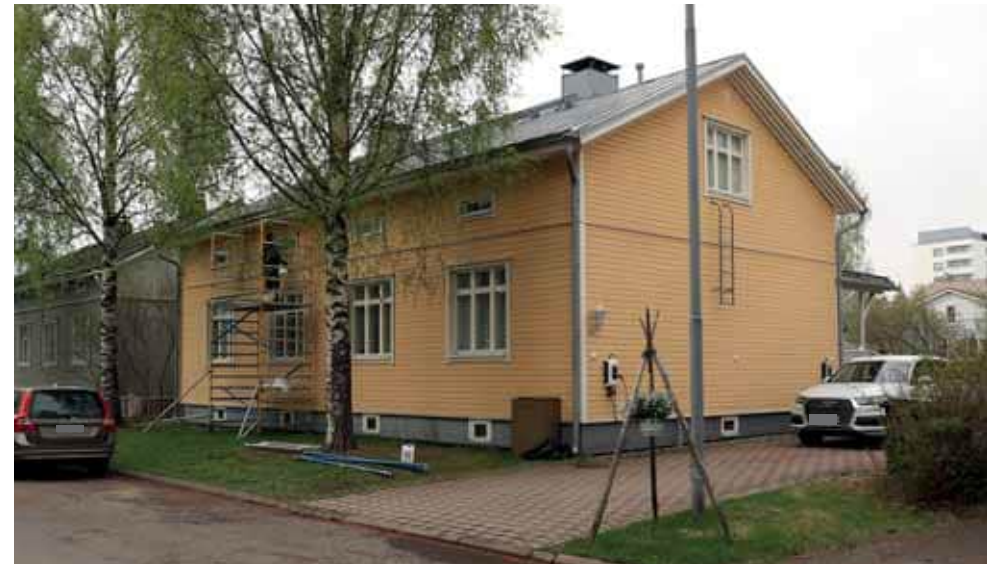
410. Karjakatu 10 kadun puolen ominaispiirteet ovat säilyneet vaikka kattoa on korotettu ja ikkunat uusittu puu-alumiini-ikkunoina. Inventointihetkellä on käynnissä julkisivujen maalaus. (Kuva: Riitta Kosonen, Arkkitehtitoimisto Jorma Teppo Oy, 5/2021.)
