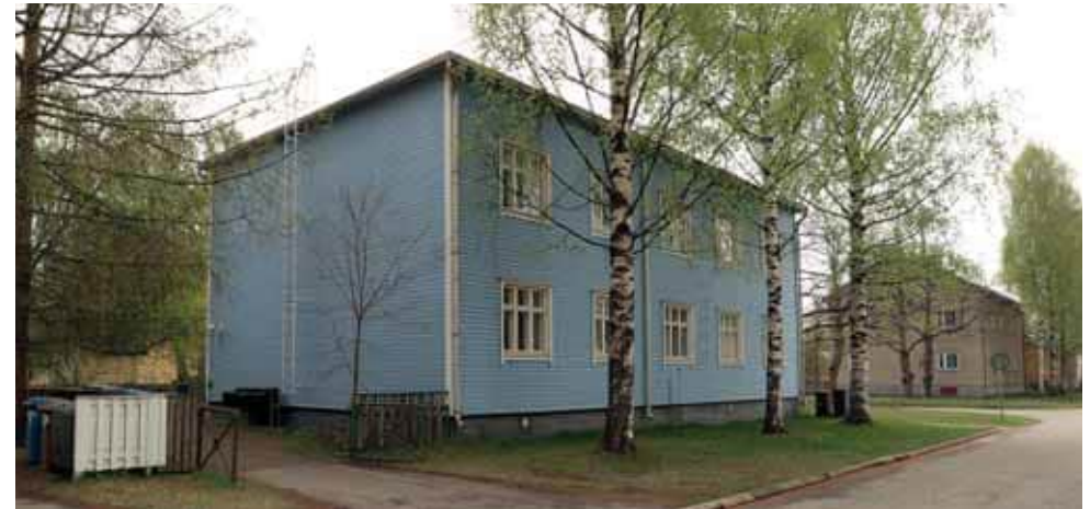
499. Karjakatu 13 alkuperäiset ikkunat ovat säilyneet samoin kuin tontille,johtava metalliputkiportti. Aita on vaihtunut puuaidaksi. (Kuva: Riitta Kosonen, Arkkitehtitoimisto Jorma Teppo Oy, 5/2021.)
