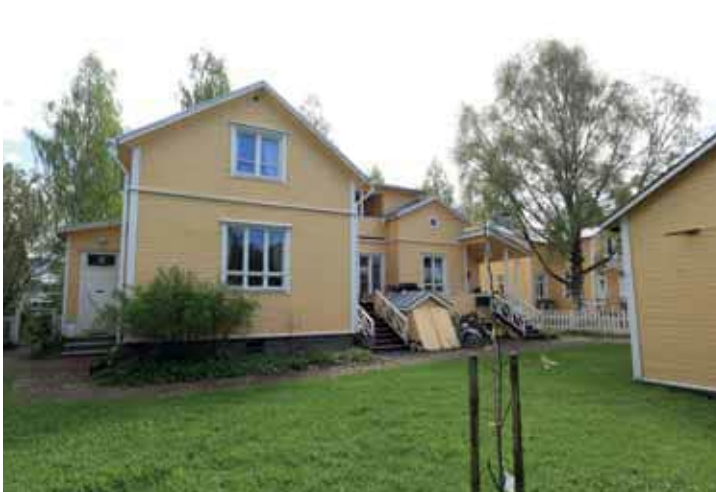
432. Etualalla L-laajennuksen pääty ja siihen liittyvä sisäänkäyntikuisti. (Kuva: Riitta Kosonen, Arkkitehtitoimisto Jorma Teppo Oy, 5/2021.)
