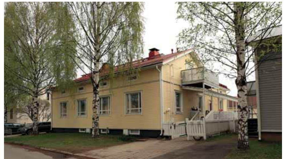
482. Karjakatu 9 ympärille on rakennettu selvästi uutena 2000-luvun kerroksena erottuvia kuisti-parveke- ja terassirakennelmia. (Kuva: Riitta Kosonen, Arkkitehtitoimisto Jorma Teppo Oy, 5/2021.)
