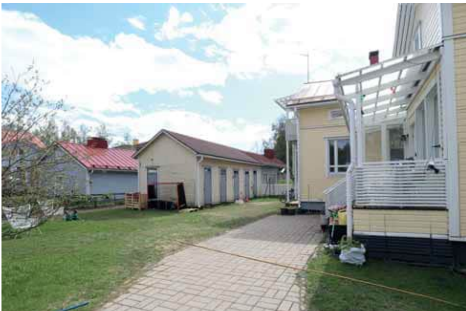
485. Talousrakennus on rakennettu kaavan mukaan kiinni naapurin piharakennukseen. Talousrakennuksen ovet ja ikkunat on todennäköisesti vaihdettu, muutoin rakennus on pitkälti alkuperäisen mukainen. (Kuva: Riitta Kosonen, Arkkitehtitoimisto Jorma Teppo Oy, 5/2021.)
