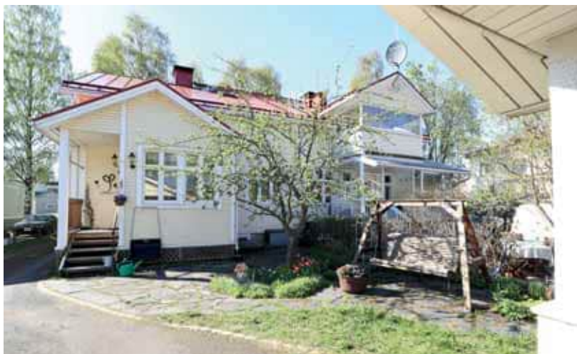
234. Puutarhakatu 17 pihan puolelle on lisätty kaksi kuistia, jotka poikkeavat tyyliltään toisistaan. Piha on kahtia jakautunut. (Kuva: Riitta Kosonen, Arkkitehtitoimisto Jorma Teppo Oy, 5/2021.)
