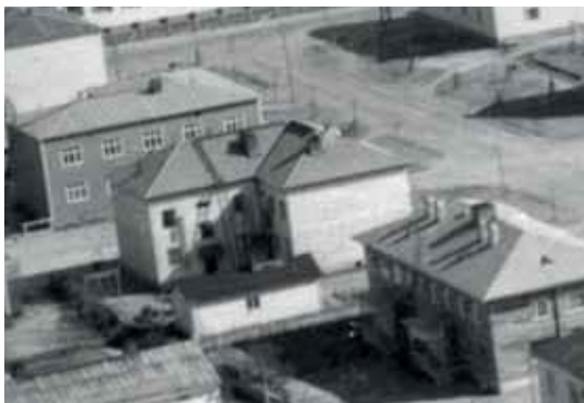
395. Puistikkokatu 11:n asuin- ja talousrakennus näkyvät kuvassa pihan puolelta. Kuvasta voidaan päätellä, että päärakennuksen katemateriaali on vaihtunut. (Kuva: Uuno Laukka 1955, Pohjois-Pohjanmaan museo, Uuno Laukan kuvakokoelmat.)
