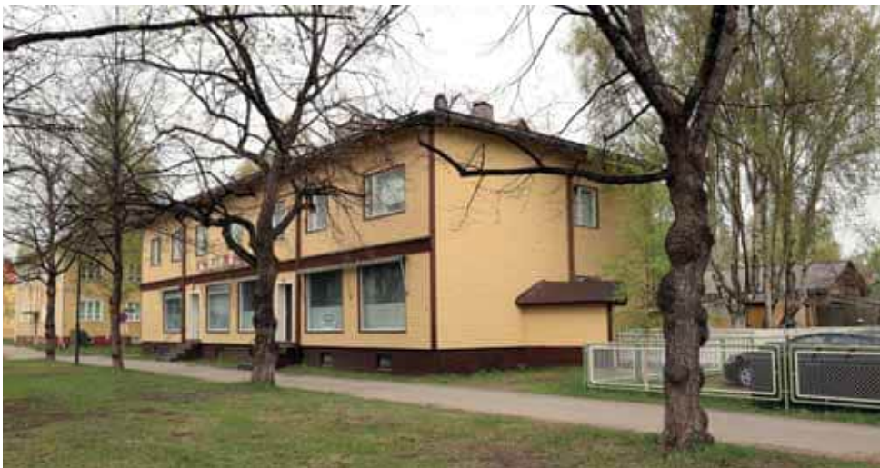
390. Puutarhakatu 13:n itäpäätyyn on tehty harjakattoinen lisäys yhden sisäänkäynnin yhteyteen. (Kuva: Riitta Kosonen, Arkkitehtitoimisto Jorma Teppo Oy, 5/2021.)
