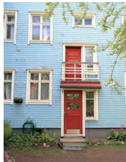
504. Ikkunat ovat alkuperäiset ja ovet uusittu tyylin mukaisina. (Kuva: Riitta Kosonen, Arkkitehtitoimisto Jorma Teppo Oy, 5/2021.) Oy, 5/2021.)
