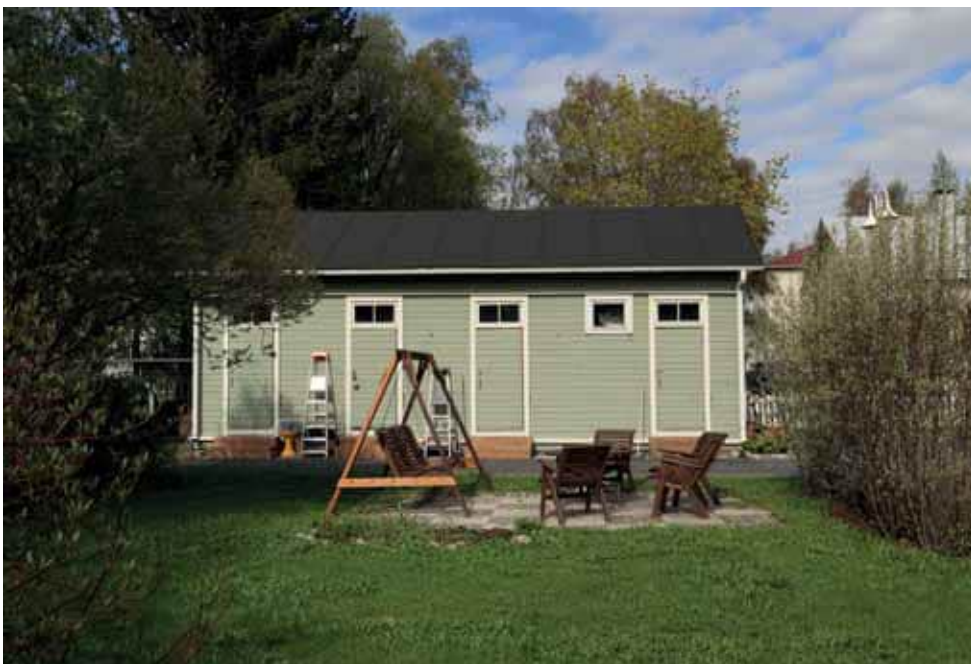
198. Puutarhakatu 18 piharakennus on kunnostettu alkuperäiset ominaispiirteet säilyttäen. Julkisivun aukotus ja materiaalit vastaavat alkuperäistä suunnitelmaa. (Kuva: Riitta Kosonen, Arkkitehtitoimisto Jorma Teppo Oy, 5/2021.)
