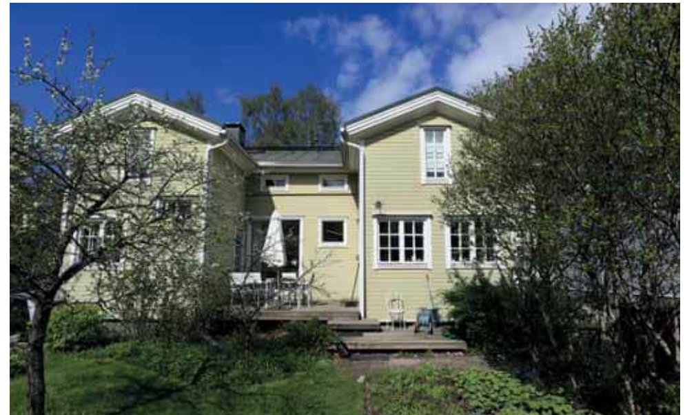
384. Pihan puolen suurimmat muutokset liittyvät kuistien uusiin ikkunoihin ja kuistien väliseen lasiaukkoon. (Kuva: Riitta Kosonen, Arkkitehtitoimisto Jorma Teppo Oy, 5/2021.)
