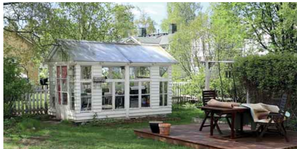
421. Karjakatu 8 tontin länsinurkassa sijaitsee vanhoista ikkunoista koottu huvimaja. (Kuva: Riitta Kosonen, Arkkitehtitoimisto Jorma Teppo Oy, 5/2021.)
