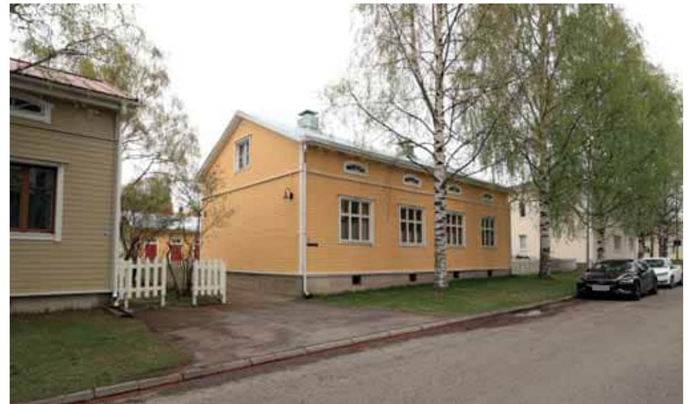
319. Karjakatu 18 katujulkisivu on säilynyt alkuperäisen mukaisena. Sokkelia on vahvistettu ja ikkunat vaihdettu alkuperäisen mukaisina sisään-ulosaukeavina puuikkunoina. (Kuva: Riitta Kosonen, Arkkitehtitoimisto Jorma Teppo Oy, 5/2021.)
