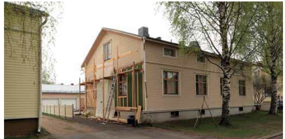
474. Päädyn julkisivussa ovat korjaustyöt käynnissä. Vinolaudoitetun seinän päälle on asennettu ohut huokoinen tuulensuojalevy ja koolaukset. Erityisesti ullakon haukkaikkunat ja kellarin ikkunat ovat syvennyksessä. (Kuva: Riitta Kosonen, Arkkitehtitoimisto Jorma Teppo Oy, 5/2021.)
