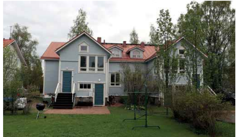
80. Pihan puolella on tapahtunut huomattavia muutoksia. Kuisteja on korotettu ja niiden aukotusta on muutettu. Kattoon on lisätty suurehkot kattolyhdyt tuomaan valoa ullakon keskiosiin. Uudet ikkunat ja ovet on uusittu alkuperäisen mukaisina puuikkunoina. (Kuva: Riitta Kosonen, Arkkitehtitoimisto Jorma Teppo Oy, 5/2021.)
