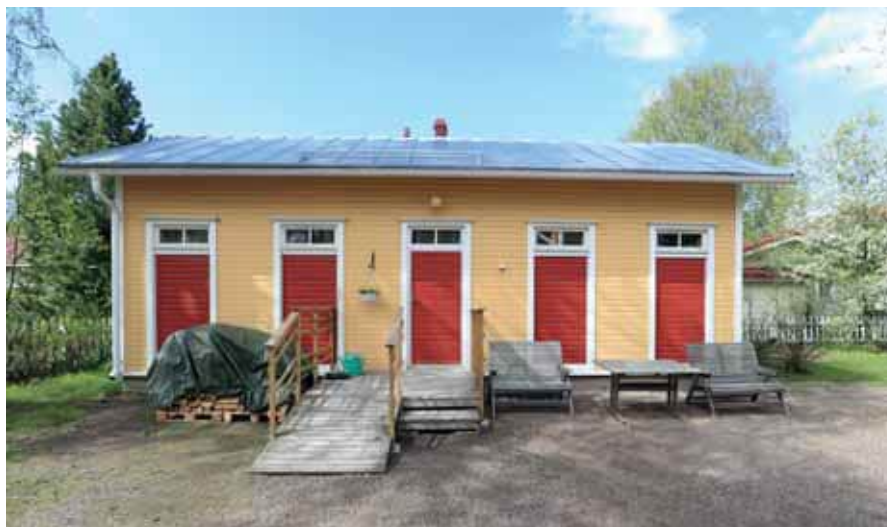
323. Karjakatu 18 alkuperäinen piharakennus on korvattu vastaavalla uudisrakennuksella. Materiaalit ja mittasuhteet ovat aiemmasta talousrakennuksesta. (Kuva: Riitta Kosonen, Arkkitehtitoimisto Jorma Teppo Oy, 5/2021.)
