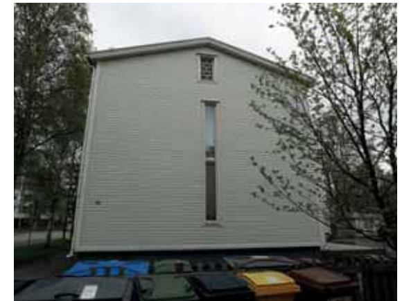
112. Eteläpäädyn ullakkoikkuna on 1930-luvulta. Korkea pystyikkuna on 2010-luvun kerrostumaa. (Kuva: Riitta Kosonen, Arkkitehtitoimisto Jorma Teppo Oy, 5/2021)
