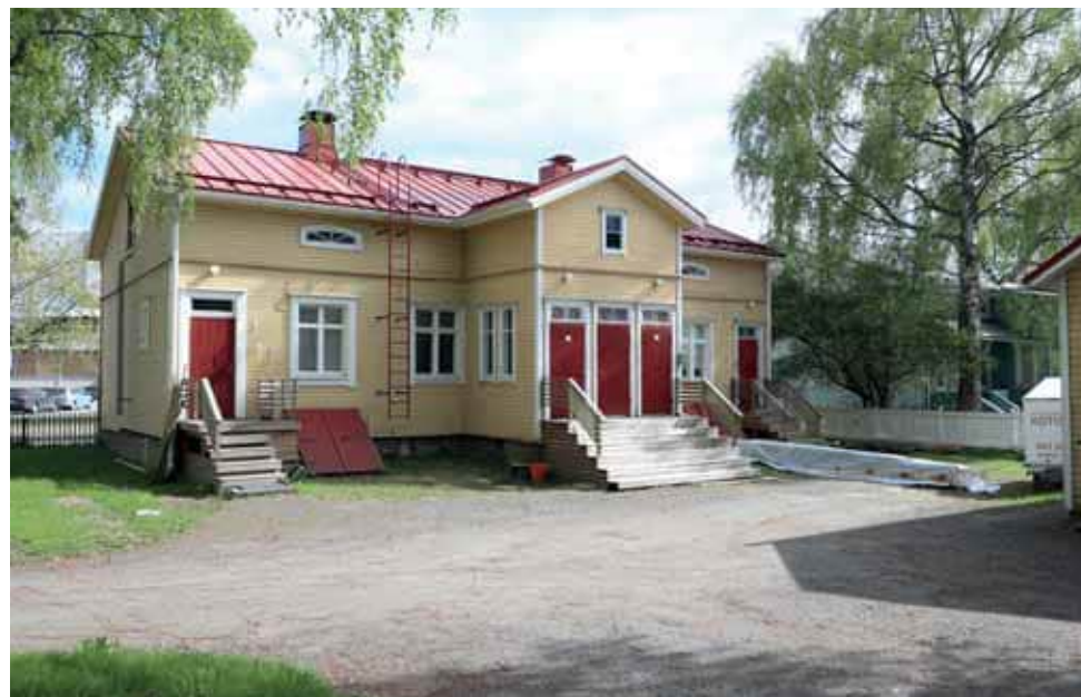
567. Teuvo Pakkalan katu 2:n rakennusten ja piha-alueen alkuperäiset ominaispiirteet ovat säilyneet. Ja alkuperäinen arkkitehtuuri on täysin tunnistettavissa. Pohjois-päädyn uusittujen ovien ja ikkunoiden vuorilaudat ovat huomattavasti alkuperäisiä leveämmät. Kellarin luukut ovat alkuperäisenmukaiset. (Kuva: Riitta Kosonen, Arkkitehtitoimisto Jorma Teppo Oy, 5/2021.)
