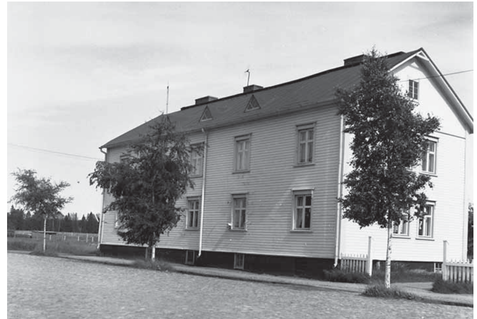
2. Syrjäkatu 1 vuonna 1964. Rakennuksen väritys on poikennut tuolloin nykyisestä ainakin sokkelin ja ikkunoiden peitelistöjen osalta. (Kuva: Pohjois-Pohjanmaan museo, kuvaaja Ahti Paulaharju, 1964.)
