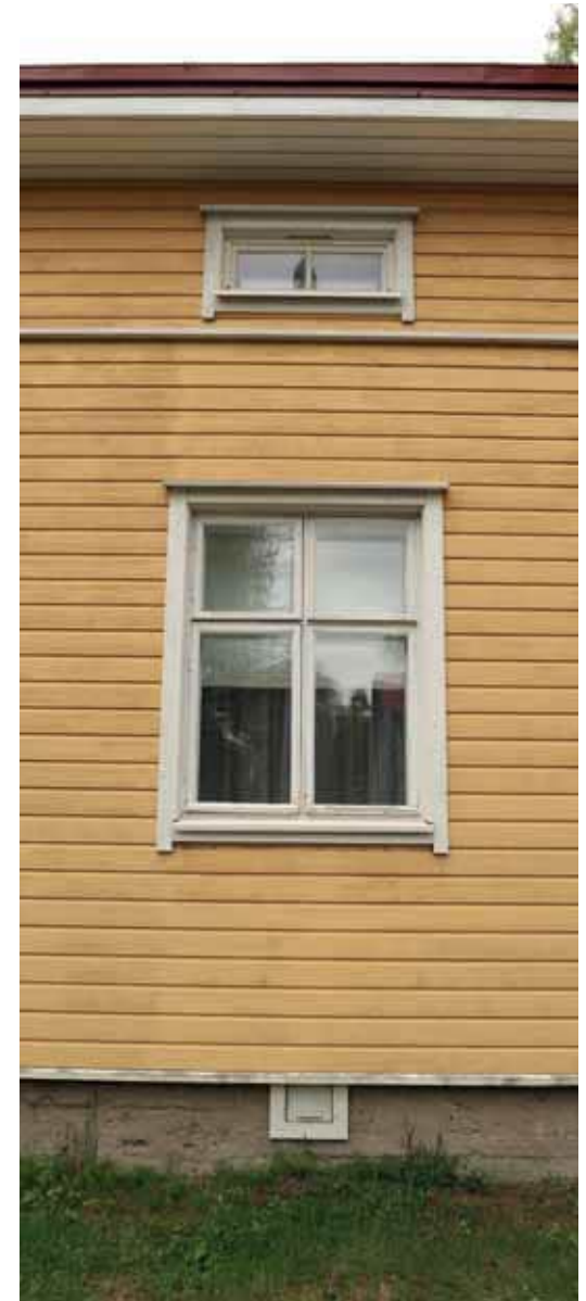
78. Katujulkisivun ikkunat ovat alkuperäiset. Vaakapanelointi ja betonisokkeli ovat Raksilalle tyypilliset. (Kuva: Riitta Kosonen, Arkkitehtitoimisto Jorma Teppo Oy, 5/2021.)
