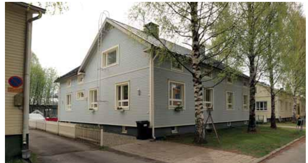
455. Karjakatu 3:n ikkunat on vaihdettu ja ullakon päätyikkunaa on suurennettu. Ikkunat ovat selvästi syvennyksessä verrattuna vuoteen 1964. Aitadan tyyli on säilynyt. (Kuva: Riitta Kosonen, Arkkitehtitoimisto Jorma Teppo Oy, 5/2021.)
