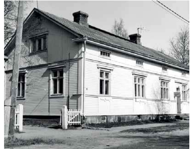
189. Puutarhakatu 20 on Raksilan runsaimmin koristeltuja taloja, vaikka suunnitelluista koristeista toteutuikin vain osa. 1970-luvulla rakennuksessa sijaitsi parturi. (Kuva: Pohjois-Pohjanmaan museo, kuvaaja Ahti Paulaharju, 1974.)
