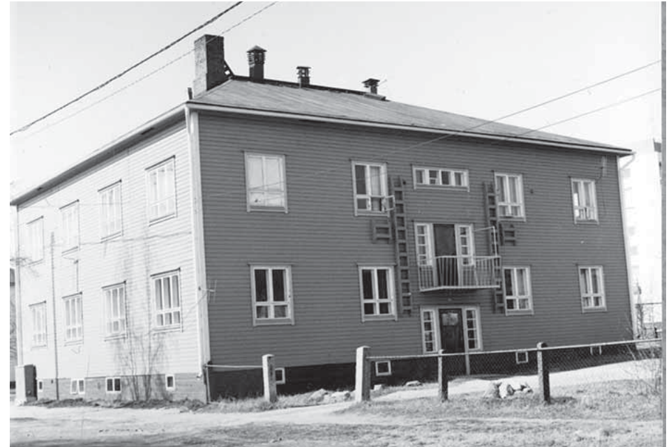
55. Puutarhakatu 12 taustalla näkyy uusi tornitalo. Kuvasta näkee, että katto ei ole ollut suunnitelmien mukainen tiilikatto. Tuuletusparvekkeessa on funktionalismille tyypilliset pinnakaiteet. (Kuva: Pohjois-Pohjanmaan museo, kuvaaja Ahti Paulaharju, 1974.)
