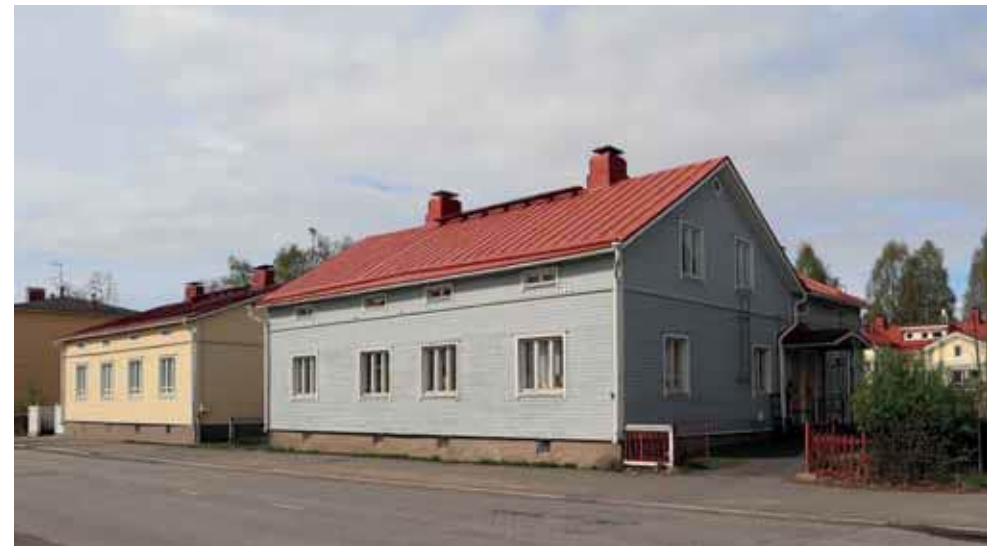
528. Teuvo Pakkalan katu 10 katujulkisivun ominaispiirteet ovat säilyneet. Pohjoispäädyn varhaiseen L-laajennukseen on lisätty sisäänkäyntikatos. Yläpohjan tuuletusta on parannettu, lisäämällä harjalle tuuletusrilä. (Kuva: Riitta Kosonen, Arkkitehtitoimisto Jorma Teppo Oy, 5/2021.)
