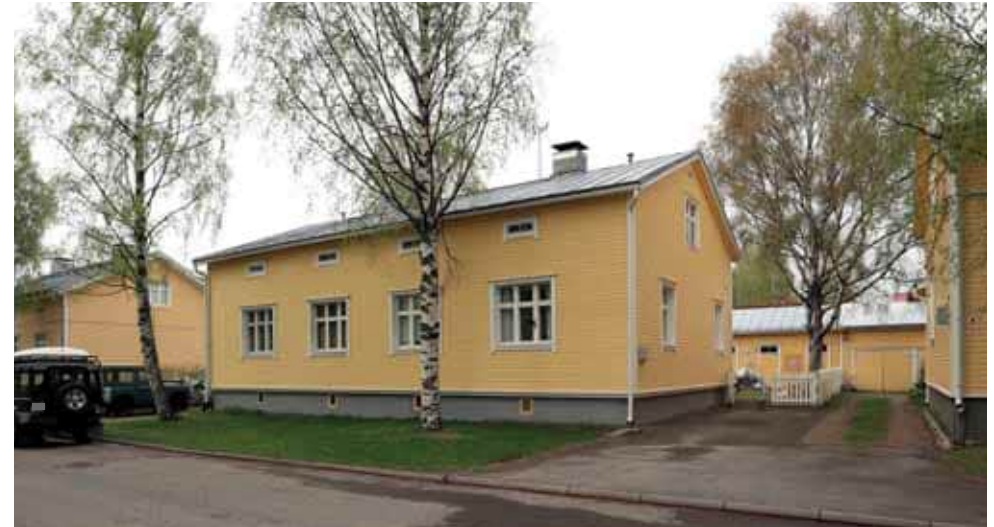
416. Karjakatu 8 katujulkisivun alkuperäiset ominaispiirteet ovat säilyneet. Osa ikkunoista on uusittu. Ikkunat ovat jääneet syvennykseen ilmeisesti lisälämmöneristämisen vuoksi. (Kuva: Riitta Kosonen, Arkkitehtitoimisto Jorma Teppo Oy, 5/2021.)
