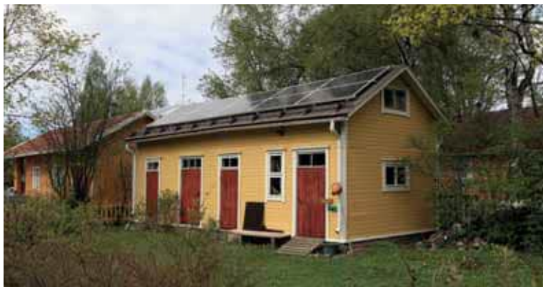
66. Puutarhakatu 10 piharakennuksen katolle on lisätty aurinkopaneelit vuonna 2018. Ulko-ovet ja katemateriaali on uusittu. Ikkunoista ainakin osa on alkuperäisiä. (Kuva: Riitta Kosonen, Arkkitehtitoimisto Jorma Teppo Oy, 5/2021.)
