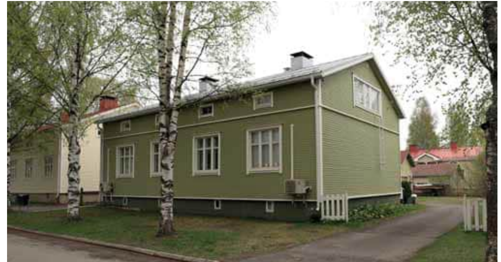
238. Puutarhakatu 19 katujulkisivu on säilynyt pääpiirteittäin alkuperäisen mukaisena. Huomiota herättävät katujulkisivuun lisätyt ilmalämpöpumput. Myös pohjakerroksen ja toisen asunnon ullakon ikkunat on vaihdettu puitejakosäilyttäen. Päädyn ikkuna on suurennettu ullakon käyttöön oton myötä. (Kuva: Riitta Kosonen, Arkkitehtitoimisto Jorma Teppo Oy, 5/2021.)
