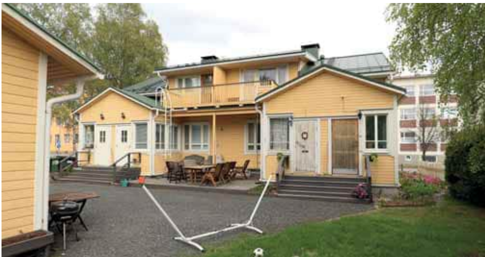
660. 1950-luvun muutokset ovat muuttaneet rakennuksen tyyliä merkittävästi pihan puolella. Ulko-ovet on uusittu alkuperäisestä tyylistä poikkeavina, mutta suurin osa ikkunoista on alkuperäisiä. (Kuva: Riitta Kosonen, Arkkitehtitoimisto Jorma Teppo Oy, 5/2021.)
