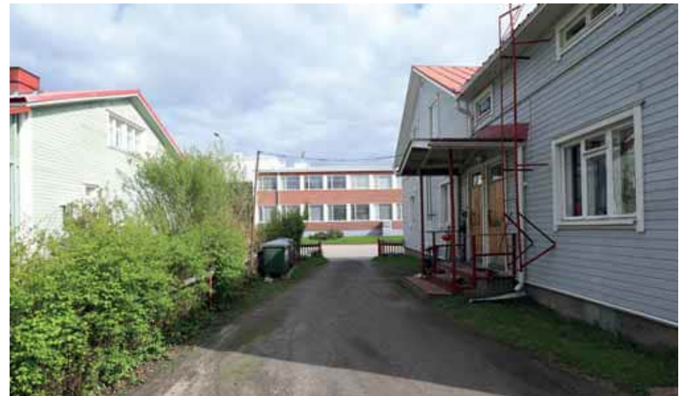
532. Sisäänkäynnin päälle on rakennettu katos. (Kuva: Riitta Kosonen, Arkkitehtitoimisto Jorma Teppo Oy, 5/2021.)
