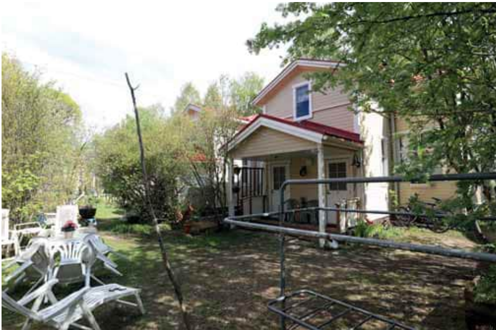
309. Kuisteihin on lisätty sisäänkäyntikatokset. Ulko-ovet on vaihdettu rakennuksen tyylistä poikkeaviksi, mutta sisäänkäyntien paikkoja ei ole ilmeisesti muutettu. (Kuva: Riitta Kosonen, Arkkitehtitoimisto Jorma Teppo Oy, 5/2021.)
