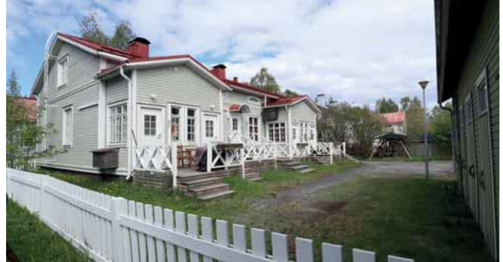
358. Puutarhakatu 5:n pihan puolelle on tehty terässirakennelmat. Ulko-ovet poikkeavat rakennuksen tyylistä. Kiustit ikkunoineen ovat oletettavasti alkuperäiset. (Kuva: Riitta Kosonen, Arkkitehtitoimisto Jorma Teppo Oy, 5/2021.)
