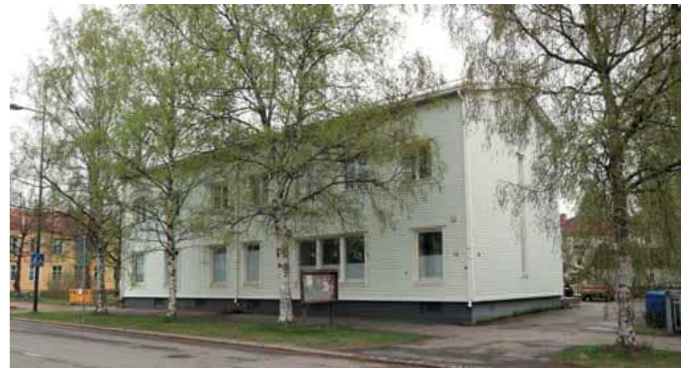
106. Syrjäkatu 13 julkisivusta ovat poistuneet myymälöiden sisäänkäynnit ja aukotukseen on tullut muutoksia. Ullakon päädysä on säilynyt alkuperäinen pikkuruutuinen ikkuna. Rakennus on selvästi tunnistettavissa kasvaneiden koivujen takaa. (Kuva: Riitta Kosonen, Arkkitehtitoimisto Jorma Teppo Oy, 5/2021.)
