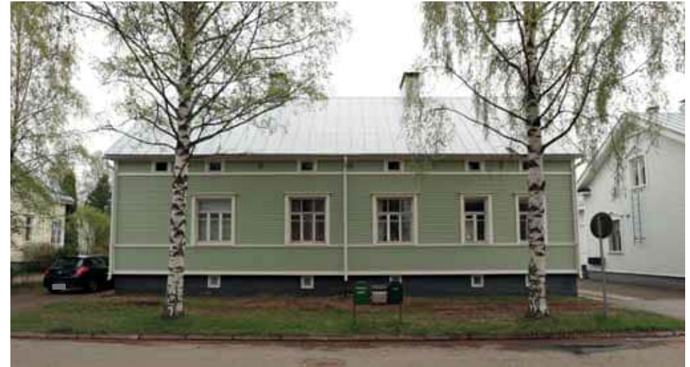
261. Puutarhakatu 25 katujulkisivu on säilynyt pääpiirteittäin alkuperäisen mukaisena, vaikka ikkunajako on muuttunut viimeksi 1960-luvulla. Ulkopuolinen lisälämmöneristys jättää alkuperäiset ikkunat voimakkaasti syvennykseen. Yhdessä ikkunassa on tuuletusta varten fortuska. Katto on uusittu saumattuna palapeltikatteena, mutta ilman jalkarännejä. (Kuva: Riitta Kosonen, Arkkitehtitoimisto Jorma Teppo Oy, 5/2021.)
