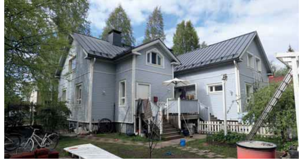
460. Karjakatu 3:n ullakoiden ikkuna-aukkoja on suurennettu ja ikkunat poikkeavat rakennuksen alkuperäisestä tyylistä. Kuistin kolmesta sisäänkäynnistä on jäljellä yksi. (Kuva: Riitta Kosonen, Arkkitehtitoimisto Jorma Teppo Oy, 5/2021.)
