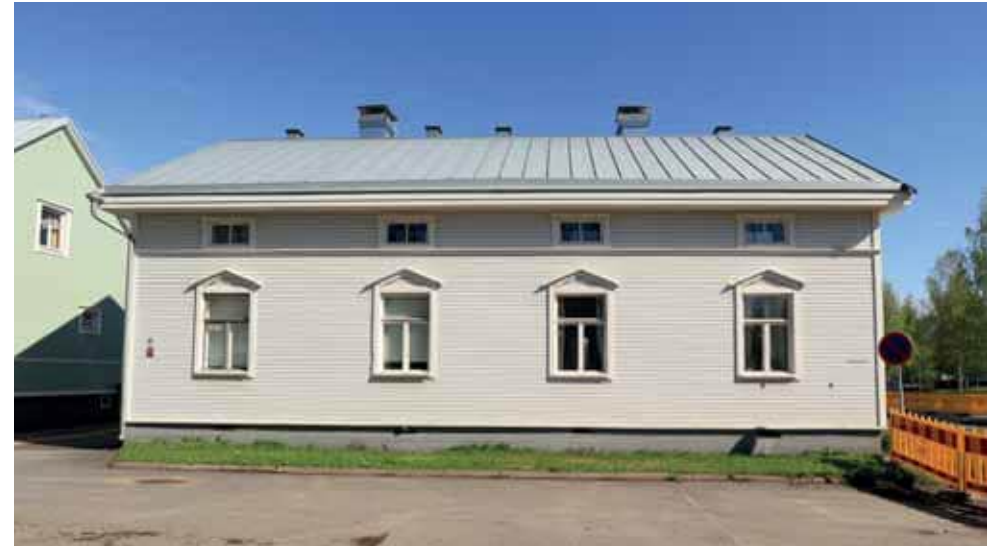
269. Puutarhakatu 27 katujulkisivu poikkeaa alkuperäisestä suunnitelmasta, sillä ullakkoa on korotettu ja lisätty tyylin mukaiset haukkaikkunat. (Kuva: Riitta Kosonen, Arkkitehtitoimisto Jorma Teppo Oy, 5/2021.)
