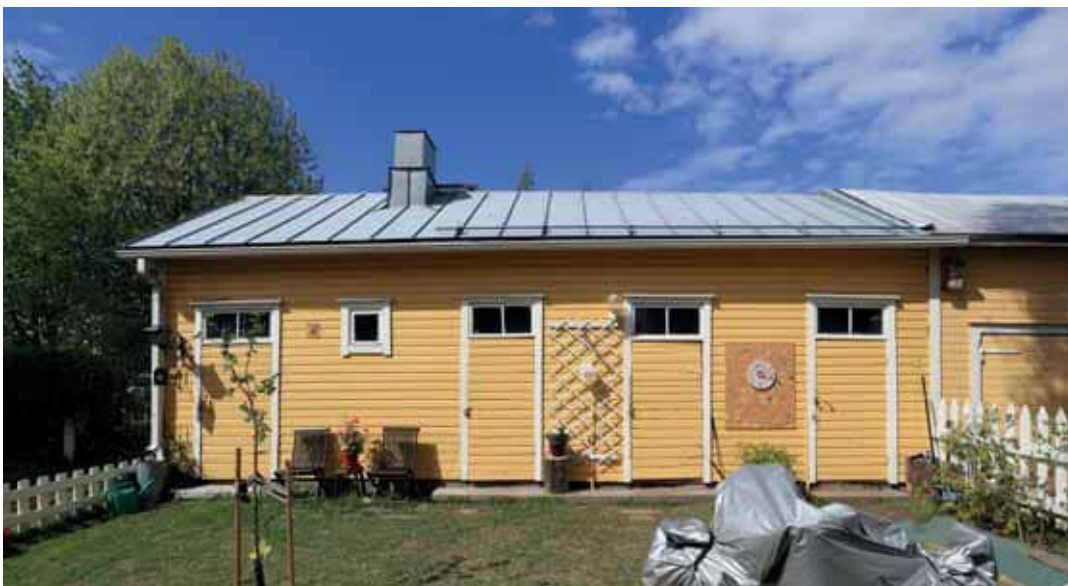
419. Karjakatu 8 piharakennuksen katto on uusittu saumattuna peltikatteena. Kuvassa näkyvä julkisivu on muutoin alkuperäisen suunnitelmanmukainen. (Kuva: Riitta Kosonen, Arkkitehtitoimisto Jorma Teppo Oy, 5/2021.)
