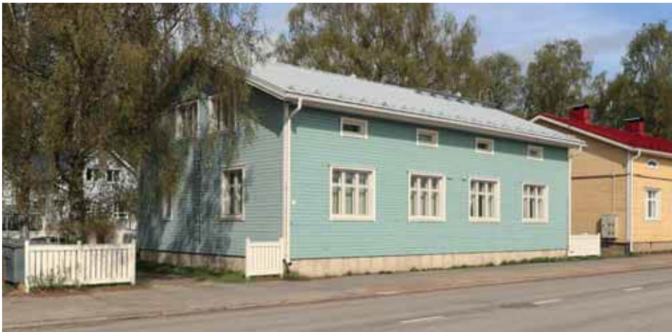
561. Teuvo Pakkalan katu 4:n päädyn ikkunat ovat myös edeltäjänsä mukaiset. Ullakon suuret ikkunat lisättiin 1940-luvulla. Aita on hieman peittävämpi ja viimeistellympi, kuin Puu-Raksilalle tyypillinen puusäleaita. (Kuva: Riitta Kosonen, Arkkitehtitoimisto Jorma Teppo Oy, 5/2021.)
