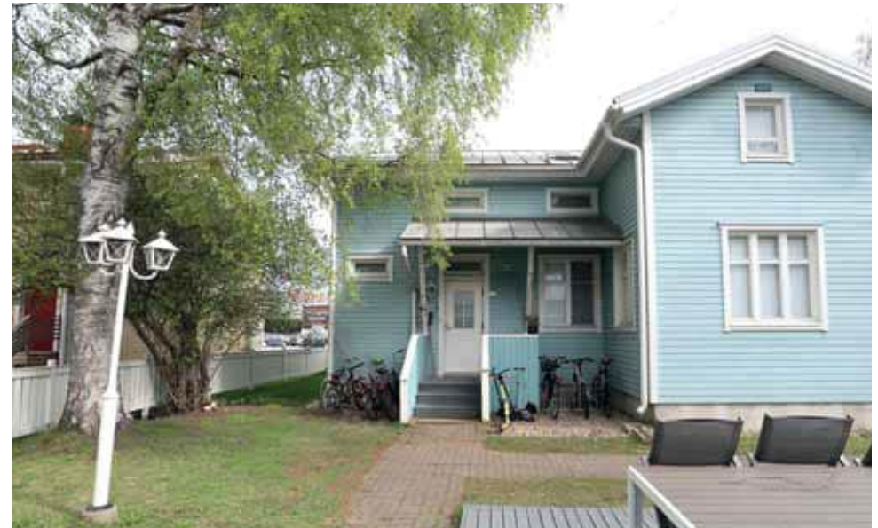
557. Sisäänkäyntien päällä on katokset. Kaiteet ovat umpinaiset. (Kuva: Riitta Kosonen, Arkkitehtitoimisto Jorma Teppo Oy, 5/2021.)
