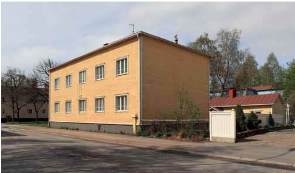
515. Sokkeli on lämmöneristetty ja rapattu. Teuvo Pakkalan kadun varrella tonttia reunustaa metalliverkkoaita. (Kuva: Riitta Kosonen, Arkkitehtitoimisto Jorma Teppo Oy, 5/2021.)
