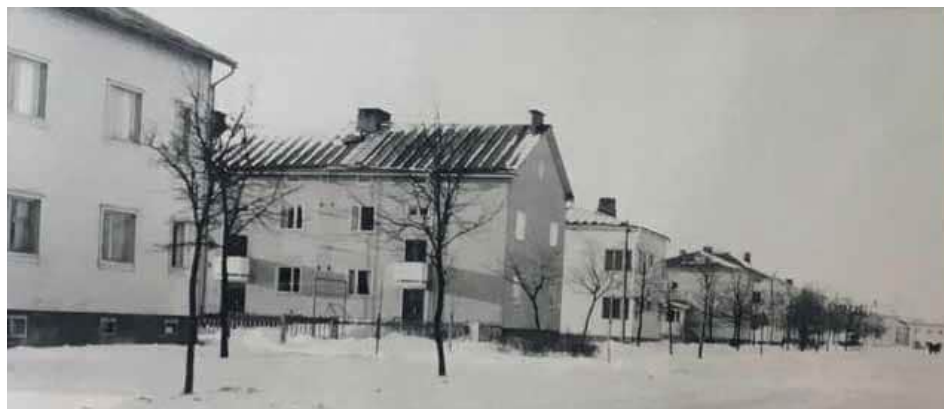
569. Karjakatu 15 kuvassa toinen vasemmalta. Pihan puolen valkeat tuuletusparvekkeet ja alkuperäisenä säilyneet ikkunat erottuvat selkeästi, koska tonttia rajaavaa puustoa ei ole vielä kasvanut. (Kuva: Raksilan asukasyhdistys.)
