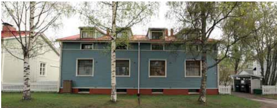
365. Puutarhakatu 7 katujulkisivu on muuttunut merkittävästi. Kattolyhtyjen lisäksi ikkunat poikkeavat alkuperäisestä tyylistä. (Kuva: Riitta Kosonen, Arkkitehti toimisto Jorma Teppo Oy, 5/2021.)
