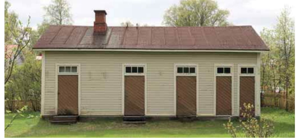
91. Piharakennus näyttää ulkoisesti säilyneen täysin alkuperäisen mukaisena. Ainostaan pesutuvan eteisen suunnitelmien mukaista pystyikkunaa ei ole. (Kuva: Riitta Kosonen, Arkkitehtitoimisto Jorma Teppo Oy, 5/2021.)
