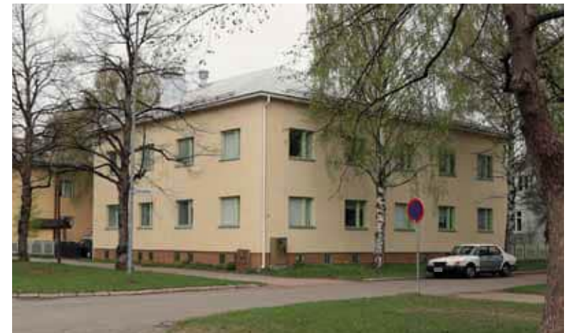
396. Puistikkokatu 11 Puistikkokadulta kuvattuna. Julkisivut ovat säilyneet pääpiirteittäin alkuperäisen kaltaisina, vaikka ne on eristerapattu ja katemateriaali sekä ikkunat on vaihdettu. (Kuva: Riitta Kosonen, Arkkitehtitoimisto Jorma Teppo Oy, 5/2021.)
