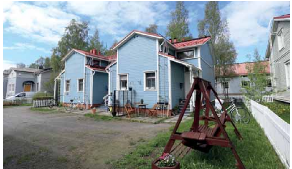
361. Puutarhakatu 7 kuisteihin on lisätty lapekattoiset "posket" sekä sisäänkäyntikatokset. Päätyjen aukotusta on muutettu. (Kuva: Riitta Kosonen, Arkkitehtitoimisto Jorma Teppo Oy, 5/2021.)
