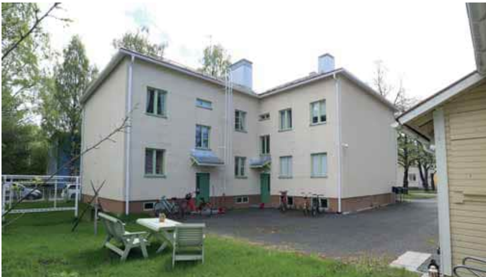
401. Puistikkokatu 11 sisäänkäynti katokset on palautettu alkuperäisen mukaisiksi. (Kuva: Riitta Kosonen, Arkkitehtitoimisto Jorma Teppo Oy, 5/2021.)
