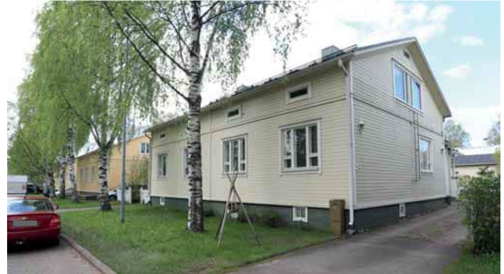
435. Karjakatu 4 katujulkisivun muutokset liittyvät pohjakerroksen uusittuihin ikkunoihin. Muutoin kadunpuolen ominaispiirteet ovat säilyneet. (Kuva: Riitta Kosonen, Arkkitehtitoimisto Jorma Teppo Oy, 5/2021.)
