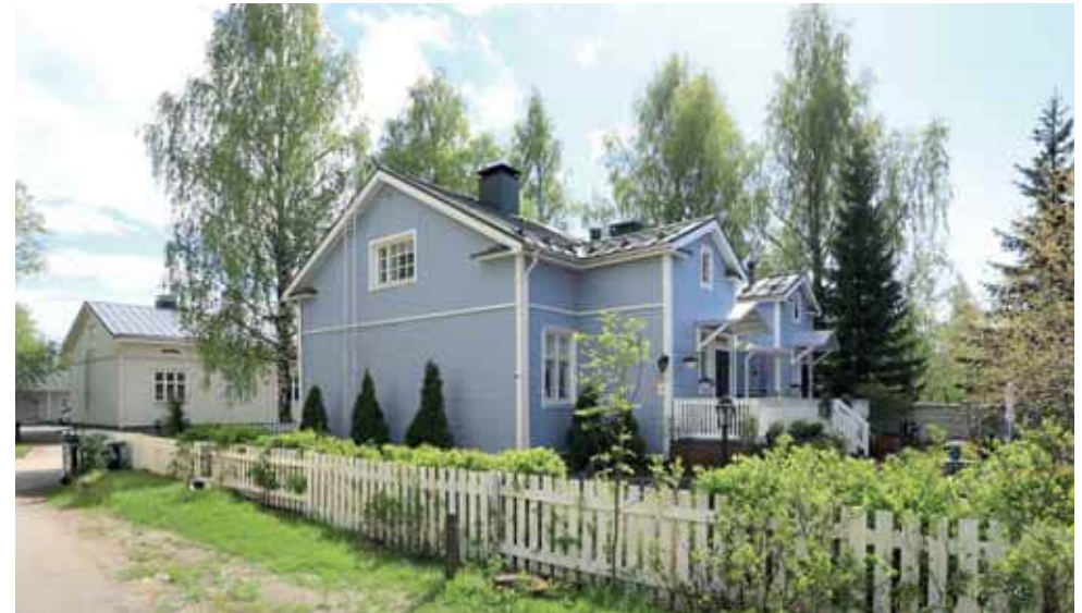
287. Karjakatu 26 Karjakadulta naapuritontilta kuvattuna. Rakennuksen muoto on säilynyt. Ullakon ikkuna on suurennettu ja uusittu kokopuisena, mutta tyylistä poikkeavan pikkuruutuisena. (Kuva: Riitta Kosonen, Arkkitehtitoimisto Jorma Teppo Oy, 5/2021.)
