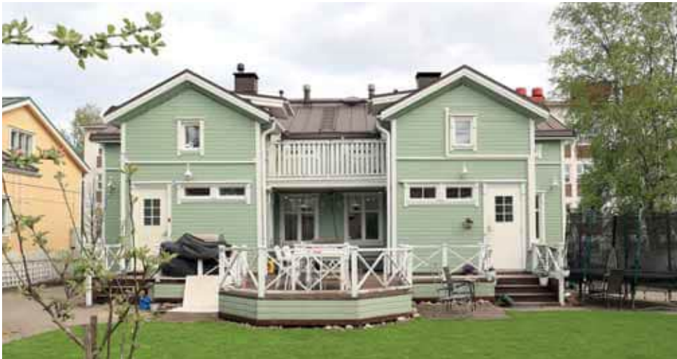
653. Kuistien ylimääräiset sisäänkäynnit on poistettu ja aukotusta muutettu. Kuistienmittasuhteet ovat säilyneet. (Kuva: Riitta Kosonen, Arkkitehtuuritoimisto Jorma Teppo Oy, 5/2021.)
