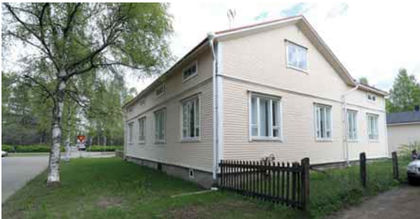
339. Puutarhakatu 1 eteläpääty ja L-osan julkisivu. (Kuva: Riitta Kosonen, Arkkitehtitoimisto Jorma Teppo Oy, 5/2021.)
