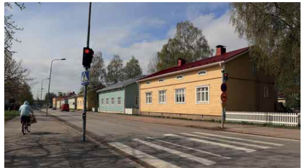
563. Teuvo Pakkalan katu 2:n katujulkisivun ominaispiirteet ovat säilyneet. (Kuva: Riitta Kosonen, Arkkitehtitoimisto Jorma Teppo Oy, 5/2021.)
