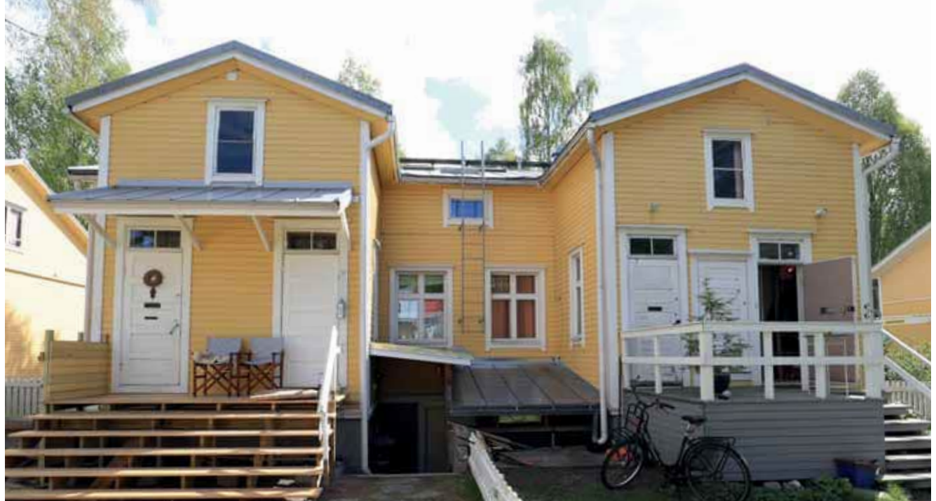
422. Pihan puolella tehdyt muutokset eivät muuta rakennuksen tyyliä. Kellariin on tehty uudet katetut sisäänkäynnit ja toiseen kuistiin lisätty sisäänkäyntikatos. Ulko-ovet ovat alkuperäiset tai alkuperäisen mukaiset. Myös kuistin yllisten ja eteläpäädyn asunnon ikkunat ovat alkuperäiset. (Kuva: Riitta Kosonen, Arkkitehtitoimisto Jorma Teppo Oy, 5/2021.)
