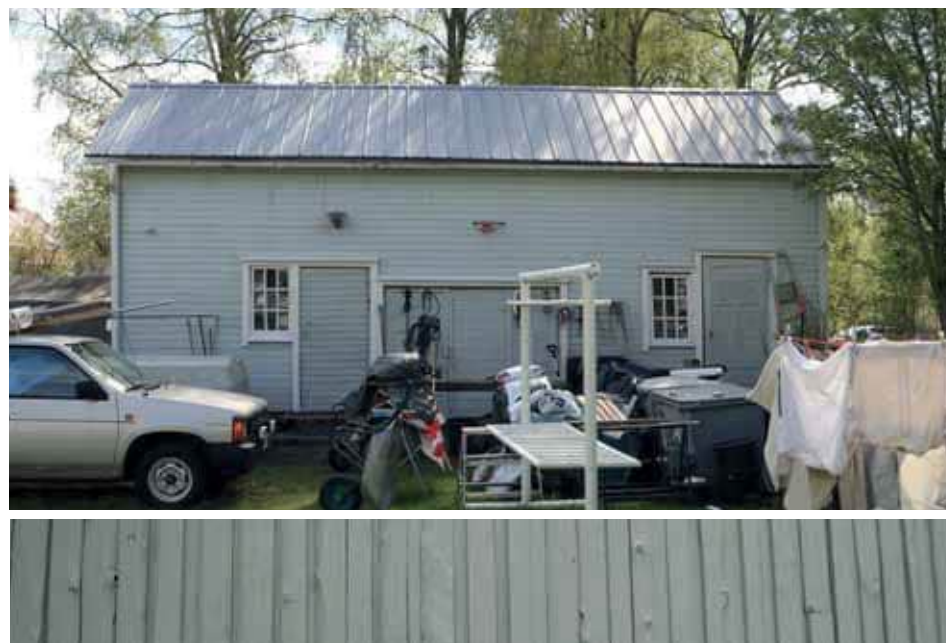
191. Puutarhakatu 20 piharakennuksen pystyrimalauidoitus (alakuvasa ote päädyn pystyrimalauidoituksesta) on vaihtunut vaakapaneeliin ja vesikate profiilipeltiin. Vesikaton ristiharja on poistettu. Ikkunat ja peilirakenteiset lauta-ovet ovat todennäköisesti alkuperäisiä, mutta oukotusta on muutettu ainakin paneloidun oven osalta. (Kuva: Riitta Kosonen, Arkkitehtitoimisto Jorma Teppo Oy, 5/2021.)
