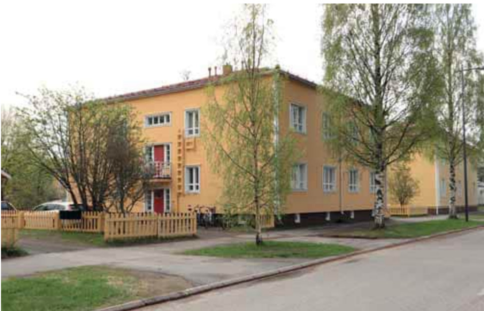
38. Syrjäkatu 9 Syrjäkadulta kuvattuna. Taustalla Syrjäkatu 11. Ainakin ikkunat ja vesikatto on uusittu, mutta rakennuksen muoto ja aukotukset ovat säilyneet. (Kuva: Riitta Kosonen, Arkkitehtitoimisto Jorma Teppo Oy, 5/2021.)
