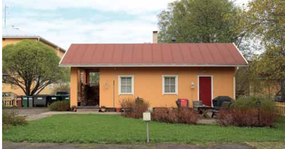
35. Syrjäkatu 9:n piharakennuksessa on huopakate ja pystypanelointi. Mittasuhteiltaan rakennus on likipitään Puu-Raksilan piharakennusten mukainen. (Kuva: Riitta Kosonen, Arkkitehtitoimisto Jorma Teppo Oy, 5/2021.)
