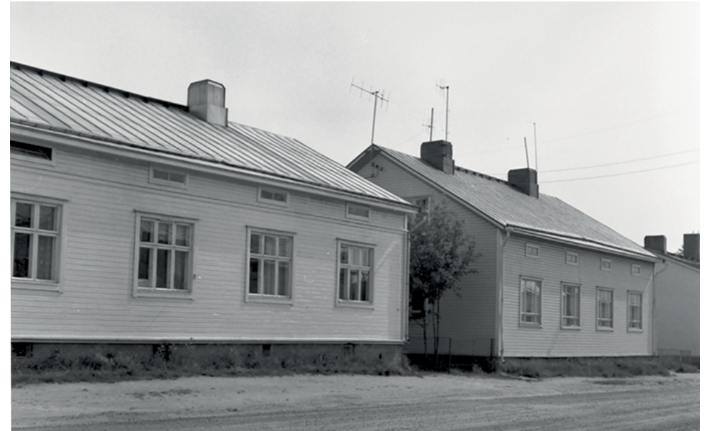
588. Karjakatu 19 kuvassa oikealla. Kerroslistaa ei ilmeisesti toteutunut. Julkisivuiltaan yhteneväisiin rakennuksiin saatiin hieman vaihtelua ikkunoita varioimalla. (Kuva: Pohjois-Pohjanmaan museo, kuvaaja Ahti Paulaharju, 1964.)
