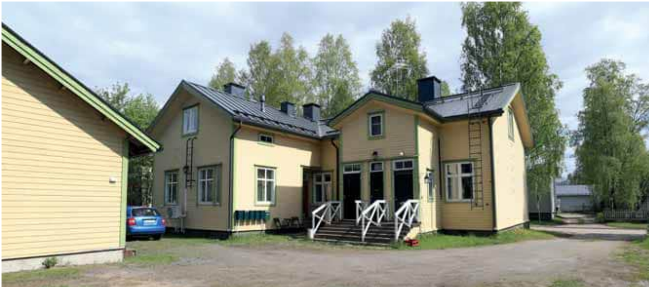
300. Karjakatu 24 pihajulkisivun muutokset ovat lähinnä rakennusosien uusimisia. Vesikatto, ulko-ovet ja asuintilojen ikkunat on uusittu. Myös räystäskourut ja syöksytorvet ovat uudet. Pihan puolelle on lisätty ilmalämpöpumppu. (Kuva: Riitta Kosonen, Arkkitehtitoimisto Jorma Teppo Oy, 5/2021.)
