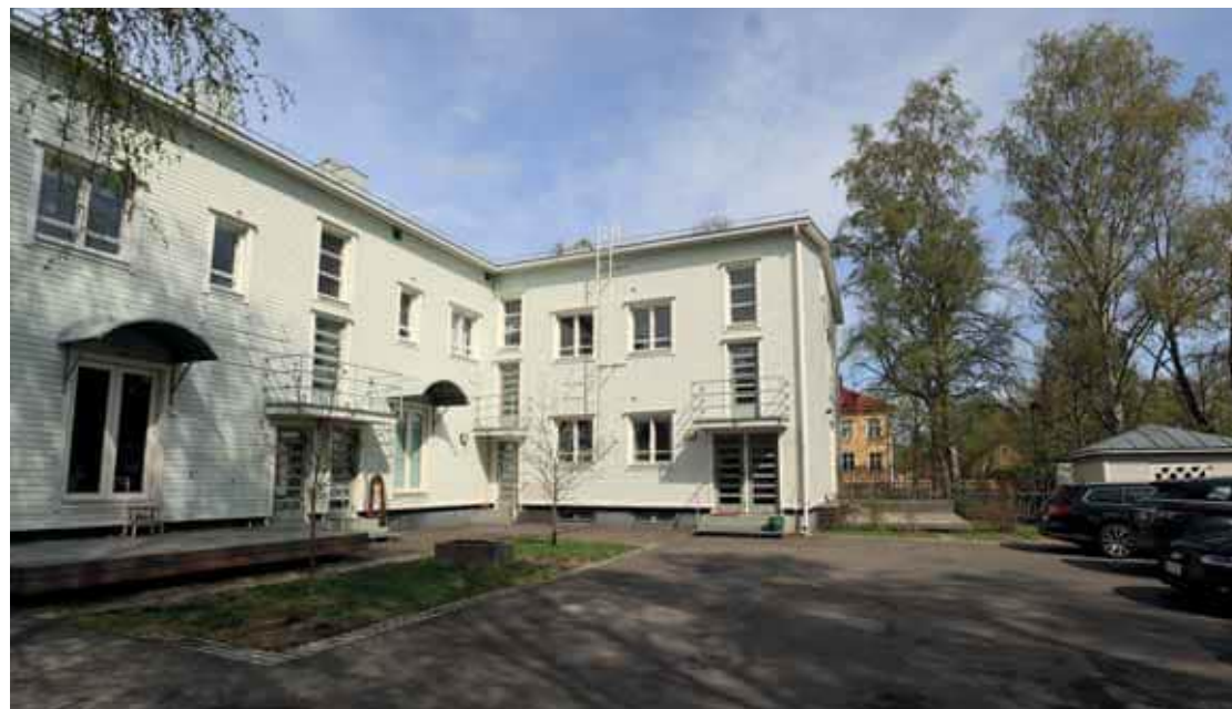
115. 2010-luvun taloyhtiöksi muuttumisen jälkeen pihaa on rakennettu ja sinne on lisätty istutuksia. (Kuva: Riitta Kosonen, Arkkitehtitoimisto Jorma Teppo Oy, 5/2021.)
