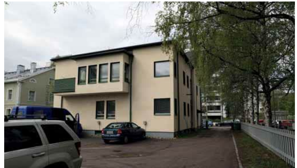
134. Pihan puolella suurimmat muutokset ovat parvekekaiteiden vaihtaminen vaakasuuntaiseksi profiilipelliksi sekä ulkopuolinen lisälämmöneristys. (Kuva: Riitta Kosonen, Arkkitehtitoimisto Jorma Teppo Oy, 5/2021.)
