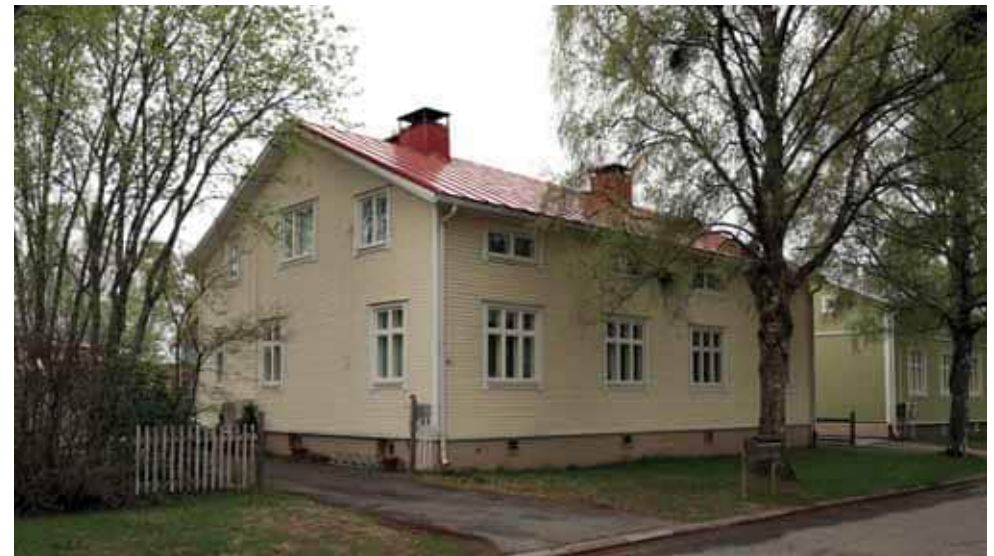
229. Puutarhakatu 17 päätyyn on lisätty ikkunoita. Ikkunoiden ja vesikatteen vaihtoa lukuun ottamatta katujulkisivu on säilynyt muuttumattomana. (Kuva: Riitta Kosonen, Arkkitehtitoimisto Jorma Teppo Oy, 5/2021.)
