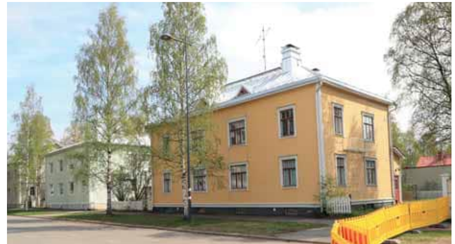
154. Syrjäkatu 23 Syrjäkadulta kuvattuna. Peltikatto on uusittu alkuperäisen mukaisena. Aita on uusittu Raksilalle tyypillisenä puusäleaitana. (Kuva: Riitta Kosonen, Arkkitehtitoimisto Jorma Teppo Oy, 5/2021.)
