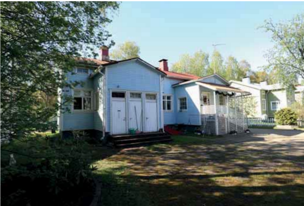
250. Puutarhakatu 21 eteläpää on varsin alkuperäisen henkinen, vaikka kuistiin on tehty muutoksia ja ulko-ovet on vaihdettu. Pohjoispäätyyn on tehty 2000-luvun tyylinen vaakarimoitettu sisäänkäyntikatos ja ulko-ovet, ikkunat sekä vesikate on vaihdettu. (Kuva: Riitta Kosonen, Arkkitehtitoimisto Jorma Teppo Oy, 5/2021.)
