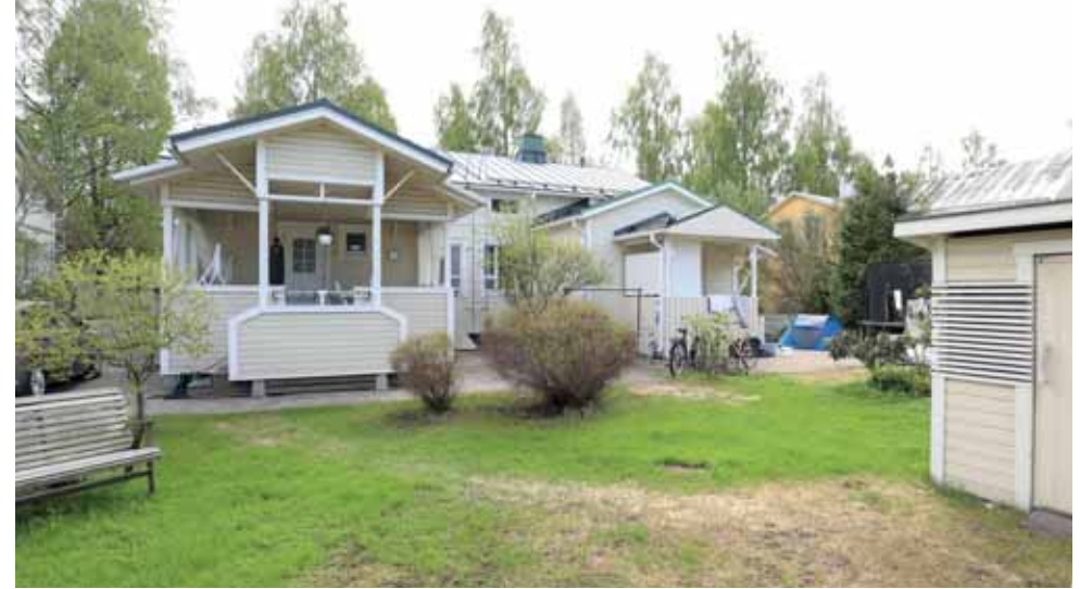
439. Teleskooppimaiset kuistilaaennukset peittävät alkuperäisen rakennuksen alleen. Niiden tyylit poikkeavat runsaasti alkuperäisestä 1930-luvun klassismista. (Kuva: Riitta Kosonen, Arkkitehtitoimisto Jorma Teppo Oy, 5/2021.)
