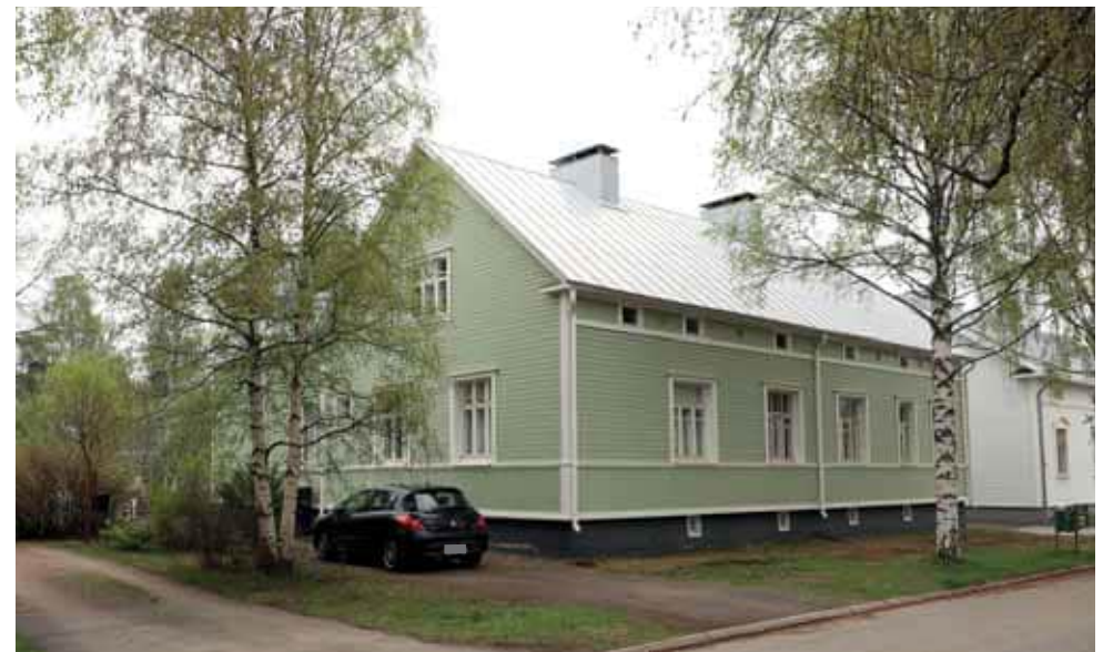
268. Puutarhakatu 25 pohjoissivu ja L-laajennus. (Kuva: Riitta Kosonen, Arkkitehtitoimisto Jorma Teppo Oy, 5/2021.)
