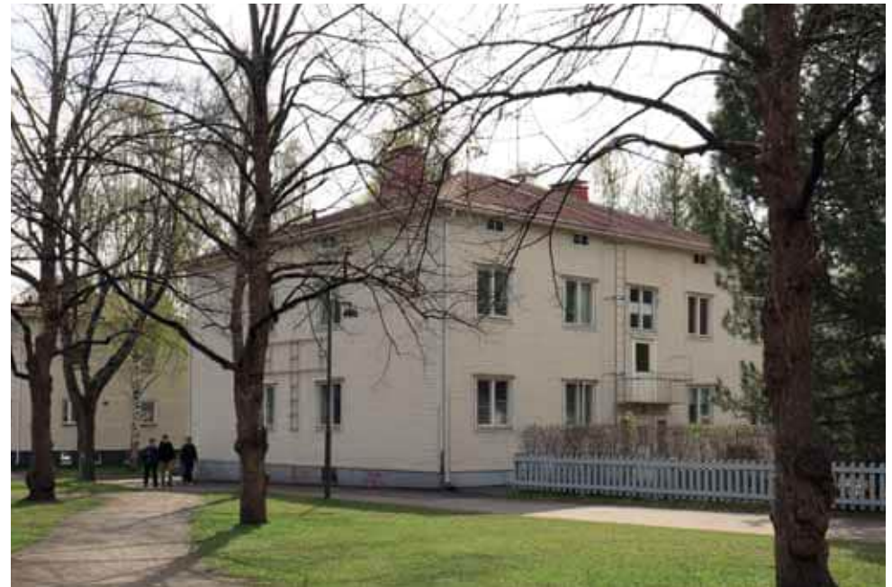
210. Puutarhakatu 14 Puistikkokadulta kuvattuna. Ulko-ovi on uusittu, muutoin julkisivut ovat lähes alkuperäiset. (Kuva: Riitta Kosonen, Arkkitehtitoimisto Jorma Teppo Oy, 5/2021.)
