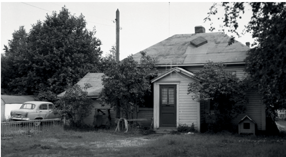
157. Syrjäkatu 23:n piharakennuksessa sijaitsi alunperin leivintupa. Rakennuksessa oli huopakatto ja suunnitelmista poiketen lasiaukollinen ulko-ovi. (Kuva: Pohjois-Pohjanmaan museo, kuvaaja Ahti Paulaharju, 1964.)
