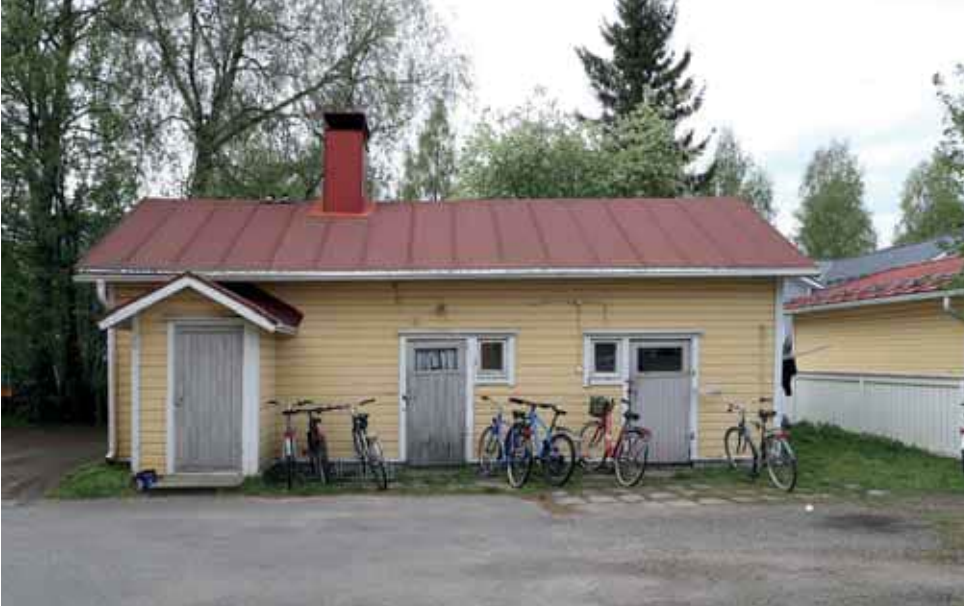
513. Piharakennukseen on tehty kuistilaajennus. Ulko-ovet ovat jälleenrakennuskauden tyyliset pystypaneloidut ovet, joissa on lasiaukko. (Kuva: Riitta Kosonen, Arkkitehtitoimisto Jorma Teppo Oy, 5/2021.)
