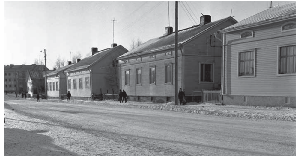
630. Teuvo Pakkalan katu 22–30. Tontin 274 rakennus kuvassa kolmas oikealta. (Kuva: Pohjois-Pohjanmaan museo, kuvaaja Ahti Paulaharju, 1964.)
