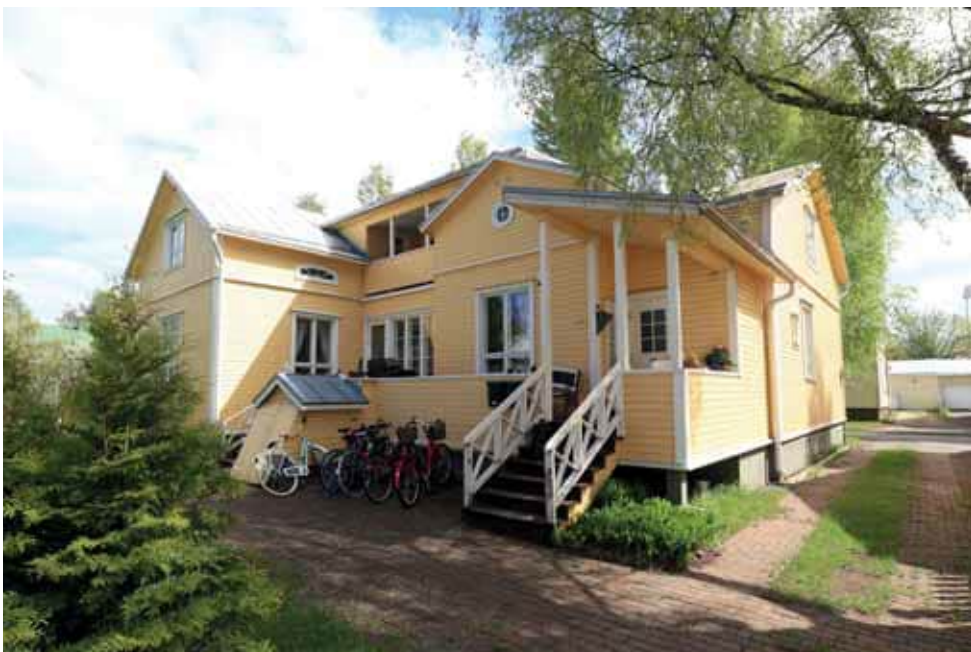
430. Karjakatu 6:n pihan puolelle on tehty runsaasti laajennuksia ja aukkomuutoksia. (Kuva: Riitta Kosonen, Arkkitehtitoimisto Jorma Teppo Oy, 5/2021.)
