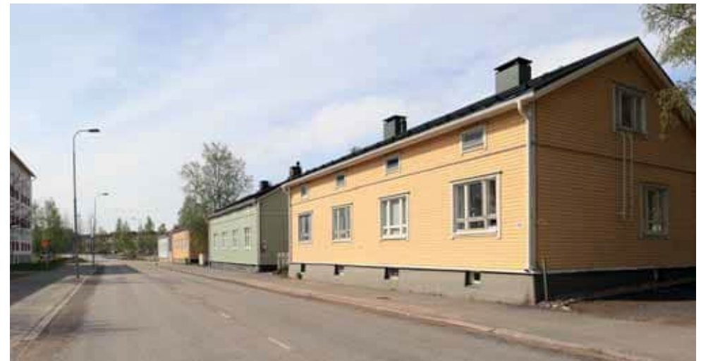
654. Teuvo Pakkalan katu 18 kerroslistaa ei ollut vielä 1960-luvulla. Yhden asunnon ikkunat on uusittu, mutt ovat alkuperäisiä siroja puuikkunoita. Rakennuksen sokkeliä on vahvistettu ulkopuolelta betonilla. (Kuva: Riitta Kosonen, Arkkitehtitoimisto Jorma Teppo Oy, 5/2021.)
