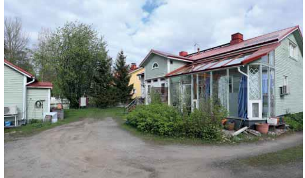
543. Pihan pinnat ja luonne on säilynyt alkuperäisen kaltaisena. Rakennusten päätyihin on lisätty ilmalämpöpumppuja. (Kuva: Riitta Kosonen, Arkkitehtitoimisto Jorma Teppo Oy, 5/2021.)
