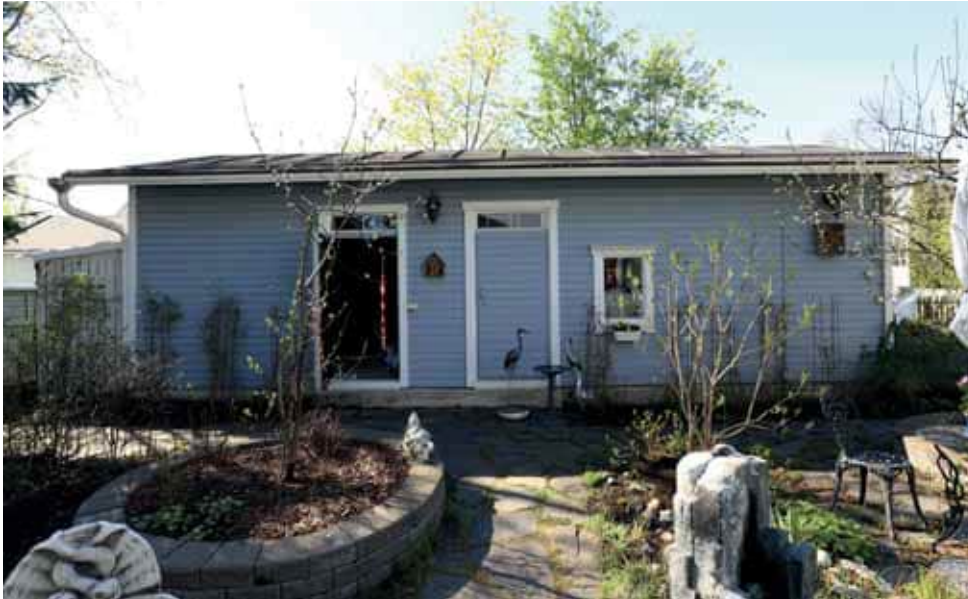
290. Karjakatu 26 uusi piharakennus ja huolellisesti rakennettua puutarhaa. (Kuva: Riitta Kosonen, Arkkitehtitoimisto Jorma Teppo Oy, 5/2021.)
