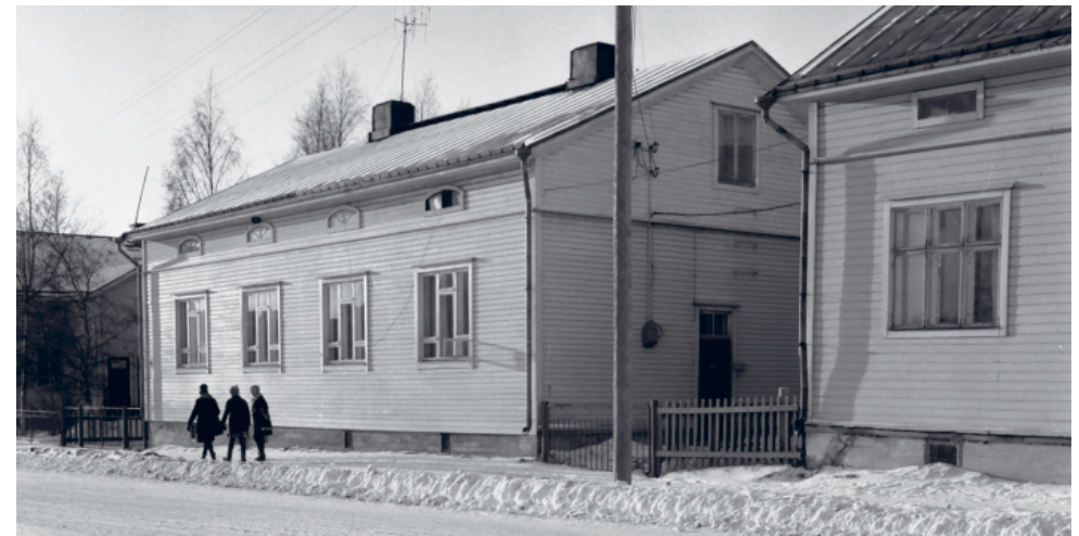
134. Teuvo Pakkalan katu 28 eli tontin 273 Kainuuntien alta purettu rakennus oli myös tyyppiä Kunnas 1. Tässä rakennuksessa oli yksi asunto perusratkaisua enemmän, joten päätyyn oli lisätty sisäkäynti. Ikkunoissa on perusratkaisua modernimpi jaotus. (Kuva: Pohjois-Pohjanmaan museo, kuvaaja Ahti Paulaharju, 1964.)
