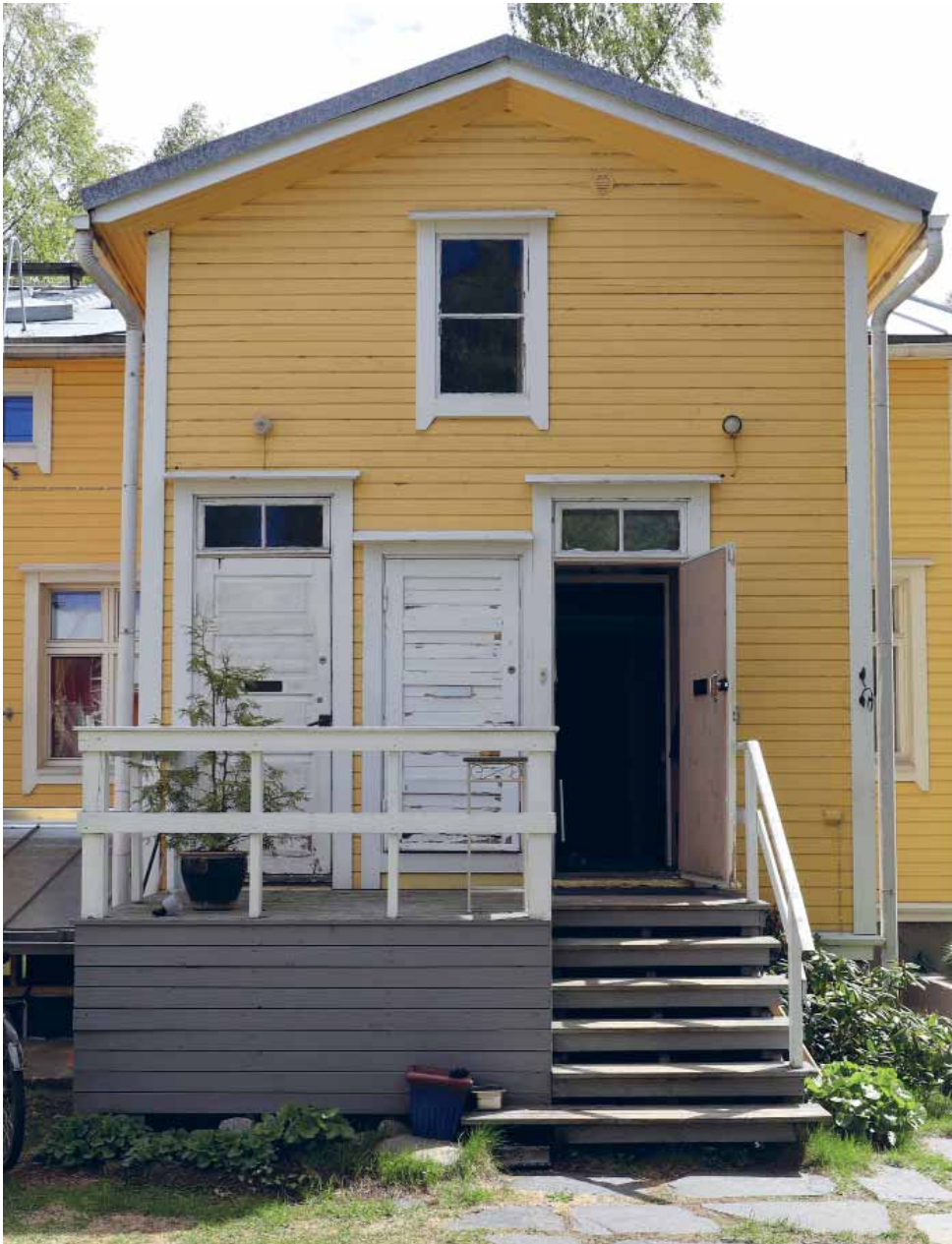
101. Tontin 246 ulko-ovet ovat alkuperäiset 5-peiliset puuovet. Myös kuistit ovat säilyneet pitkälti alkuperäisinä. (Kuvat: Riitta Kosonen, Arkkitehtitoimisto Jorma Teppo Oy, 5/2021)
