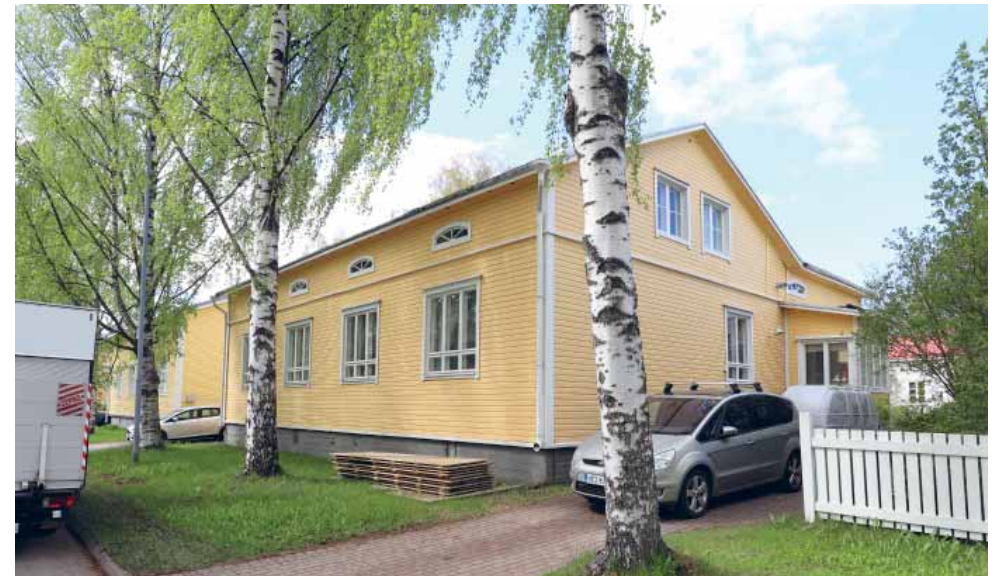
143. Tontilla 247 olevaa rakennusta on laajennettu L-malliseksi ja kuisteja on muutettu. Pihan puolella alkuperäinen malli ei ole enää tunnistettavissa. (Kuva: Riitta Kosonen, Arkkitehtitoimisto Jorma Teppo Oy, 5/2021)
