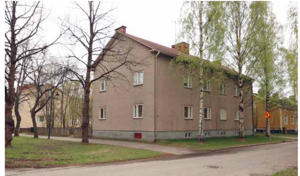
109. Tontin 264 puurunkoinen rakennus on rapattu. Se on tyypillinen jälleenrakennuskauden kerrostalo. (Kuva: Riitta Kosonen, Arkkitehtitoimisto Jorma Teppo Oy, 5/2021)
