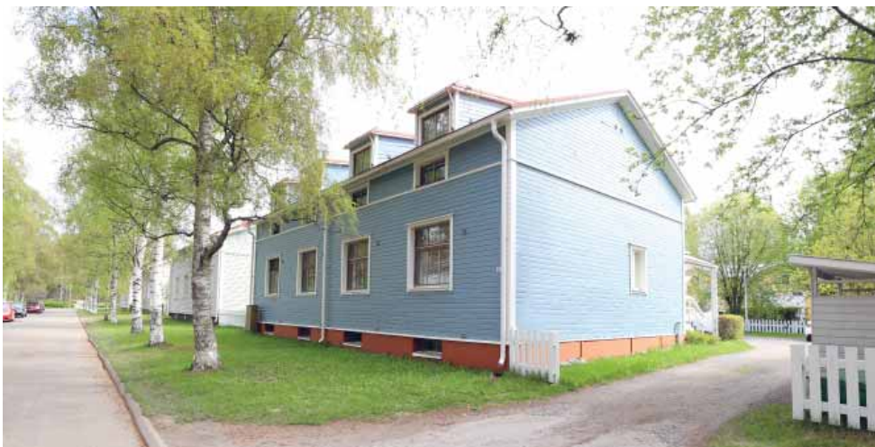
180. Tyypillinen esimerkki rakennuksesta, johon on tehty tyyliin vaikuttavia muutoksia. Rakennus on lisälämmöneristetty, ikkunat uusittu, katujulkisivuun on lisätty kattolyhyt. Pihan puolella kuisteja ja sisäänkäyntejä on muutettu. (Kuva: Riitta Kosonen, Arkkitehtitoimisto Jorma Teppo Oy, 18.5.2021)
