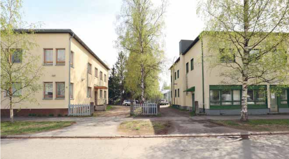
176. Vasemmalla tyypillinen esimerkki lähes alkuperäisenä säilyneestä rakennuksesta, jossa kuitenkin on ikkunat vaihdettu puitejako säilyttäen ja ulko-ovet uusittu. Oikealla tyypillinen esimerkki rakennuksesta jossa enemmän muutoksia, mutta tyyli säilynyt. Oikean puoleisessa rakennuksessa on lisäksi ikkuna-aukkoja pienennetty, sisäänkäyntejä poistettu ja arkkitehtuurin yksityiskohtia kuten kaiteita uudistettu. (Kuva: Riitta Kosonen, Arkkitehtitoimisto Jorma Teppo Oy, 18.5.2021)
