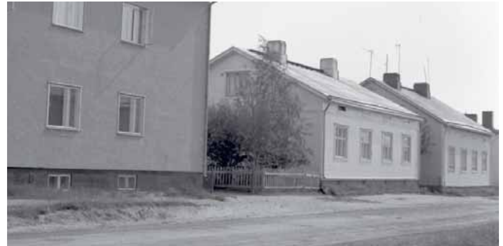
145. Tontin 265 tyyppi Kunnas 5 kuvassa keskimmäisenä. Kadun puolelta eri tyypit eivät juurikaan poikkea toisistaan tai Kunnaksen yksillöisistä ratkaisuista, sillä kaava ja rakennusmääräys määrittivät mittasuhteet ja ikkunoiden jaotos vaihteli tasaisesti kaikissa tapauksissa. (Kuva: Pohjois-Pohjanmaan museo, kuvaaja Ahti Paulaharju, 1964.)
