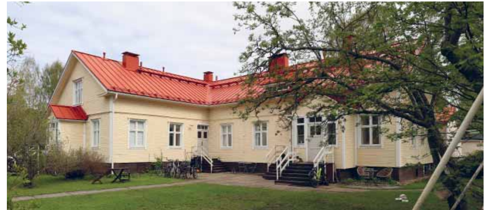
173. Tyypillinen esimerkki lähes alkuperäisenä säilyneestä päärakennuksesta. Katujulkisivussa ei muutoksia. Ikkunat uusittu puitejako säilyttäen, mutta raskastekoisempina. Ulko-ovet ovat alkuperäiset. Päädyn kuisti lisätty varhaisessa vaiheessa. Vesikate uusittu katemateriaalisäilyttäen. Kattolyhdyt ja niiden ikkunat alkuperäisiä. (Kuva: Riitta Kosonen, Arkkitehtitoimisto Jorma Teppo Oy, 18.5.2021)
