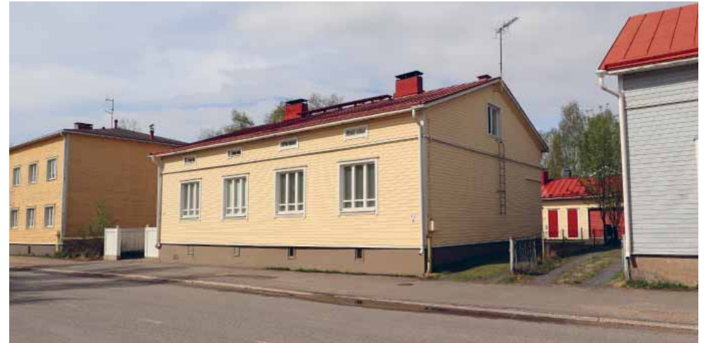
142. Tontin 258 asuinrakennus on tyyppiä Kunnas 4. Pihan puolella kuisteja on laajennettu, joten alkuperäinen malli ei ole enää tunnistettavissa. (Kuva: Riitta Kosonen, Arkkitehtitoimisto Jorma Teppo Oy, 5/2021)
