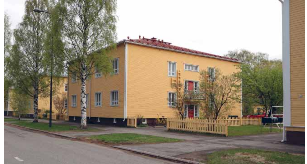
178. Tyypillinen esimerkki tyyliiltään säilyneestä noppatalosta, jossa on kuitenkin uusittu julkisivut lähes kokonaan ja lisätty runsaasti ulkopuolista lisälämmöneristettä. (Kuva: Riitta Kosonen, Arkkitehtitoimisto Jorma Teppo Oy, 18.5.2021)
