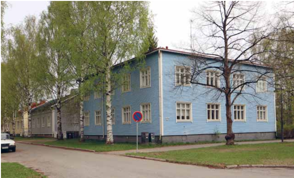
108. Tonteilla 256 ja 257 sijaitsee lähes identtiset L-malliset puukerrostalot. Ne edustavat puutalo- klassismia. (Kuva: Riitta Kosonen, Arkkitehtitoimisto Jorma Teppo Oy, 5/2021)
