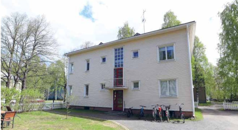
174. Tyypillinen esimerkki ulkoisesti lähes alkuperäisenä säilyneestä noppatalosta, jossa on paljon alkuperäisiä tai alkuperäisen mukaisena uusittuja rakennusosia kuten ikkunat, ovet ja katto, mutta julkisivuihin on lisätty lämmöneristettä ja laudoitus uusittu. Rakennuksessa ei ole laajennuksia. (Kuva: Riitta Kosonen, Arkkitehtitoimisto Jorma Teppo Oy, 18.5.2021)
