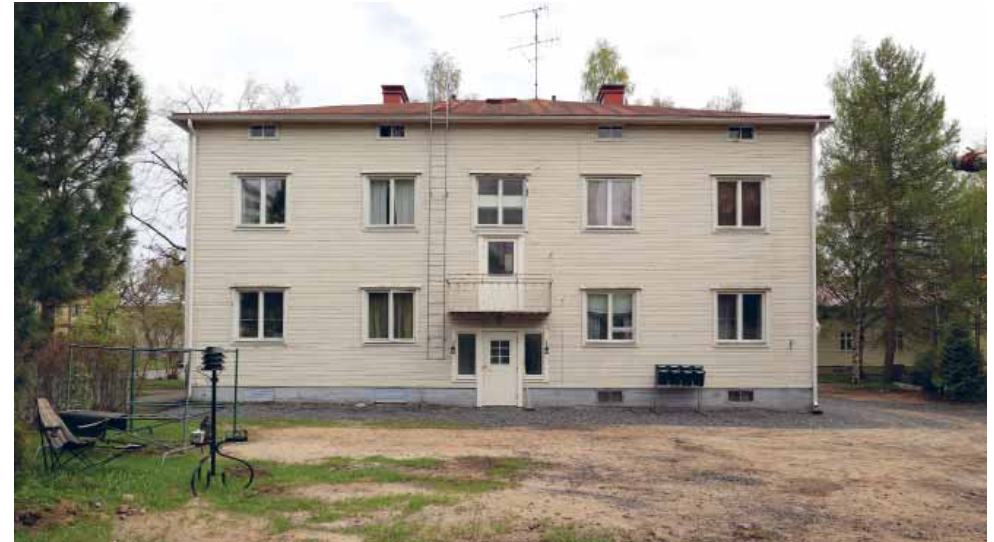
104. Tontin 219 noppatalon ikkunat toteutuivat kaksijakoisina. Ulko-ovet on vaihdettu. (Kuva: Riitta Kosonen, Arkkitehtitoimisto Jorma Teppo Oy, 5/2021)
