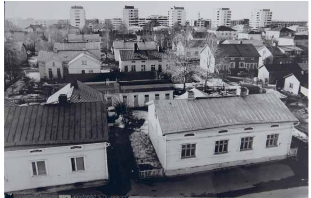
148. Kuvassa vasemmalla tonttien 268 ja 275 peilikkuvina toteutetut L-malliset talot. Etualalla olevan rakennuksen ikkunat on vaihdettu T-mallisiksi. (Kuva: Raksilan asukasyhdistys)
