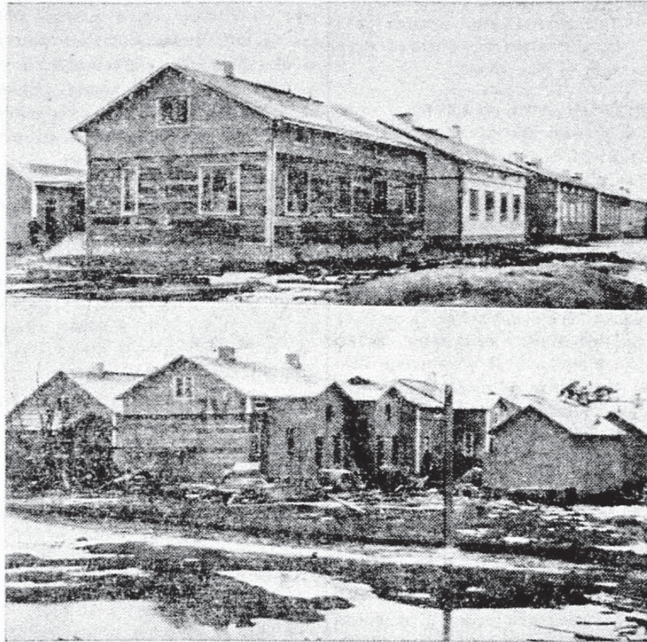
Rakennustoiminta Oulussa on viime aikoina ollut erittäin vilkasta myöskin Rautatientakana, jonne on Syrjäkadulta Oulujoelle päin oleville tonteille kohonnut rakennus toinen toisensa viereen. Ylläolevassa kuvassamme näemme ensin rivin jo valmistuneita uudistaloja, alempana useita rakennustyön alla olevia.
