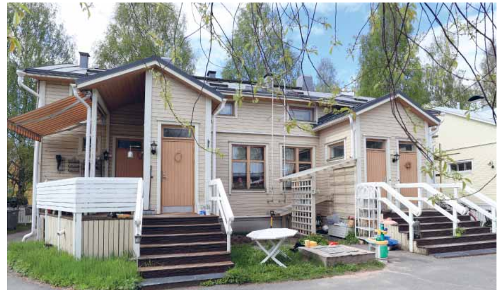
146. Tontilla 253 asuinrakennukseen on lisätty kuistit jälkikäteen, kuten Raksilassa on tyyppillisesti tehty alun perin kuistittomissa ratkaisuissa. Näin on tehty myös tontilla 265. Myös ikkunat ja ulko-ovet on vaihdettu. (Kuva: Riitta Kosonen, Arkkitehtitoimisto Jorma Teppo Oy, 5/2021)
