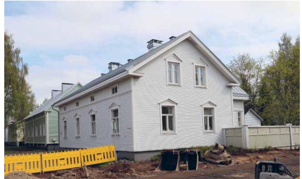
151. Tontin 226 asuinrakennus on ainoa säilynyt Miesmaan tyyppiratkaisuista. Suunnitelmalle tunnusomaista olivat ikkunoiden päällä olevat päätykolmiot. Alun perin rakennukseen ei suunniteltu haukkaikkunoita. (Kuva: Riitta Kosonen, Arkkitehtitoimisto Jorma Teppo Oy, 5/2021)
