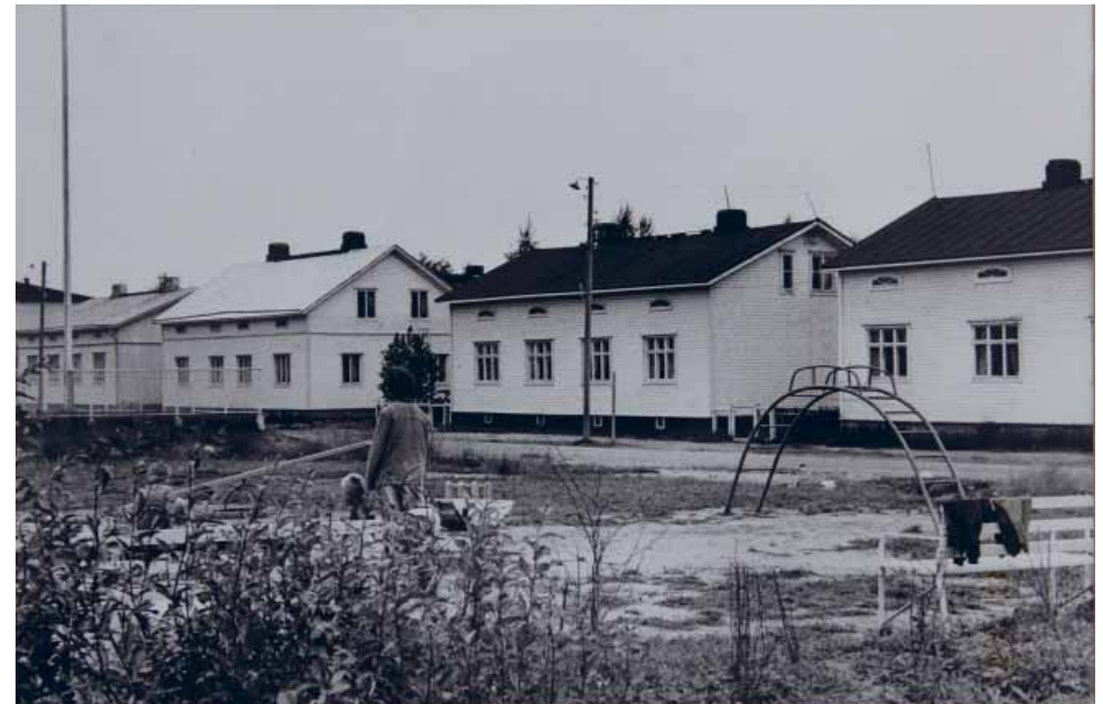
117. Kuvassa Teuvo Pakkalan kadun varren taloja. Kuvassa näkyvät vasemmalta oikealle Teuvo Pakkalan katu 12, 10, 8 ja 6. Suunnittelijoina taloissa ovat olleet korkeimmassa Miesmaa ja lopussa Kunnas. Nykyisen jäähallin parkkipaikalla sijaitsi leikkikenttä. (Kuva: Rakasilan asukasyhdistys.)
