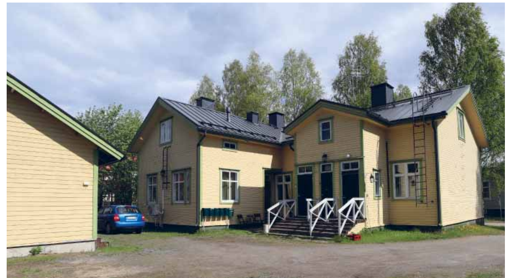
149. Tontin 231 asuinrakennus on massaltaan ja aukotukseltaan alkuperäisen mukainen. Tässä versiossa nurkan syvennyksessä on vain yksi sisäänkäynti. L-sakaran toisella puolell on käynnit kahteen asuntoon. (Kuva: Riitta Kosonen, Arkkitehtitoimisto Jorma Teppo Oy, 5/2021)
