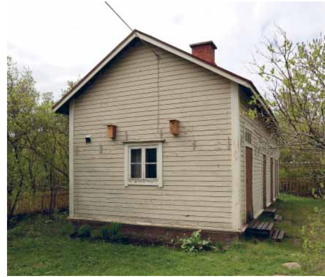
112. Puu-Raksilassa on vielä yksi ulkoisesti kaikilta osiltaan alkuperäisenä tai alkuperäisen mukaisena säilynyt piharakennus. Rakennus sijaitsee korttelissa 29 tontilla 204. Rakennuksen suunnitelma on likipitään vastaava kuin alla esitetty tontin 202 piharakennuksen suunnitelma. (Kuva: Riitta Kosonen, Arkkitehtitoimisto Jorma Teppo Oy, 5/2021)
