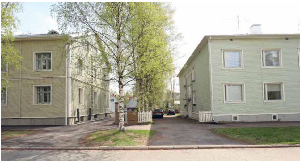
181. Tyypilliset esimerkit rakennuksista, joissa tyyliin vaikuttavia muutoksia. Vasemmassa rakennuksen julkisivumateriaali on vaihtunut ensimmäisen kerroksen osalta, ikkunat ovat voimakkaasti syvennyksessä, sokkeli on levytetty. Oikean puoleisessa rakennuksessa ikkunat ja ulko-ovet on vaihdettu tyyliiltään alkuperäisestä rakennuksesta poikkeaviksi. Ikkunoiden puitejako on muuttunut. (Kuva: Riitta Kosonen, Arkkitehtitoimisto Jorma Teppo Oy, 18.5.2021)
