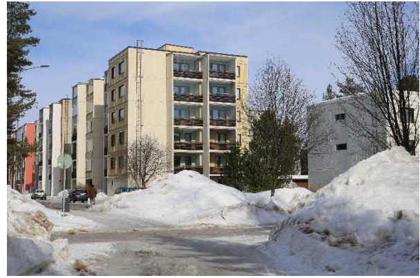
Kuva 38. Alue on suurelta osin rakennettua.
