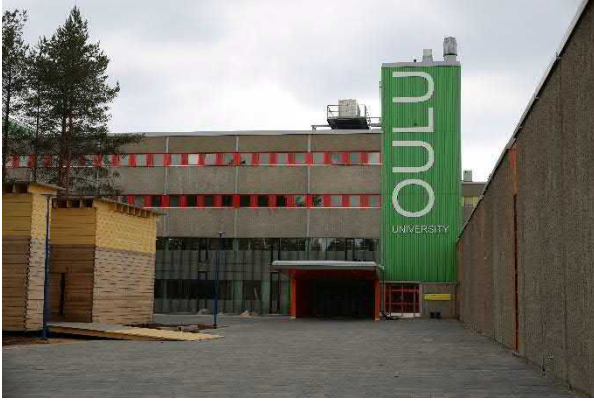
Kuva 54. Oulun yliopiston uusi pääsisäänkäynti.
