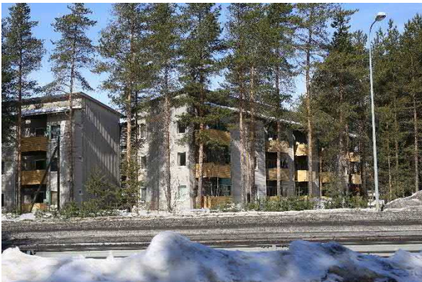
Kuva 57. Puurakentamista Kaijoharjun keskussa.
