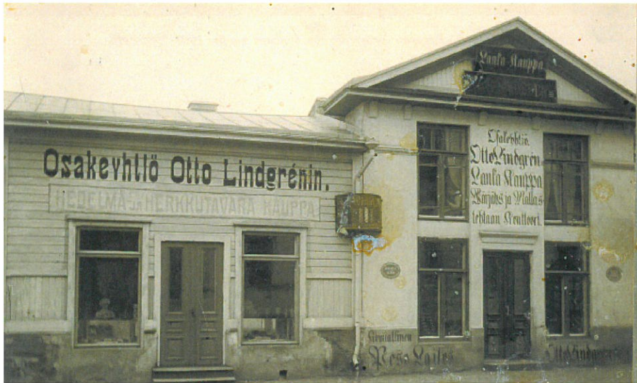
Kuva 89. Pakkahuoneenkatu 5, Lindgrenin kauppa vuonna 1910 (PPM).
