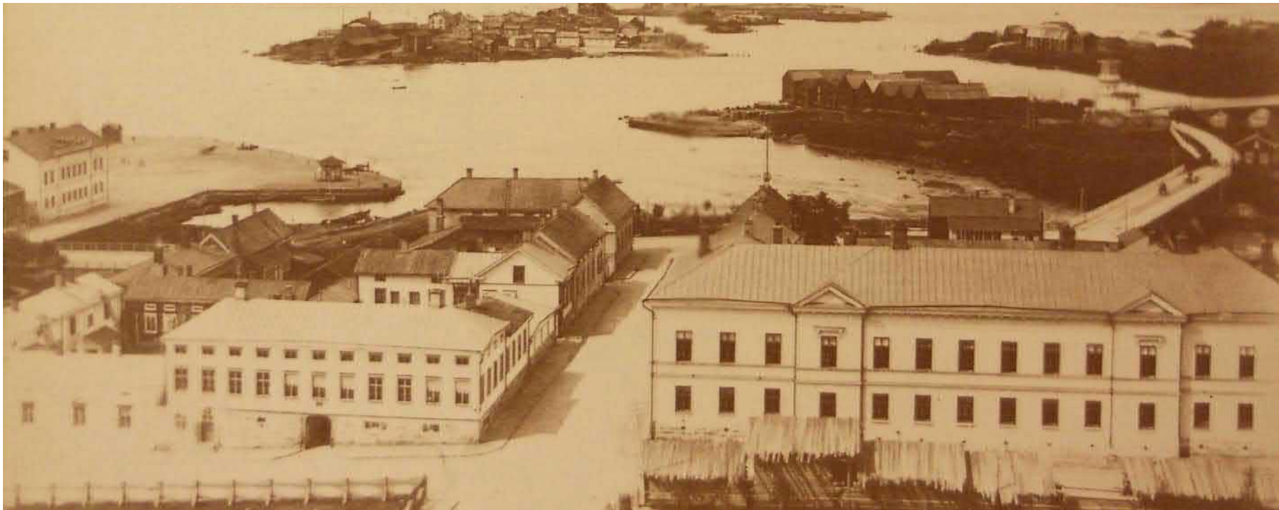
Kuva 18. Vuosina 1875-75 laajennettu Oulun lyseo, taustalla Linnansaaren tähtitorni ja kauppiaiden makasiinit. Merikoulun rakennuksen harjalla näkyy harjakoriste. Kuva otettu vuosien 1875 ja 1880 välillä, Ina Liljeqvist & Co. Werner Johannes Åströmin arkisto, Oulun Maakunta-arkisto.
