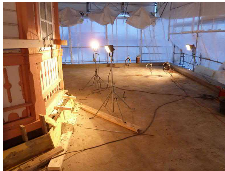
Kuva 77. Tähtitornin terassin betonivalutöiden aikaan. Valokuva Kari Parkkinen.
