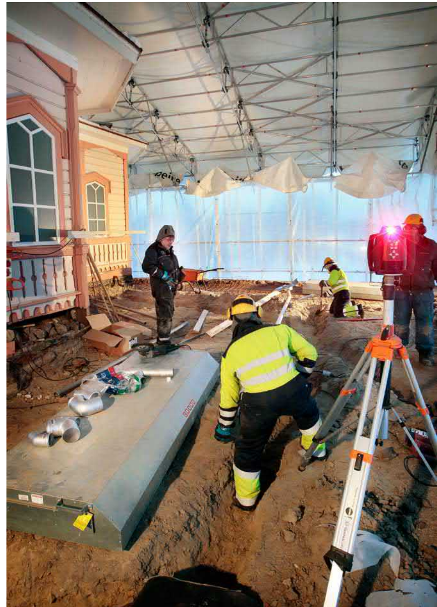
Kuva 75. Terrassin maalattiaan kaivettiin ojat sadevesiviemäriä varten. Työ tehtiin käsipelillä, etteivät tähtitornin alla olevat holvit vaurioitu. Kuva Jukka Leinonen, 3.1.2011, Kaleva.
