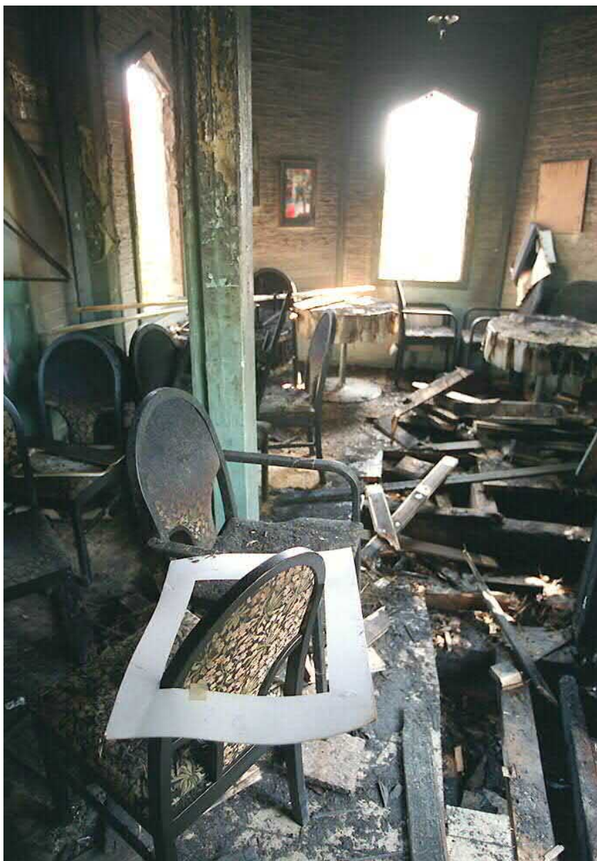
Kuva 47. Tulipalon tuhoja ensimmäisessä kerroksessa. Kuva Tapio Maikkola, 21.7.1997, Kaleva.
