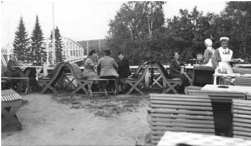
Kuva 39. Lottakahvilan terassi, vielä maapohjaisena. Pohjois-Pohjanmaan museo.
