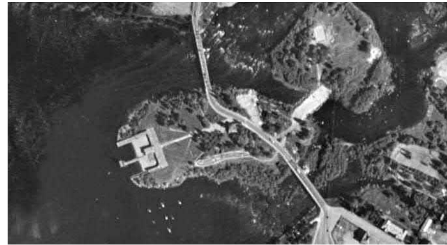
Kuva 11. Linnansaarelle vievät sillat ja uimalaitos vuonna 1947. Liikelaitos Oulun Tilakeskus.
