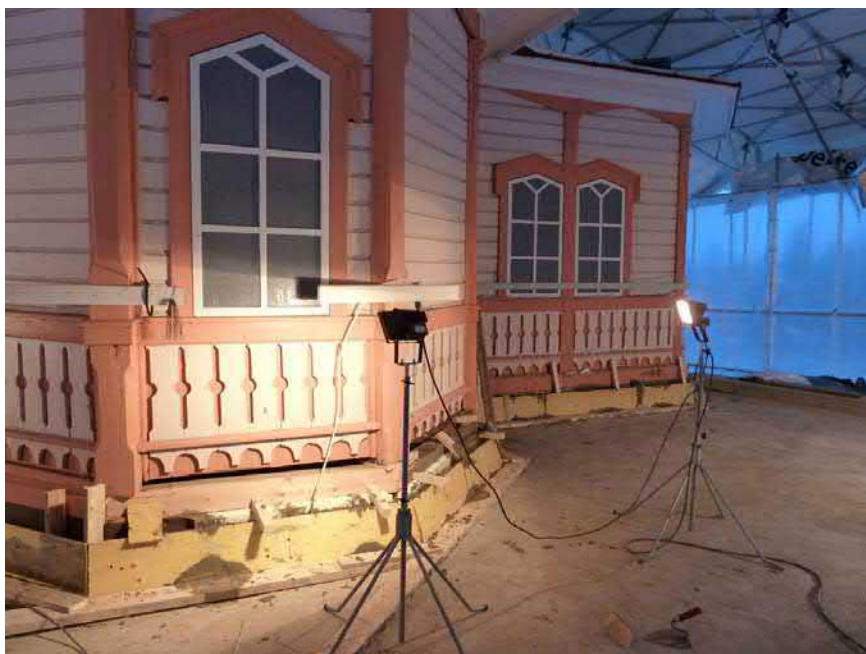
Kuva 79. Terrassin pohjan valutöiden valmistuttua tornin juuren ympärille valettiin betonimantteli. Valokuva Kari Parkkinen.
