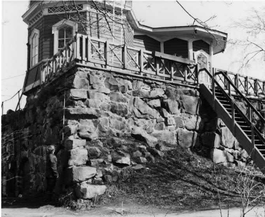
Kuva 68. Terrassin pinta on laatoitettuna ja uudet kaiteet asennettuna. Torni on saanut tumman värityksen. Kuva vuosien 1966 ja 1970 väliltä. Pohjois-Pohjanmaan museo.
