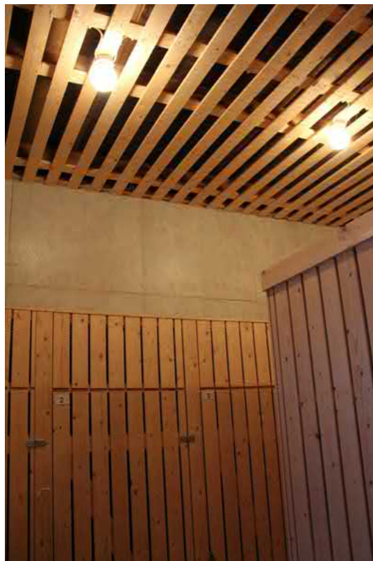
129. Varastorakennus on ulkoiselta hahmoltaan alkuperäisen kaltainen. Sisäpuolella on varastot on palo-osastoitu levyttämällä
