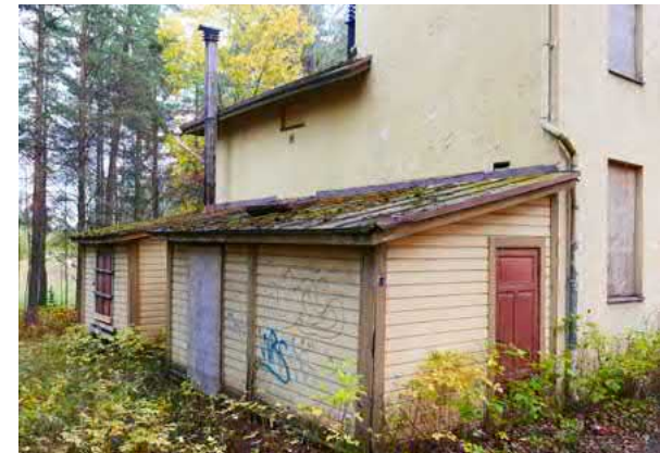
143. Julkisivu länteen. Edessä on pesulan aputiloja.
