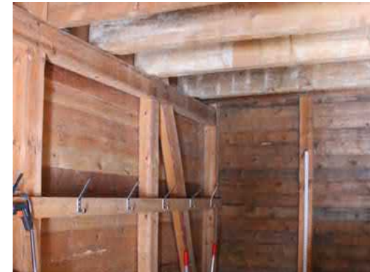
169. Rakennus on rankarunkoinen, vain tallin seinät on hirrestä.
