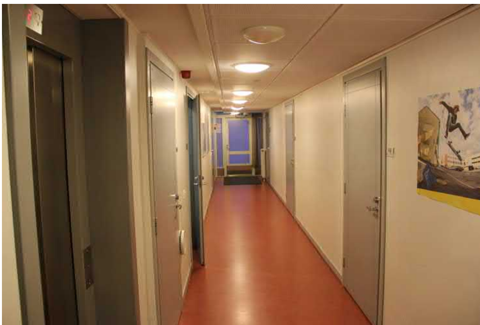
117. Asunnot on ryhmitelty keskuskäytävän varrelle. Vasemmalla on 2004 peruskorjauksen yhteydessä asennettu hissi.
