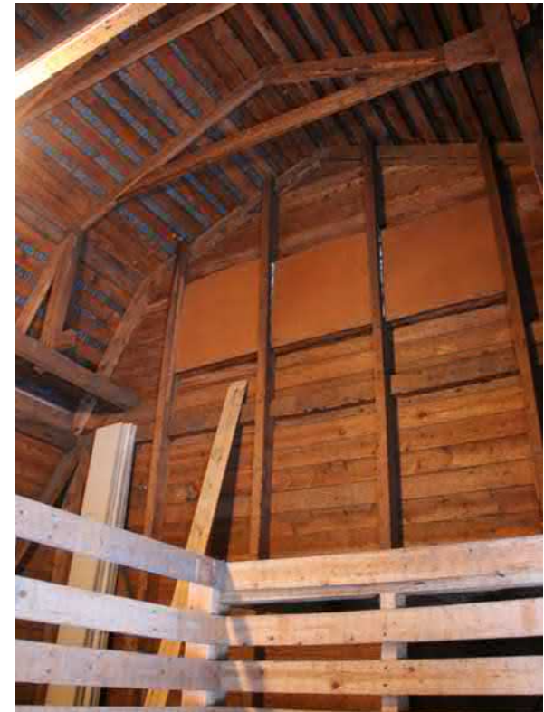
195. Sisätila on korkea ja sen rakenteet ovat näkyvissä.
