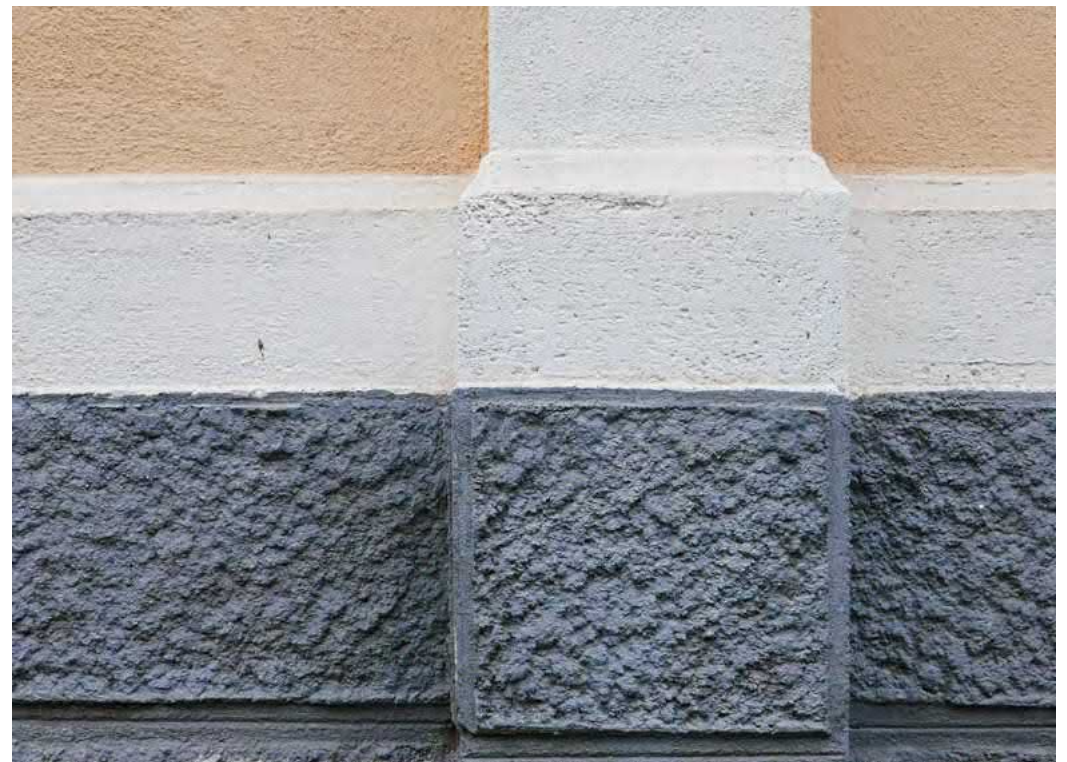
191. Hirsirunkoisen rakennuksen julkisivut on rapattu muistuttamaan kivirakennusta.
