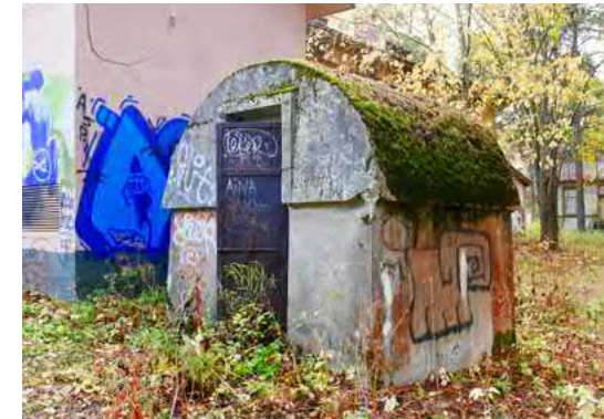
150. Monoliittinen tuhkarasto on valettu kahdessa osassa.
