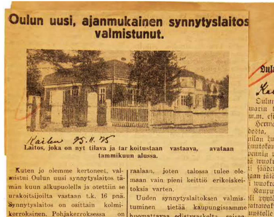
64. Pitkään odotetun uuden synnytyslaitoksen valmistuminen herätti oululaisissa innostusta. Sanomalehti Kaiku esitteli rakennusta 25.11.1925. Kuva: Oulun Kaupunginarkisto
