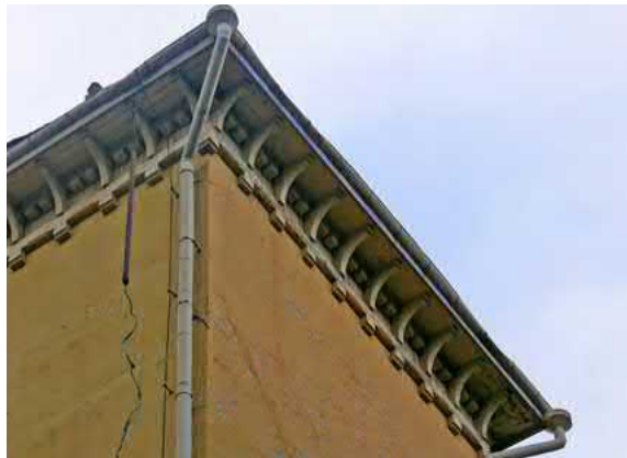
140. Puiet konsolit kannattelevat vesitornin kattotasannetta.
