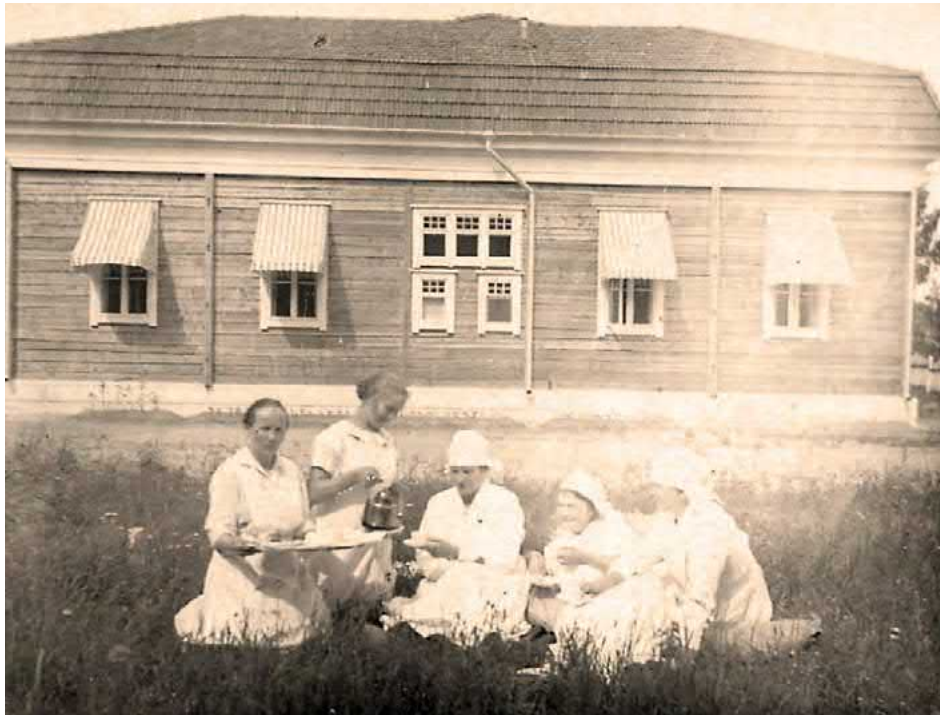
63. Synnytysairaala ennen julkisivujen rappaamista. Rappausverkon kiinnittämisessä on käytetty pieniä tähden muotoisia tiiliä. Myöhemmin päätyjulkisivussa näkyvään mansardikattoon puhkaistiin sairaanhoitajien asuntojen ikkunalyhdyt. Kuva: PPM
