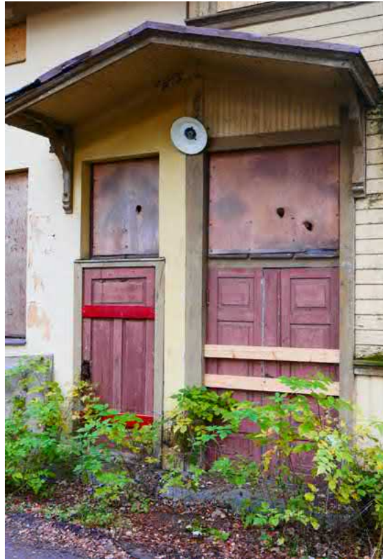
148. Sisäänkäynti on säilynyt alkuperäisenä.
