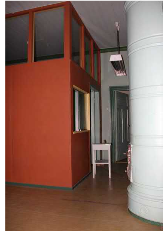
149. Sisätiloissa on runsaasti kerrostumia sadan vuoden ajalta. Ne ovat tunnistettavissa ja tarvittaessa poistettavissa.
