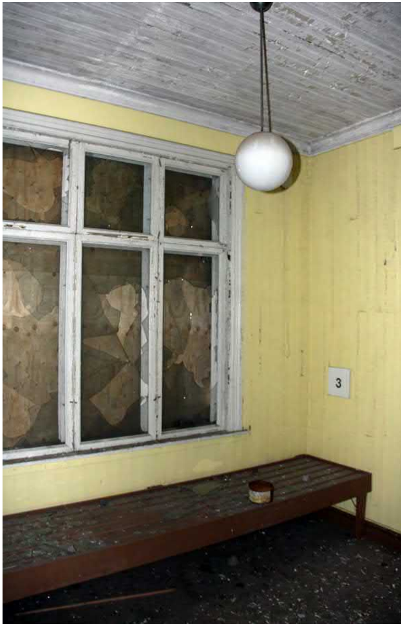
137. Alkuperäiset rakennusosat ovat paksujen maalikerrosten peittämiä.
