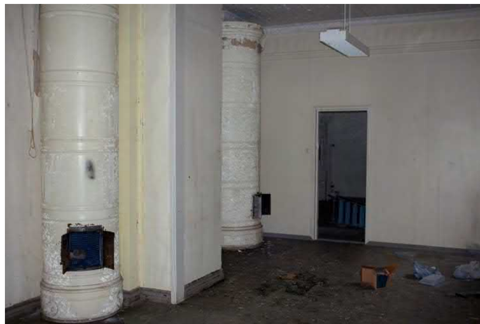
165. Ruokala rakennuksen laajin yhtenäinen tila. Teräskuoriset pystyuunit ovat säilyneet. Kuva: Ida Mustamaa
