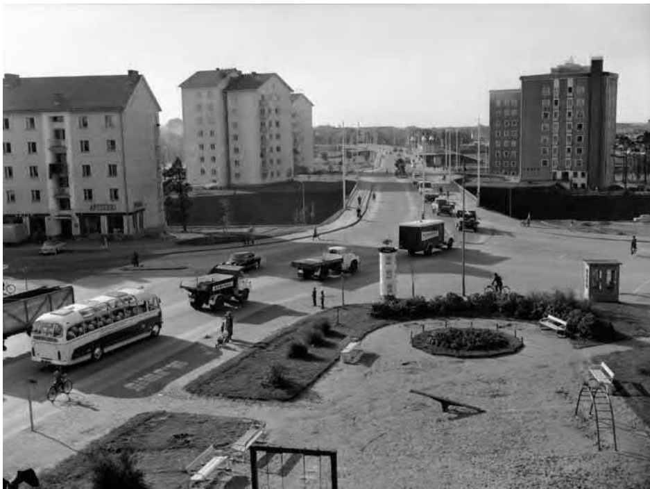
74. Tuiran Koskikeskuksen rakentaminen 1950-luvun alussa teki Tuirasta Suomen modernin kaupunkirakentamisen näytekkunan. Sen uskottiin korvaavan nähtävyytenä vesivoiman palvelukseen valjastetut kosket. PPM Uuno Laukan kokoelma
