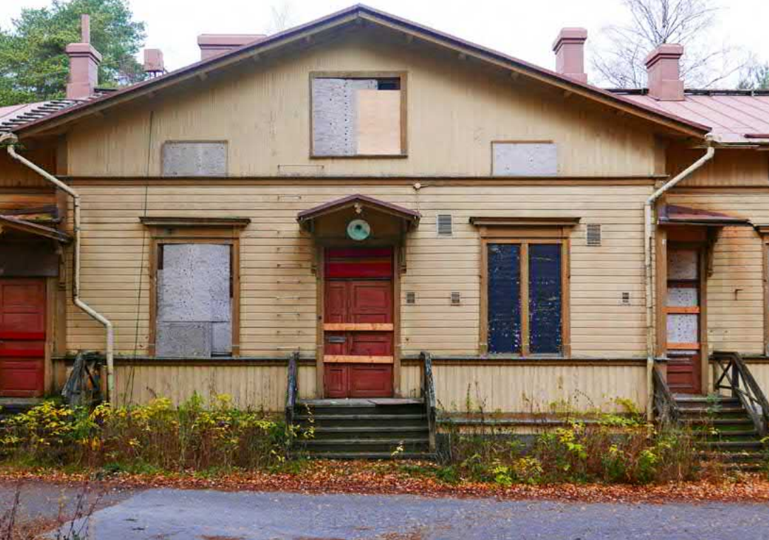
160. Pääsisäänkäynti sijaitsee rakennuksen keskellä. Sen yläpuolelle rakennettiin vuonna 1925 palvelijan asunto.
