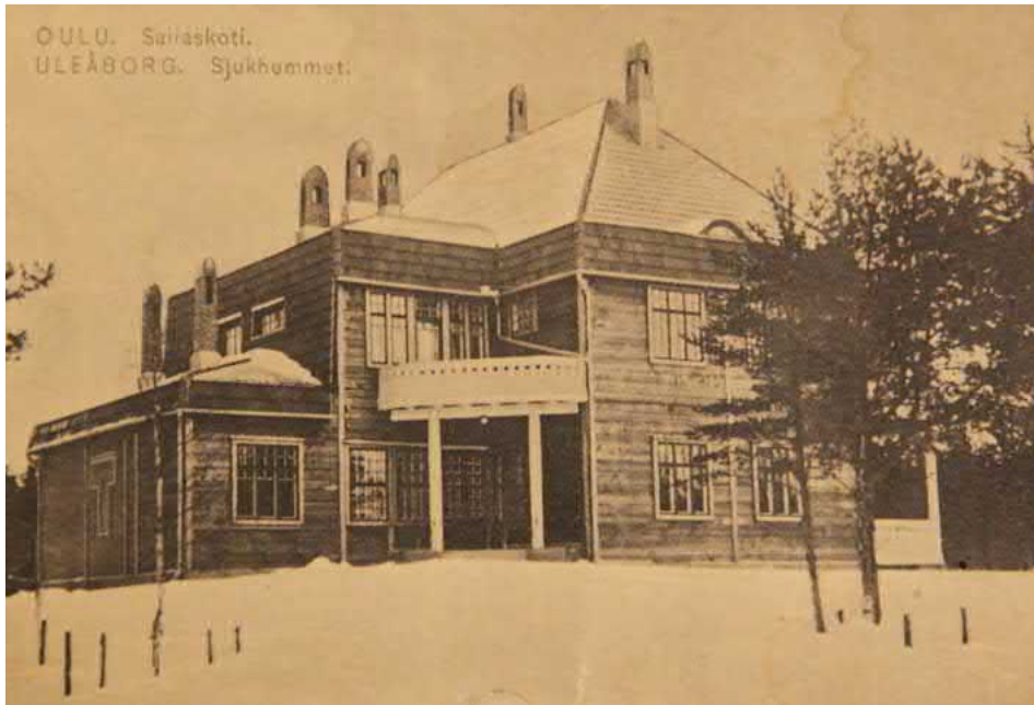
51. Postikorttikuvassa Hermolan vastavalmistunut rakennus odottaa julkisivuvuorauksia. Kuva: PPM
