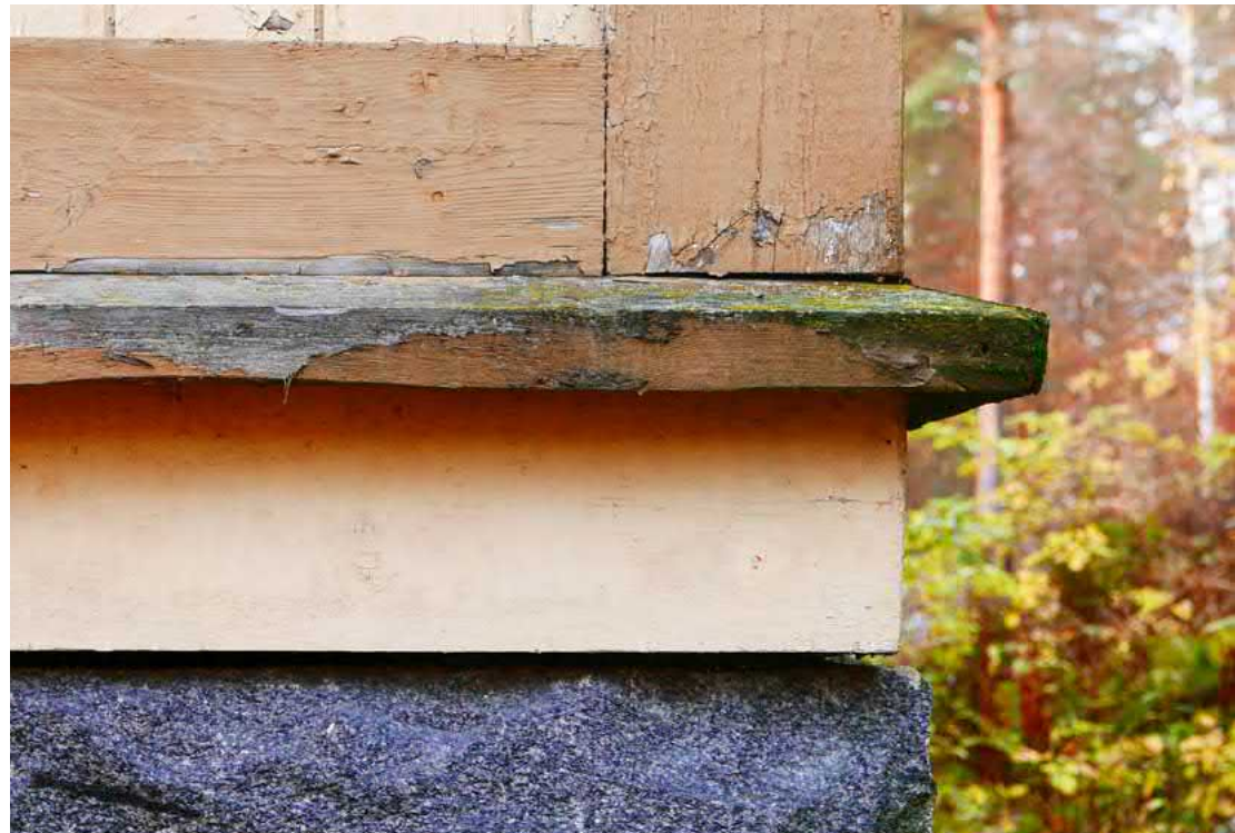
163. Yksityiskohta kivijalan ja puurungon liitoksesta.
