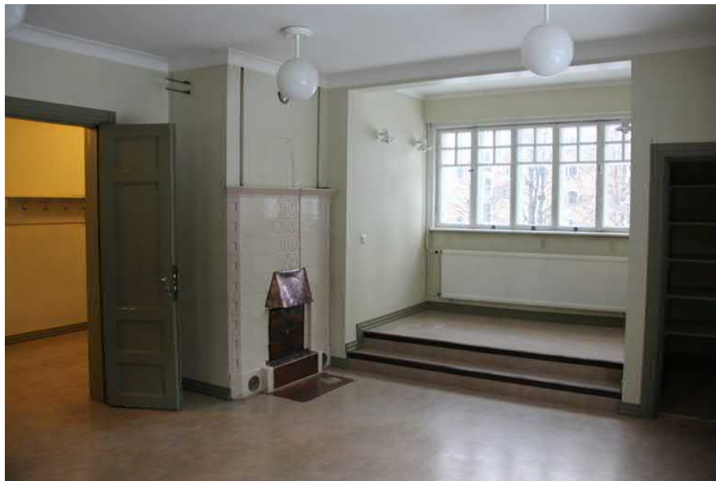
206. Rakennuksen sisätiloissa on säilynyt valkoisia kaakeliuuneja. Huoneiden alkuperäiset materiaalit ovat peittyneet vuosien 1975 ja 1988 korjausten yhteydessä.
