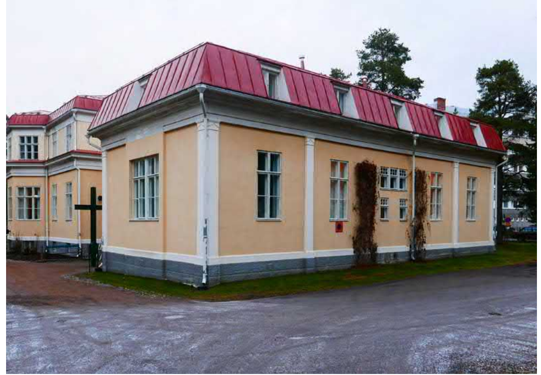
189. Eteläpäädyn kattohuoneistoon on rakennettu asuinhuoneita sairaanhoitajille.
