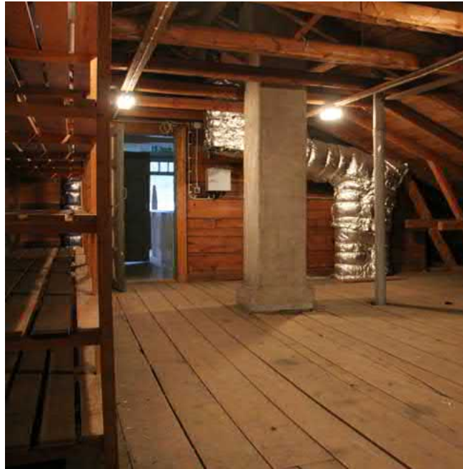
213. Ullakko on säästynyt suurilta muutoksilta.
