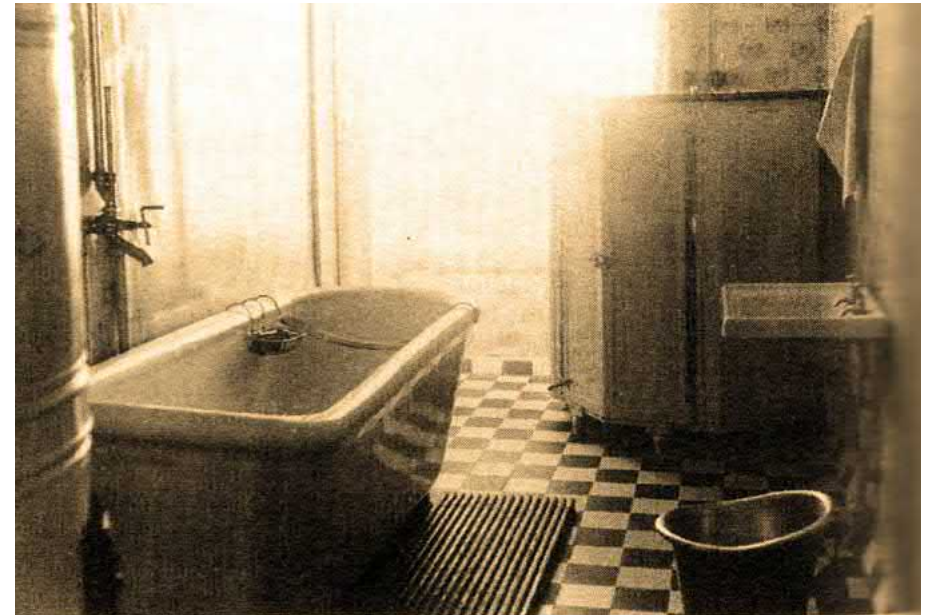
46. Hygieniaan kiinnitettiin suurta huomiota. Potilasosastot varustettiin kylpyhuoneilla. Osastoille tuli vesi sairaalan oman vesitornin paineistamana. Käytettävissä oli myös lämmintä vettä 1906. PPM
