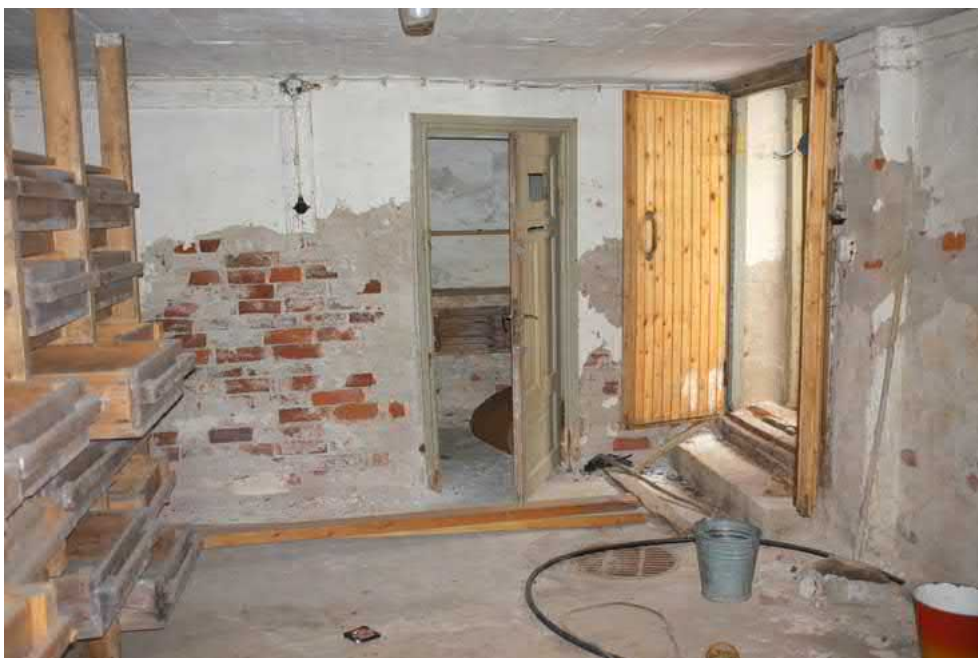
164. Rakennuksessa on vuonna 1937 rakennettu täysikokoinen kellari, jonne on suora sisäänkäynti rakennuksen takaa. Kuva: Ida Mustamaa
