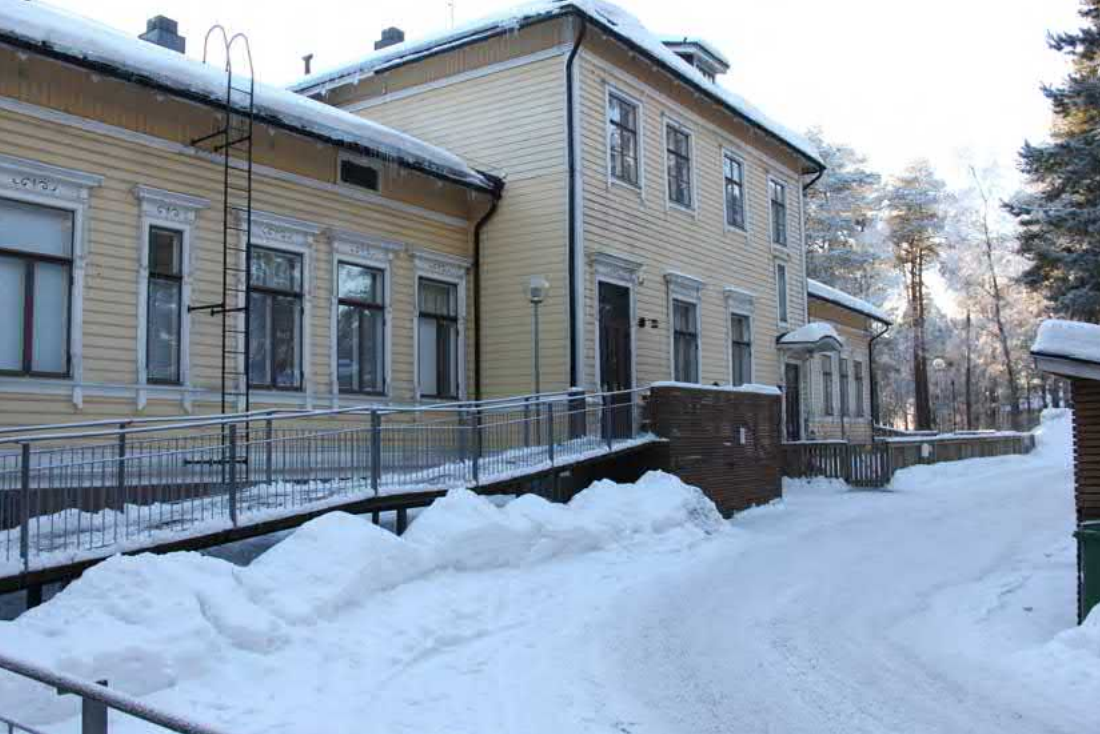
178. Etupihalle on tehty pitkä pyörätuoliluiska. Sisäänkäynnin muutoksessa ikkuna ja ulko-ovi ovat vaihtaneet paikkaa.
