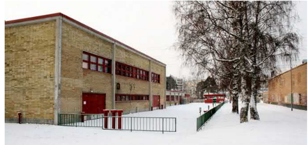
Kuva 9 Pohjoispuoleinen piha-alue on varattu keittiön huoltoon ja henkilökunnan paikoitukseen
