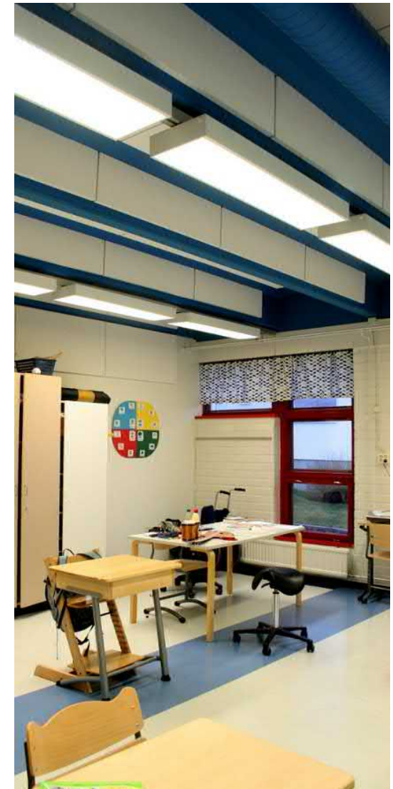
Kuva 30 Luokkien akustointia on parannettu akustointilevyillä. Lattiassa sinisen laattarivin kohdalla on ollut väliseinä. Kalustus on kokoelma koulun toimintavuosilta.
