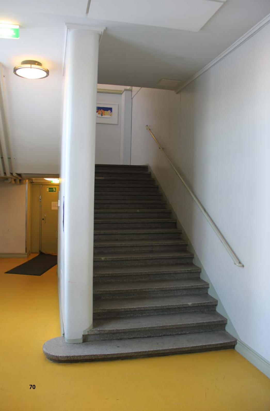
181. VASEMMALLA on ensimmäisen kerroksen porrashuone. Mosaikkibetonista valetut askelmat ovat alkuperäiset. Portaalla on sähköpääkeskus.
