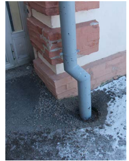
100. Pihan puolella sadevesi kerätään suoraan huulevesijärjestelmään.
