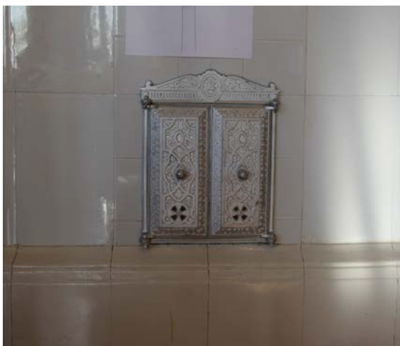
155. Alkuperäisestä lämmitysjärjestelmästä on jäljellä kaksi kakluunaa.
