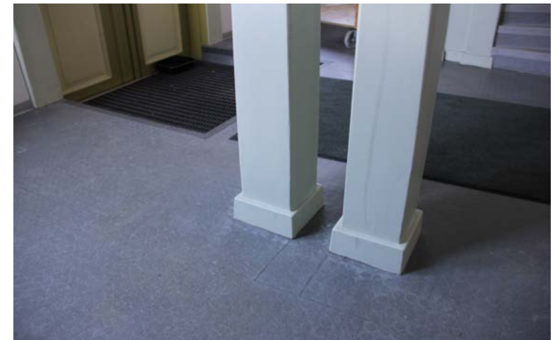
133. Porrashuoneen lattia on pinnoitettu kulutusta kestäväällä kolikkomatolla.
