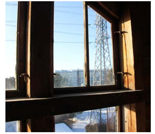
146. Ullakon päätyikkuna on alkuperäinen vuodelta 1931.
