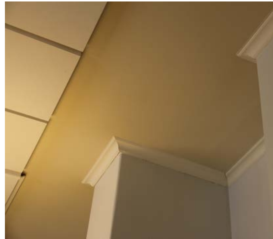
124. Luokkahuoneen alakatto on sävytetty ja sitä kehystä kovera kattolista.
