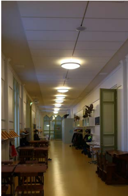
126. Valaisimet ja akustiikkalevyt jäsentävät käytävän alakattoa. Ilmanvaihtotekniikka on upotettu alakattoon sekä sivuseiniin.
