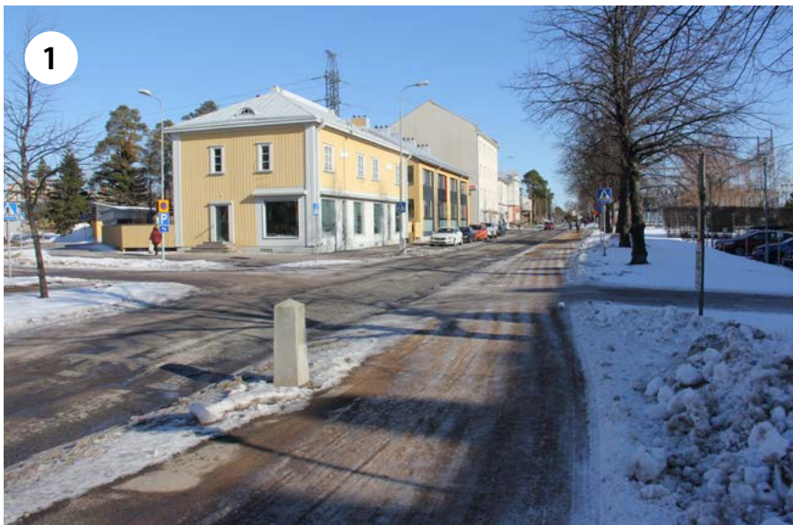
7. Näkymä Merikoskenkadulta koulun suuntaan. Koskitien vasemmalla puolella on ensin Osuuskaupan talo (1925) ja sen takana Säästöpankin talo (1938). Niiden välissä on 2000-luvun täydennysrakentamista.
