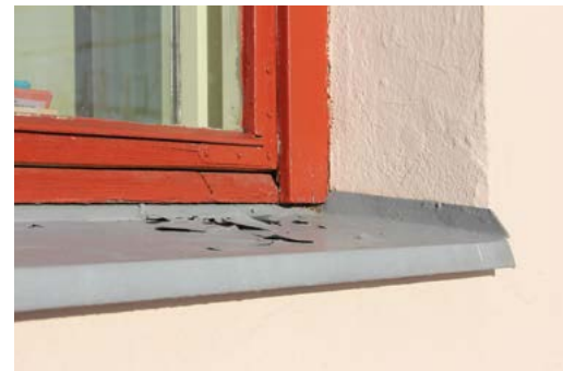
142. Ensimmäisen kerroksen ikkuna ulkopuolelta.
