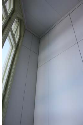
178. Seinät on eristetty ja levytetty.
