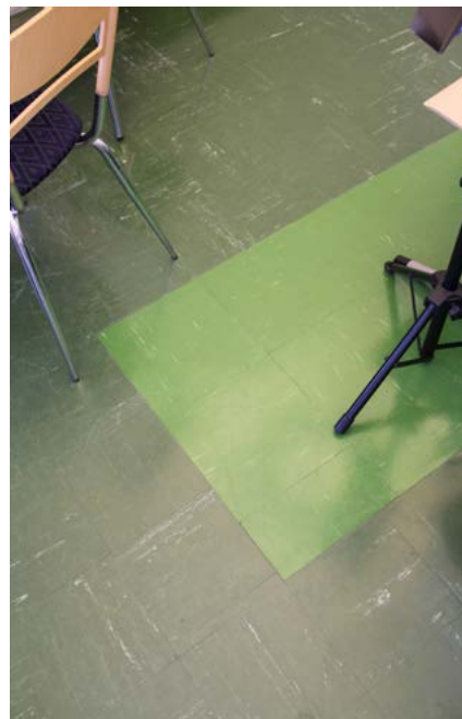
212. Lattia on päällystetty Hovi-vinyylilaatoilla.
