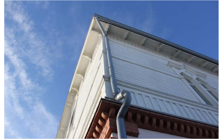
103. Avoräystäitä kannattaa kattotuolien vasat sekä puiset konsolit.
