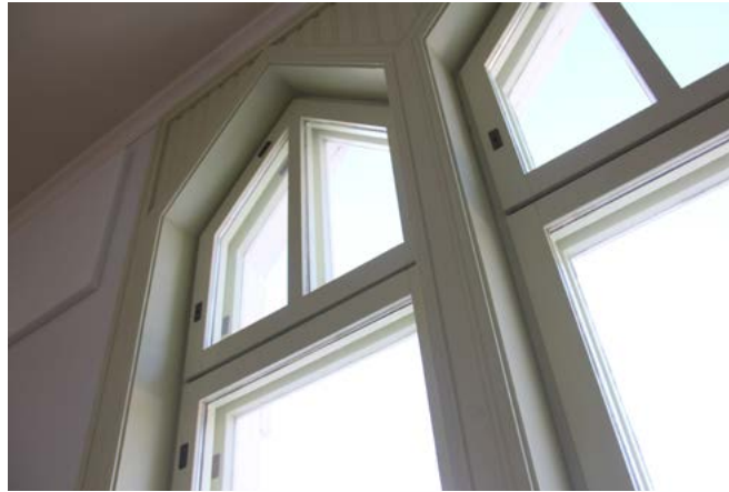
144. Toisen kerroksen ikkuna muodostuu kahdesta päällekkäisestä osasta. Molemmat osat ovat avattavia.
