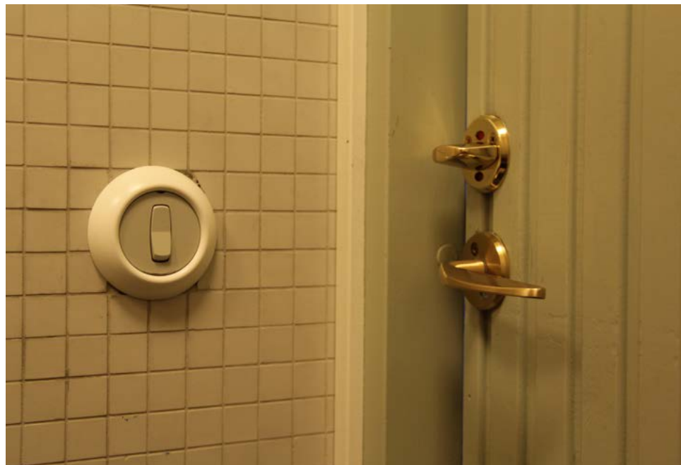
208. Yksityiskohta WC:n sisäpuolelta. Pintamateriaalit ovat korkeatasoisia.
