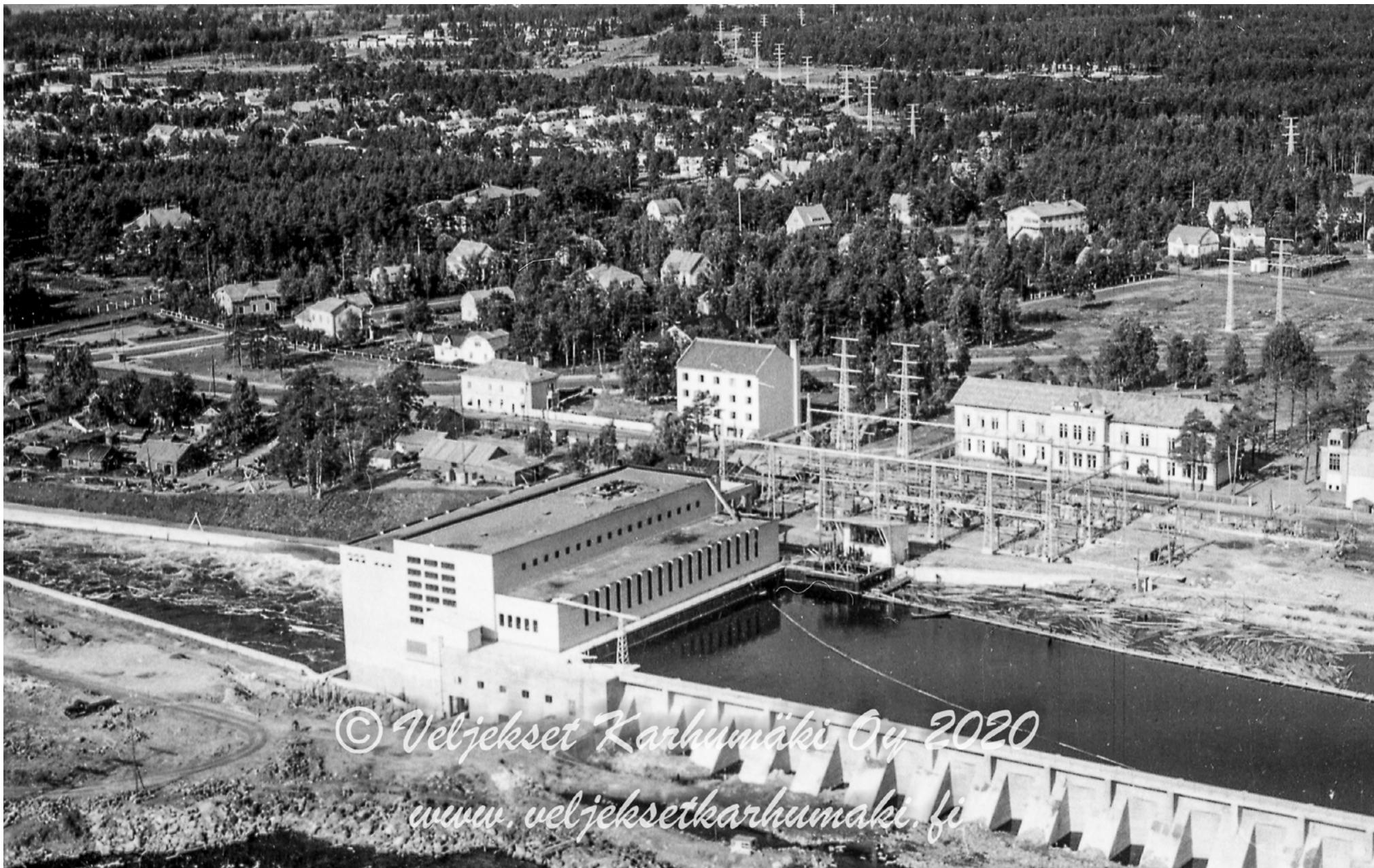
53. Syksyllä 1949 voimalaitoksen kytkinkenttä on valmistunut. Tuiran koulun takana on rakentamatonta nurmikenttää, jonka poikki kulkee Ouluntie Tuiran torille. ILMAKUVA: Veljekset Karhumäki Oy
