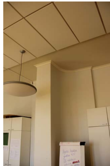
205. Kahden puretun pystyseinin kaareva palomuurin on säilynyt luokassa 214.
