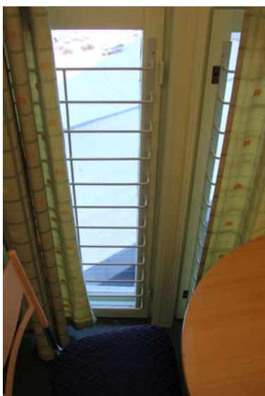
214. Ikkunat on varustettu kaltereilla.
