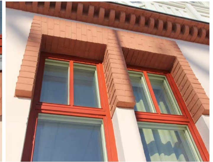
114. Keskirisaliitissa ikkuna-aukkoa on korostettu muuratulla kehyksellä.
