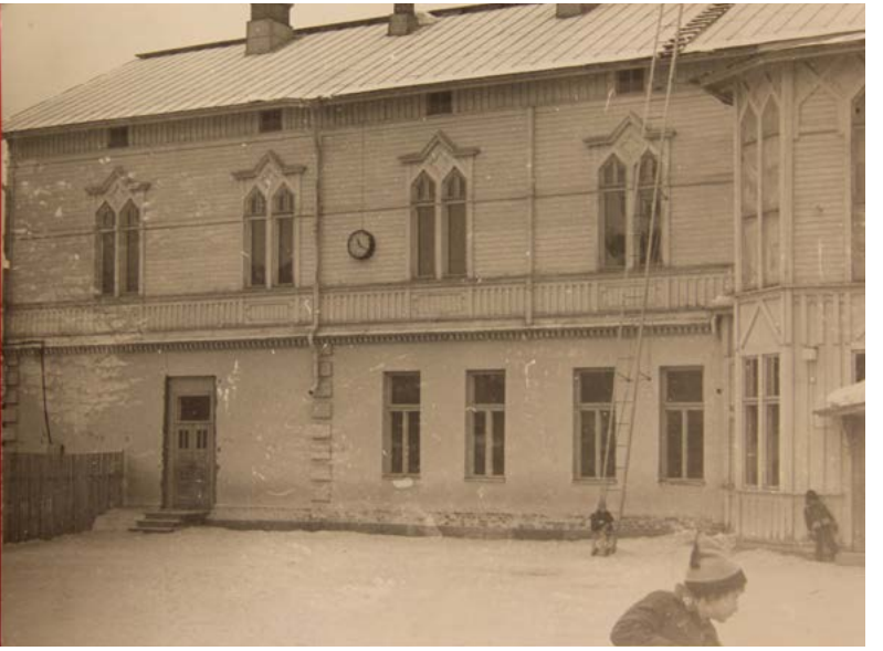
56. 1970-luvun alussa otetussa valokuvassa näkyy ovi sisäpihalle. Sen tilalle tehtiin kaksi ikkunaa sen jälkeen, kun koulu kytkettiin vuonna 1974 valmistuneeseen koulun. KUVA: Tuuran koulun arkisto
