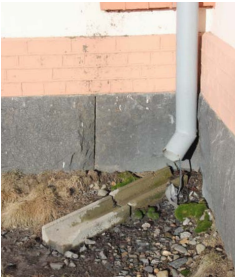
99. Koskitien puolella sadevesi johdetaan katolta maaperään.
