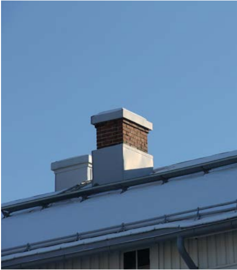
101. Vesikatto tuulettuu sivuräystäiltä. Räystäällä on sadevesikourut ja lumiesteet.
