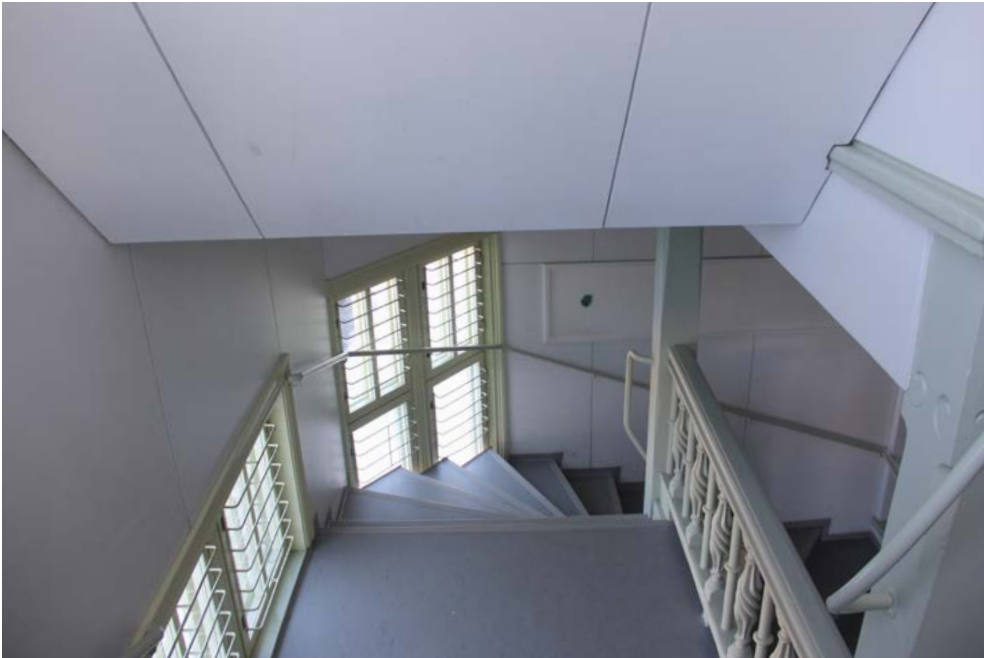
173. Näkymä toisen kerroksen tasolta porrassyöksyyn. Ikkunoissa on kalterit putoamisen estämiseksi.
