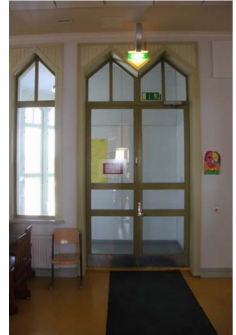
193. Pääportaaseen johtavat osastoivat ovet rakennuksen toisessa kerroksessa.
