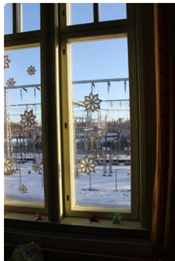
204. Ikkunanäkymää hallitsee kytkinkenttä.
