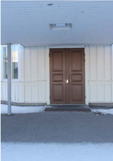
109. Pääovi on sadekatoksen puristuksessa.
