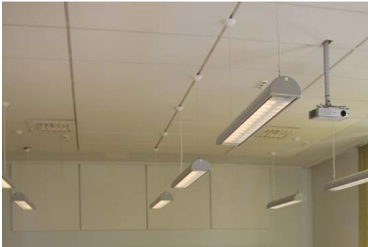
123. Luokkahuoneiden alakattoihin on kiinnitetty vaaleat akustiikkalevyt. Ripustukset on tehty pääosin levyjen saumoihin.
