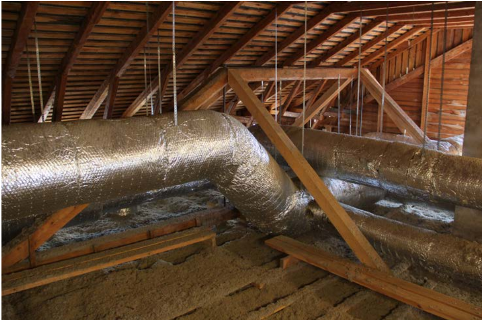
228. Putkituksista huolimatta vesikaton rakenteellisuus ja taitava puutyö on edelleen nähtävissä. Kuvassa yksi ansarakenteista.
