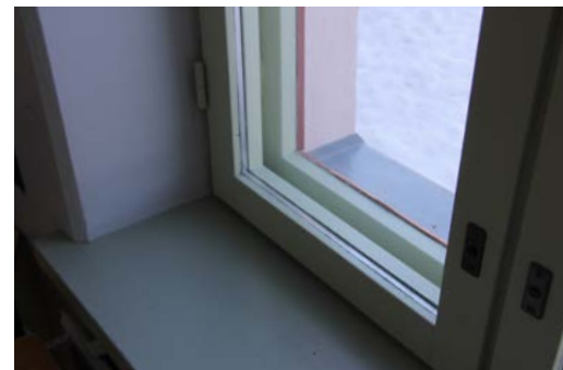
140. Ensimmäisen kerroksen ikkuna sisäpuolelta.
