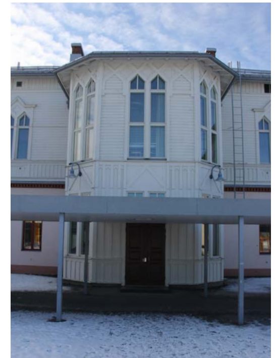
94. Symmetria toistuu myös porrashuoneen muodossa.
