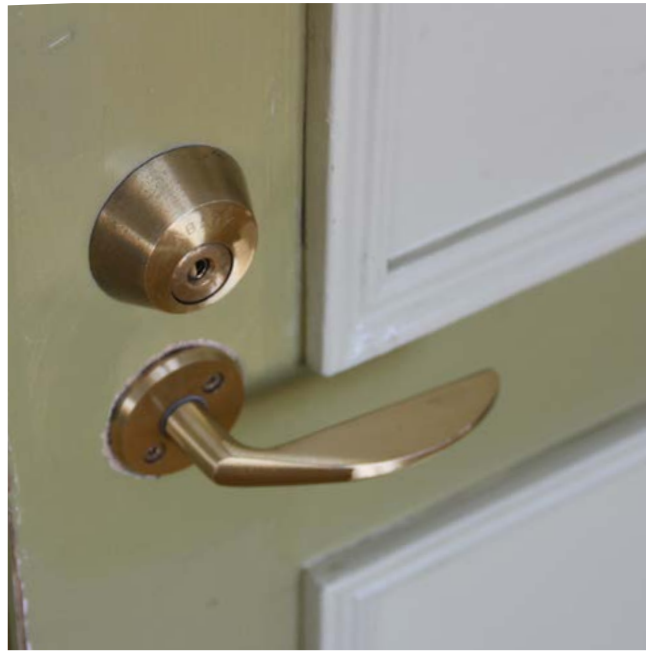
135. Oviin on vaihdettu yhdenmukaiset messinkihelat.
