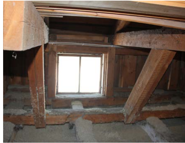
231. Ruotsalaisten kattotuolien välissä on yksinkertainen haukkaikkuna.
