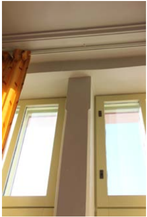
143. Ikkunat on ryhmitelty pareittain. siten, että kahden karmen välissä on pileri. Kuvassa ensimmäisen kerroksen luokkahuoneen ikkuna.
