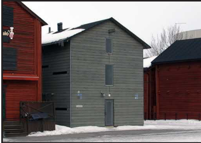
Torinrannan uusi aitta nro 6 – Saaristonkatu 1a Huoltorakennus, Arkkitehtitoimisto Ulla ja Lasse Vahtera Oy, rakennuslupa 6.4.1998
