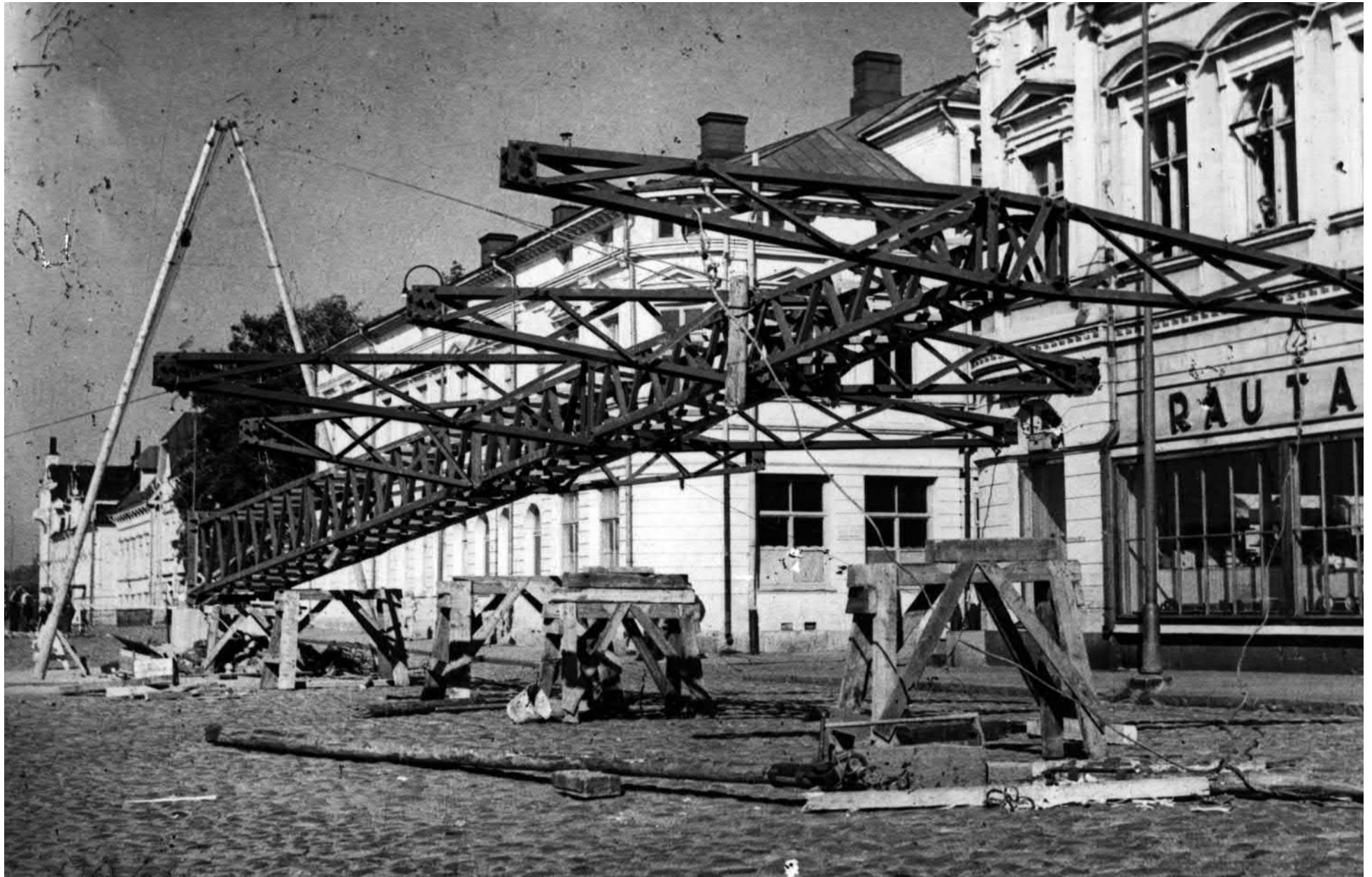
Kuva 28. Merikoskesta Nuottasaareen johtavaa sähkölinjaa pystytetään Rantakadulle 23.7.1947.
