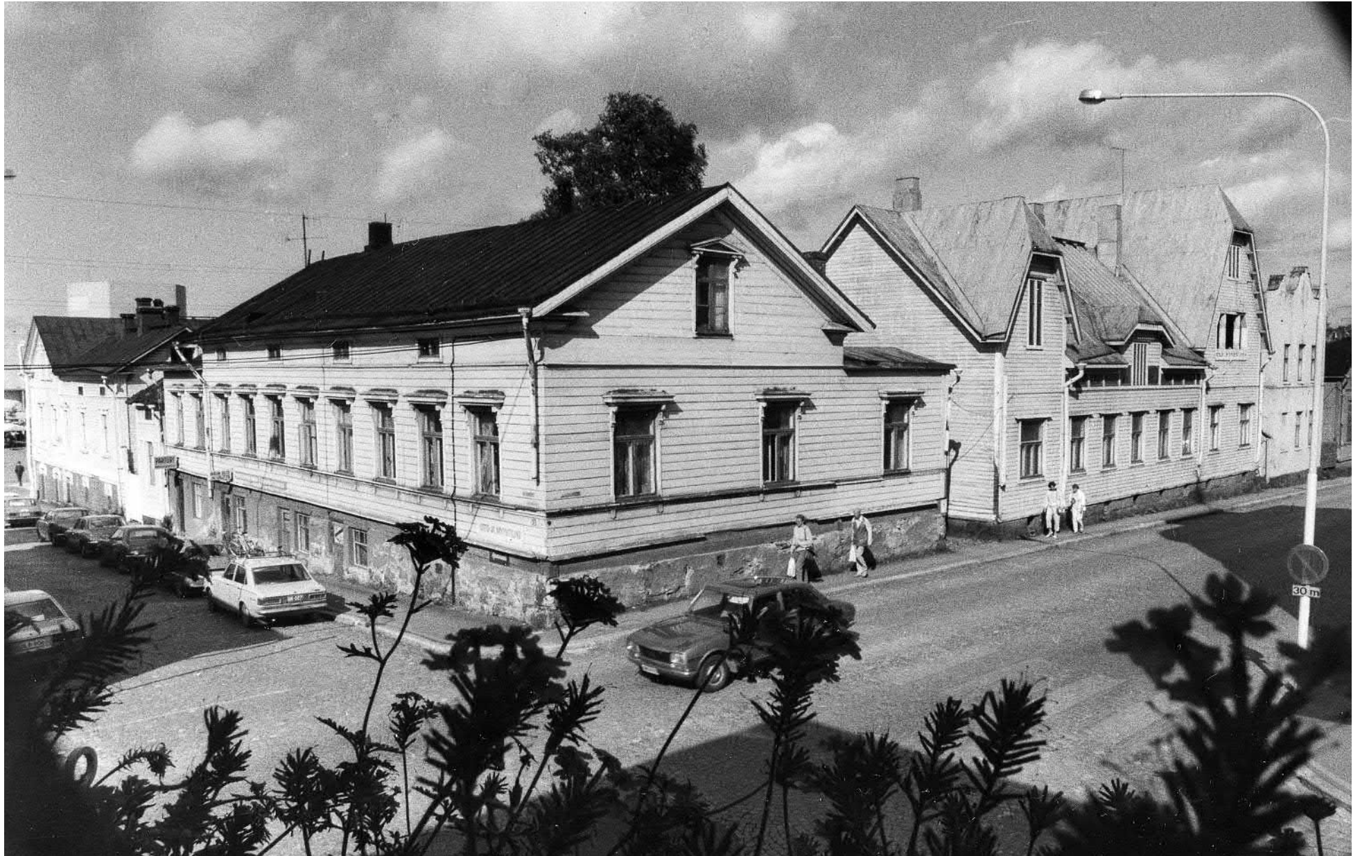
Kuva 68. Vuoden 1989 asemakaavamuutoksella suojeltiin useita rantakortteleiden vanhoja puurakennuksia. Esimerkiksi tämä kulmauksen rakennus sai kaavassa suojelumerkinnän sr-4. Rakennus kuitenkin tuhoutui käyttökeltottomiksi tulipalossa 1990-luvun alkupuolella.
