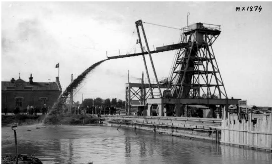
Kuva 27. Kauppahallin viereistä venevalkamaa täytetään 4.8.1938. Venevalkama täytettiin Oulun edustalta laivaväylän ruoppauksesta nousseella mudalla.
