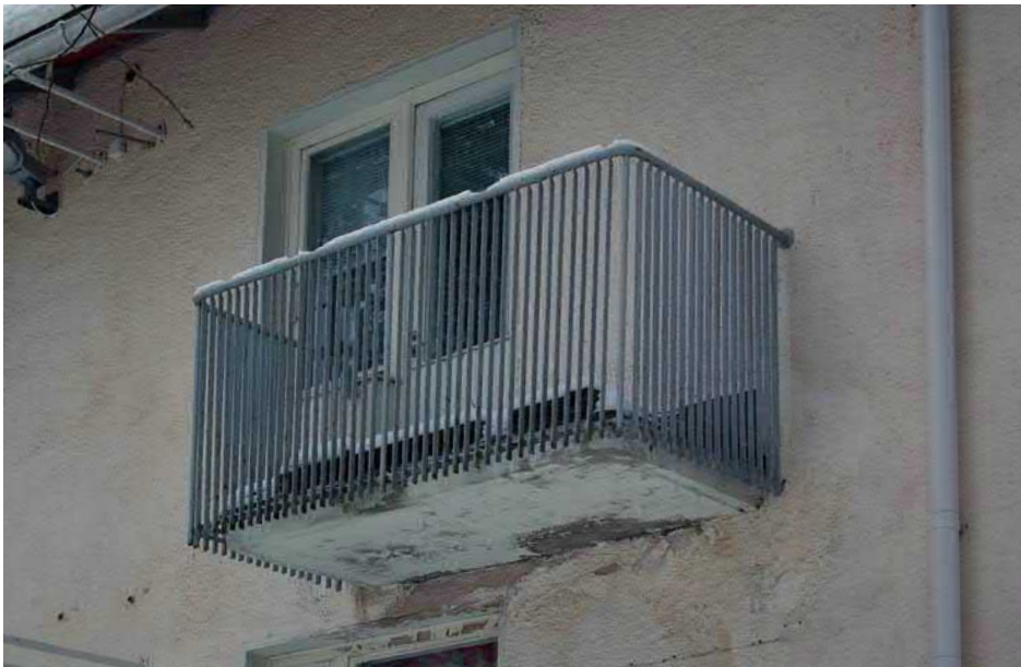
Kuva 57. Takajulkisivun toisen kerroksen parveke on ilmeisesti alkuperäiskunnossa.
