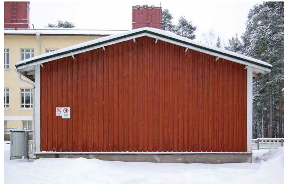
Kuva 47. Autotalli- ja vajarakennus.
