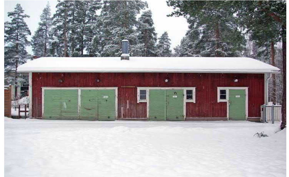
Kuva 46. Autotalli- ja vajarakennus.
