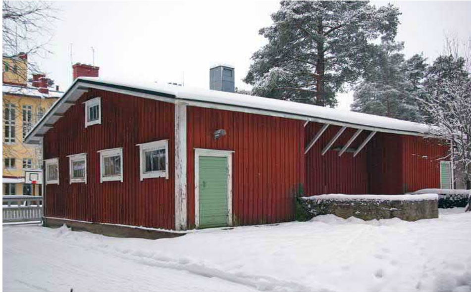
Kuva 43. Tunkio-osa tallirakennuksesta on purettu. Betoninen korkea sokkeli on vielä jäljellä.
