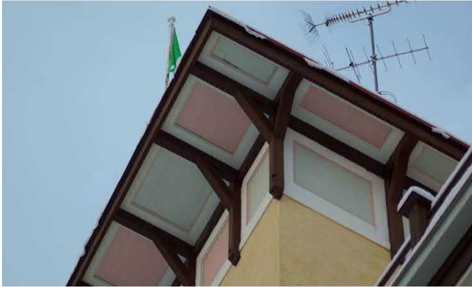
Kuva 68. Rästystä kannattelee puusta toteutetut konsolit, joiden jakamissa kentissä on peiliihieet. Peilin värisävyjä on vaihdettu ilmeisesti useampaan otteeseen. Väritutkimuksella olisi mahdollista saada selville alkuperäiset sävyt. Konsoleita ja seinäpinnan peilinauha-aihetta ei ole rakennuksen takajulkisivulla.
