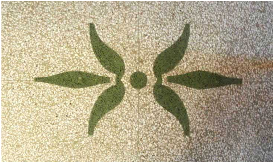
Kuva 66. Aula- ja hallitilojen kunnostetut marmorimosaiikkilattiat ovat hyväkuntoiset. Lattioihin on toteutettu erisävyisiä koristekuvioita. Rajaukset marmorimosaiikkikenttiin ja -kuvioihin on toteutettu työselostuksen mukaan sinkkilevylistoin.
