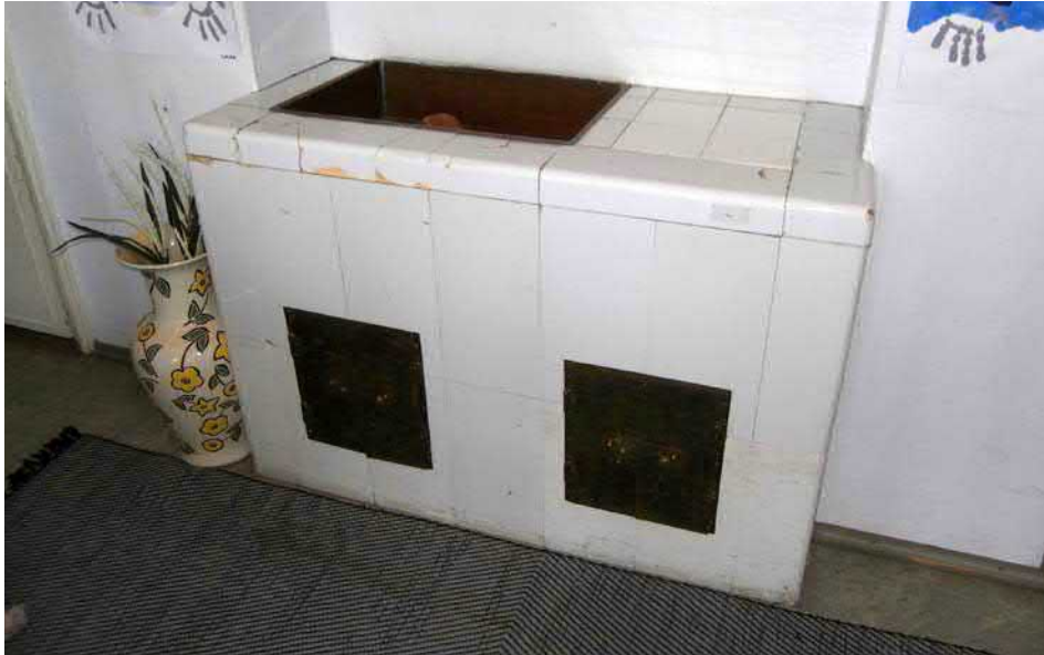
Kuva 65. Rakennuksen toisen kerroksen ylähallissa sijaitseva lämmitysruukki. "Perimätiedon" mukaan uunin päällä olevassa kuparisessa vesialtaassa on lämmitetty tuttipulloja.
