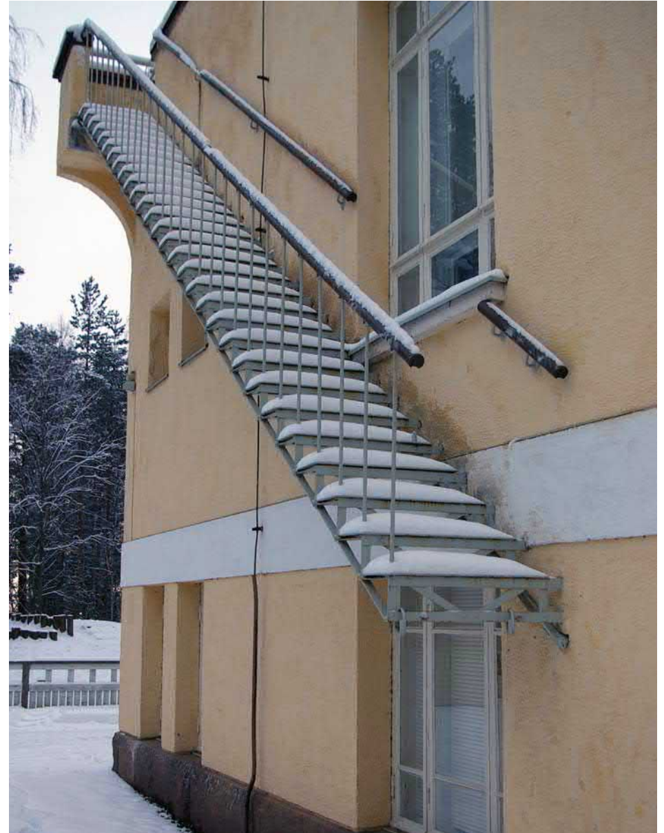
Kuva 73. Paloportaat rakennuksen molemmissa päädyissä johtavat toisen kerroksen avoparvekkeilta alas maahan. Rakennusluvista vastanneessa kaupungin Maistraatissa olisi haluttu, että portaat johtavat maahan asti, mutta käytännön syistä rakennuttaja halusi portaiden päättyvän ennen maan tasoa.
