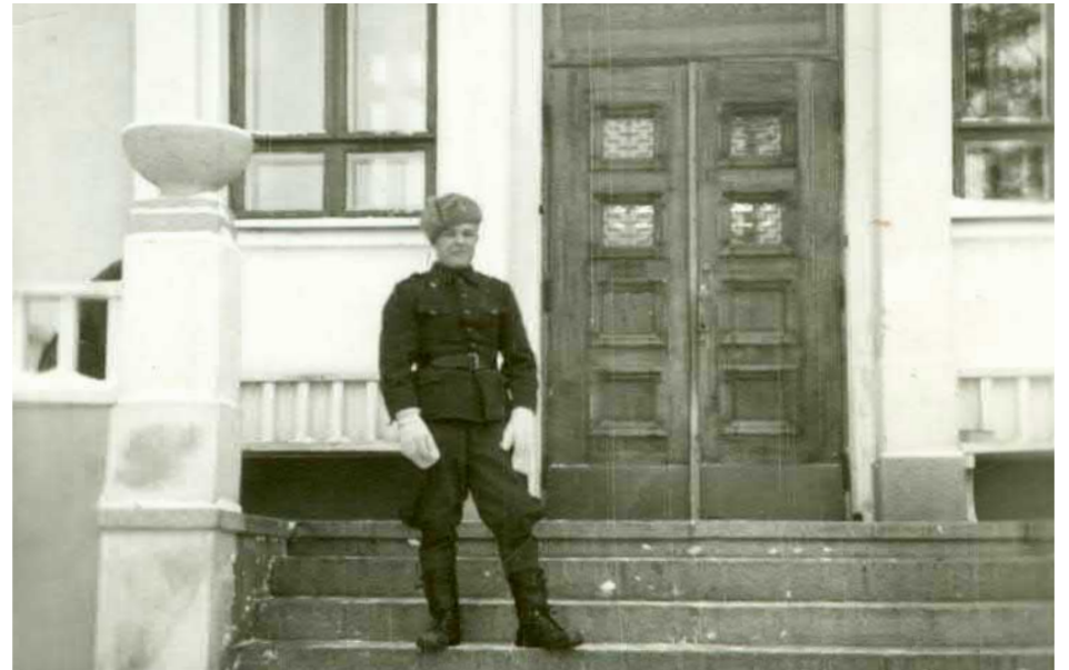
Kuva 18. Sotilas lastenparantolan portailla. Kuvasta näkyy selvästi, kuinka ikkunoiden ulompi puite oli väriltään tumma. Rakennuksen työselityksen mukaan sisäänkäynnin molemmin puolin ikkunoiden alla sekä rinta-aidan sisäpuolella oli petäjäpuusta valmistetut maalatut penkit.
