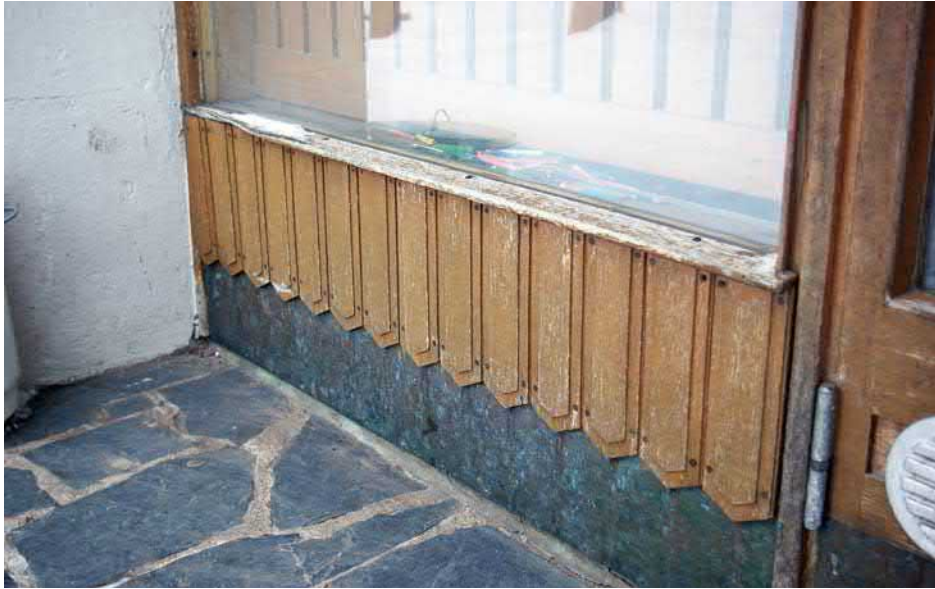
Kuva 56. Rakennuksen pintaverhousmateriaaleja: liuskekivi, kuparilevy, koristeppuupaneeli ja tamminen sisäänkäyntiovi.
