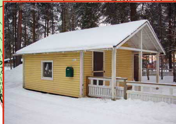
Leikkikalugarasto Arkkitehtitoimisto Jorma Teppo Oy Rakennuslupa 20.5.1985 Valmistui 1985 piharemontin yhteydessä
