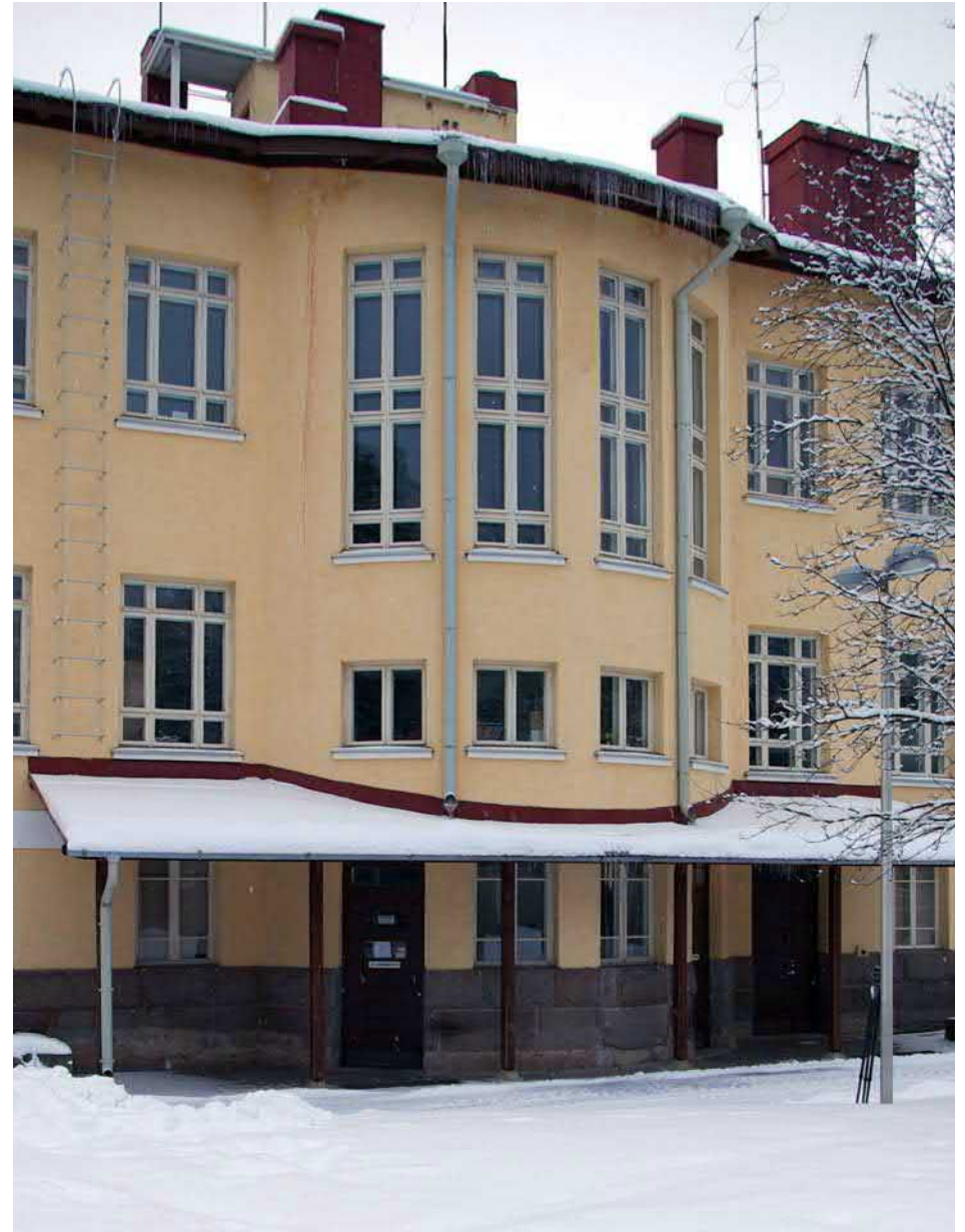
Kuva 70. Porrashuone työntyy julkisivusta ulos kaarevana elävoittäen julkisivua. Takajulkisivun sisäänkäyntikatokset toteutettiin 1980-luvun alun laajan peruskorjaustöiden yhteydessä.
