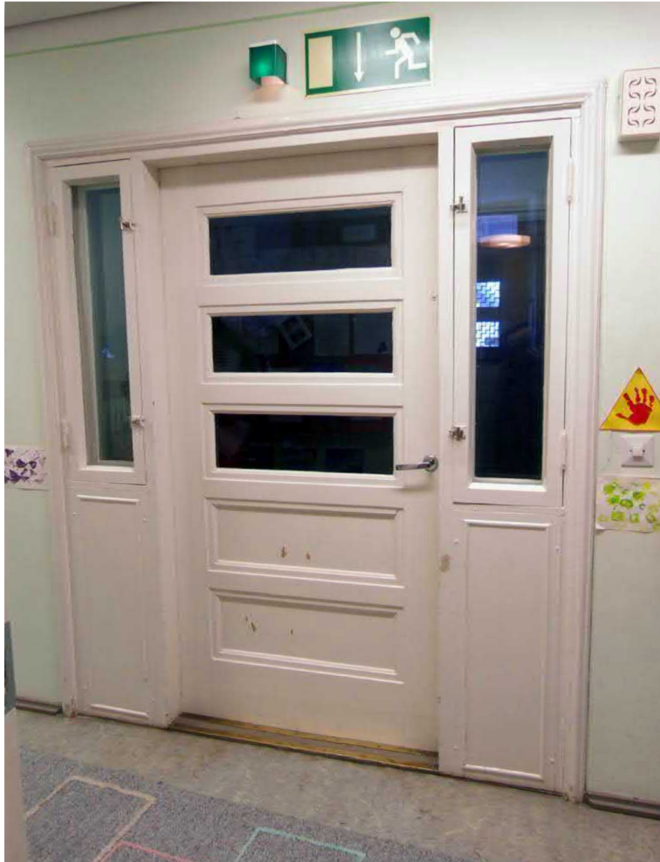
Kuva 63. Sisätilojen väliovet ovat pääsääntöisesti alkuperäisiä. Kuvassa väliovityyppi, jonka molemmin puolin on valoaukolliset pielet.
