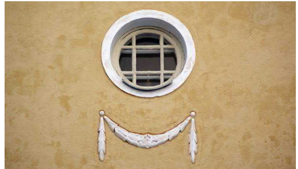
Kuva 28. Pääjulkisivussa olevat kolmannen eli ullakkokerroksen pyöreät ikkunat ja koristeaihe. Alunperin ikkunoiden taakse oli suunniteltu vesisäiliö ja varastotilaa. Vaikka huonetilat muutettiin rakennusvaiheessa asuinhuoneiksi, ei ikkunoiden muotoa tai kokoa muutettu ulkonäöllisistä syistä. Näin totesi Sucksdorff työmaan valvojalle Kaarlo Kaattarille eräessä hänelle lähettämässään kirjeessä.
