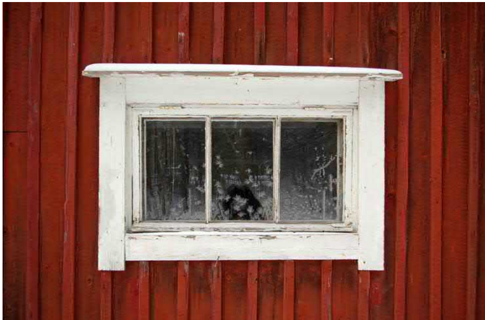
Kuva 44. Piharakennusten ikkunat ovat pääsääntöisesti kaksipuitteiset.
