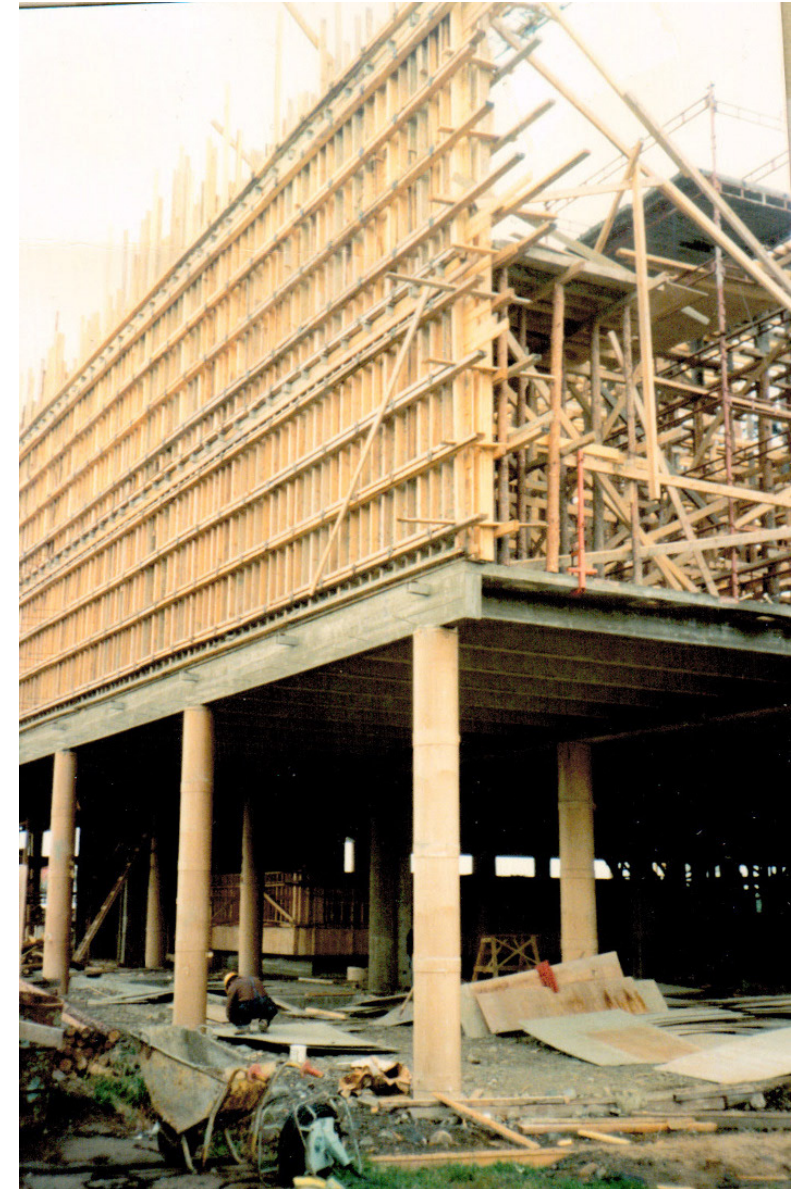
Kuva 13 Lounaisjulkisivun muuttityöt meneillään
