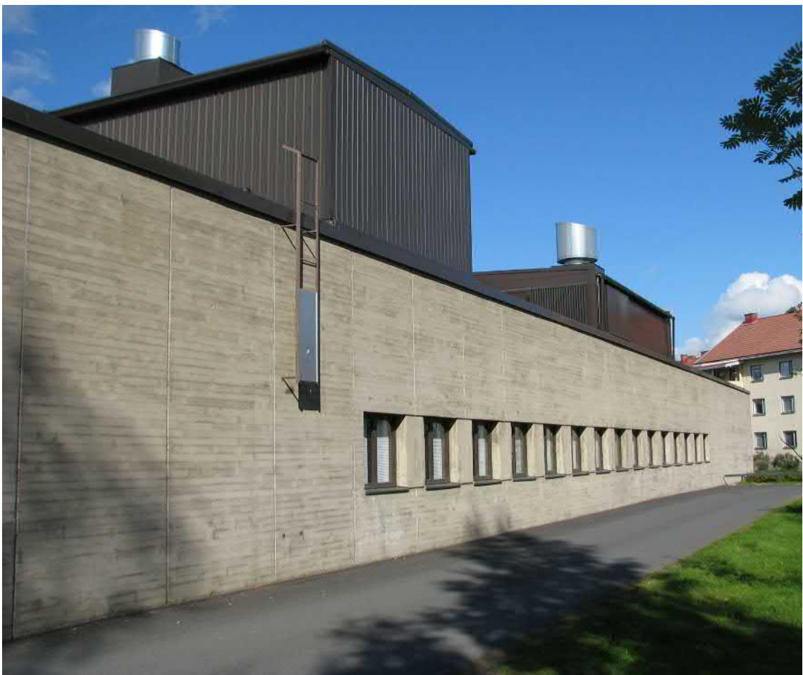
Katolle sijoitetut IV-konehuoneet hallitsevat näkymää rakennusta itäpuolelta lähestyttäessä. (AS)
