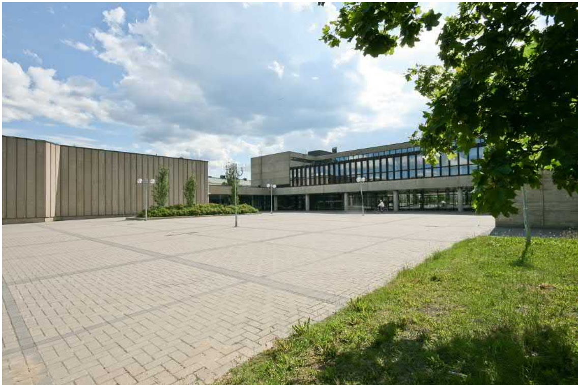
Alkuperäiset, n. neliömetrin kokoiset betoniset, neliömäiset pihalaatat on korvattu pienillä, koristeellisesti limitetyillä betonikivillä. Suurten kenttien väliin jäävät muita tummemmat pihakivet jakavat pinnan suuriin neliökenttiin. (OUKA, TK, 2013)
