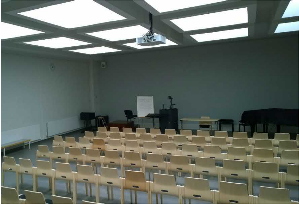
Luentosali on menettänyt alkuperäisyytensä pintojen uusimisen yhteydessä. Tammiparketti on väistynyt sintrattujen laattojen alta ja alakaton alkuperäisen mäntypaneelin sijaan tilalla on akustointisyistä käytetty pinnoitettua valkoista mineraalivillaa. (AS)
