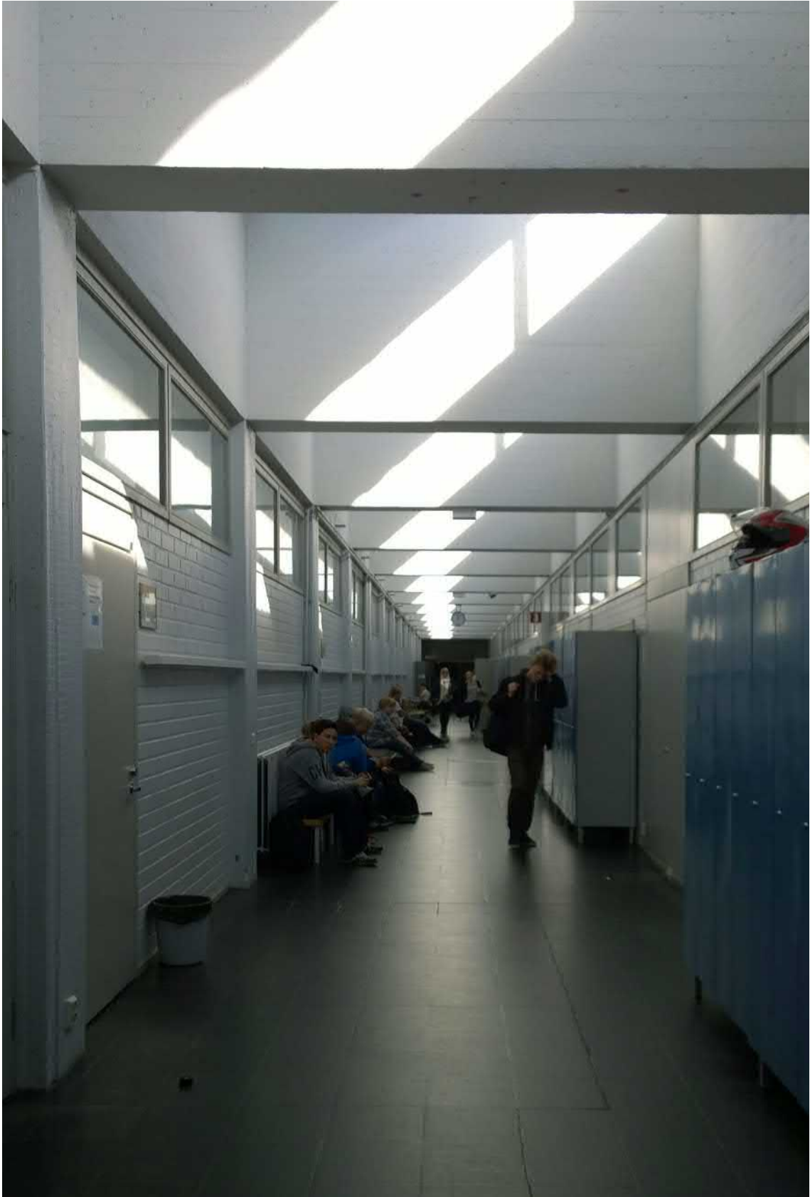
B ja C osille tyypillinen keskikäytävä on säilynyt ainoastaan rakennusosassa B. Tila on säilyttänyt alkuperäisyytensä hyvin mm. pintojen, ovien ja seinien yläosan ikkunoiden osalta. Myös ovien listoitukset ovat alkuperäiset. (AS)
