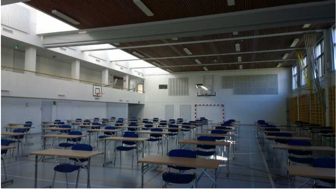
Liikuntasalin muutokset ovat pieniä, ja liittyvät pintojen uusimiseen tai akustoinnin parantamiseen. Alakaton mäntylauditus on alkuperäinen, samoin salin rimarilität. (AS)
