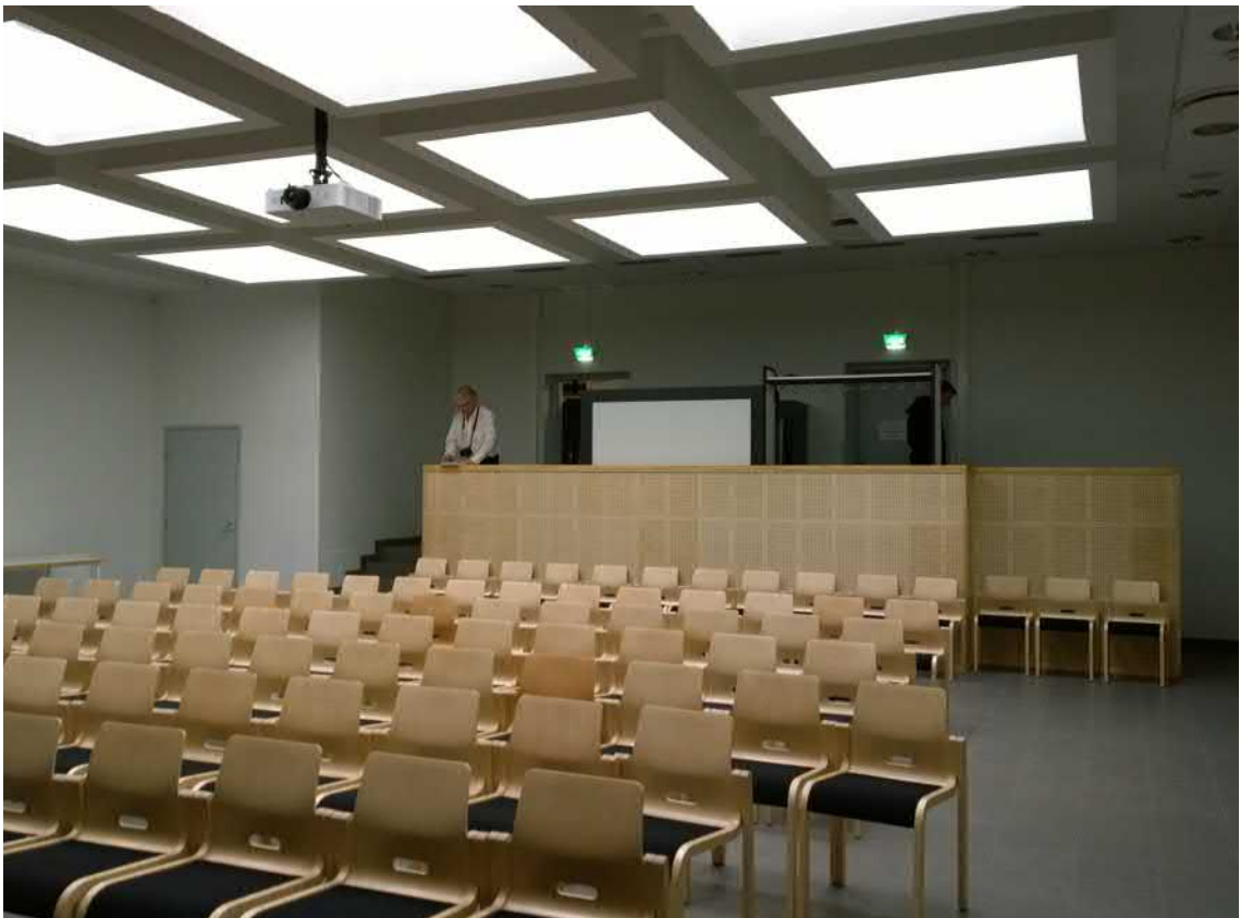
Luentosali on menettänyt alkuperäisyytensä pintojen uusimisen yhteydessä. Tammiparketti on väistynyt sintrattujen laattojen alta ja alakaton alkuperäisen mäntypaneelin sijaan tilalla on akustointisyistä käytetty pinnoitettua valkoista mineraalivillaa. (AS)
