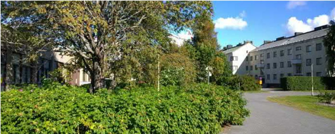
Vasemmalla Pohjankartano, oikealla Kollaantien 1950-luvun lopun kerrostaloja, suunnittelija rakennusmestari August Rönköharju. (AS)
