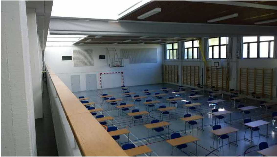
Liikuntasali on säilyttänyt alkuperäisyytensä erinomaisesti. Käytäväosan alakattoon on lisätty valkoisia vaimenuslevyjä, samoin kattolyhtyihin. (AS)
