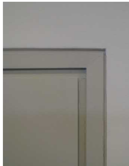
Portaiden tammiset käsijohtimet ovat alkuperäiset. Alkuperäisten ovien listoitus on huolellisesti toteutettu; listan ja seinän väliin jää varjouri. (AS)
