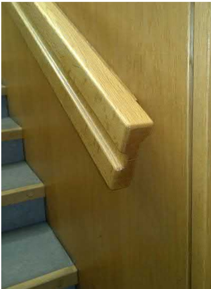
Portaiden tammiset käsijohtimet ovat alkuperäiset. Alkuperäisten ovien listoitus on huolellisesti toteutettu; listan ja seinän väliin jää varjouri. (AS)
