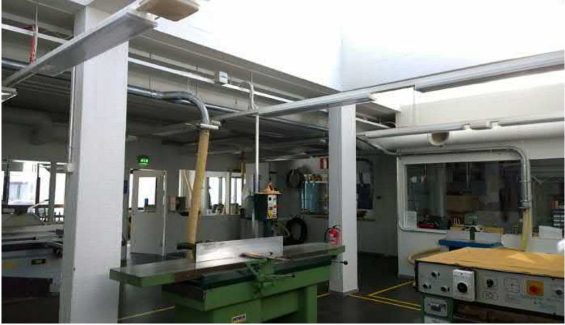
Metalli- ja puutyöluokkien muutostöissä on pyritty tilojen aiempaa parempaan käytettävyyteen ja valottavuuteen. Keskikäytäväratkaisusta on jäljellä kattoikkunoiden vyöhyke. (AS)
