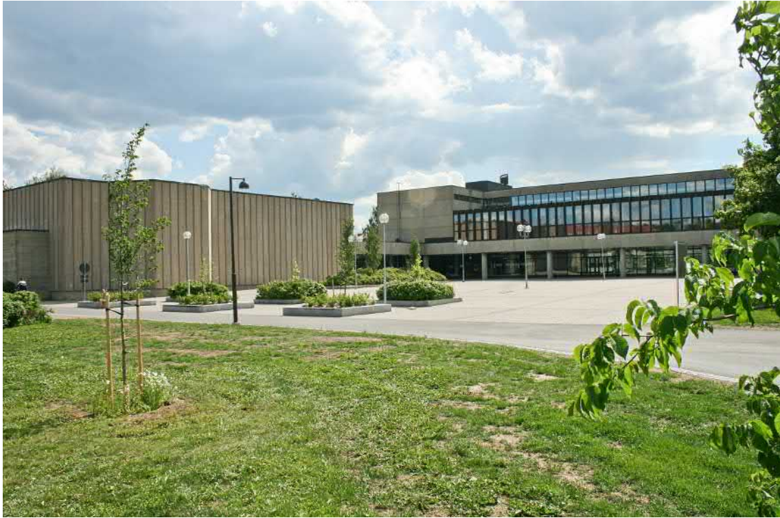
Lähestymissuunta pohjoisen puistoalueelta on vehreä. Pääsisäänkäynnin eteen jäävä piha-alue on säilynyt alkuperäisen kaltaisena, avarana puolisisäpihana. Rajattuja, neliömäisiä istutusalueita on alkuperäistä enemmän, myös vesiallas on muutettu sellaiseksi. (OUKA, TK, 2013)
