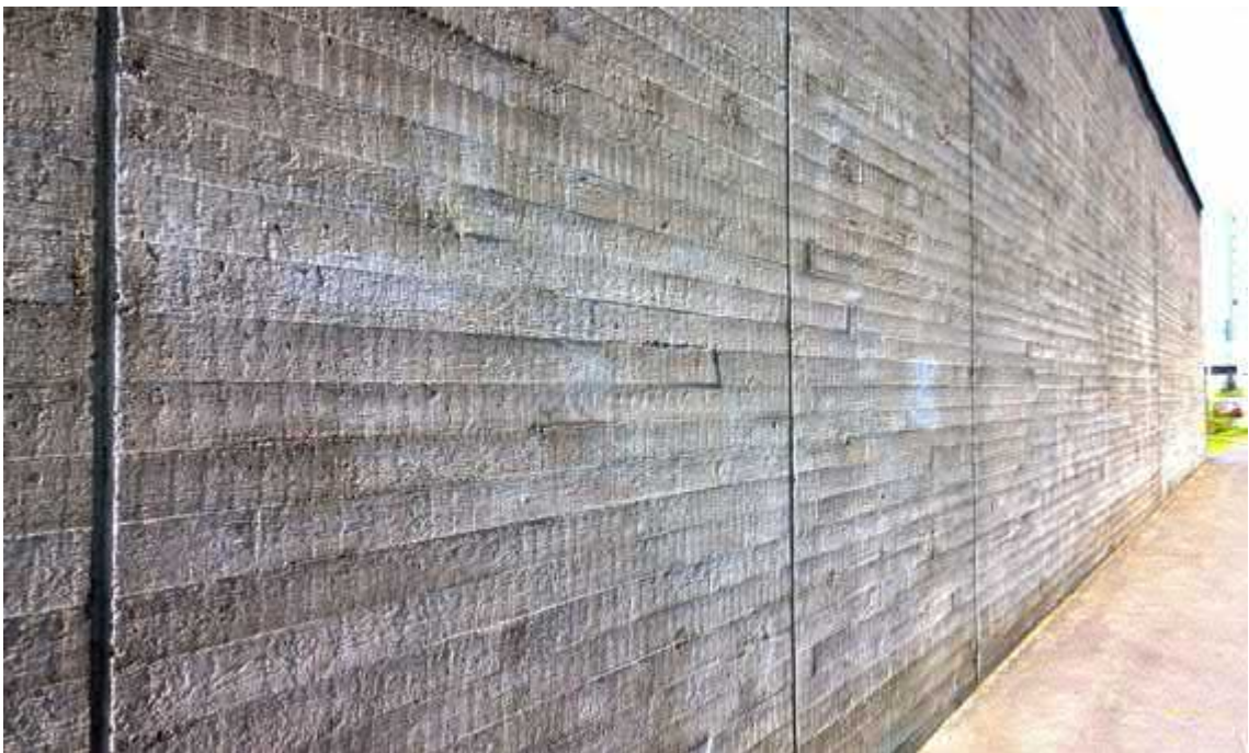
Juhlasalin ulkoseinissä on käytetty U-muotoisia elementtejä. Muualla A-osassa julkisivupinnat on verhottu silein betonielementein. Kirjastossa ja salin viereisten tilojen julkisivuissa on käytetty lautamuottiin valettua betoniseinää, joka on jaettu pystyuriin noin kahden metrin välein. (AS)
