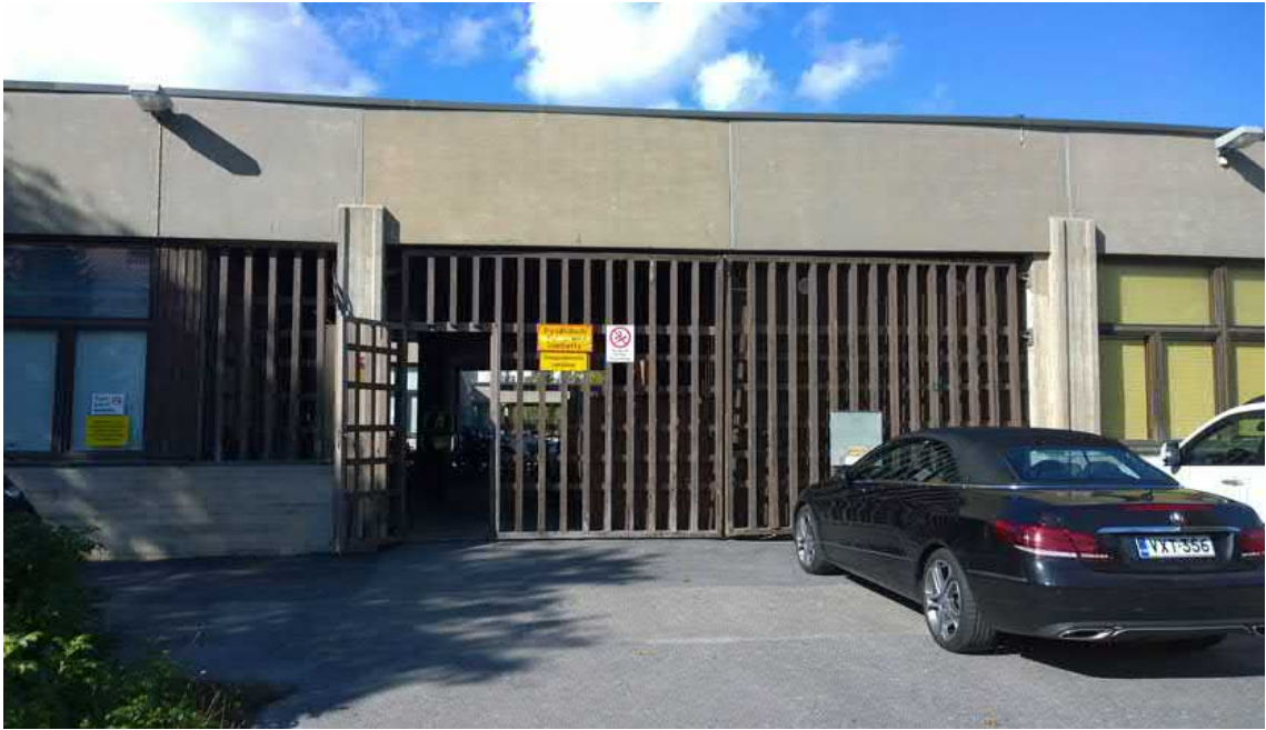
Sisäpihalle johtavan kulkureitin tukkivat portit istuvat kömpelösti rakennuksen arkkitehtuuriin. (AS)
