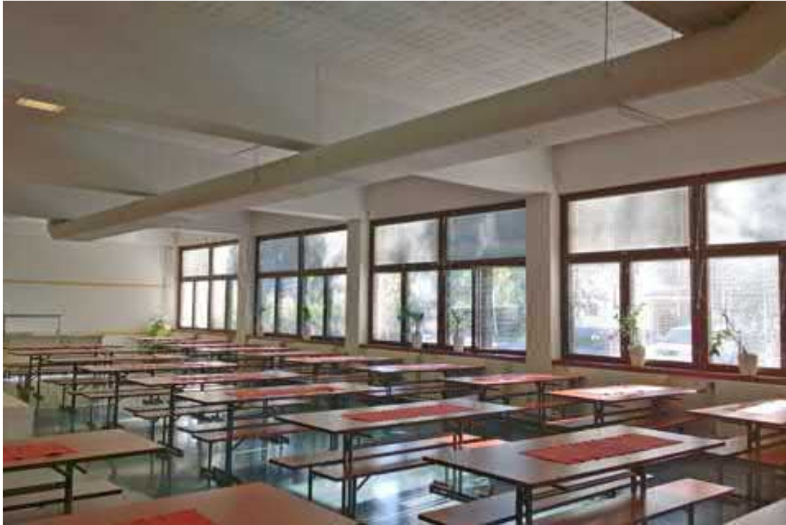
Ruokasalin myöhemmät muutokset liittyvät lähinnä akustoinnin ja ilmanvaihdon parantamiseen. (AS)
