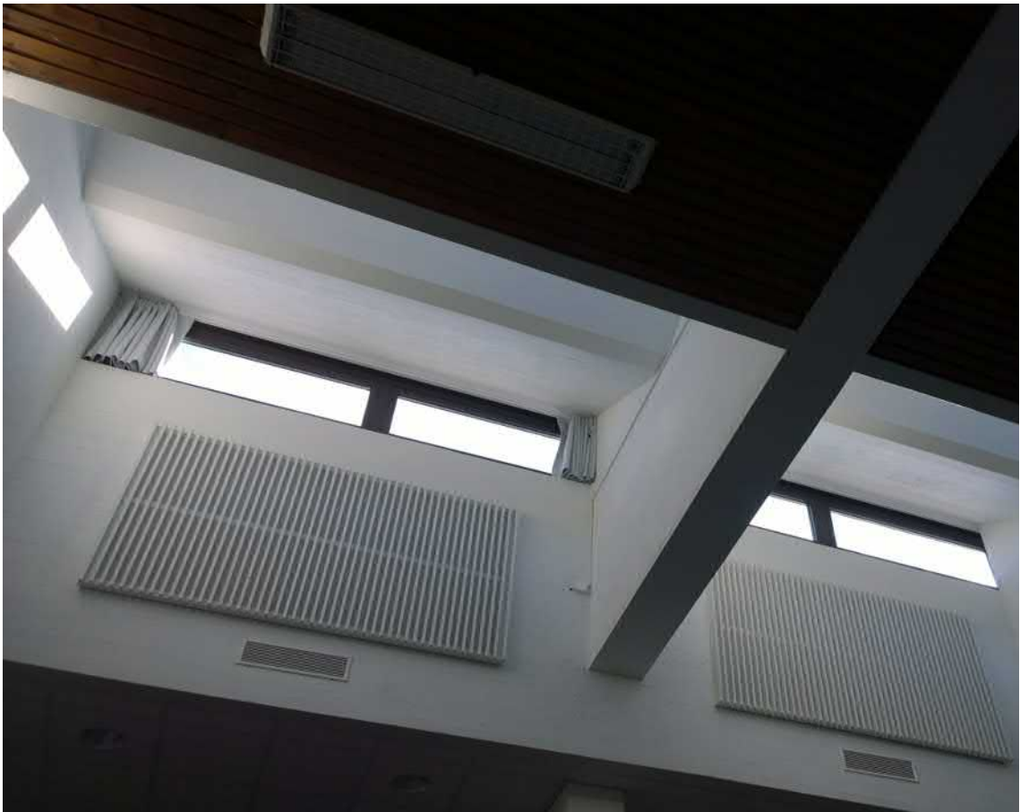
Liikuntasalin muutokset ovat pieniä, ja liittyvät pintojen uusimiseen tai akustoinnin parantamiseen. Alakaton mäntylauditus on alkuperäinen, samoin salin rimarilität. (AS)
