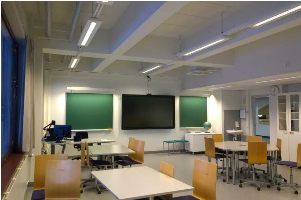
Luokkien akustiikkaa on parannettu lisäämällä kattoon akustoivia levyjä. Alakaton osittainen alaslasku liittyy ilmanvaihtoon parantamiseen. Uusi AV-tekniikka mahdollistaa nykyaikaisten opetusmenetelmien käytön. (AS)
