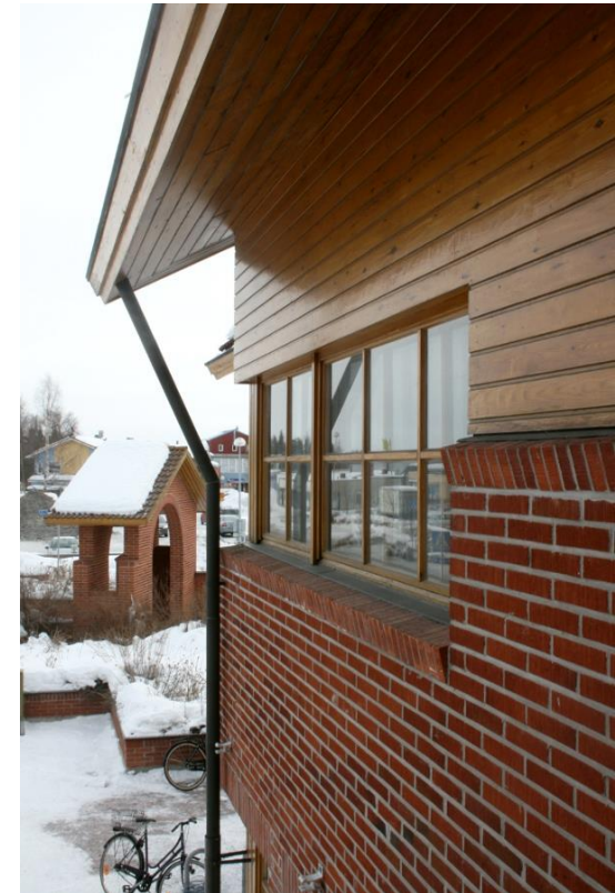
Kuva 25 Vesikourut on asennettu piiloon. Kuvassa näkyy ikkunan istutus seinärakenteeseen sekä tiiliverhouksen ja pellityksen detaljit (PK)
