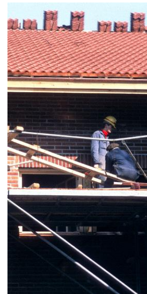
Kuva 29 Kattotiiliä ladotaan paikoilleen (TK)
