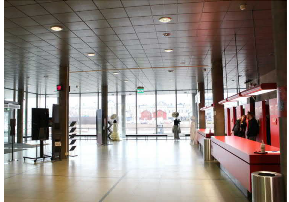
Aulan lattiassa kapeat mustat listat muodostavat vaaleanharmailla sementtimosaiikki-laatoilla päällystettyyn lattiaan 3 x 3 metrin ruudukon.
