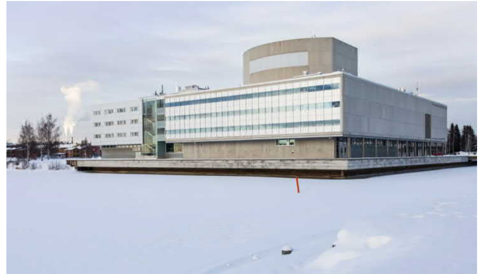
Julkisivu lounaaseen vuonna 2017. Vanhassa osassa arkadin alla näkyvät peruskorjauksen yhteydessä lisätyt uudet ikkunat. (Kuva Esa Eirola).
