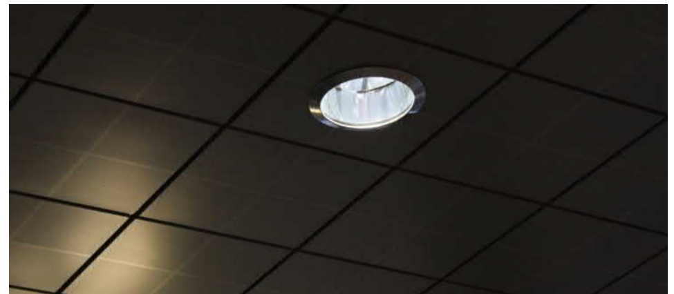
Modulaarisuus pintamateriaaleissa hahmottuu parhaiten aulassa. Alakatto on uusittu peruskorjauksen yhteydessä samankaltaiseksi kuin alkuperäinen.
