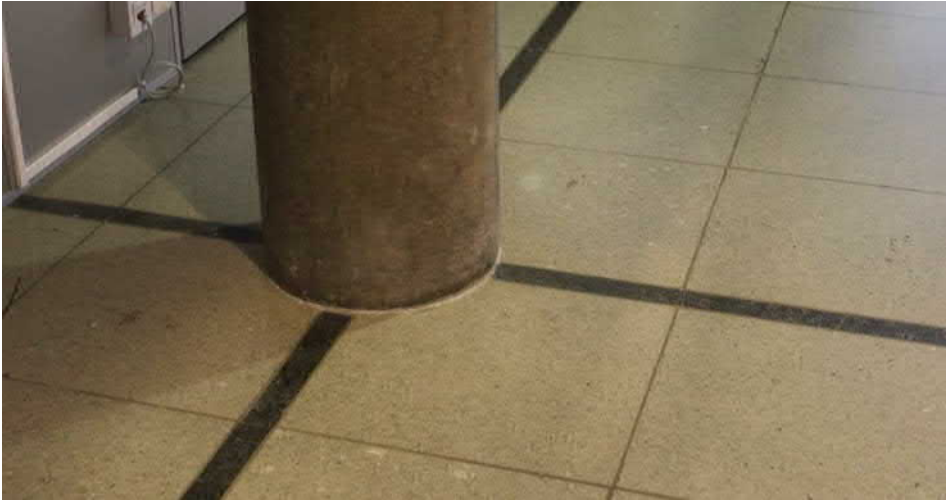
Aulan lattiassa kapeat mustat listat muodostavat vaaleanharmailla sementtimosaiikki-laatoilla päällystettyyn lattiaan 3 x 3 metrin ruudukon.
