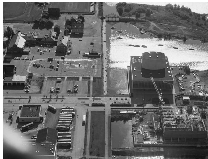
Kuva 44. Kauppatorin ympäristö muuttui voimakkaasti 1970- ja 80-luvulla. Uusi kaupunginteatteri on saamassa seurakseen kaupunginkirjaston, vielä toiminnassa oleva linja-autoasema kuvassa vasemmassa alareunassa. Kuva Jarmo Kontiainen. Museoviraston kuvakokoelmat, Journalistinen kuva-arkisto, Kaleva. 29.08.1980.
