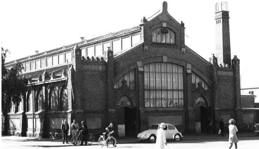
Kuva 59. Kauppahallin pohjoispäädystä erottuvat nykyään purettu keskuslämmityksen savupiippu sekä ilmastoinnin läpivienti ylimmästä päädyn ikkunasta. Savupiippuun on lisätty rakentamisen jälkeen suojakaiteet nuohoamista varten. Kuva Raimo Ahonen, Pohjois-Pohjanmaan museo, 1972.
