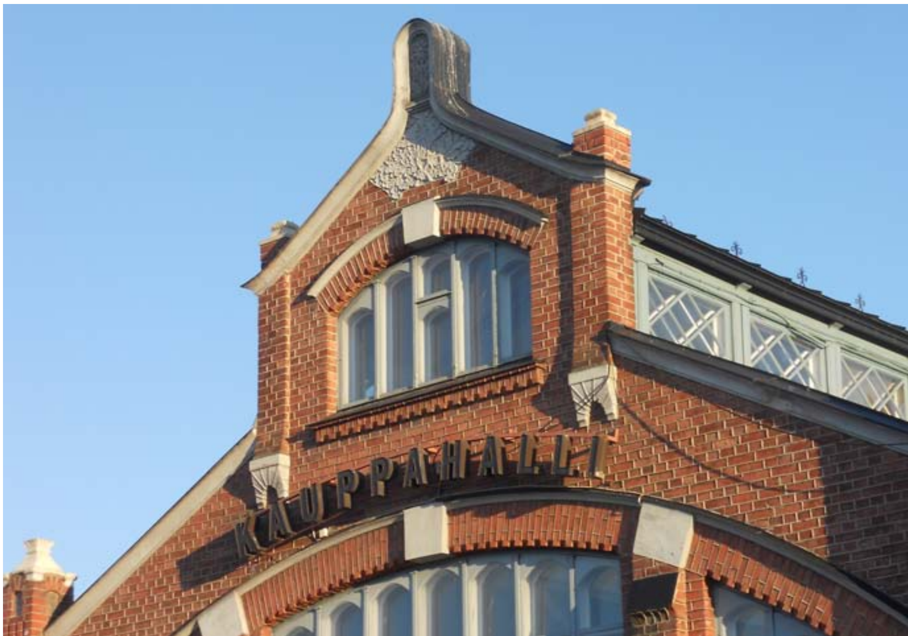
Kuva 74. Kauppahallin nykyinen nimikyltti ja päätyjulkisivun runsasta tiilimuuraus- ja reliefikoristelua.
