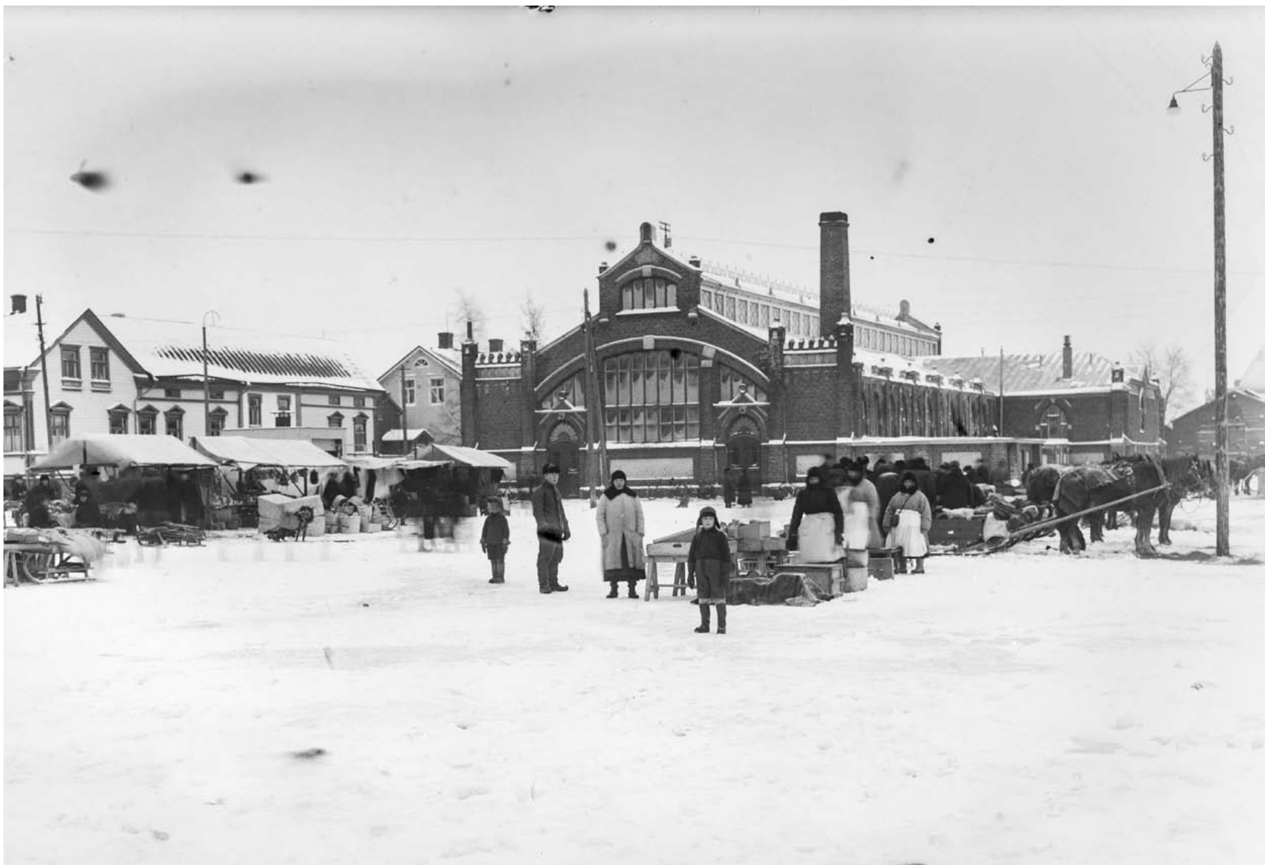
Kuva 40. Kauppahallin kylmävarasto ja jäähdytysosasto alkuperäisessä asussaan ennen talonmiehen asunnon laajennusta kuvan oikeassa reunassa. Museoviraston kuvakokoelmat, Journalistinen kuvakokoelma, Kaleva, 5.12.1934.
