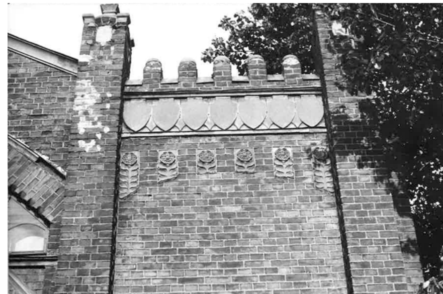
Kuva 48. Arkkitehtonisia yksityiskohtia. Oulun yliopiston arkkitehtuurin tiedekunnan arkisto. Kuvaaja ja aika tuntematon.
