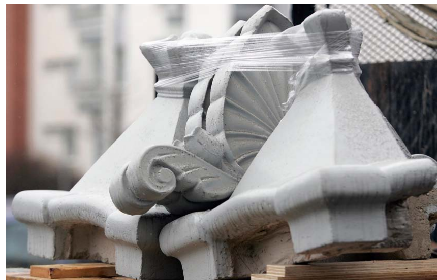
Kuva 71. Uudet rakennusmestari Aaro Vähäkankaan johdolla valetut kattokruunujen koristeosat odottavat asentamistaan. Pekka Ala-aho, 16.5.2007, Kalevan kuva-arkisto 17.5.2007.
