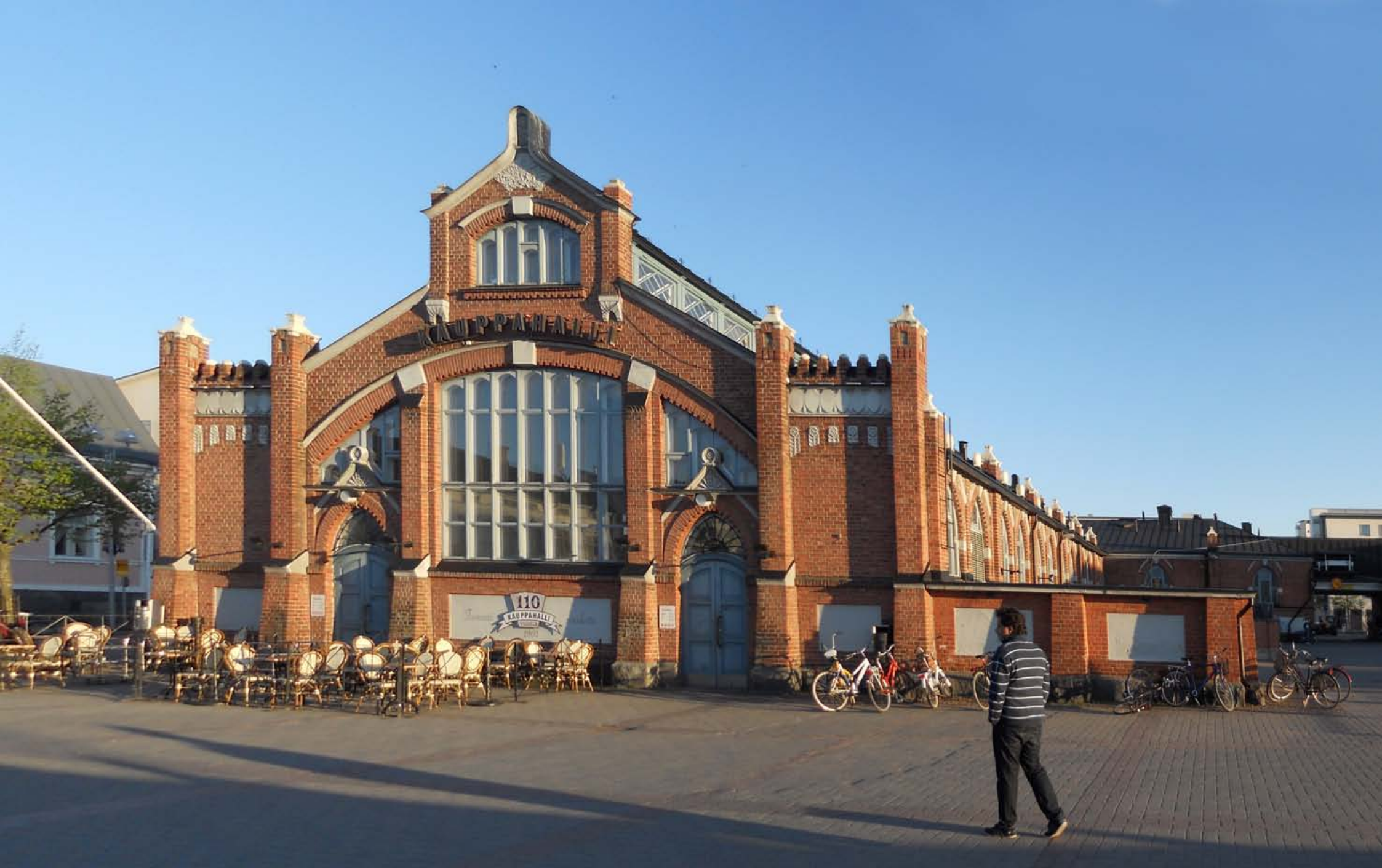
Kannen kuva: Kauppahallin päätyikkunaan asennettu ilmanvaihtuventtiili. Oulun yliopiston arkkitehtuurin tiedekunnan arkisto. 1970-luku, kuvaaja tuntematon. Sisäkannen kuva: Kauppahalli kesäillan auringossa vuonna 2017.
